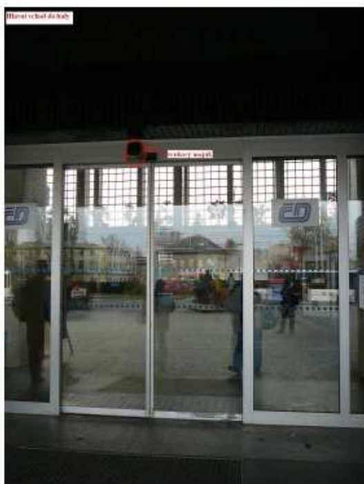
P2.1 DHM vstup do nádraží varovný pás.
