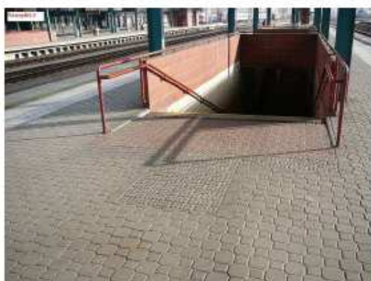
P2.5 Chybné provedení SP, VP nástupiště č. 3.
