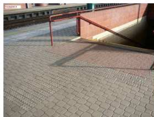
P2.6 Chybné provedení SP, VP nástupiště č. 4.
