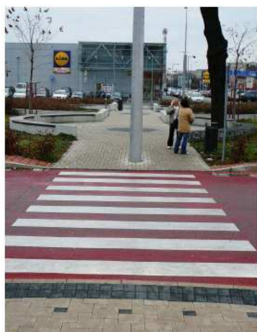
P4.4 Chybějící SP přechodu do odpočinkové zóny.
