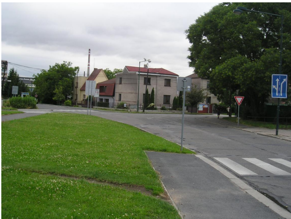
obr. 7: Pohled na napojení ulice Letců R.A.F. na ulici Zbožská
