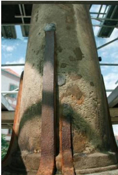
Fotografie č. 50, 51 Detail dříku sloupu a ukotvení železných spon olovem.
