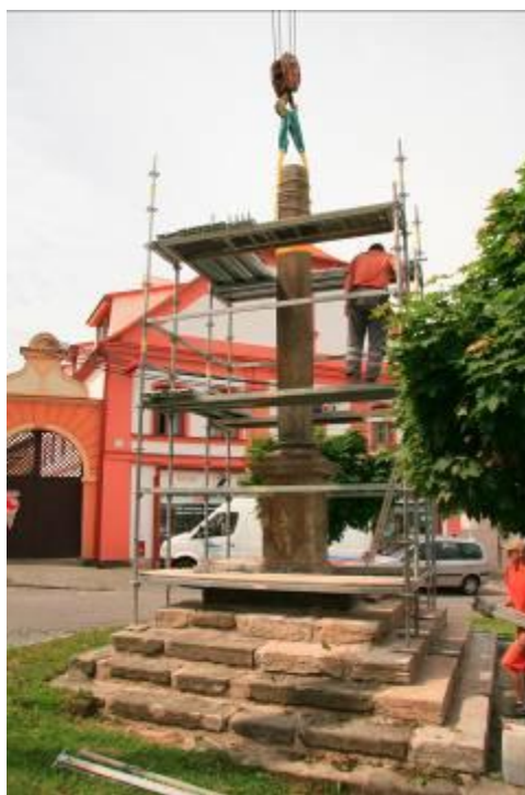
Fotografie č. 102, 103, 104 Zajištění dříku sloupu kombinací dvou 4m vázacích popruhů při montáži a demontáži sloupu. Na fotografii 104 zpětné osazení dříku sloupu.
