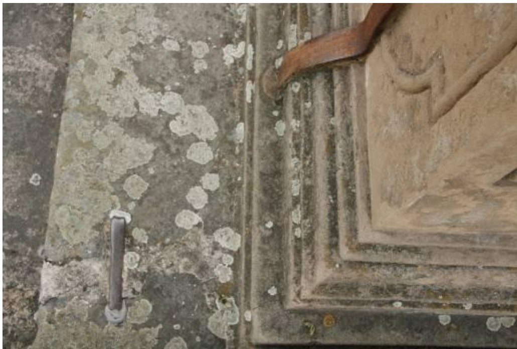
Fotografie č. 55 Detail kovové spony na schodišti, které zároveň zajišťuje patku soklu.
