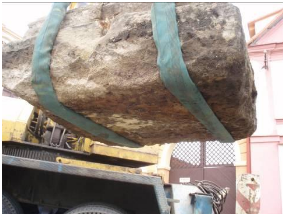
Fotografie č. 67 Vyzdvižení profilované patky po odstranění vrchního stupně kamenného schodiště.
