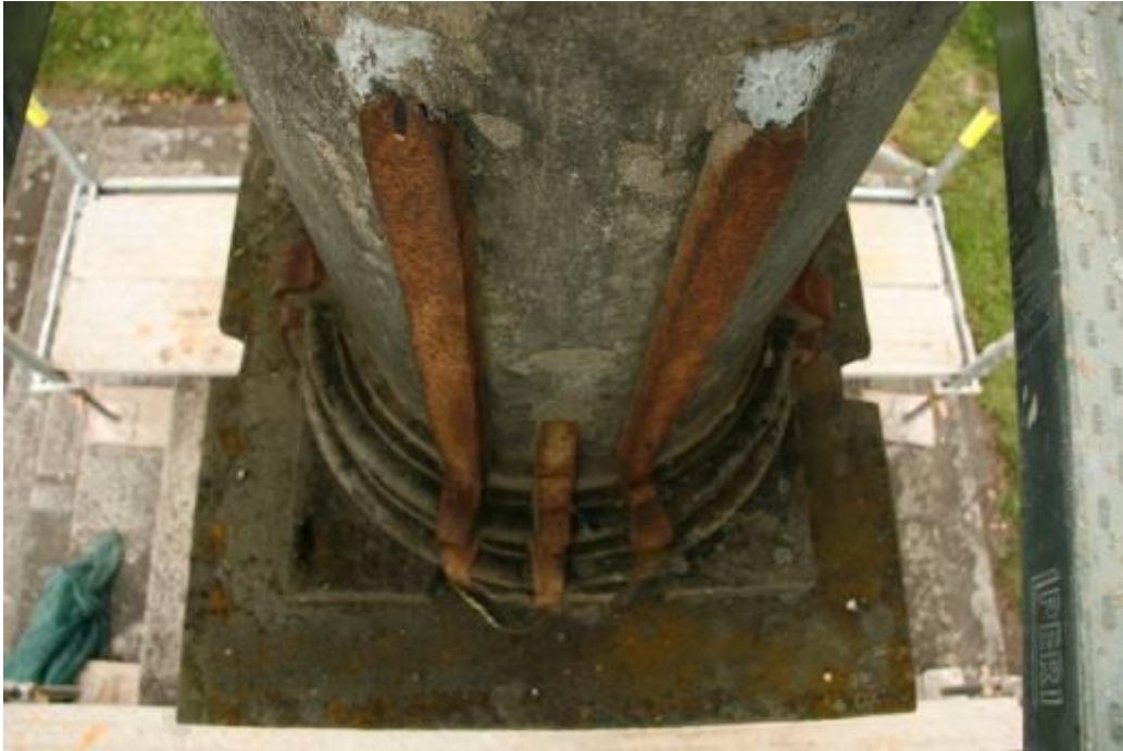
Fotografie č. 49 Detail dříku sloupu a ukotvení železných spon olovem.
