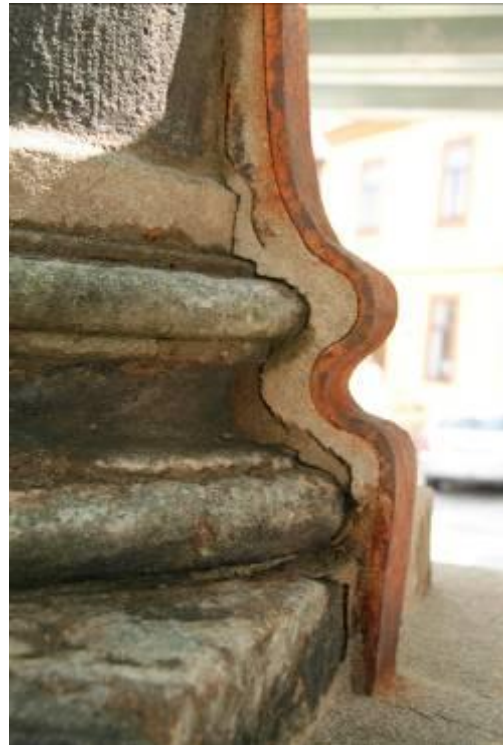
Fotografie č. 50, 51 Detail dříku sloupu a ukotvení železných spon olovem.
