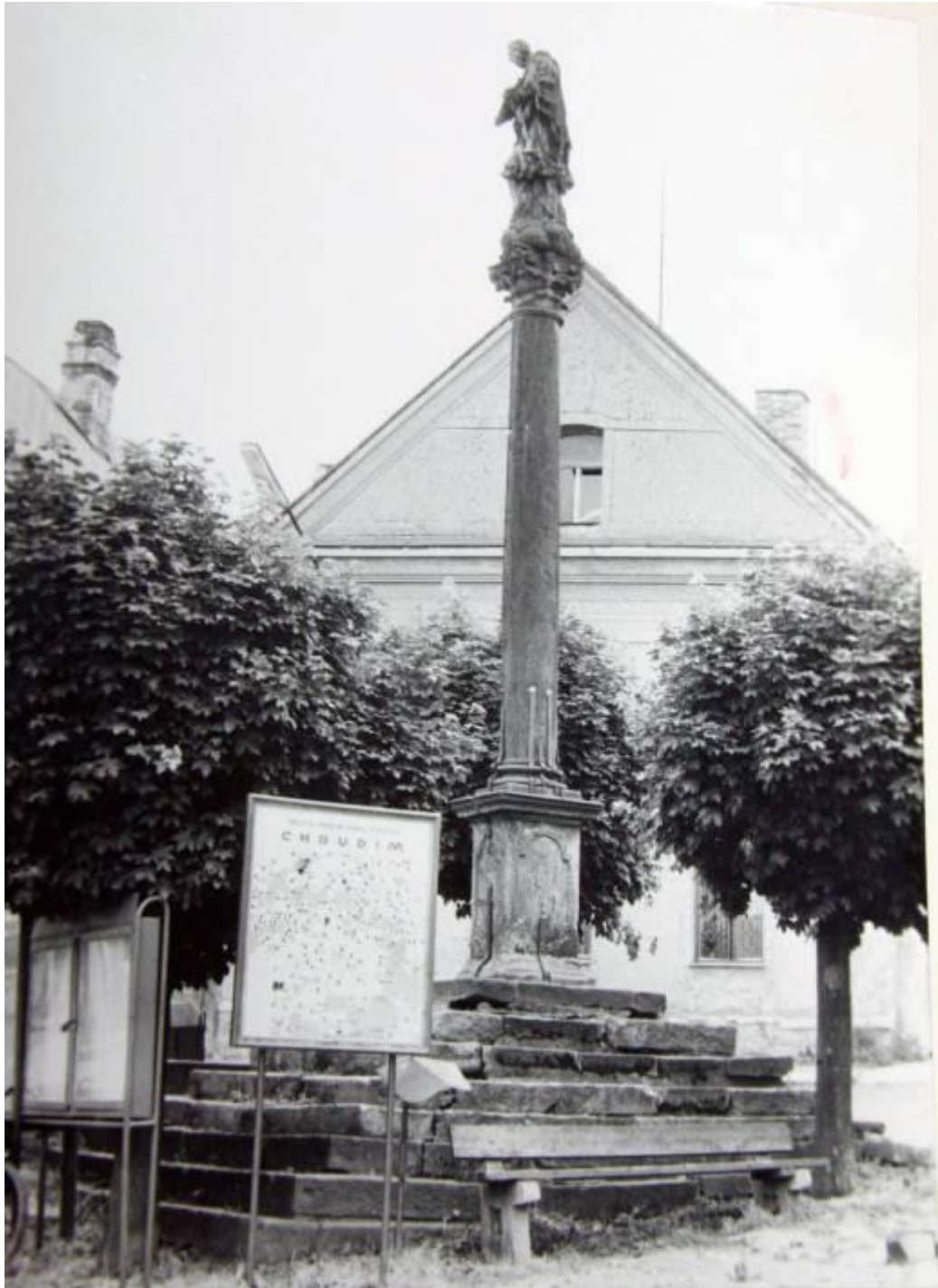
Fotografie č. 1 Socha sv. Jana Nepomuckého na sloupu od západní strany náměstí v Luži. Fotokopie z restaurátorské zprávy z 1988.
