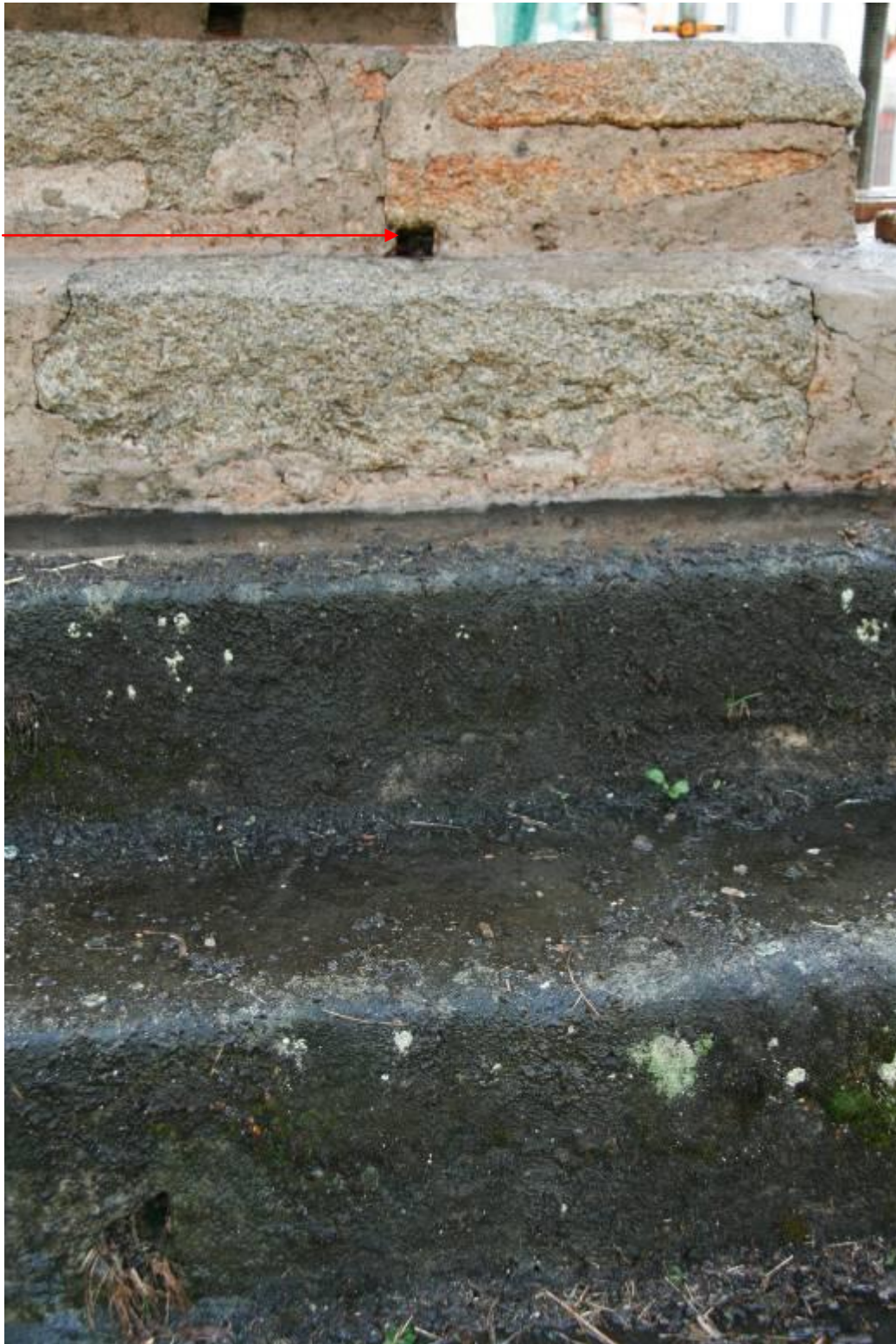
Fotografie č. 59 Čištění schodiště tlakem vody (technologie Wap). Detail otvorů po vyhnílých dřevěných klínech z opravy v roce 1988.
