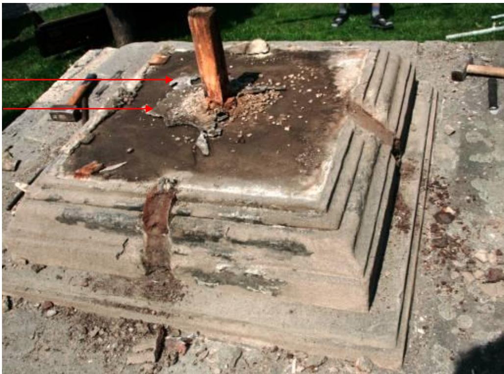
Fotografie č. 66 Profilovaná patka soklu. Zajištění kovového spoje roztaveným olovem.
