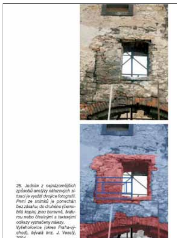
Obr. 128 – Grafická dokumentace nálezové situace - Bláha, J., Jesenský V., Macek, P., Razím V., Sommer, J., Veselý J., Operativní průzkum a dokumentace historických staveb, strana 75
