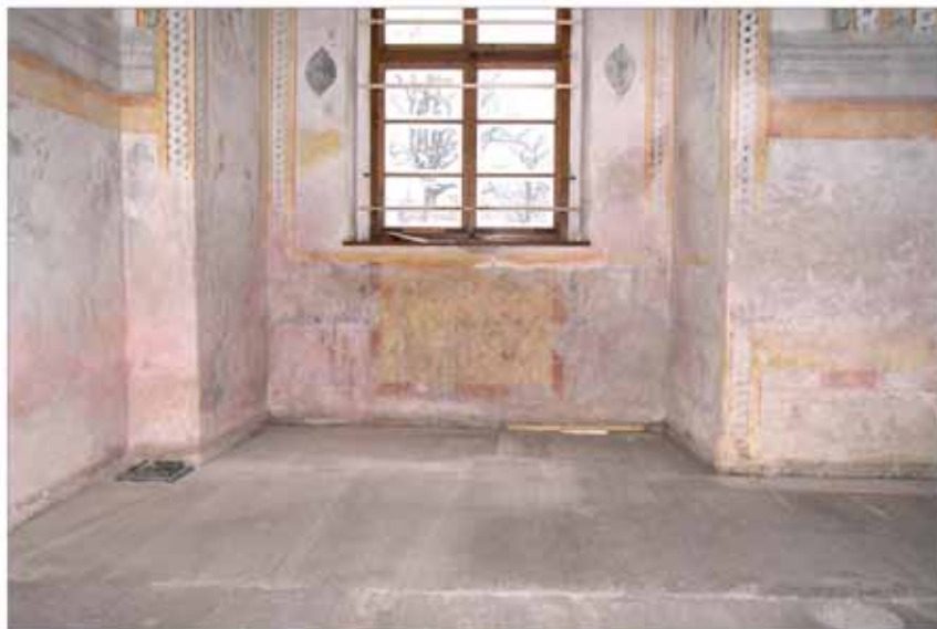
Obr. 19. Soklové partie okenního výklenku (č.26) – růžový povlak na povrchu omítek a patrná hranice poškození omítek vzlinající vlhkostí.
