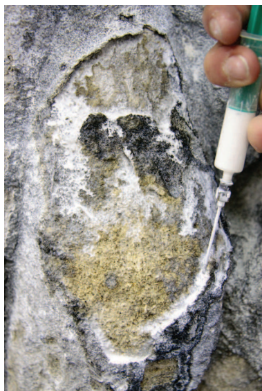
injektáž okrajů krust CaLoSiLem® Pasty
