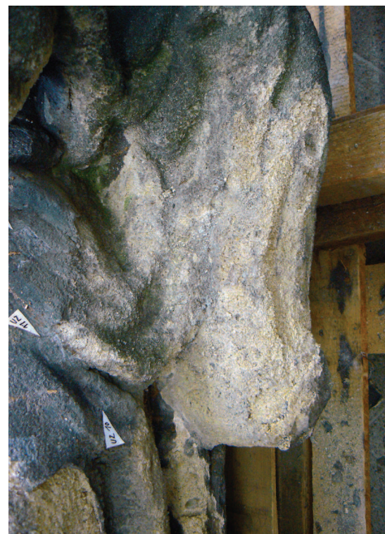
Detail - levé křídlo anděla v průběhu prací - čištění před konsolidací, odstraňování nevhodných tmelů; vlevo povrch křídla pokrytý tmelem; vpravo křídlo po odstranění tmelu
