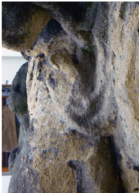
Detail - draperie pod opaskem, levý bok anděla v průběhu prací - čištění před konsolidací, odstraňování nevhodných tmelů; vlevo tmel s provedenou sondáží; vpravo stejné místo po odstranění tmelu
