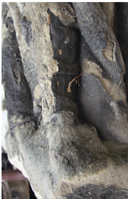
Detail - levá noha anděla - pohled z boku stav před restaurováním
