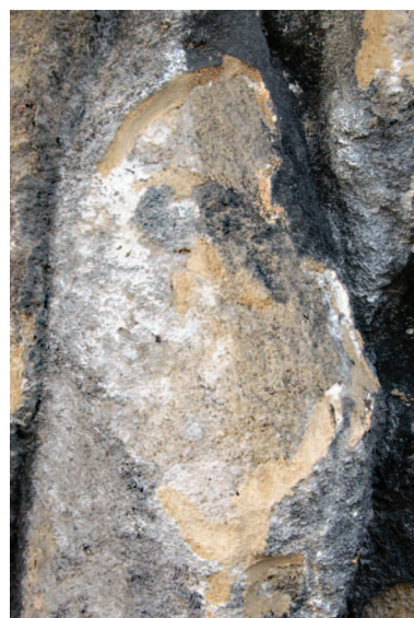
po mokrém čištění následovalo suché čištění; poloviční čištění mikropískováním
