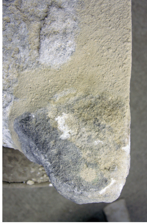
Detail - odlomený levý zadní roh podstavy (z leva a zezadu) v průběhu prací - dotmelení chybějících částí podstavy
