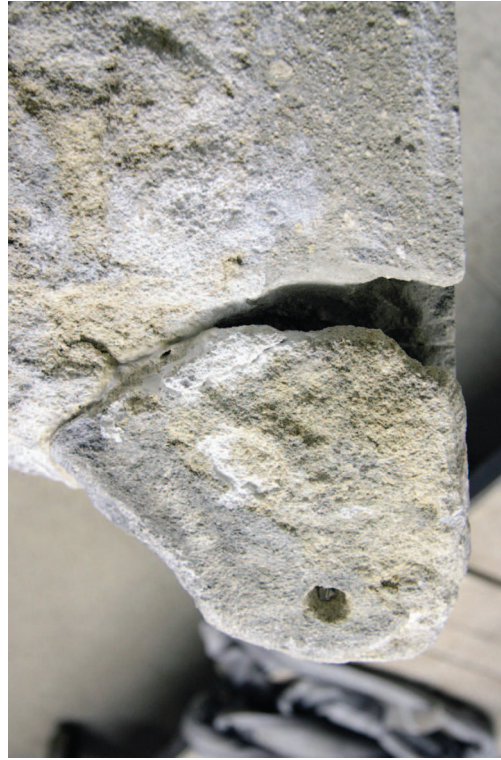
Detail - odlomený levý zadní roh podstavy (z leva a zezadu) v průběhu prací - po dolepení odlomených kusů
