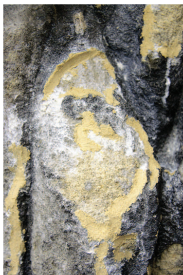
po provedení zajišťovacích tmelů, před čištěním
