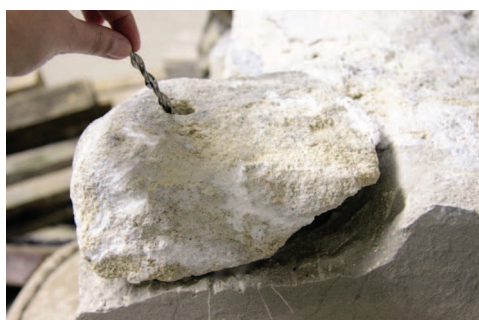
Detail - podstava sochy zezadu dodusané lůžko, kam byly fragmenty dolepeny; fixace čepem HeliBar
