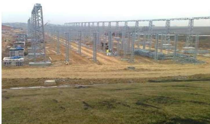
Obrázek 12 - Výstavba nové TR 400/110/22kV Kletné
