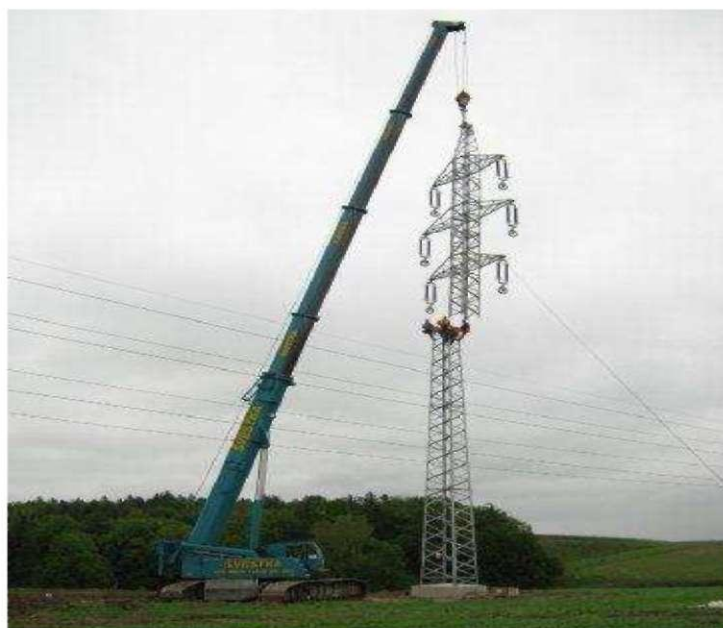
Obrázek 10 - Stavba liniového vedení VVN – TR Chodov – TR Řeporyje
