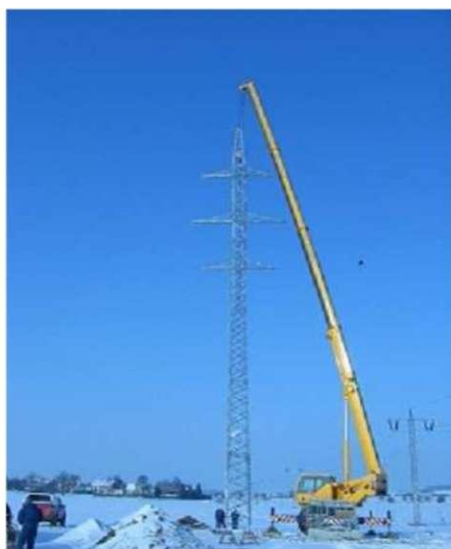
Obrázek 13 - Výstavba liniového vedení VVN – Dluhonice - Hodolany
