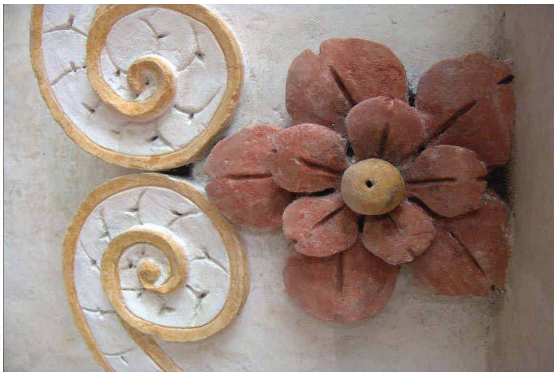
OBR. 67. DETAIL VOLUTOVÉHO ZAKONČENÍ PO RESTAUROVÁNÍ
