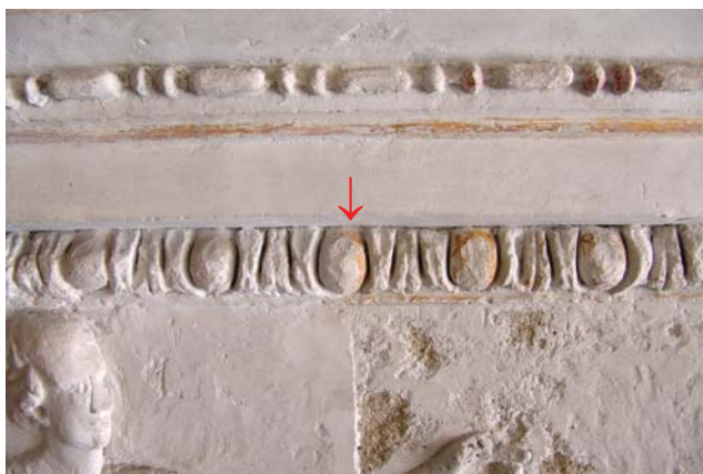
Obr. 40 - Postup odstraňování pačoku a sádrových tmelů, šipkou označena hranice odkryvu
