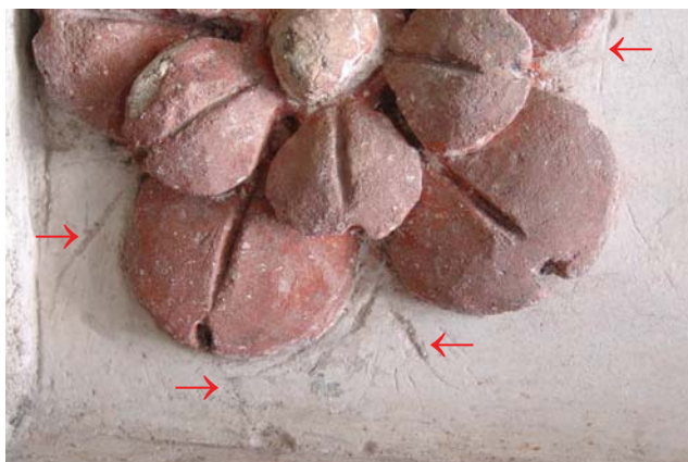
Obr. 33 - Škrábance z předchozího restaurování
