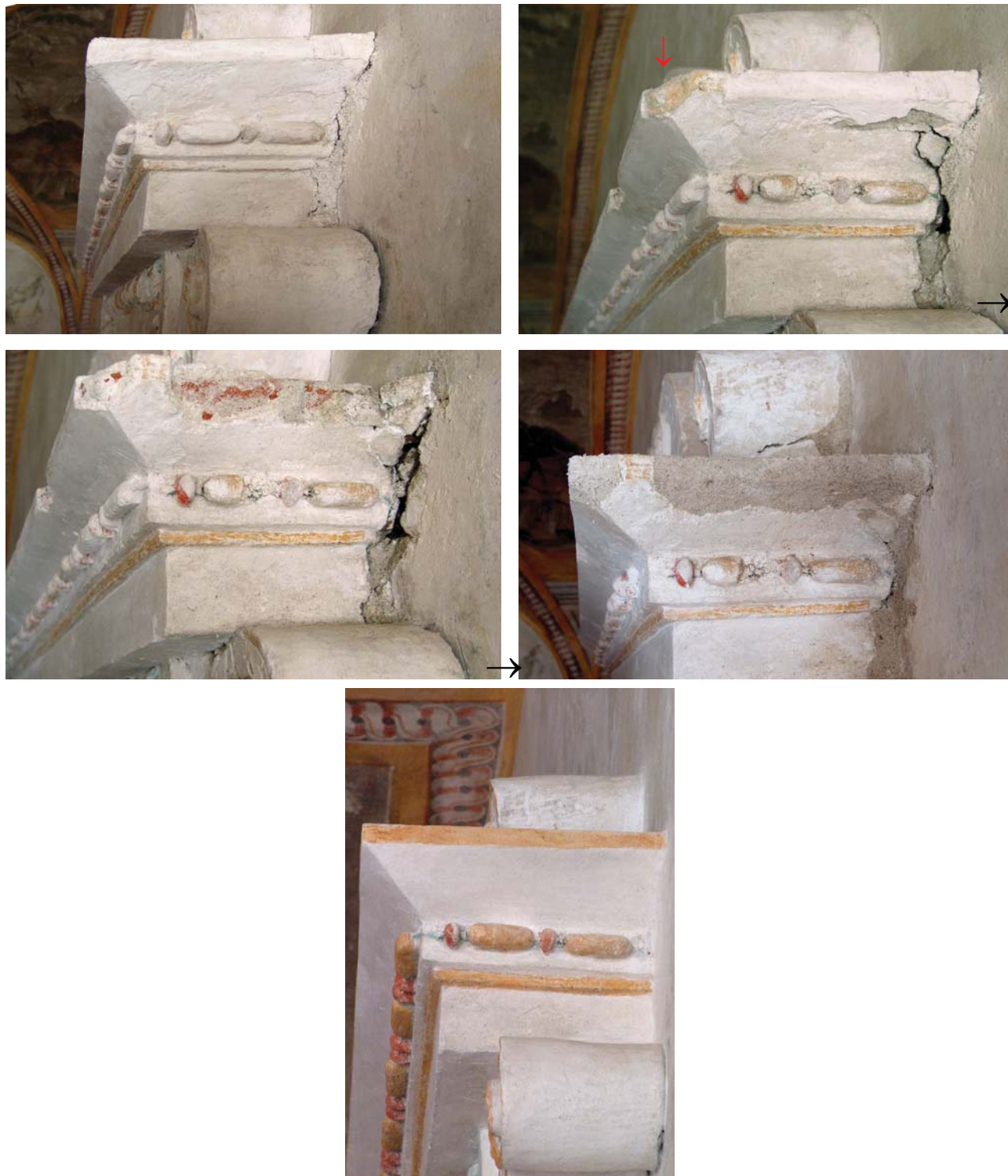
Obr. 56 - Postup odstranění doplňků a opětovné vytmelení pravé části římsy
