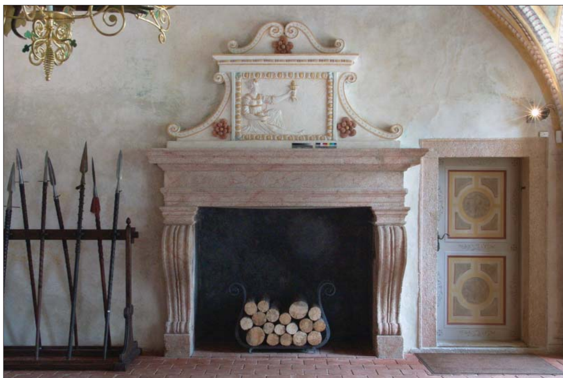
OBR. 105. KRB SE ŠTUKOVÝM NÁSTAVCEM PO RESTAUROVÁNÍ
