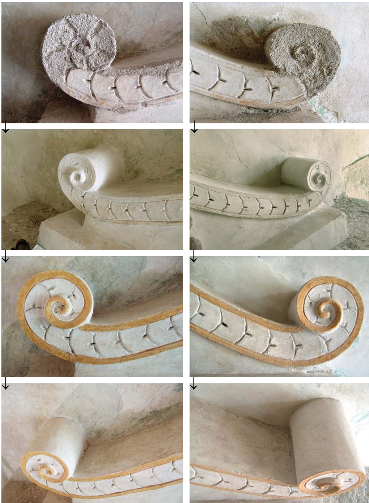
Obr. 53 - Postup odstraňování sádrových zakončení volut 1,2 - nanesení základní tvaru v jádrové maltě 3,4 - voluty po rekonstrukci jemným štukem 5,6 - voluty po rekonstrukci a po retuši 7,8 - stav po rekonstrukci a po retuši, pohled zhora
