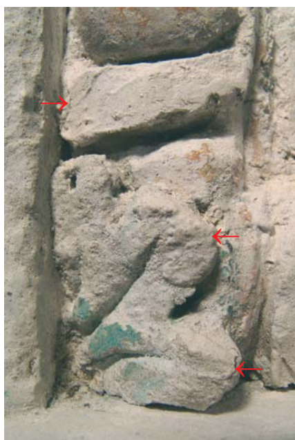
Obr. 37 - Zalití modelace a nevhodné doplnění.
