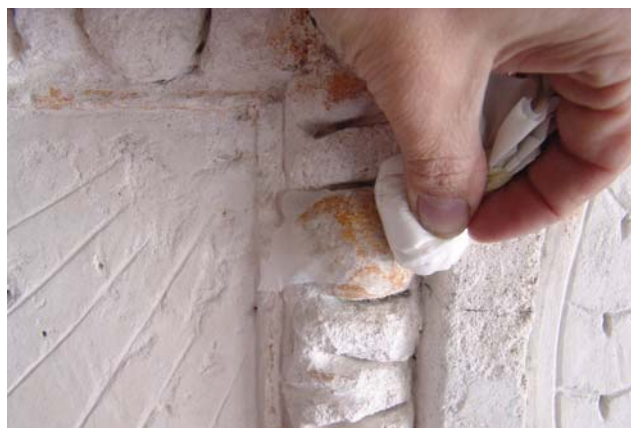
Obr. 44 - Přitahování tampónky
