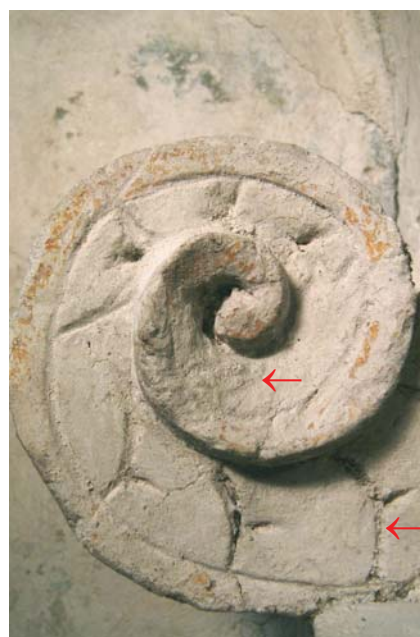
Obr. 38 - Zalití hloubek druhotnými nátěry.
