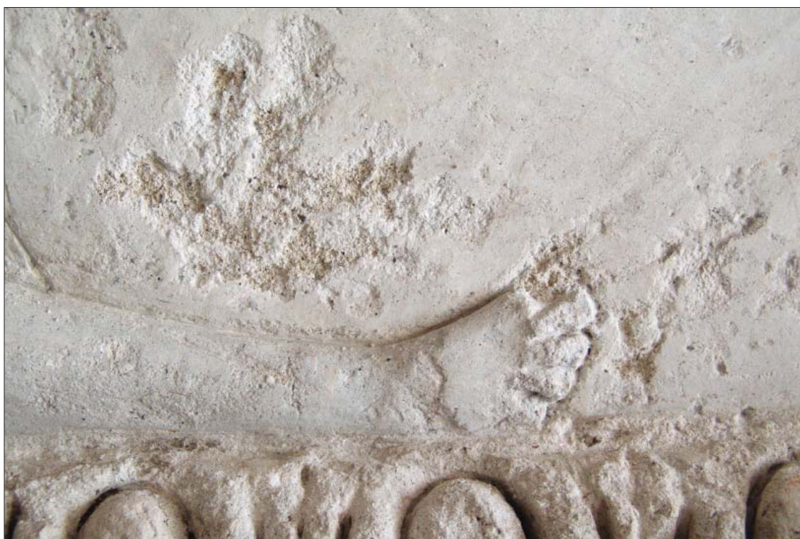
OBR. 93. NOHA FIGURY PO ODKRYVU A ODSTRANĚNÍ TMELŮ
