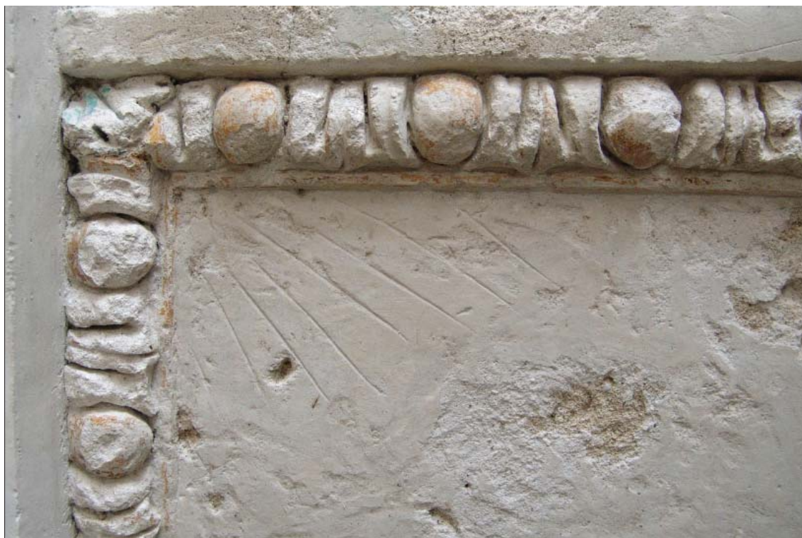
OBR. 99. PRAVÝ HORNÍ ROH VEJCOVCOVÉHO RÁMU POLE S FIGUROU PO ODKRYVU A PO ODSRTANĚNÍ TMEĚŮ
