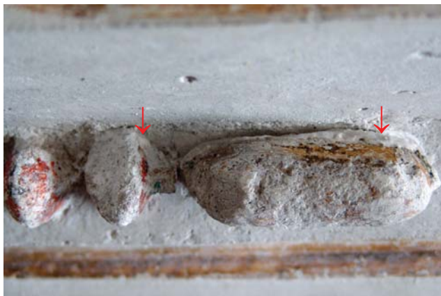
Obr. 47 - Kulička a váleček vejcovce přilepený na sádru a vlivem toho vystupují nad ostatní články.
