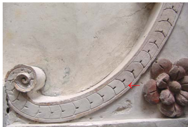
Obr. 41 - Postup odstraňování překryvných nátěrů, šipkou označena hranice odkryvu
