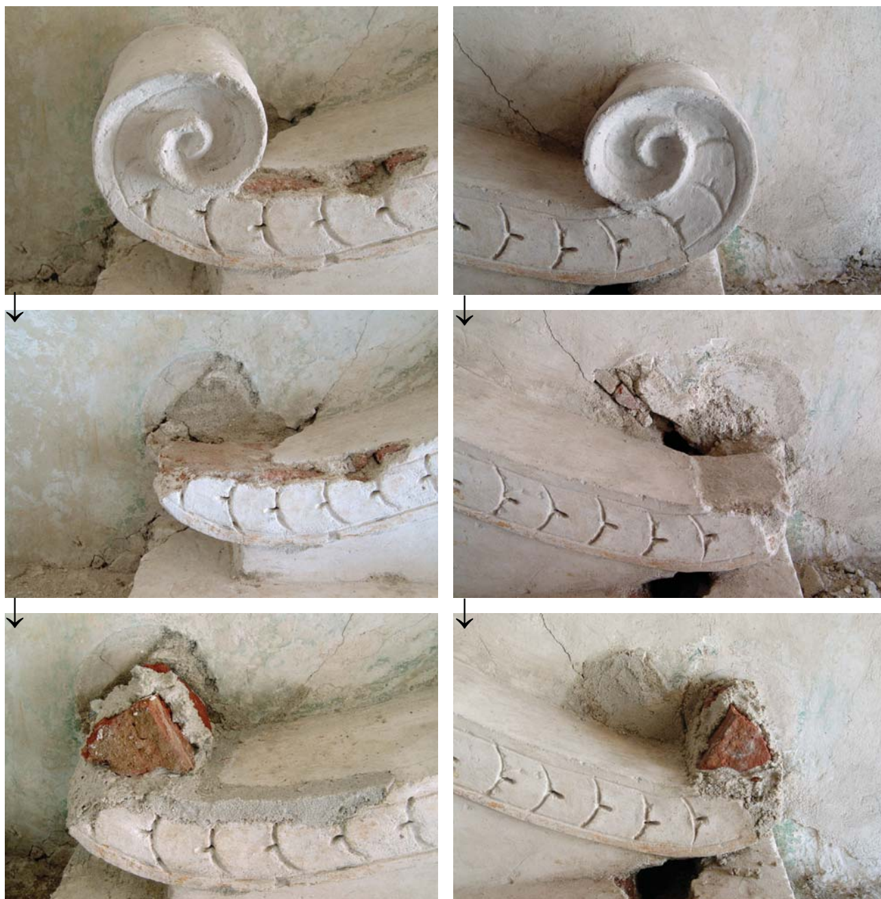
Obr. 52 - Postup odstraňování sádrových zakončení volut 1,2 - sádrové tmely 3,4 - odstraněné voluty, zřetelný otisk původních volut 5,6 - jádro armované cihlou
