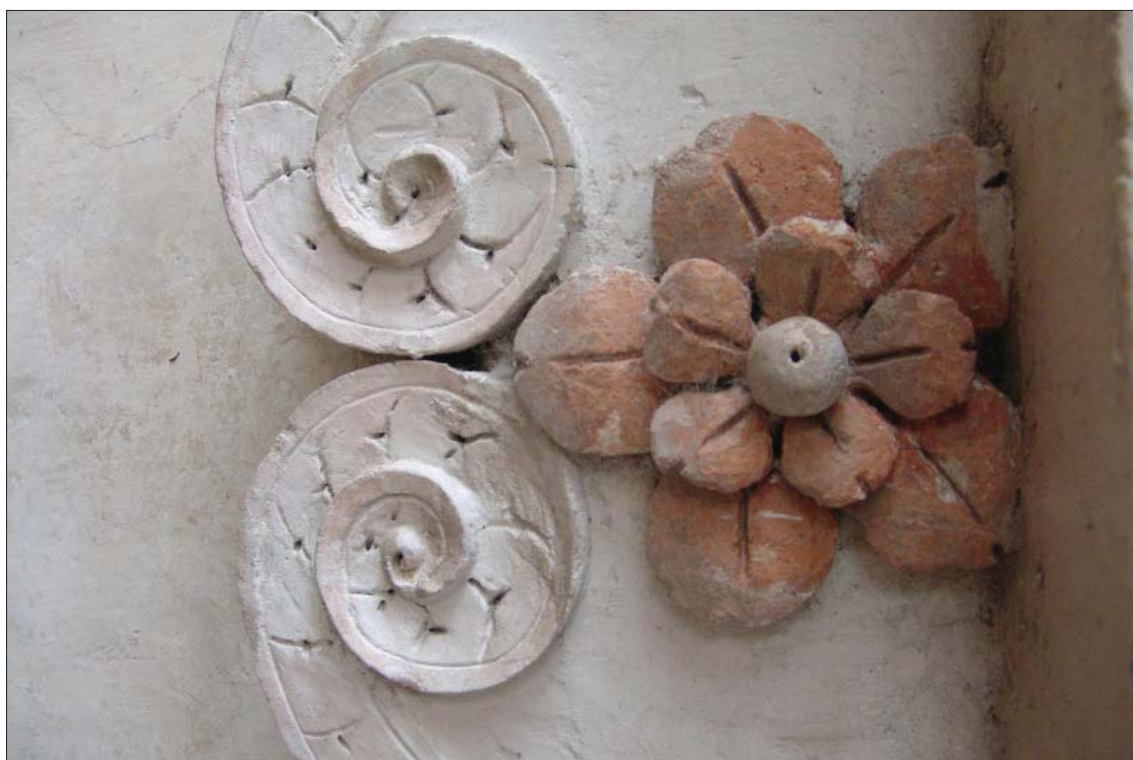
OBR. 66. DETAIL VOLUTOVÉHO ZAKONČENÍ PŘED RESTAUROVÁNÍM
