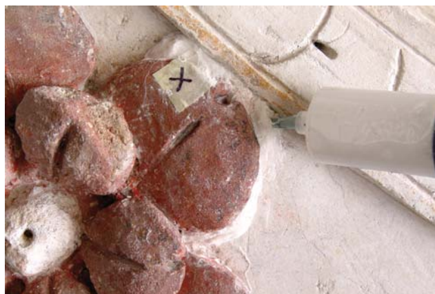
Obr. 46 - Aplikace groutu do navrtaných děr.
