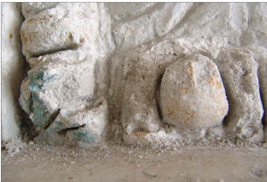
OBR. 102. LEVÝ DOLNÍ ROH RÁMU POLE S FIGUROU PO ODSTRANĚNÍ TMELŮ
