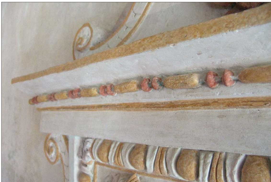
OBR. 65. DETAIL ŘÍMSY PO RESTAUROVÁNÍ
