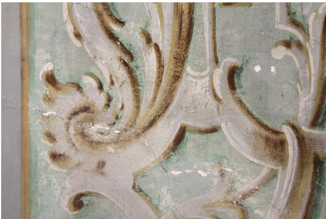
Obr. 22. Stav malby po očištění a vytmelení.
