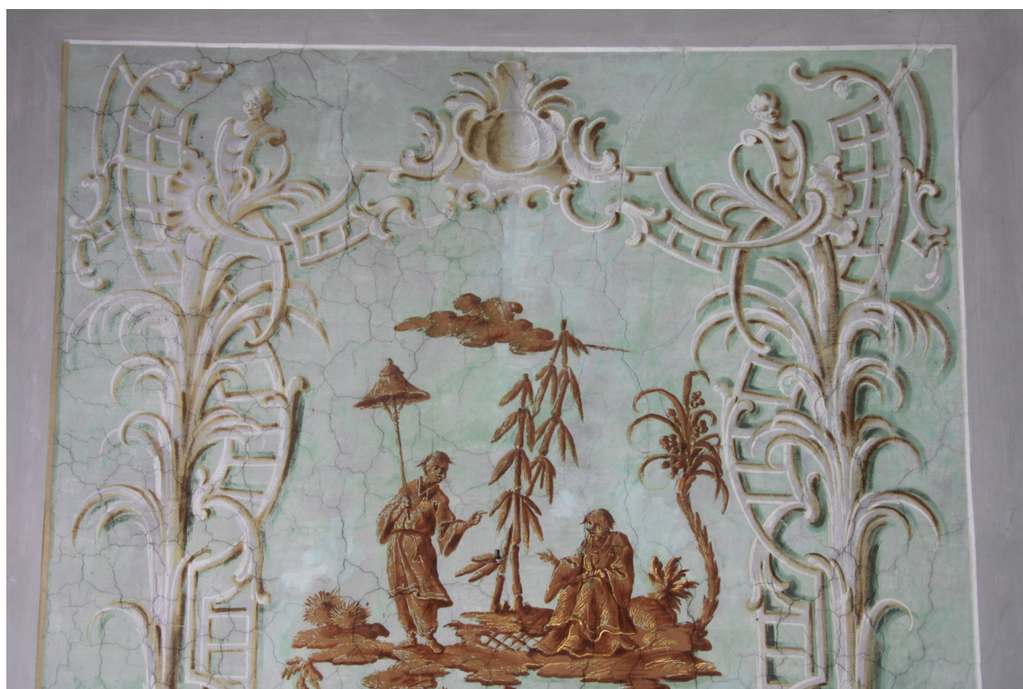
Obr. 21. V pravé polovině obrázku je malba vyčištěná, po čištění došlo k úbytku značného množství vlasových prasklin.
