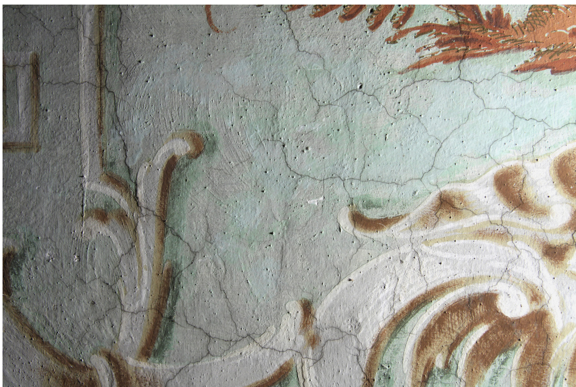
Obr. 11. Razantní (boční) nasvícení mého úseku, stav před restaurováním. Velice dobře jsou čitelná veškerá poškození barevné vrstvy, síťové praskliny, stékance barvy a propadlá místa. Zřetelněji se vykreslila štětcová struktura malby.
