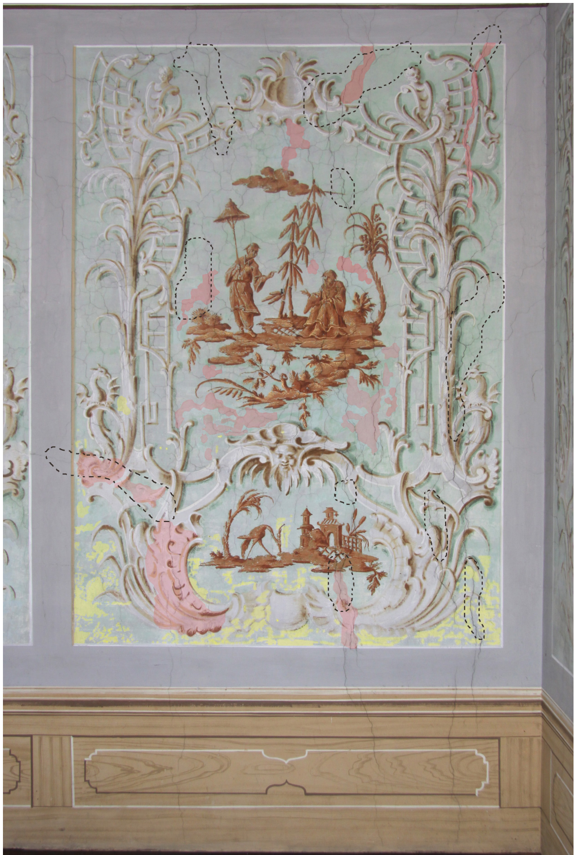
Obr. 3. Grafická dokumentace neinvazivního průzkumu. Plošně žlutě jsou vyznačena místa poškození barevné vrstvy otěrem, ztráta čitelnosti tvarů či úplná ztráta barevné vrstvy. Plošně červeně jsou vyznačena místa přemaleb. Černá přerušovaná linie značí domnělé dutiny v omítkové vrstvě.
