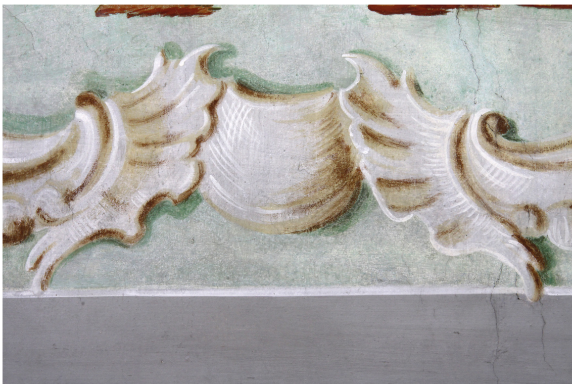
Obr. 30. Stav po restaurování. Byla doplněna světla a stíny rokajů do té míry, až se původní tvary staly opět čitelnými a hmotnými.
