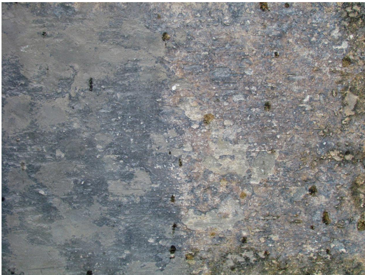
Snímek 21 – konzole detail, stav po čištění abrazivní metodou před odsolováním
