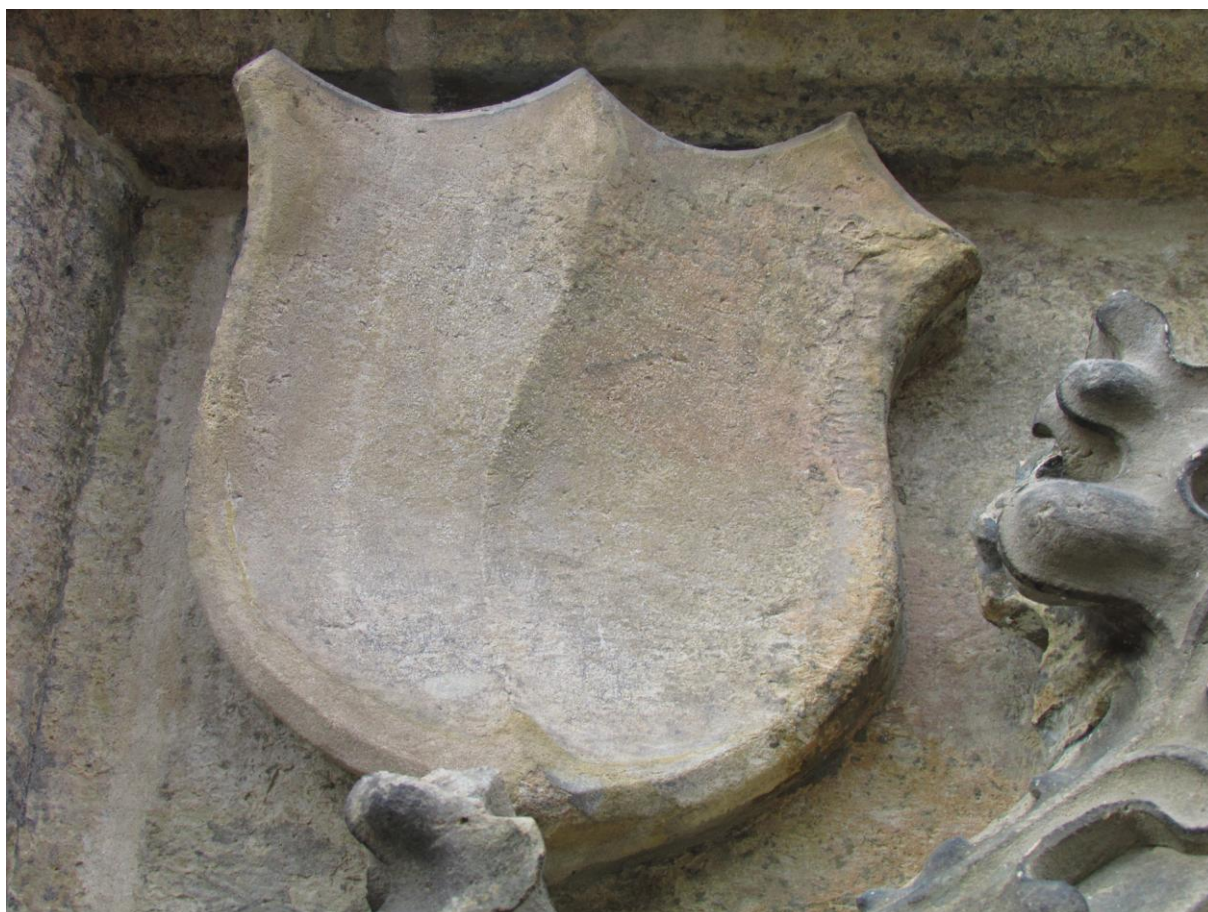
Snímek 55 – erb pod korunní římsou detail, stav po ukončení plastické a barevné retuše
