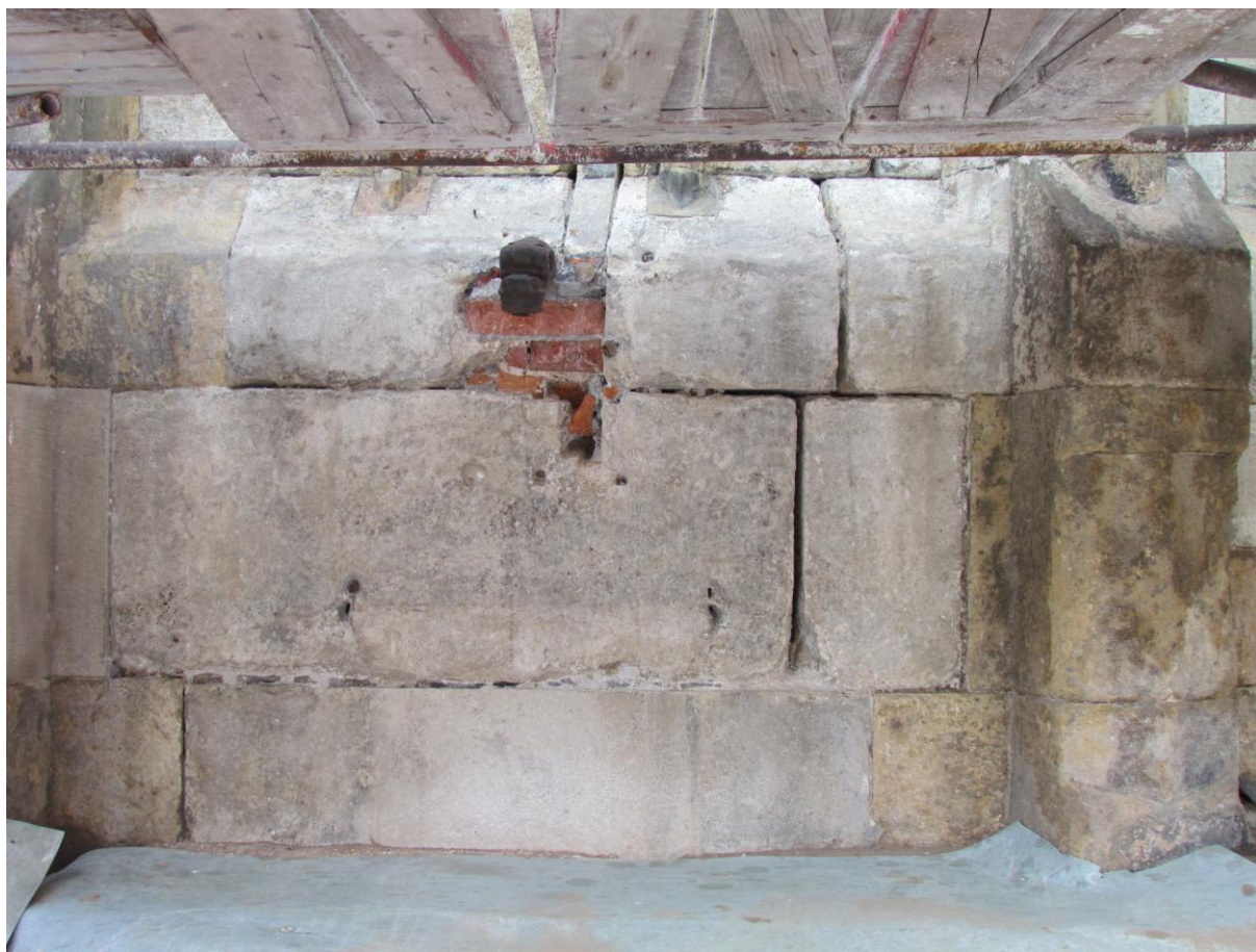
Snímek 40 – chrlič detail, odkrytá vyzdívka
