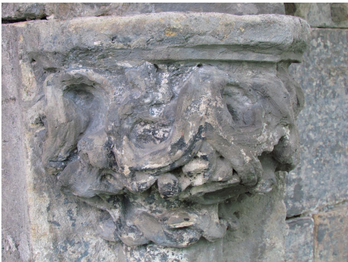
Snímek 21 – konzole detail, stav po čištění abrazivní metodou před odsolováním
