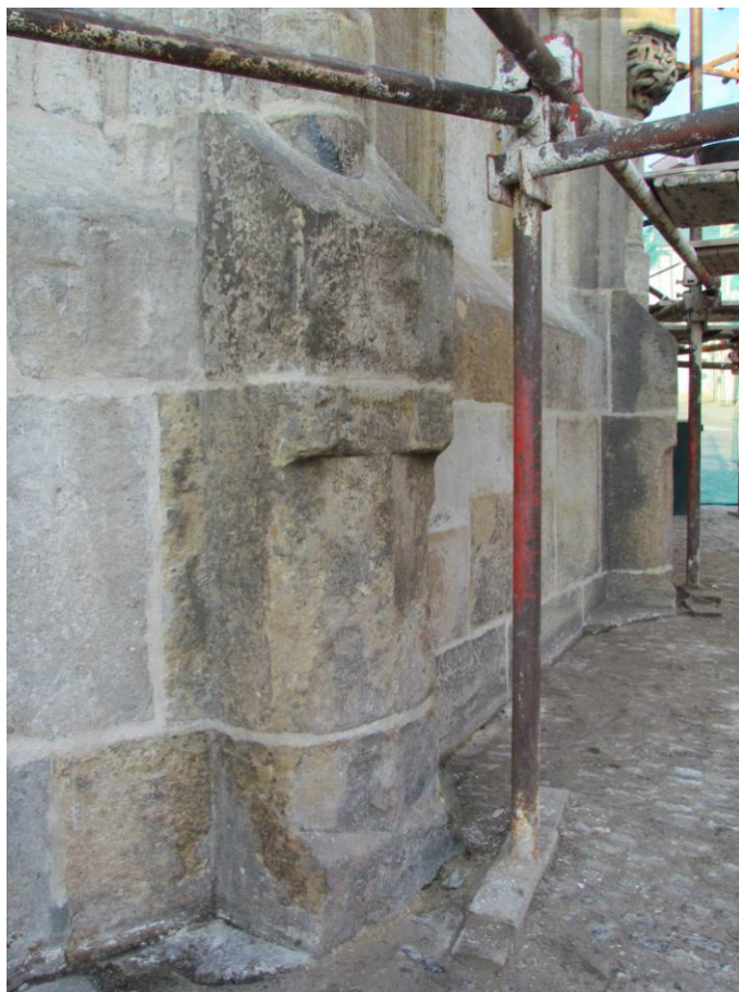
Snímek 75 a 76 – spodní část, pilíř, srovnání stavu před restaurováním (dole) a po ukončení restaurátorských prací (1. fáze barevné retuše)
