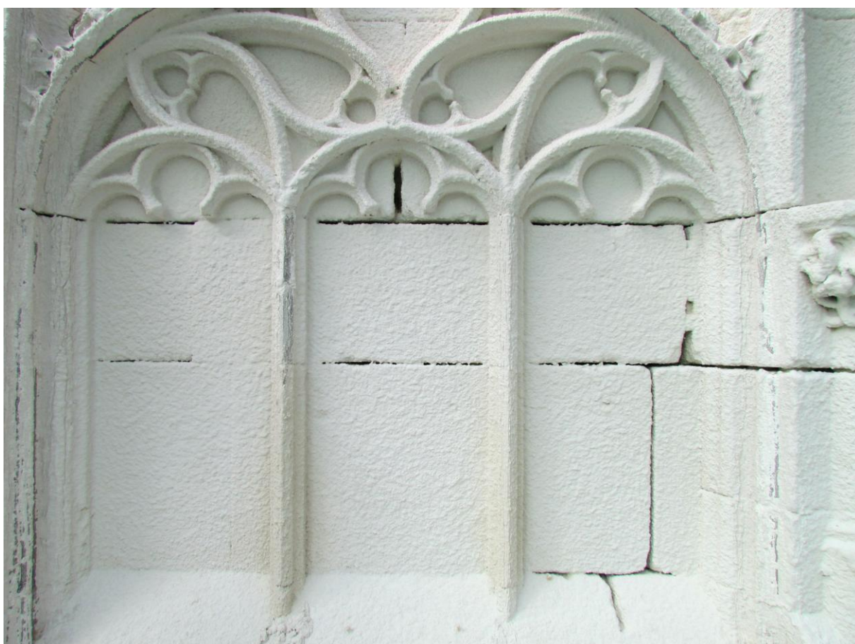
Snímek 25 – střed pole, průběh odsolování
