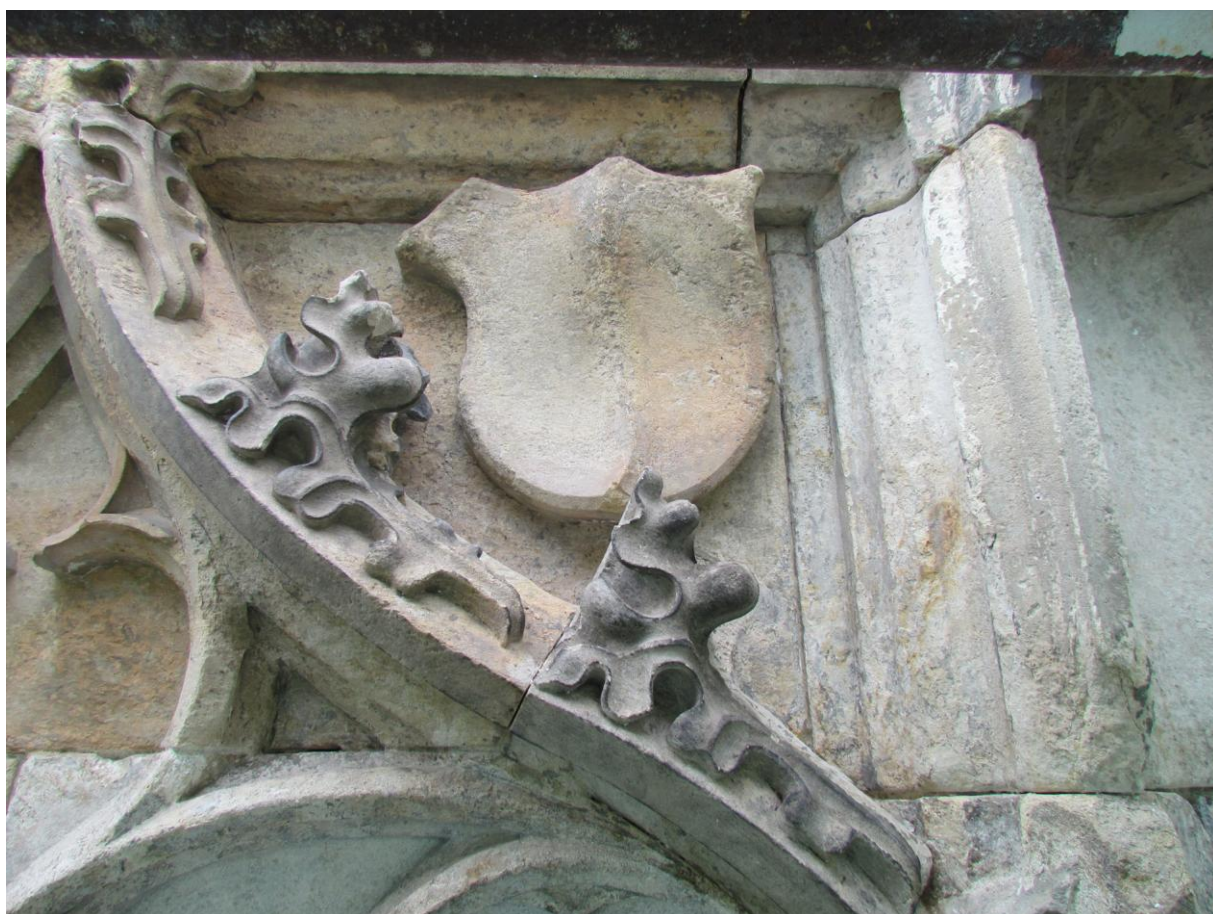
Snímek 33 - cvikl s erbem, kraby, stav po čištění abrazivní met. po odsolování
