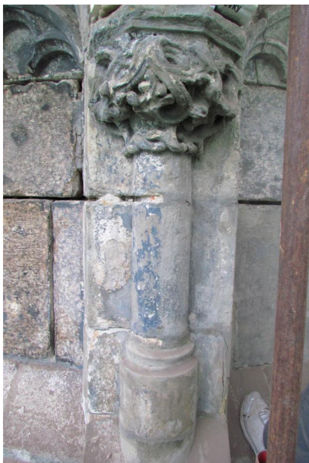
Snímek 19 – pilíř, průběh čištění abrazivní metodou před odsolováním
