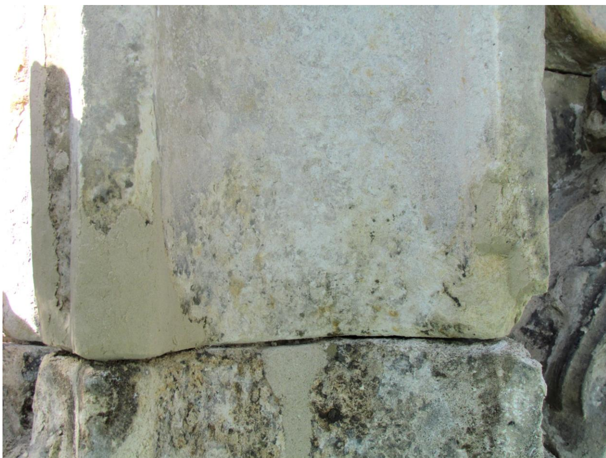
Snímek 49 – výklenek, průběh plastické retuše, srovnání (vpravo konzervační tmel)
