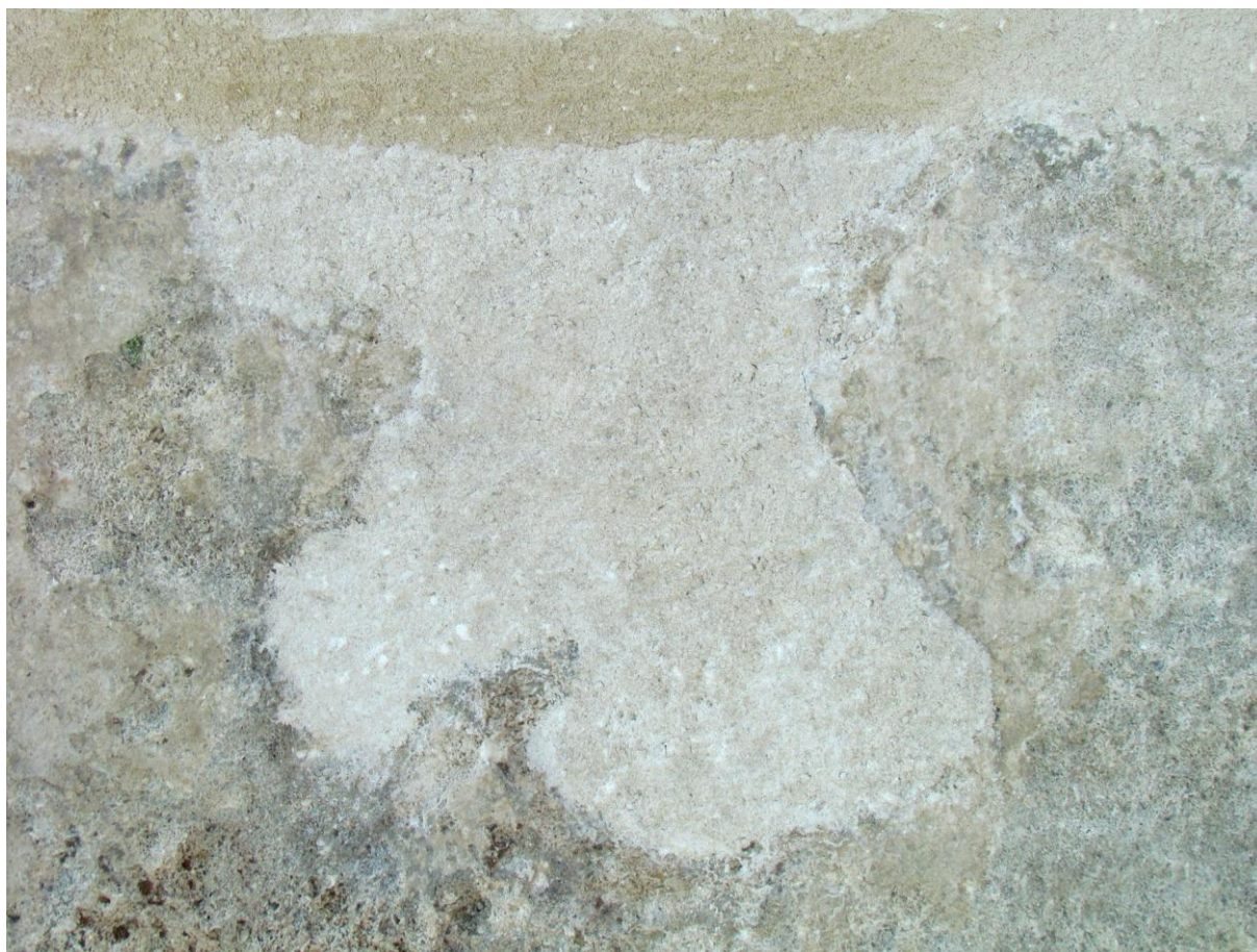
Snímek 53 - spodní část, tmel detail, stav po ukončení barevné retuše
