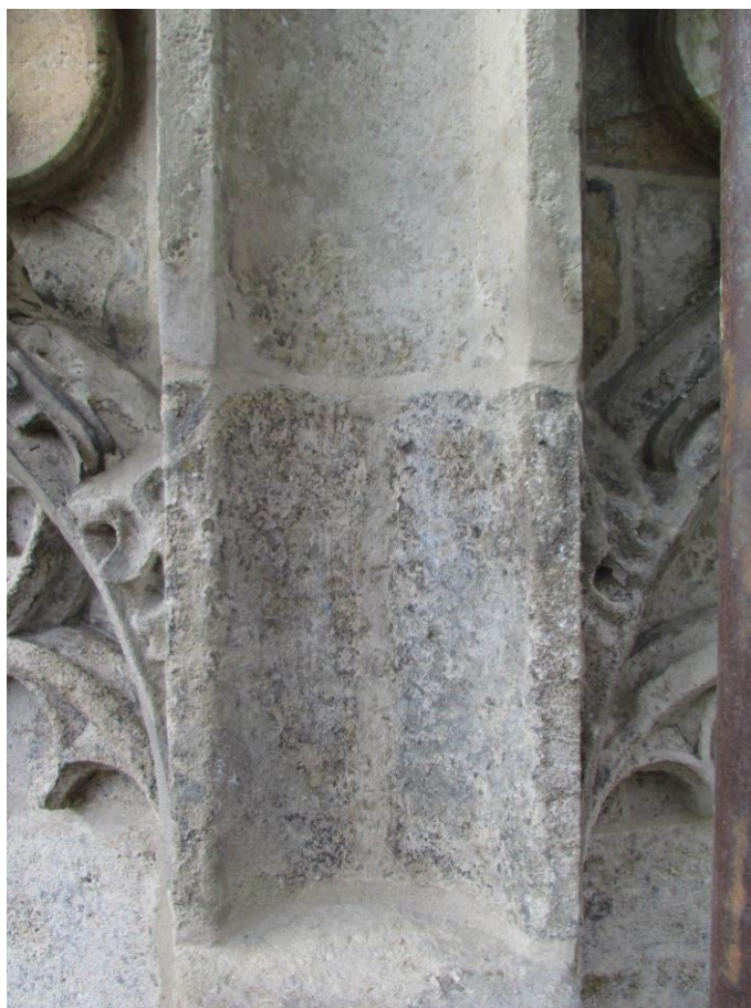
Snímek 65 a 66 – výklenek, srovnání stavu před restaurováním (dole) a po ukončení restaurátorských prací (1. fáze barevné retuše)
