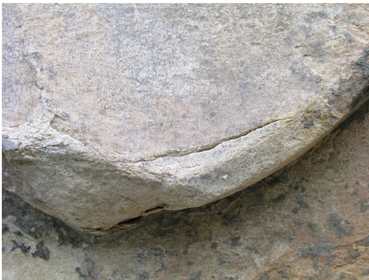
Snímek 42 - erb detail, prasklina
