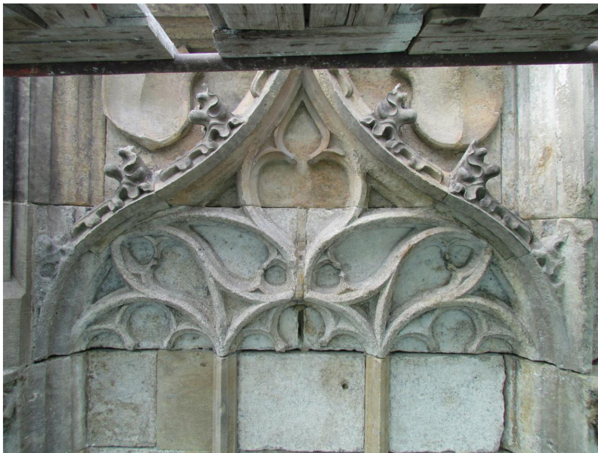
Snímek 37 – kružby, oslí hřbet, stav po čištění abrazivní met. po odsolování
