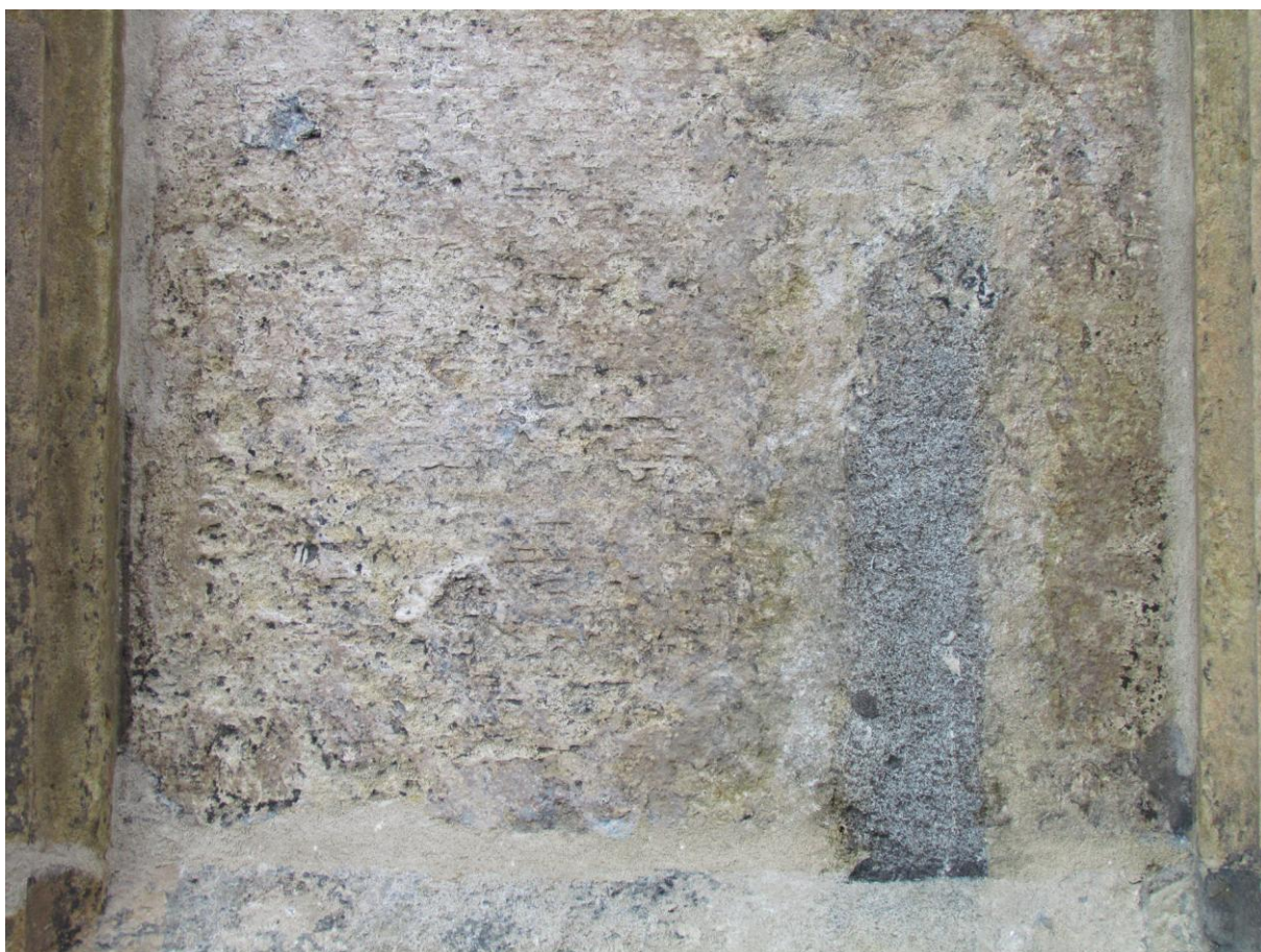
Snímek 58 – kamenná vložka detail, stav po ukončení plastické a barevné retuše
