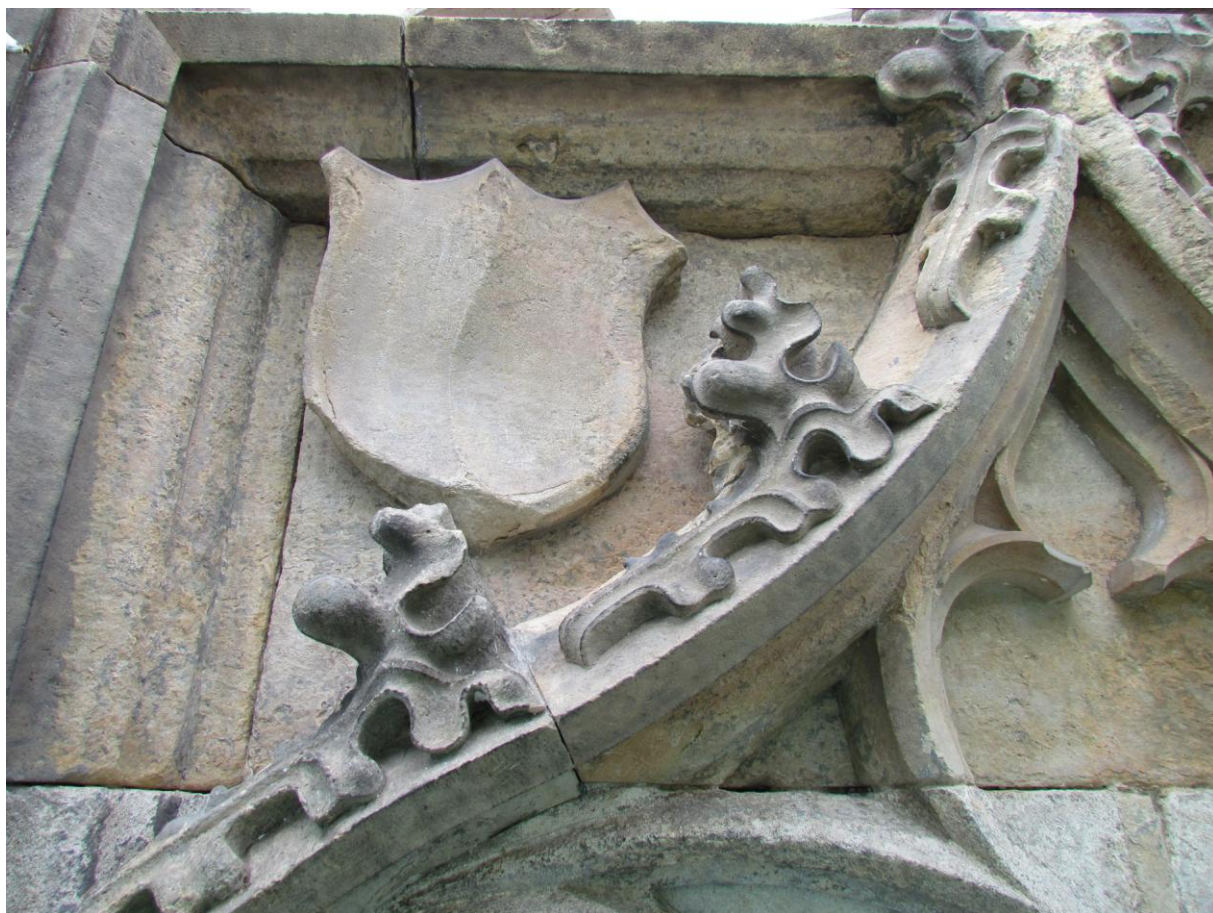
Snímek 32 - cvikl s erbem, kraby, stav po čištění abrazivní met. po odsolování
