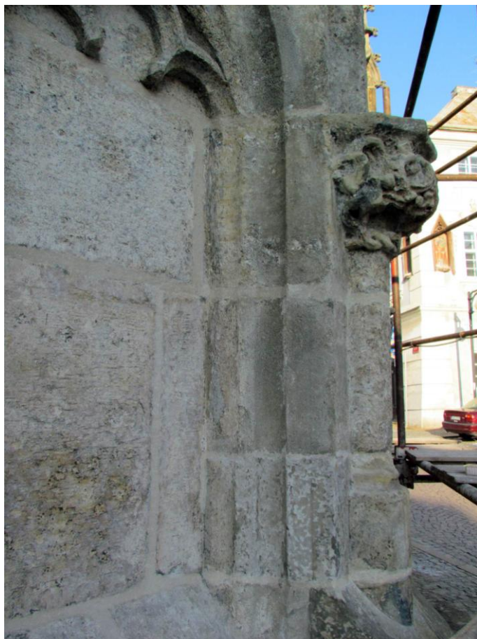
Snímek 69 a 70 – střední část a pilíř, srovnání stavu před restaurováním (dole) a po ukončení restaurátorských prací (1. fáze barevné retuše)
