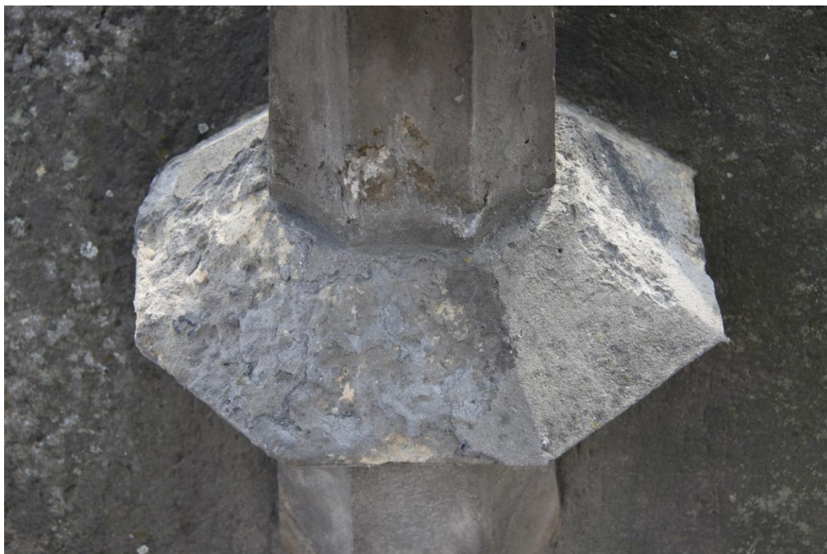
Snímek 12 – vrcholová kytka detail, po odstranění vyžilých tmelů
