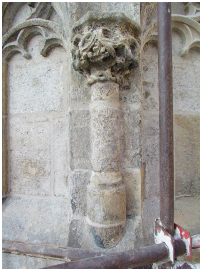
Snímek 63 a 64 – pilíř, srovnání stavu před restaurováním (dole ) a po ukončení restaurátorských prací (1. fáze barevné retuše)
