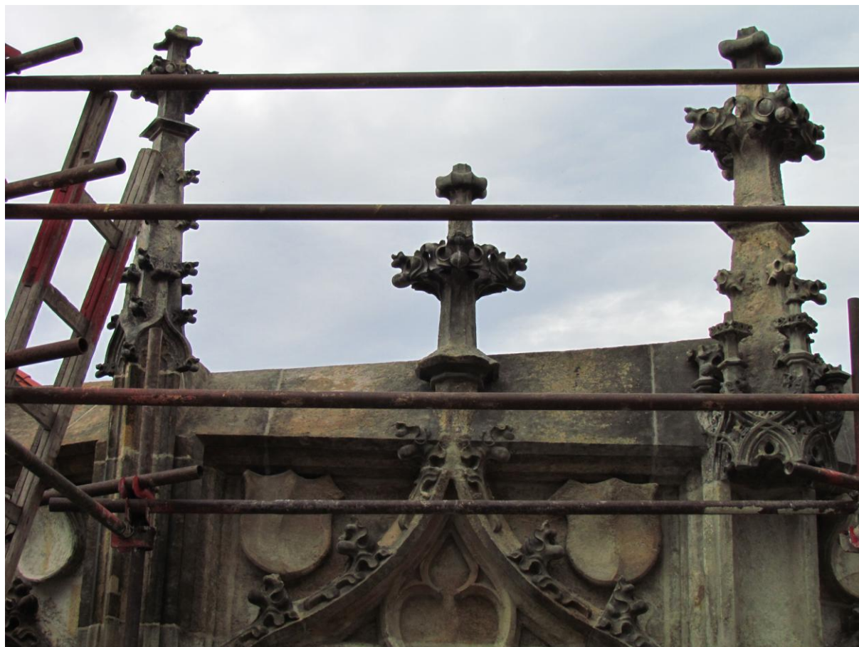
Snímek 61 – kružby a střední část, stav po ukončení 1. fáze barevné retuše
