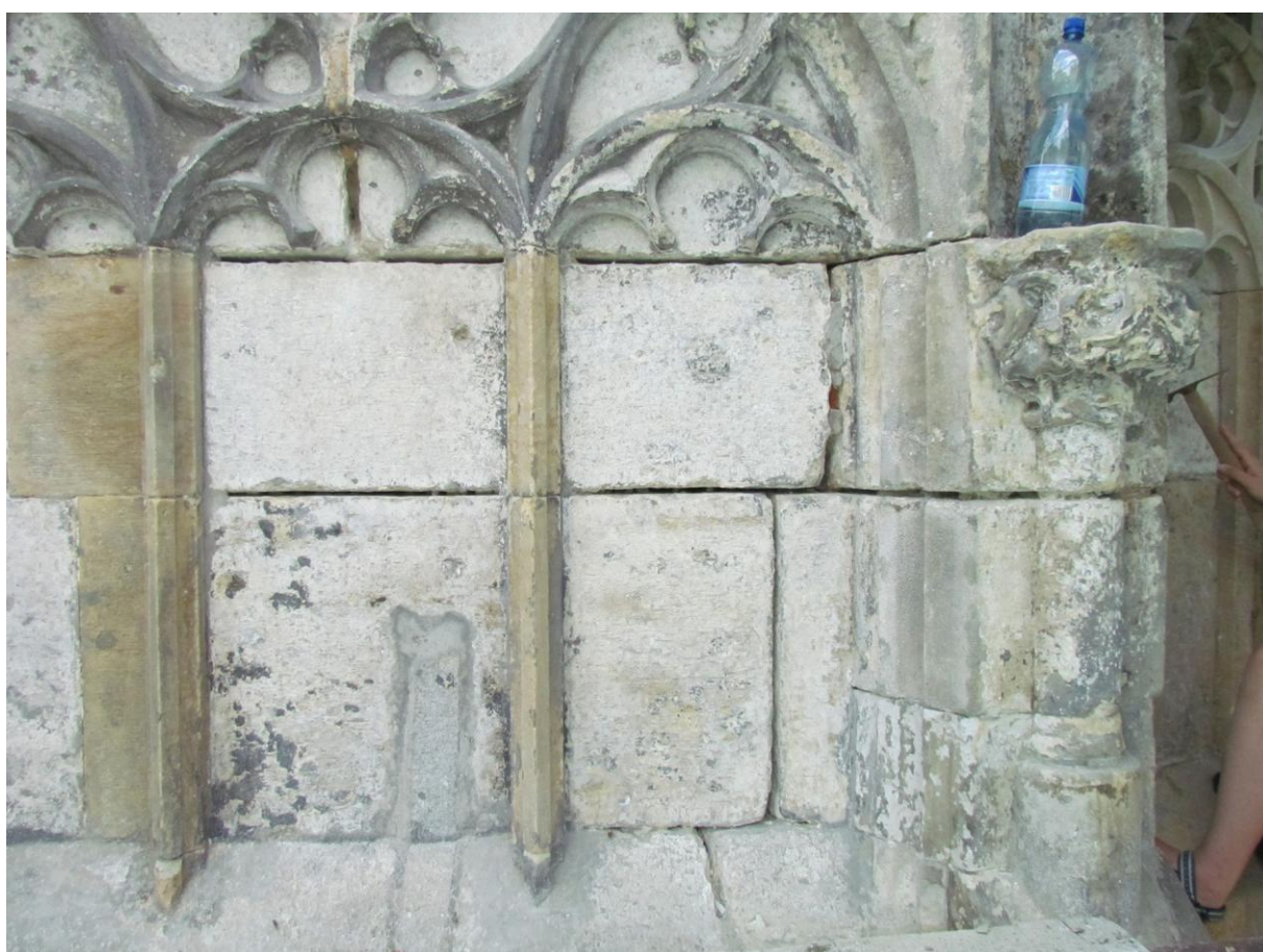
Snímek 29 – střed pole, pilíř, stav po ukončení odsolování
