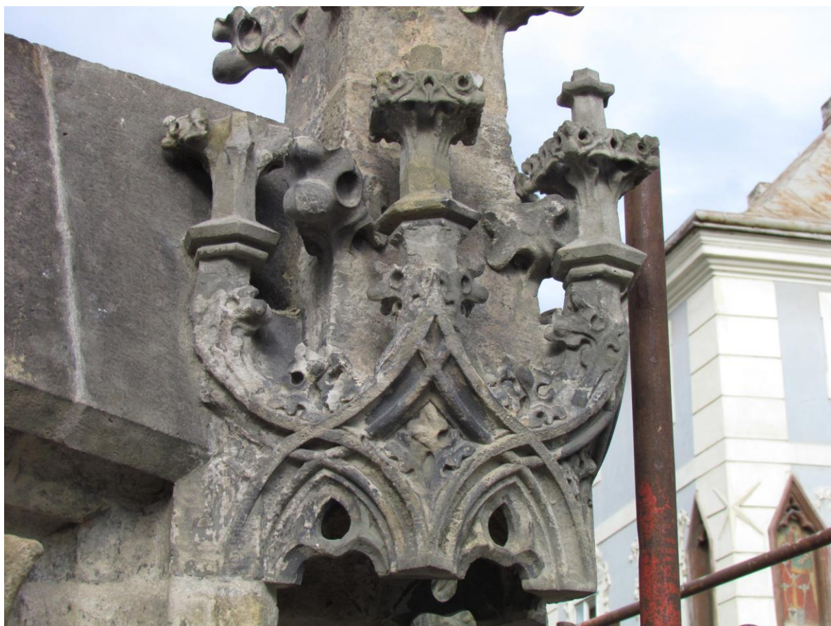
Snímek 77 a 78 – baldachýn detail, srovnání stavu před restaurováním (dole) a po ukončení restaurátorských prací (1. fáze barevné retuše)
