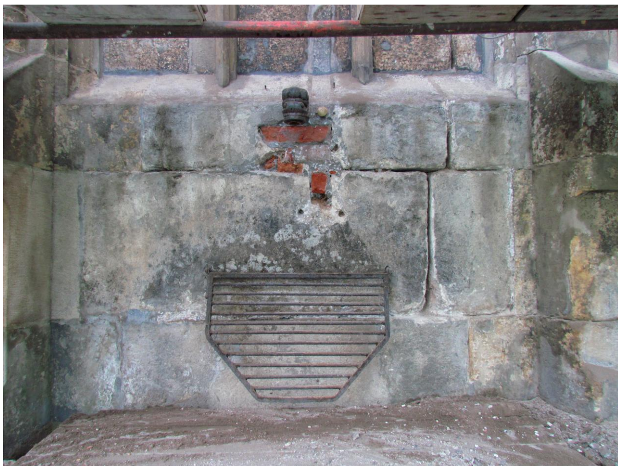
Snímek 17 – spodní část pole, průběh odstraňování spár
