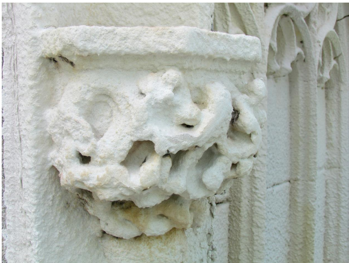
Snímek 26 – konzole detail, průběh odsolování
