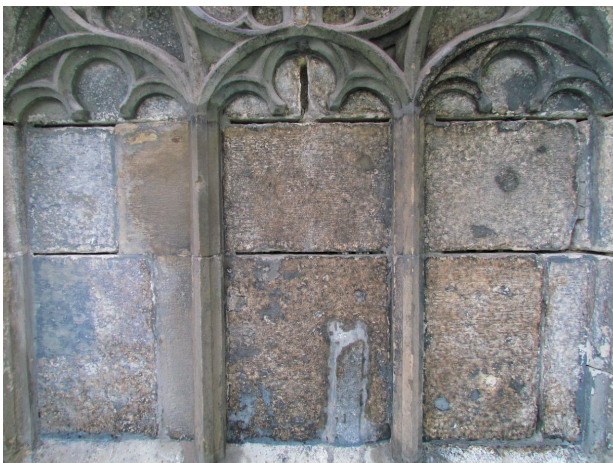
Snímek 23 – střed pole, stav po čištění abrazivní metodou před odsolováním
