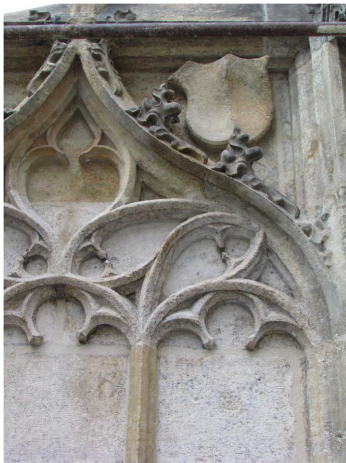
Snímek 71 a 72 – cvikl, kružby a oslí hřbet, srovnání stavu před restaurováním (dole) a po ukončení restaurátorských prací (1. fáze barevné retuše)
