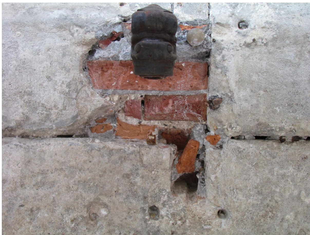
Snímek 40 – chrlič detail, odkrytá vyzdívka
