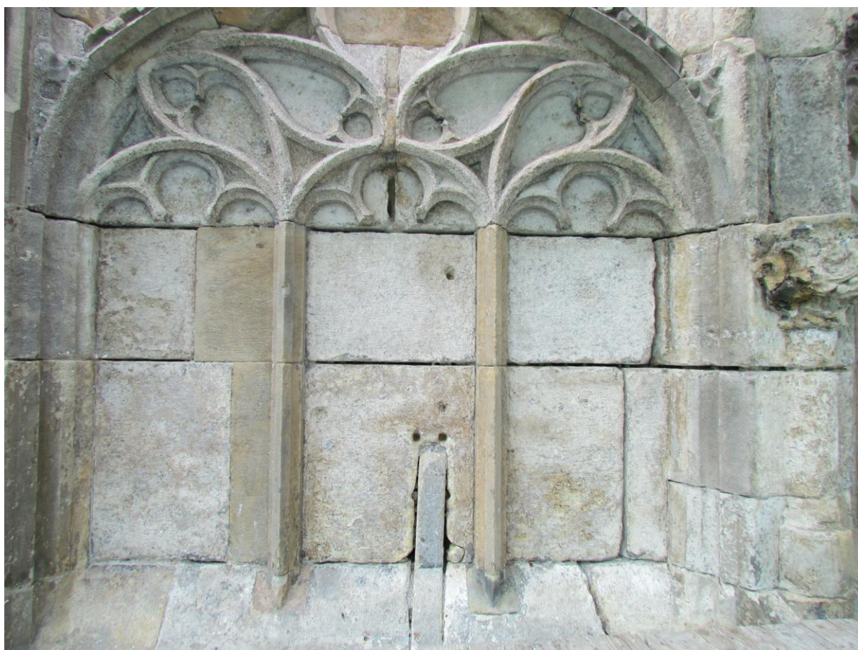
Snímek 38 – střed pole, stav po čištění abrazivní metodou po odsolování
