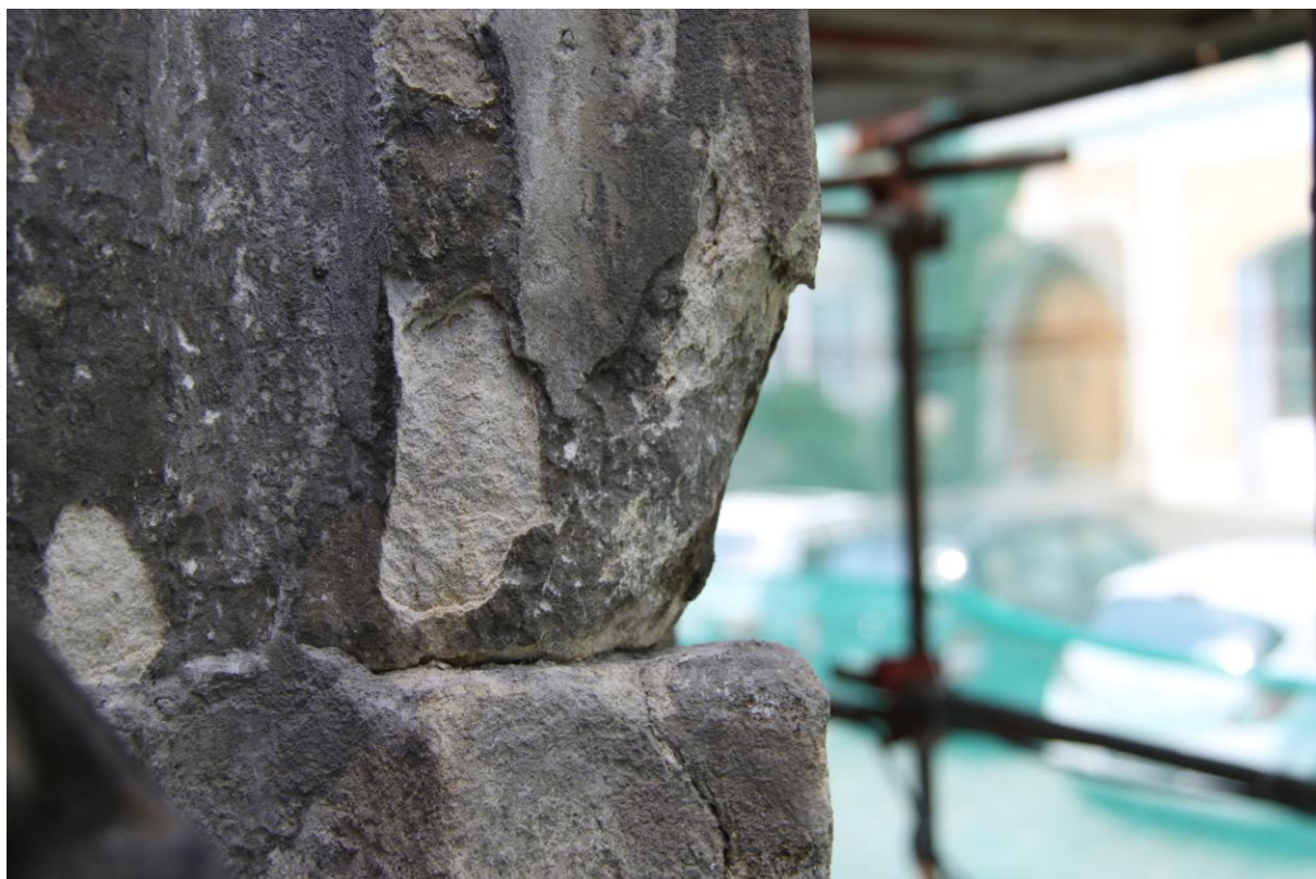
Snímek 14 - výklenek detail, po odstranění vyžilých tmelů
