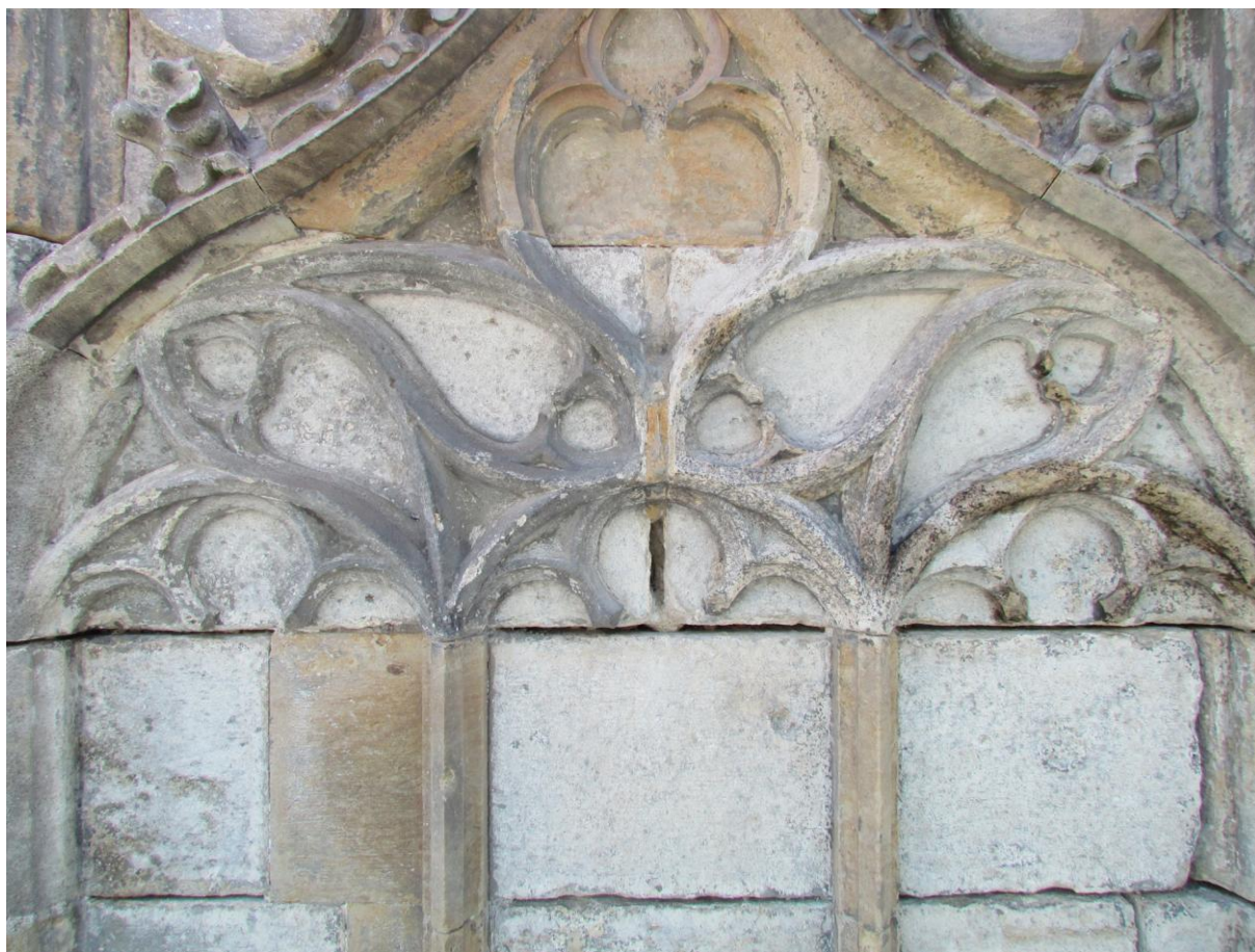
Snímek 30 – kružby, průběh čištění abrazivní metodou po odsolování
