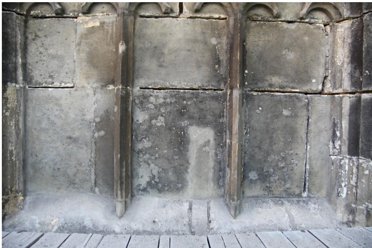
Snímek 17 – spodní část pole, průběh odstraňování spár
