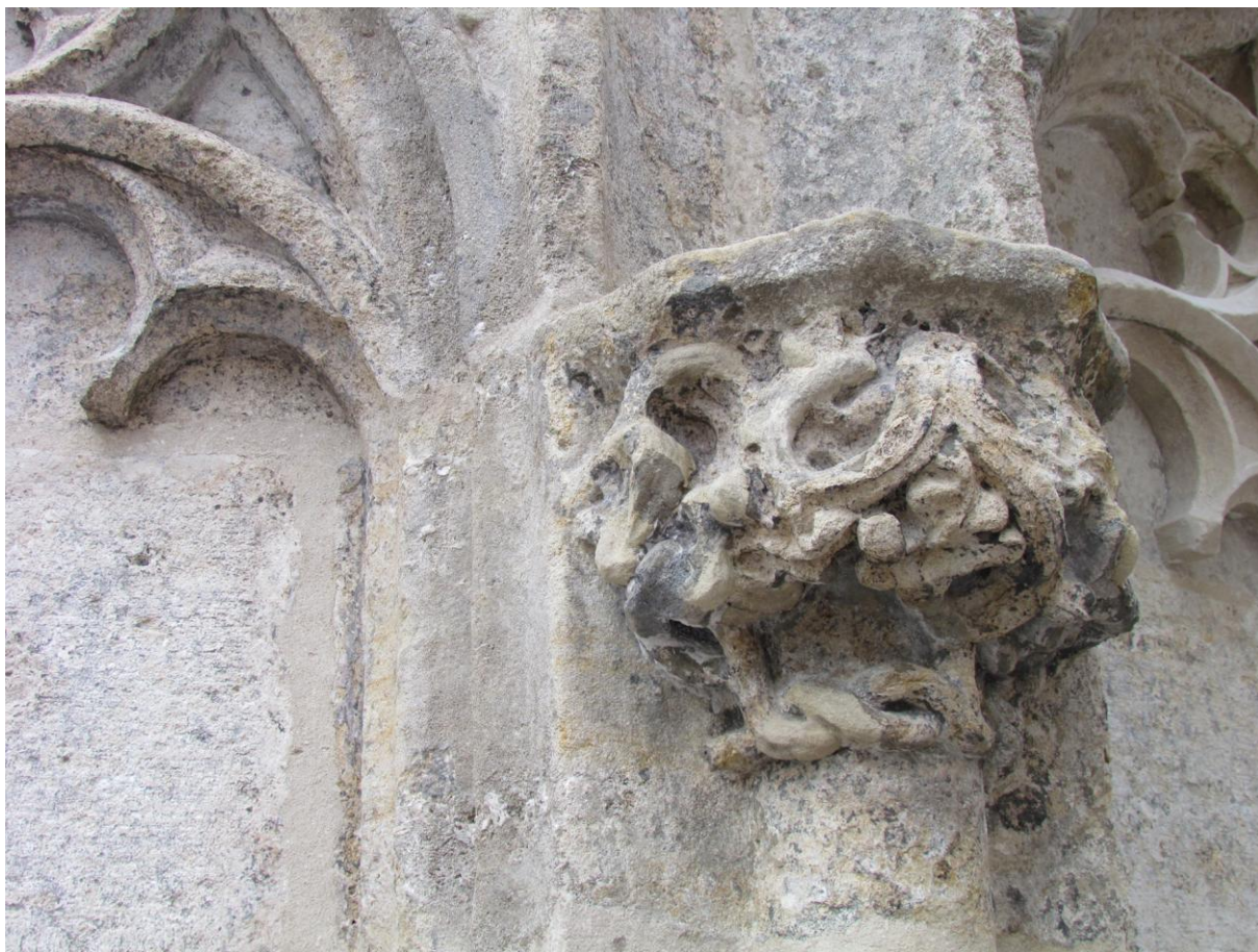
Snímek 58 – kamenná vložka detail, stav po ukončení plastické a barevné retuše
