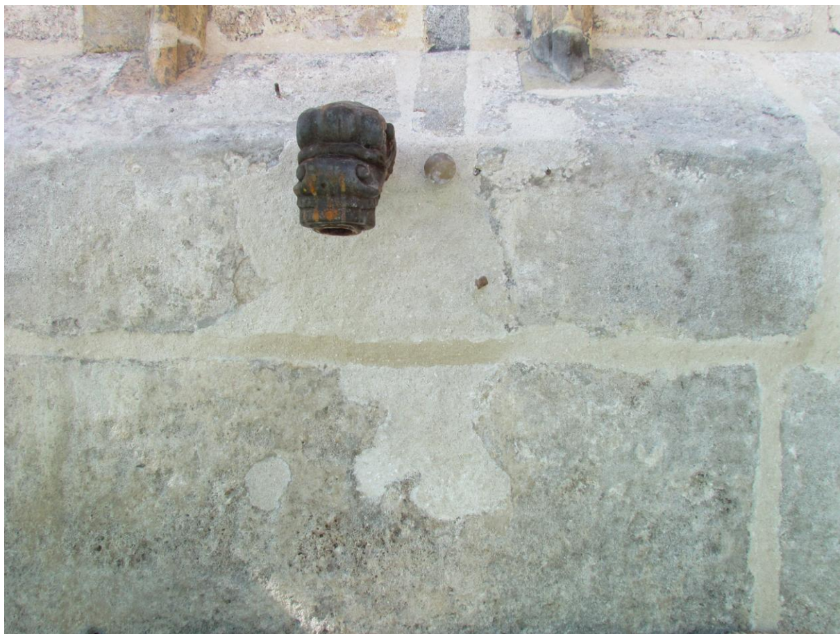
Snímek 50 – chrlič detail, stav po ukončení plastické retuše a spárování
