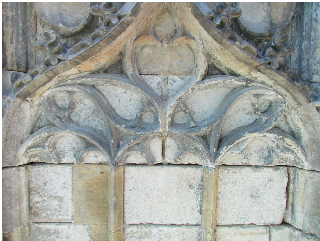
Snímek 28 – kružby, stav po ukončení odsolování
