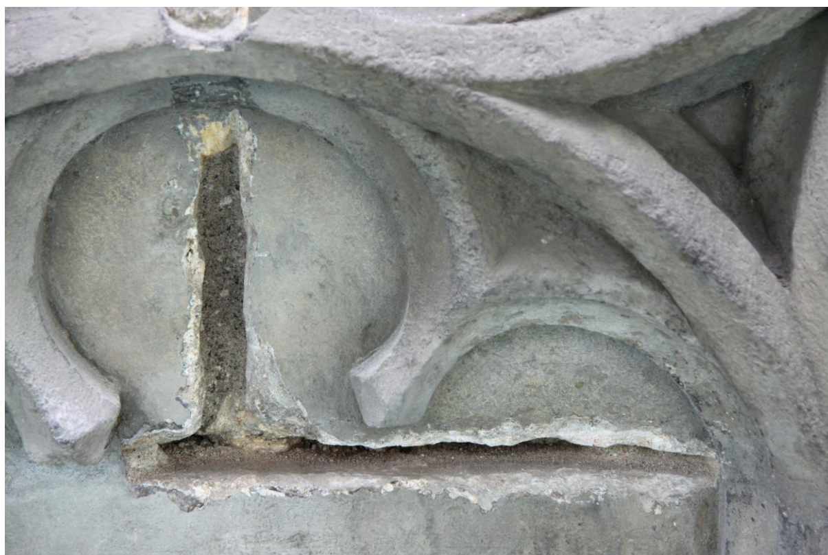
Snímek 15 - kružby detail, průběh odstraňování spár
