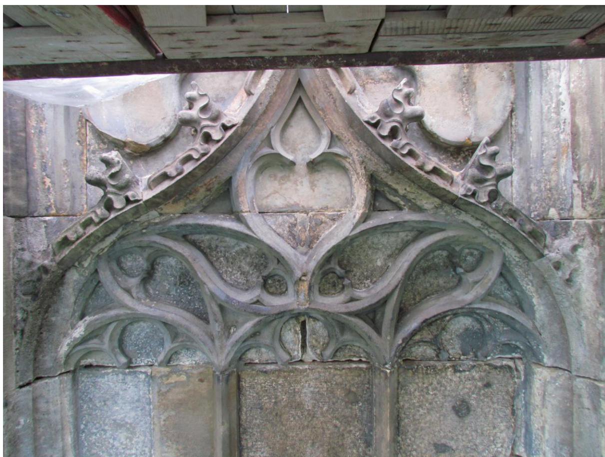
Snímek 23 – střed pole, stav po čištění abrazivní metodou před odsolováním
