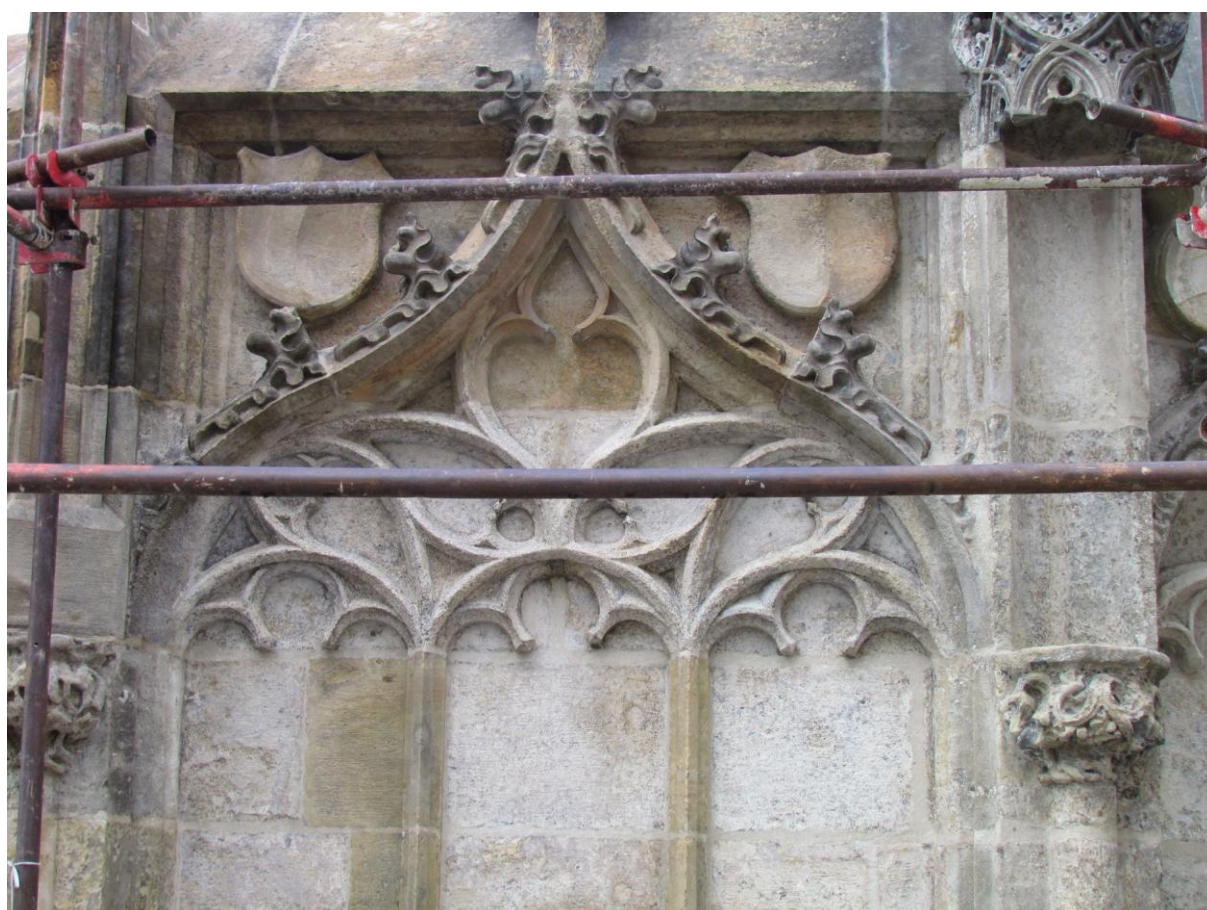
Snímek 61 – kružby a střední část, stav po ukončení 1. fáze barevné retuše
