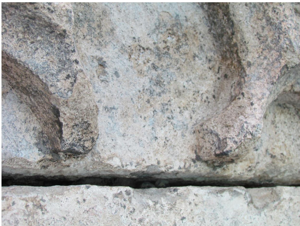
Snímek 47 – kružby detail, ztráta hmoty v trnech
