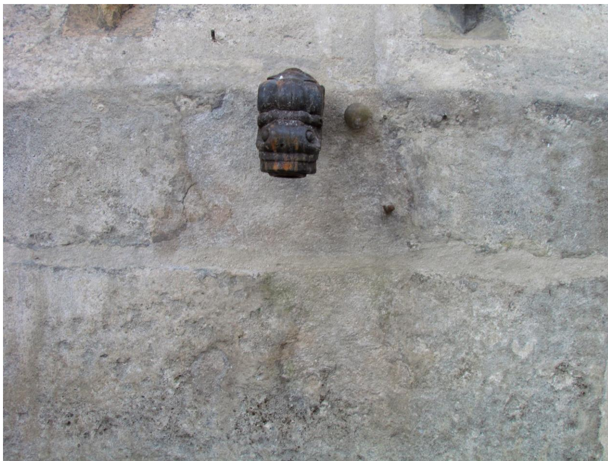
Snímek 55 – erb pod korunní římsou detail, stav po ukončení plastické a barevné retuše
