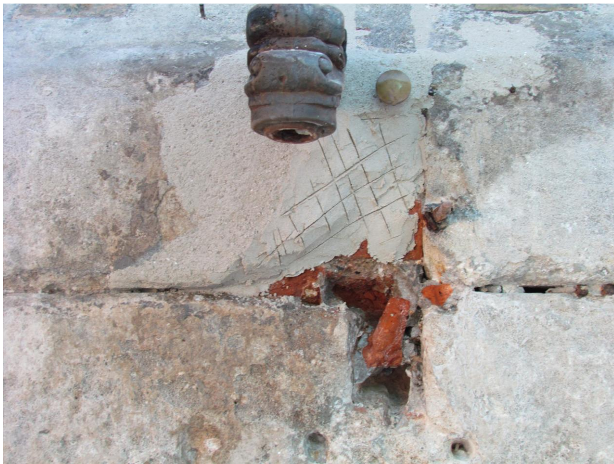
Snímek 49 – výklenek, průběh plastické retuše, srovnání (vpravo konzervační tmel)
