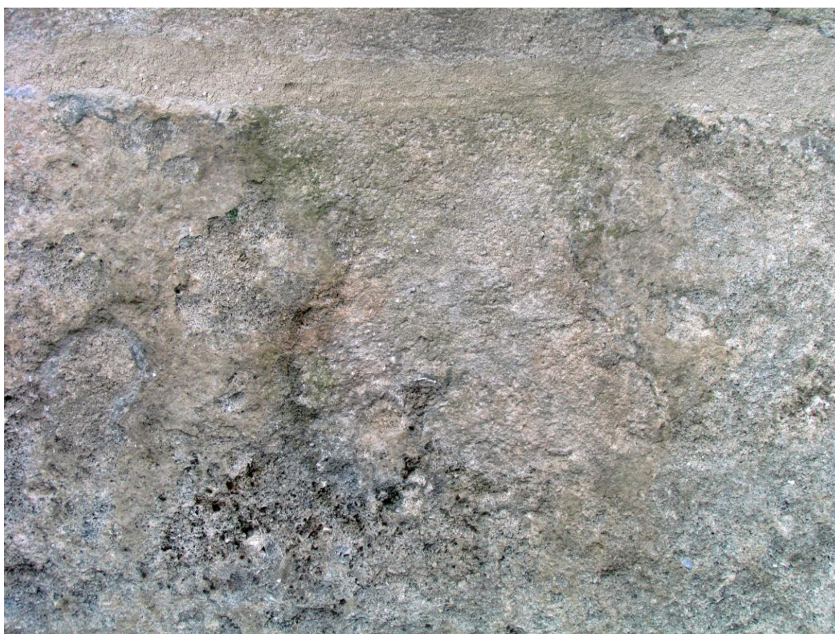
Snímek 53 - spodní část, tmel detail, stav po ukončení barevné retuše
