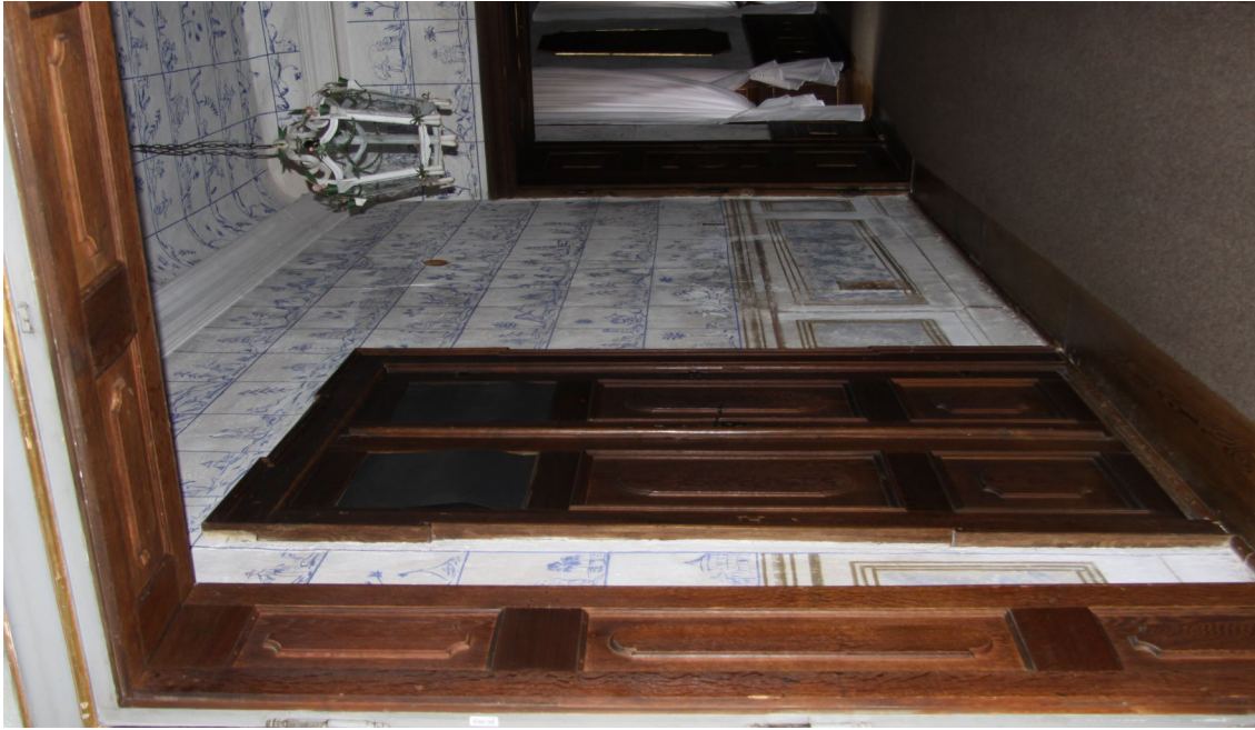
Obr. 7: Chinoiserie na stěnách a stropu spojovací chodby zámku Jaroměřice nad Rokytnou.
