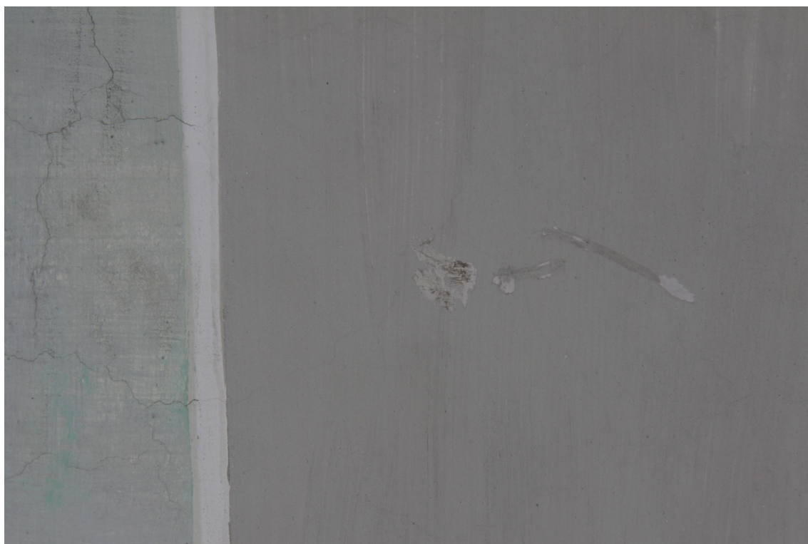
Obr. 13: Stav před restaurováním. Detail poškození. Drobná mechanická poškození v šedém rámu. Pravý okraj výjevu.
