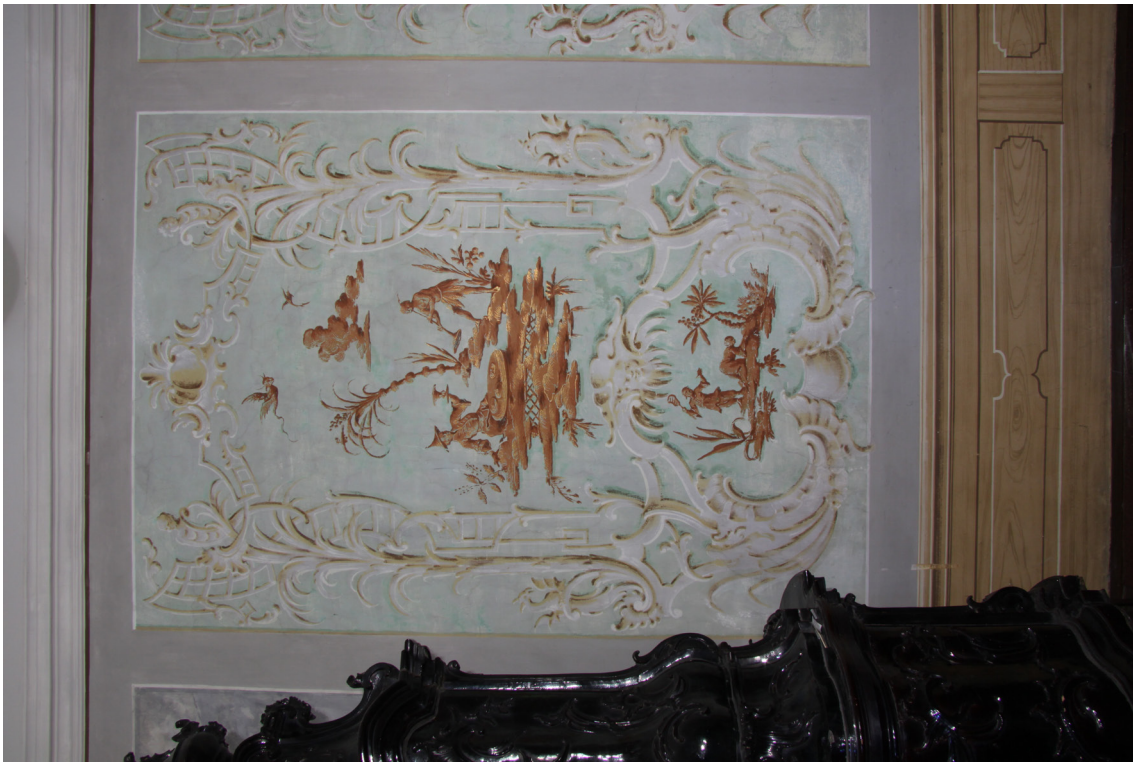
Obr. 27: Stav po očištění a prekonsolidaci maleb. Celkový pohled.
