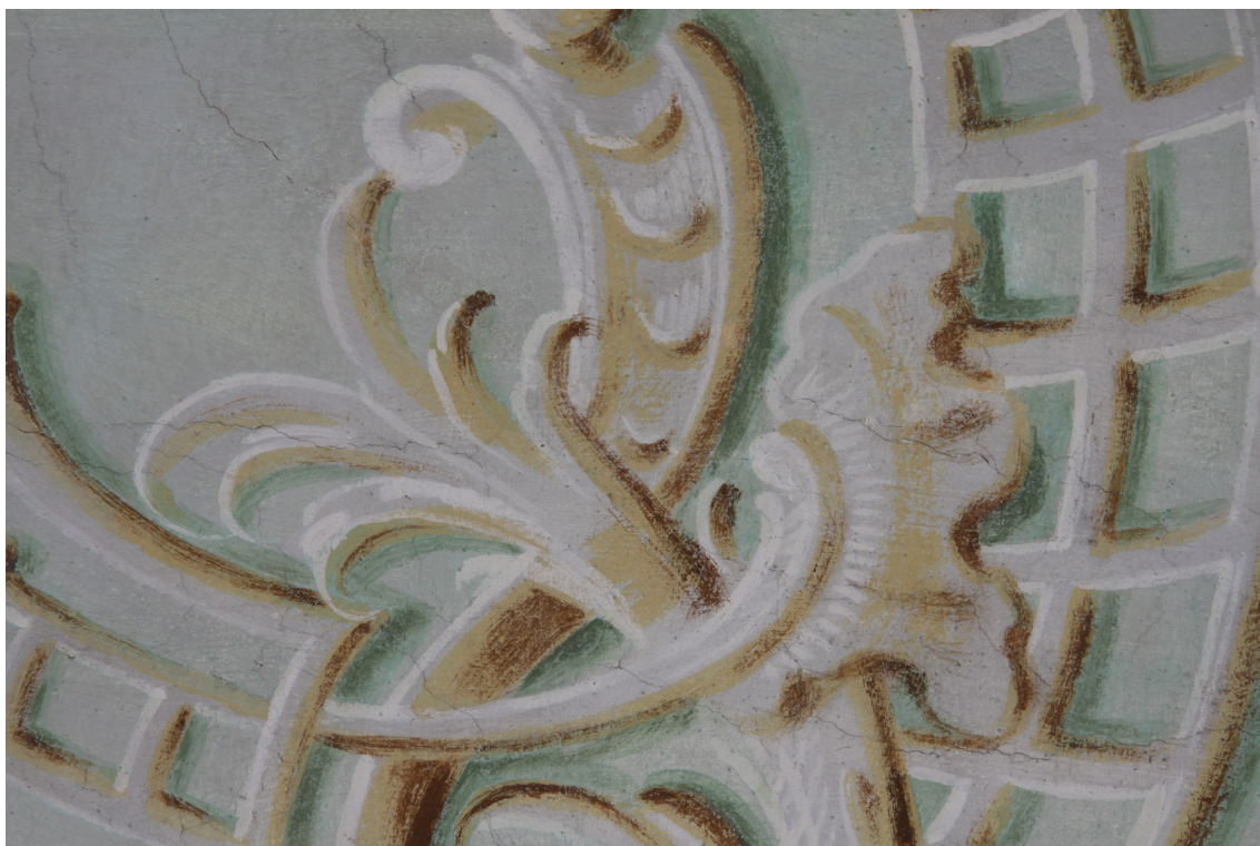
Obr. 50: Stav po restaurování. Detail malby, mřížka rokaje pravý horní roh zrcadla.
