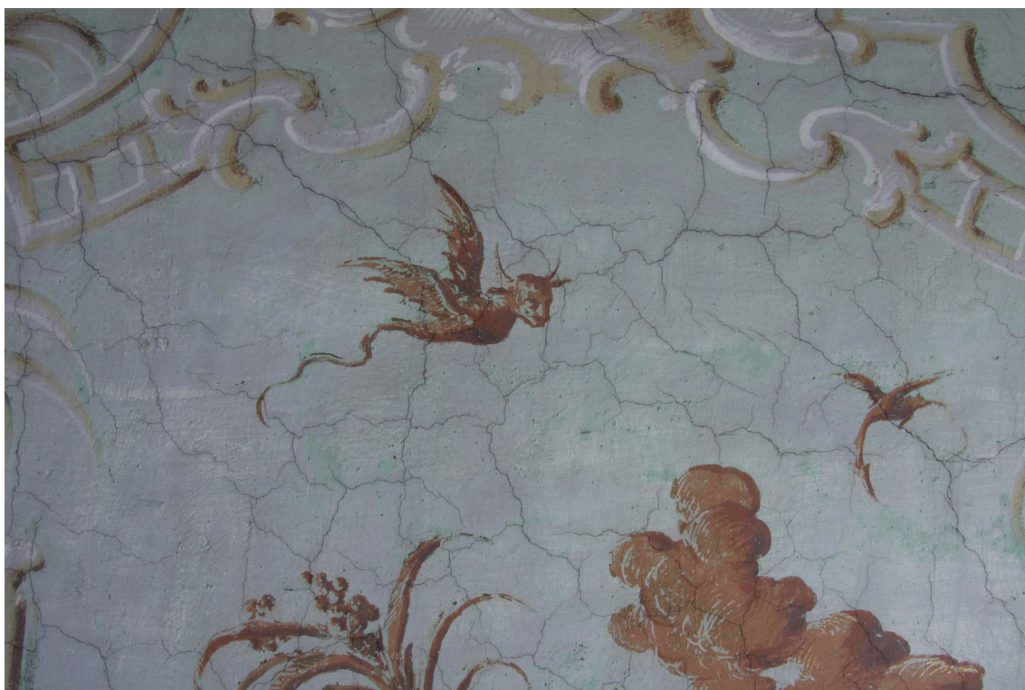
Obr. 5: Stav před restaurováním. Detail poškození, popraskaná barevná vrstva s nánosy prachu a sazí.
