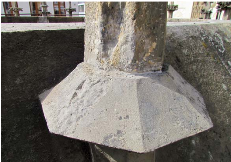
stav po odsekání tmelů
