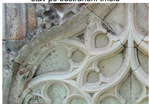
stav po odsolovacím zálalu
