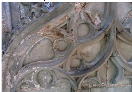
stav po odstranění tmelů
