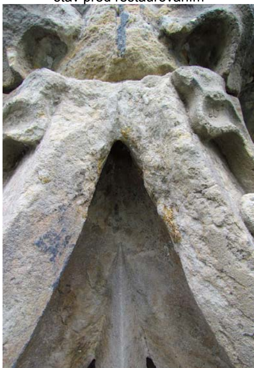
stav po odstranění tmelů
