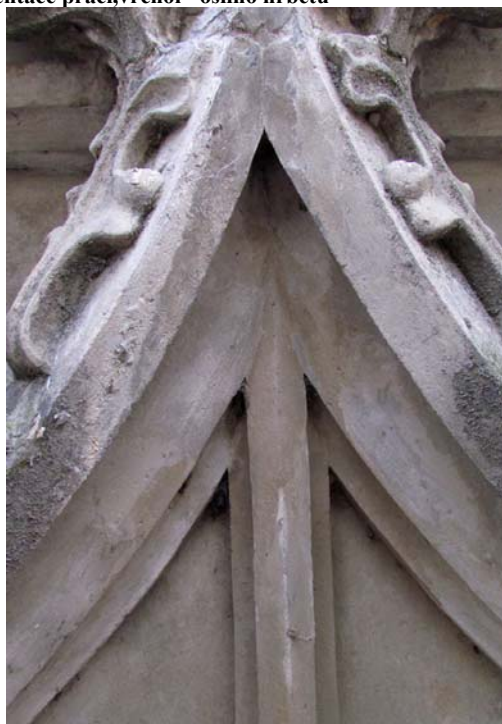
stav před restaurováním
