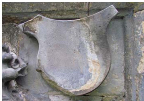
stav po očištění
