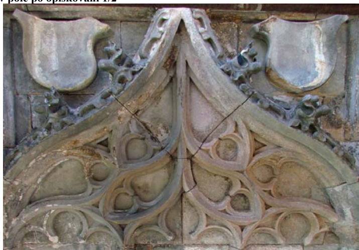
Obrázek 35 Stav pole po opískování 1/2
