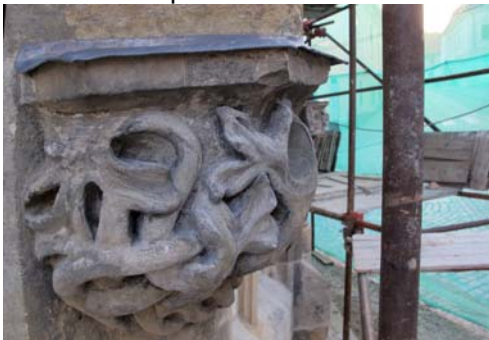
zkouška zakrytí olověnými pláty
