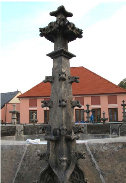
stav po restaurování
