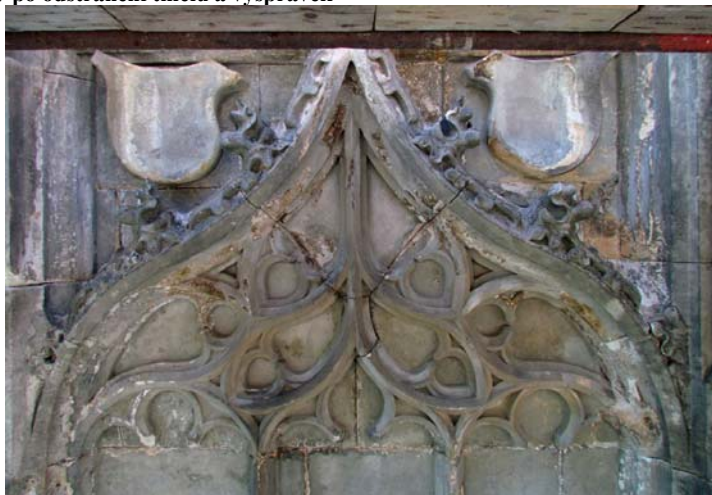
Obrázek 34 Stav po odstranění tmelů a vysrávek
