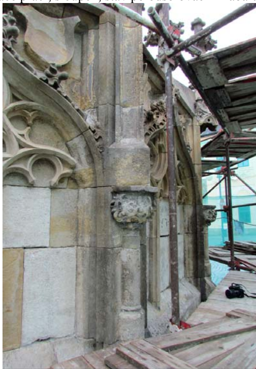
Obrázek 50 Dokumentace prací, sloupek, stav po odsolovacím zábalu
