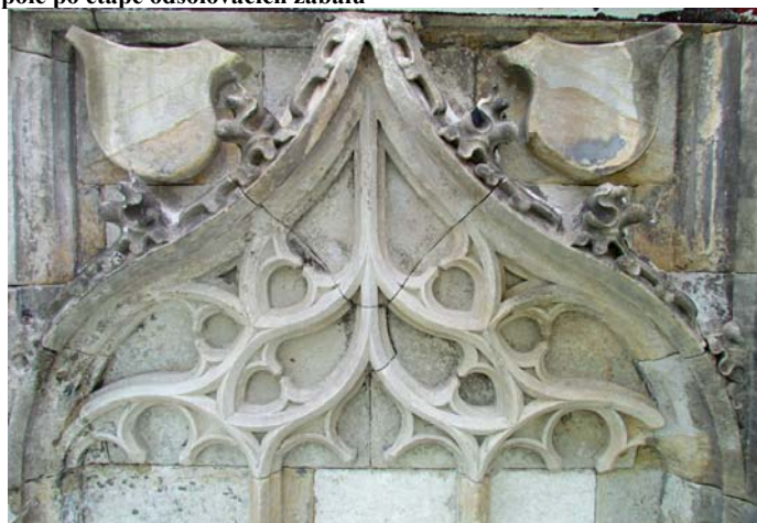
Obrázek 37 Stav pole po etapě odsolovacích zábalů
