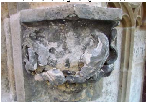
hlavice po dolepení kamenných fragmentů
