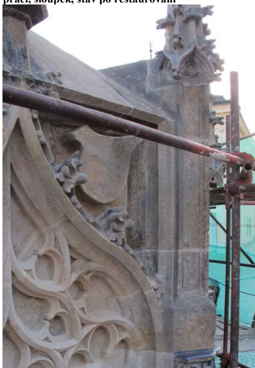
Obrázek 52 Dokumentace prací, sloupek, stav po restaurování
