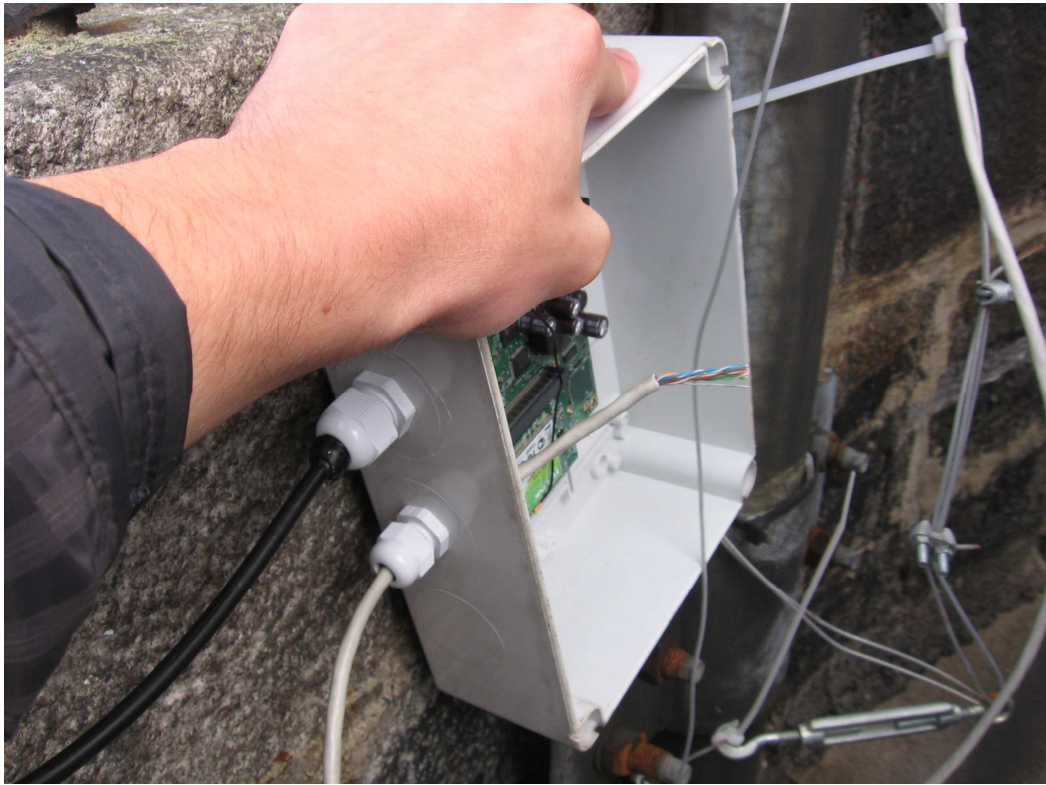
Obrázek 48 – Realizace spoje na Milešovce – instalace vysílací stanice
