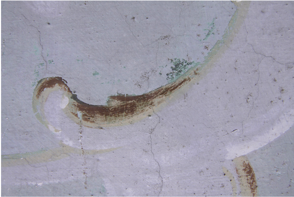
Obr.31 : lokálně dochované fragmenty originální barevné vrstvy ve stínech rokaje (fragmenty tmavě zelené a hnědé). Stav před restaurováním.
