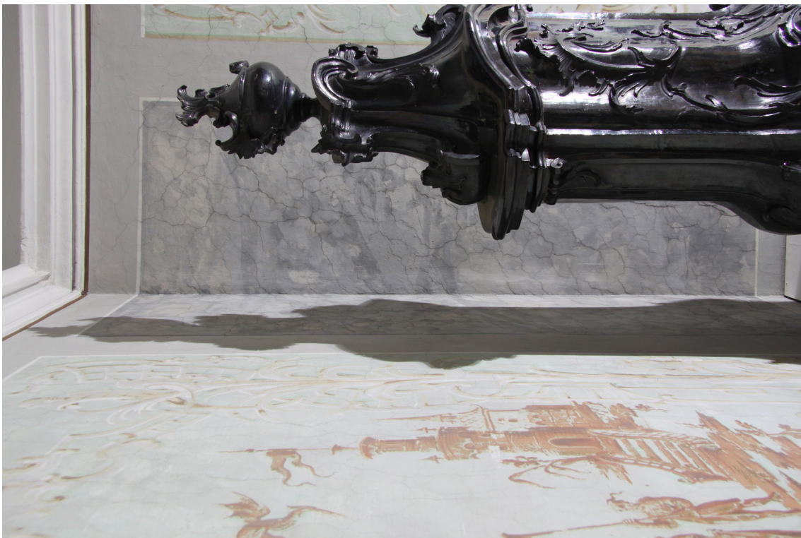
Obr.24: Celkový pohled na pole s iluzivním mramorováním na severní části východní stěny. Stav před restaurováním.
