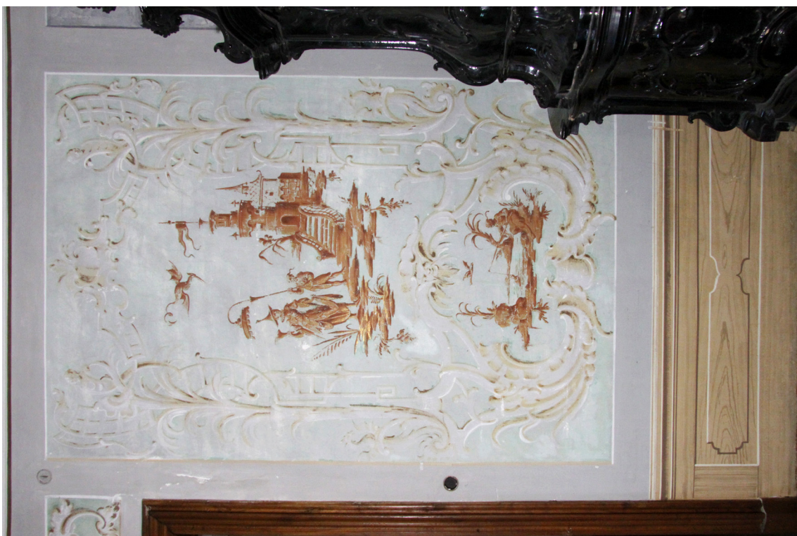
Obr.51: Celkový pohled na východní část severní stěny. Stav po celoplošném očištění, injektáži a tmelení.
