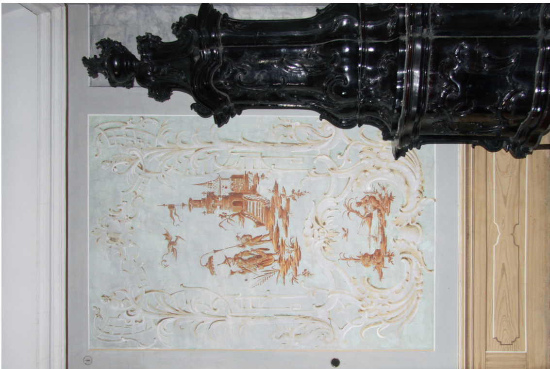
Obr.23: Celkový pohled na východní část severní stěny. Stav před restaurováním.
