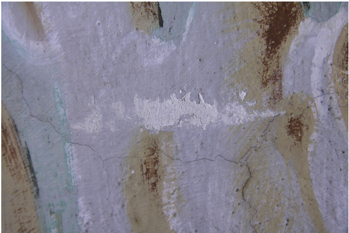
Obr.26: Lokální ztráta barevné vrstvy, která odpadla až na vápenný podkladový nátěr. Stav před restaurováním.
