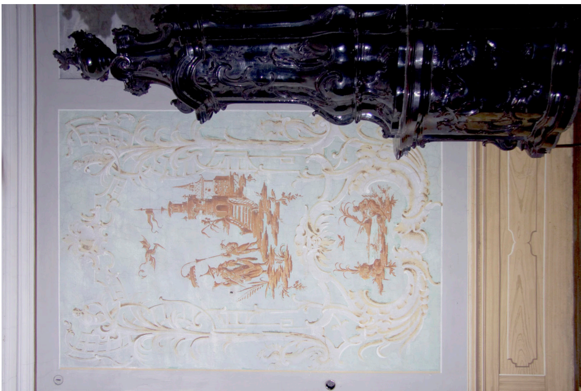
Obr.35: Celkový pohled na východní část severní stěny. Stav před restaurováním.
