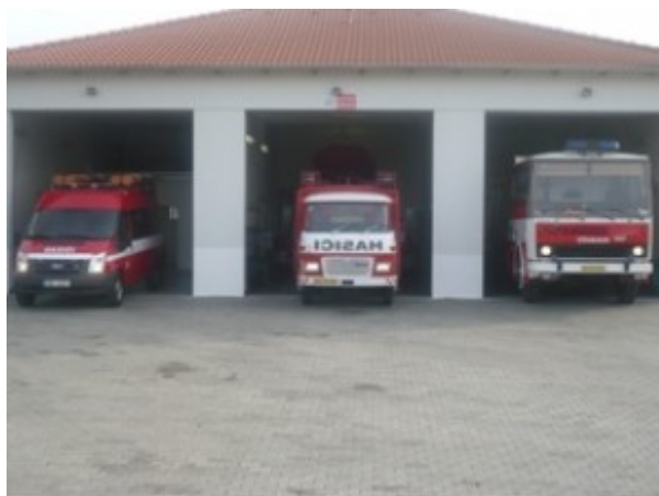
OBR. 3 - Nové garáže SDH Třebonice
