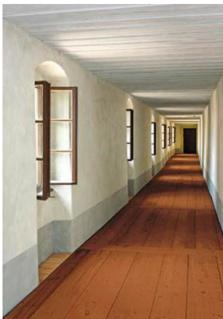
Obrázek 14: Pohled do spojovací chodby těsně před dokončením
