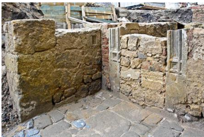
Obrázek 16: Opěrný pilíř (vlevo) a pozdně gotický vstupní portál do věže, zdobený tzv. přetínávacími pruty
