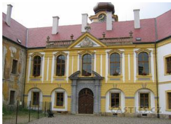
Obrázek 12: Průčelí západního křídla po obnově
