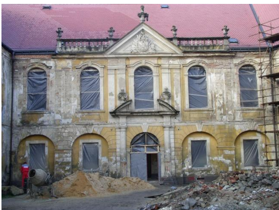
Obrázek 11: Průčelí západního křídla před obnovou
