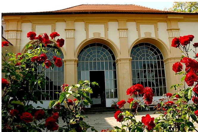
Obrázek 10: Východní průčelí Saly terreny
