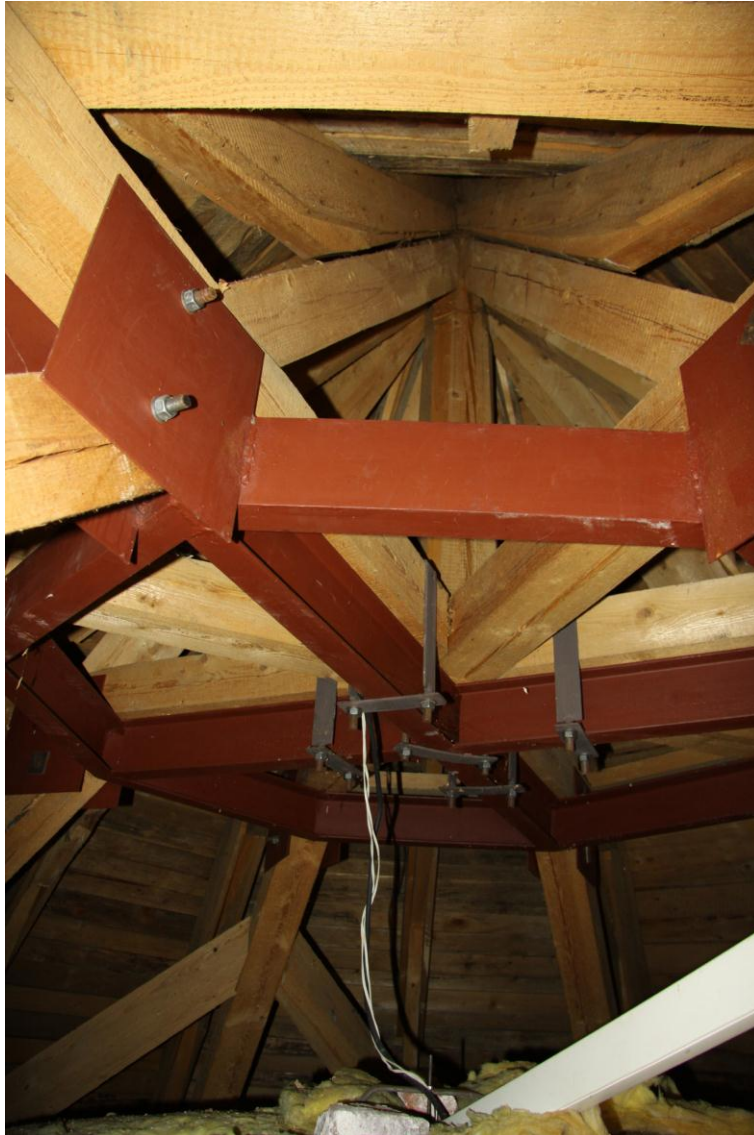
Foto. 7. Pohled do krovu věže.
