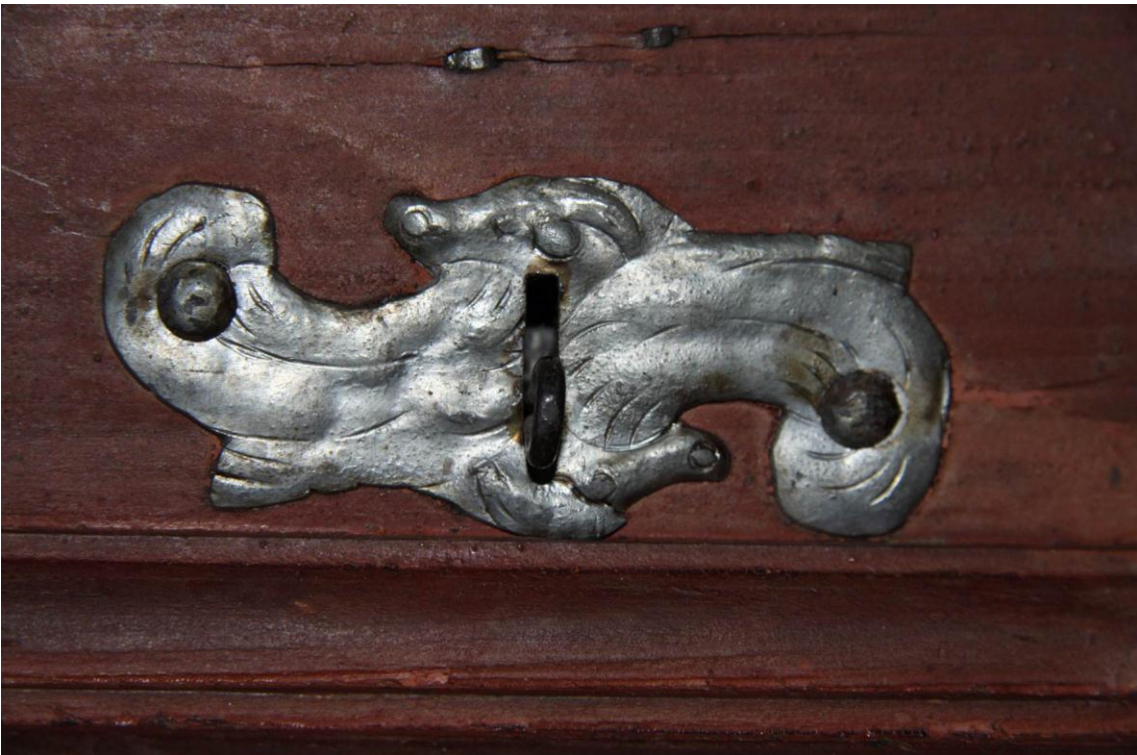
Foto. 32. Kovaný štítek se závlačkou – způsob uzavírání mělkých skříní stolu na severní, východní a jižní straně.
