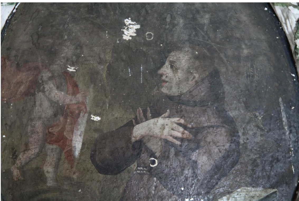
Foto. 45. Detail jednoho z medailónů s poškozením malby. V místech poškození je dobře viditelný křídový podklad.
