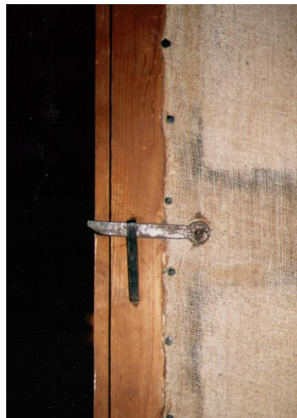
Detail fixování plátna z rubové strany křidel dveří (snímek Kateřiny Balcarové).
