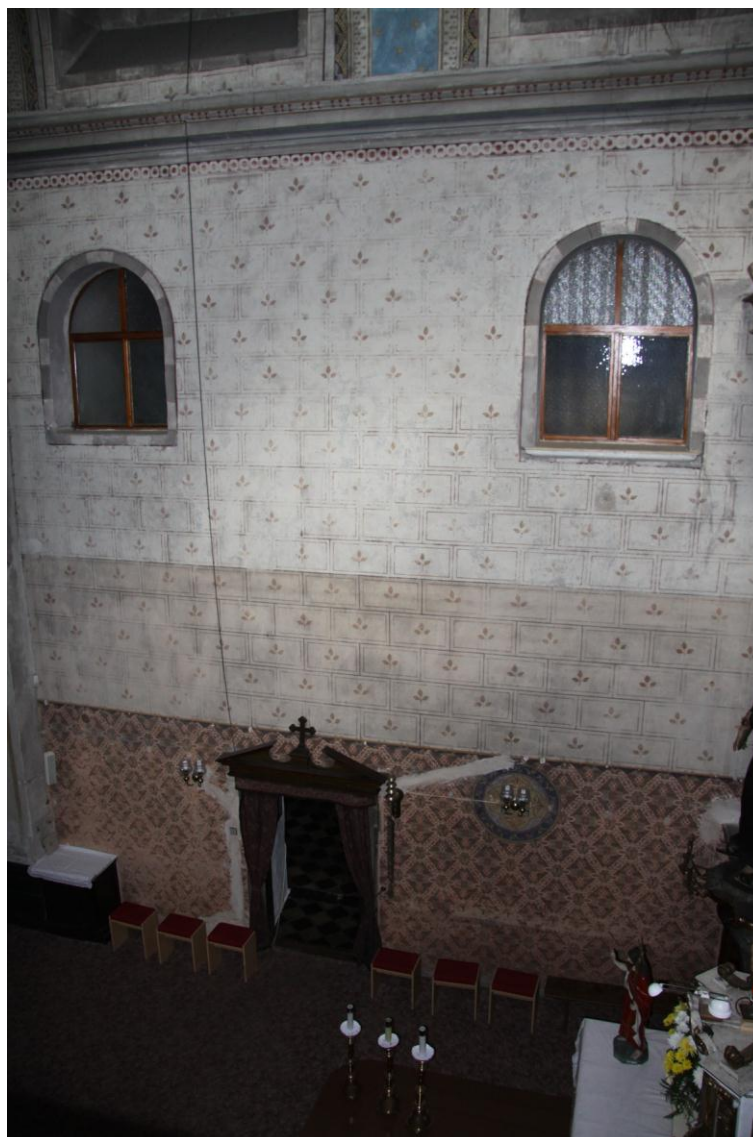
Foto. 11. Vstup do sakristie z presbytáře kostela. Pohled z okna v prvním patře ochozu presbytáře.
