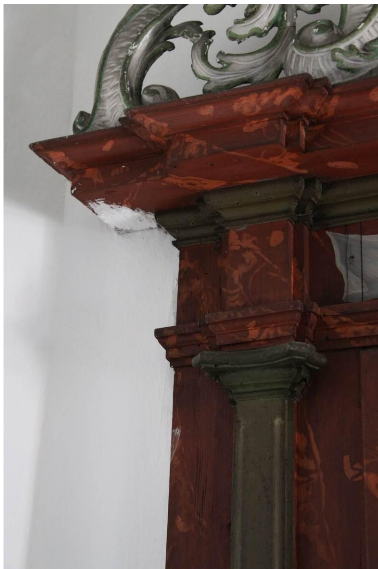
Foto. 41. Pohled na roh knihovny skříně se znečištěním spodní části římsy, které svědčí o přemalování místnosti knihovny.
