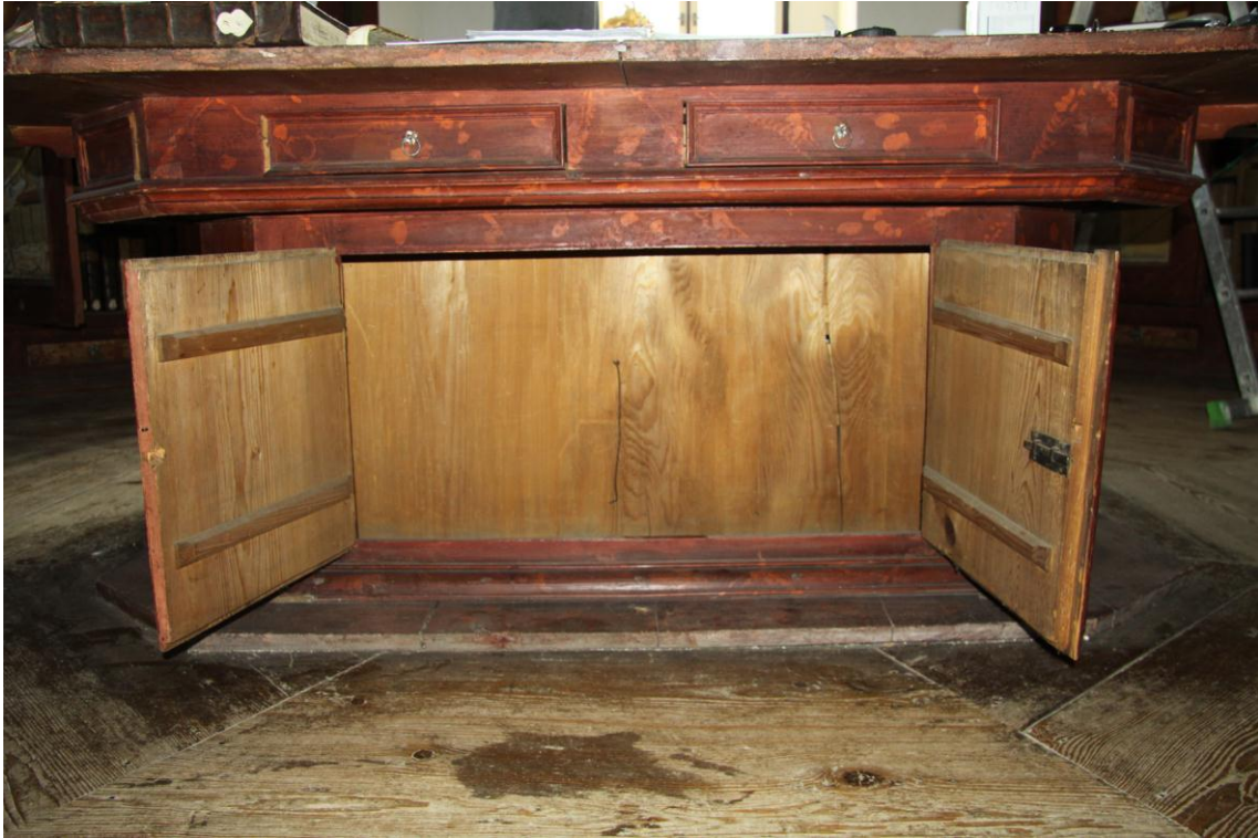
Foto. 29. Jedna z mělkých skříněk stolu. Uvnitř skřínky je patrný háček s dlouhým tělem sloužící k uzavírání levého křídla dveří. Pohled ze severní strany.
