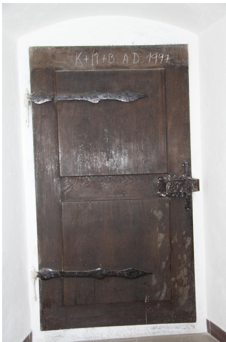
Foto. 12. Celkový pohled na vstupní dveře s tvarově jednoduchými kovanými pásovými závěsy.
