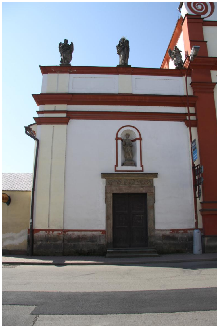
Foto. 53. Průčelí kapličky sv. Petra. Portál z tesaného pískovce, v nice nad ním socha sv. Petra, na vrcholu korunní římsy socha Krista s anděly po stranách.
