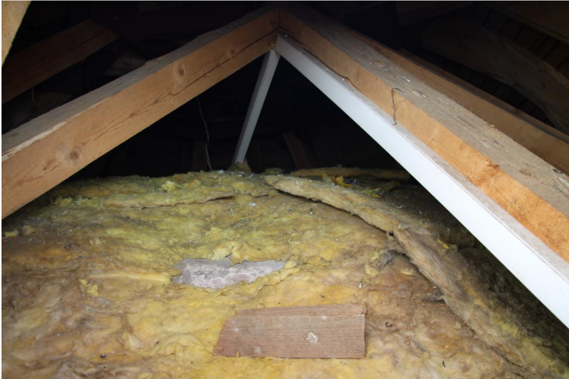
Foto. 8. Klenba knihovny z pohledu krovu. V místě odsunutí izolace je patrné její vyzdění.
