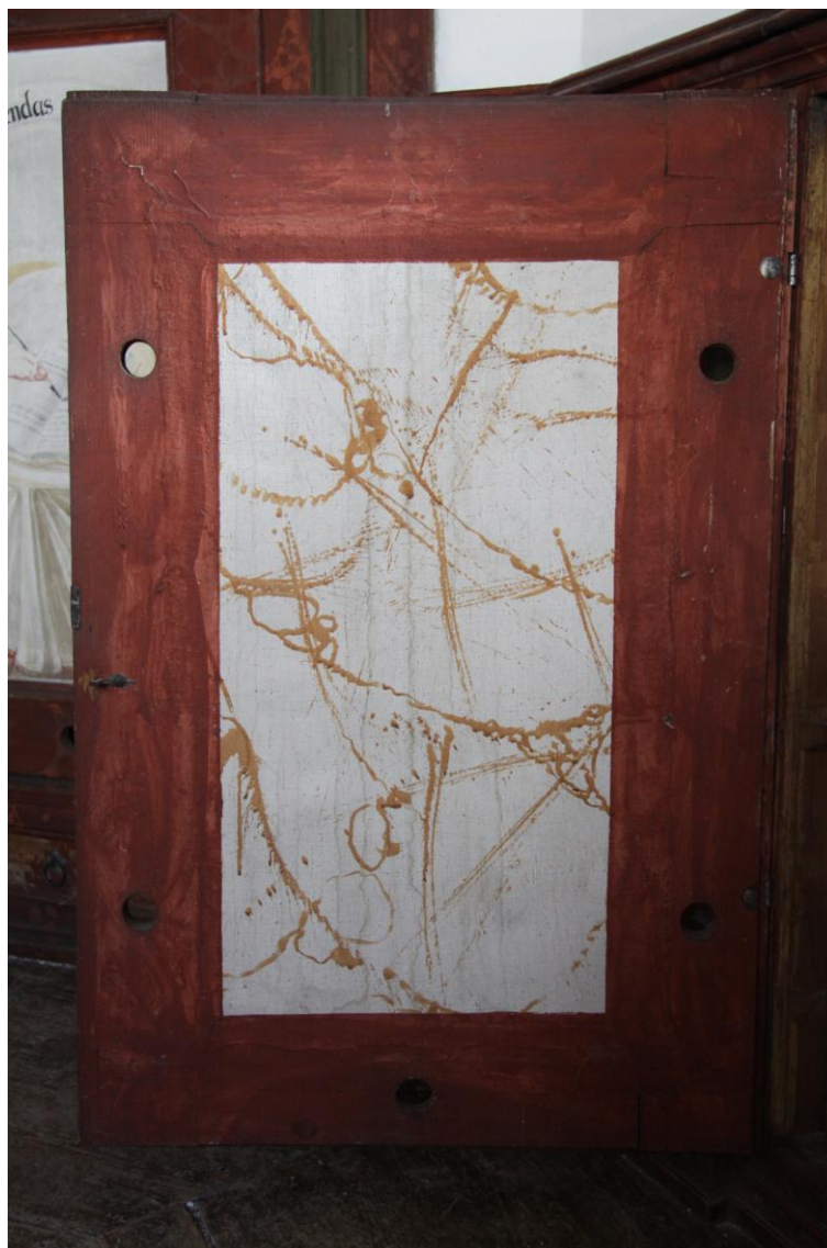
Foto. 34. Celkový pohled na vnitřní stranu textilní rámové výplně křídla dveří – skříňka č. 4.
