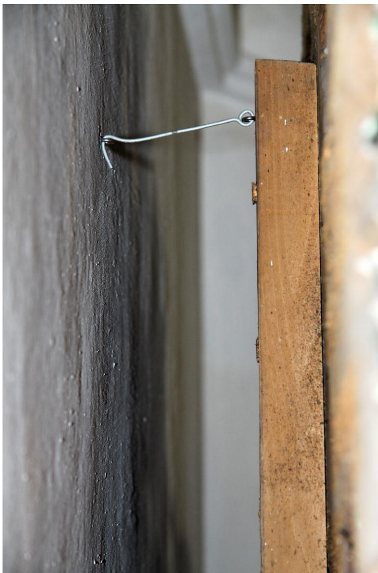
Foto. 46. Pohled na rubovou stranu medailonu supraporty s detailem dřevěného trámku, fixovaného k medailonu pomocí dřevěných kolíčků. K trámku je upevněn i háček s prodlouženým tělem, který slouží k fixaci supraporty ke zdi.
