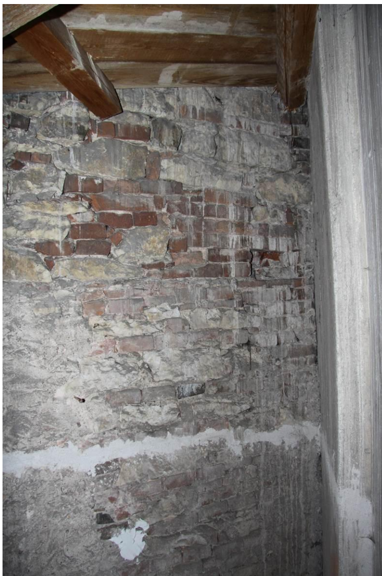
Foto. 10. Detail smíšeného zdiva věže.
