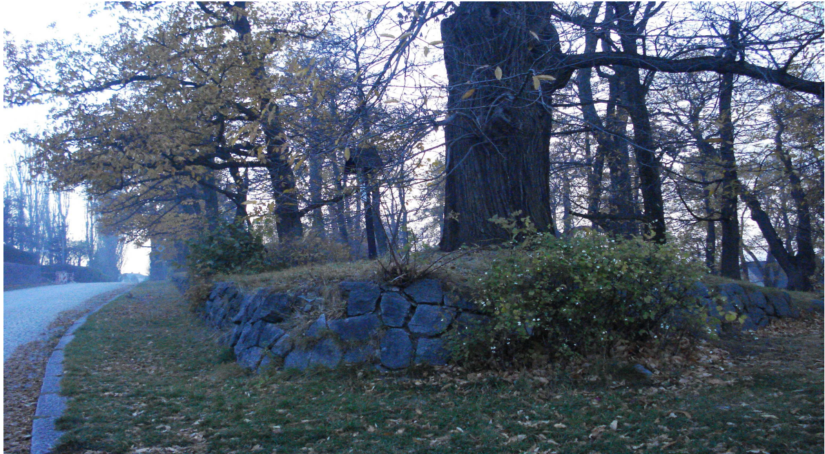
Obr. 1: Kaštanka, Nasavrky. Vaněk zde vypracoval podpěrný vál v rozích, aby předešel hroucení.
