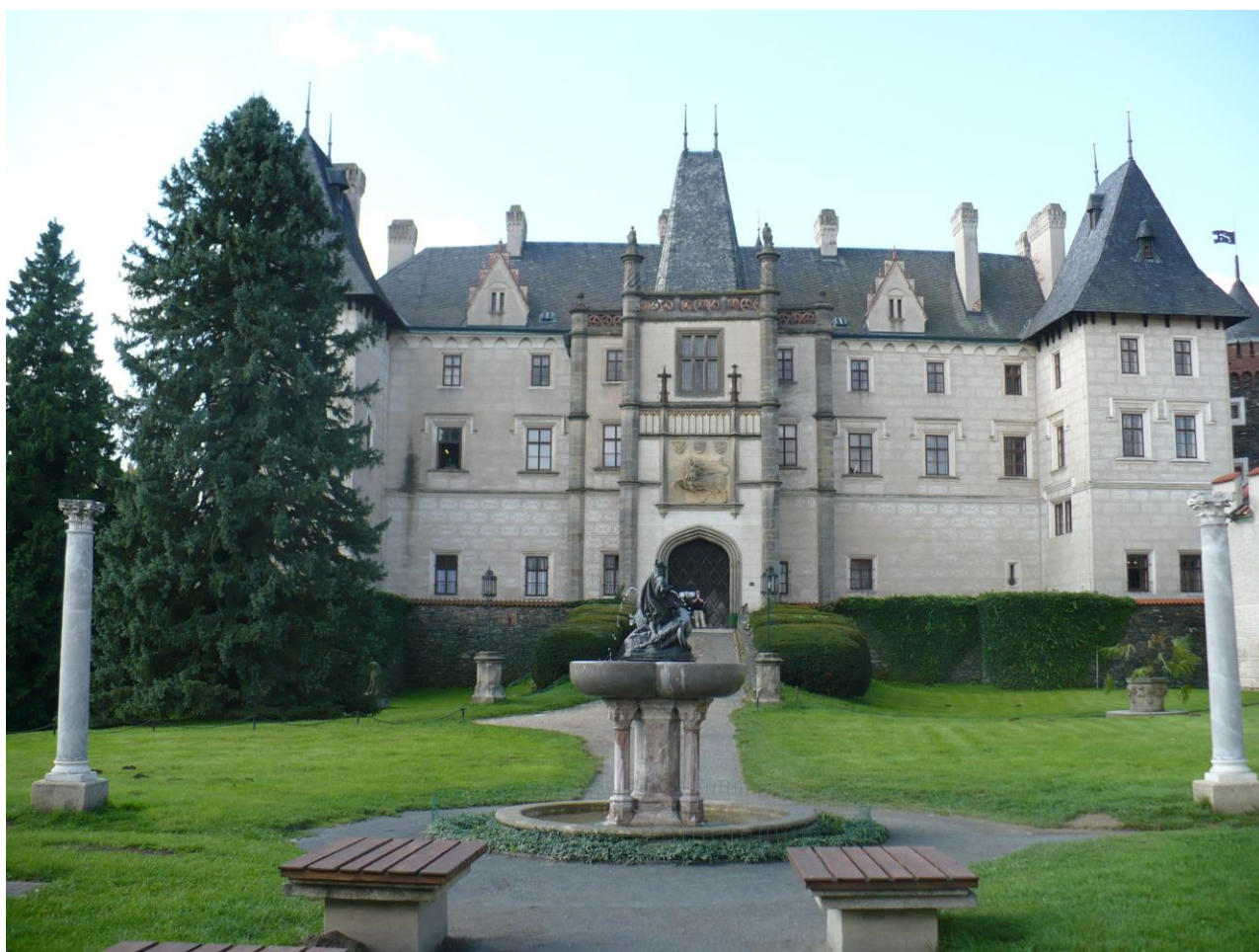
Obr. č. 5 - Hlavní průčelí zámku s kašnou od Antonína Fernkorna v pohledu z Předzámčí
