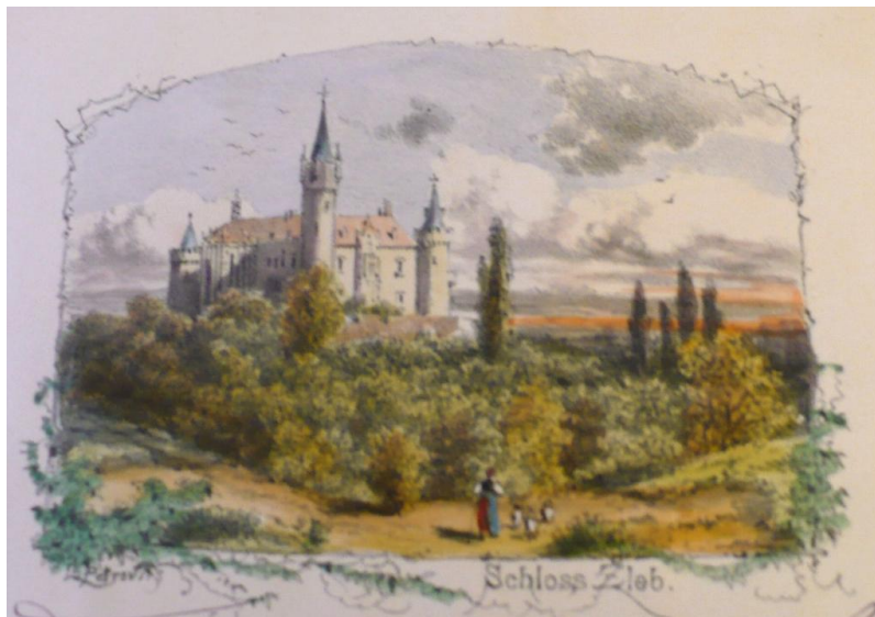
Obr. č. 2 - Pohled na romanticky přestavěný zámek z druhé poloviny 19.století
