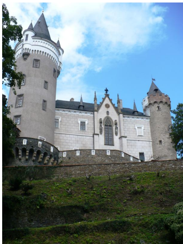
Obr. č. 10 - Pohled na jižní průčelí zámku s Velkou a Holubovou věží
