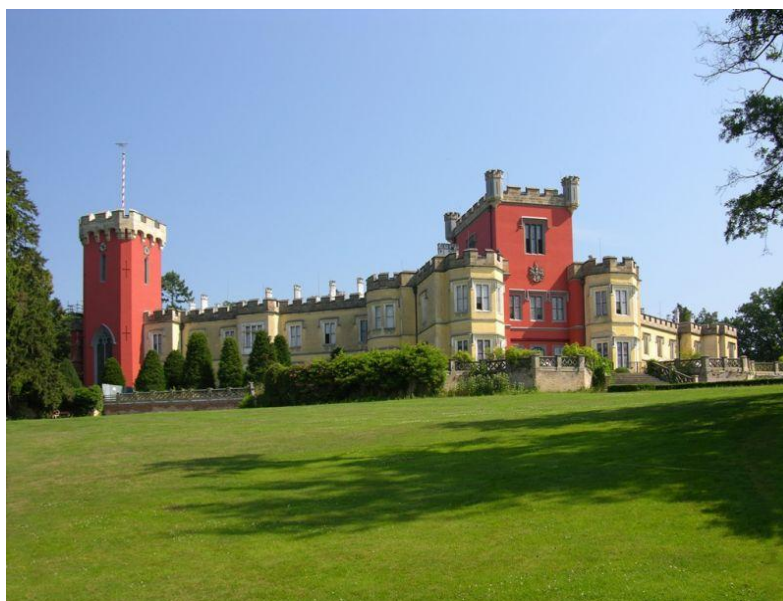
Ob. č. 42 - Pohled na zámek od jihozápadu
