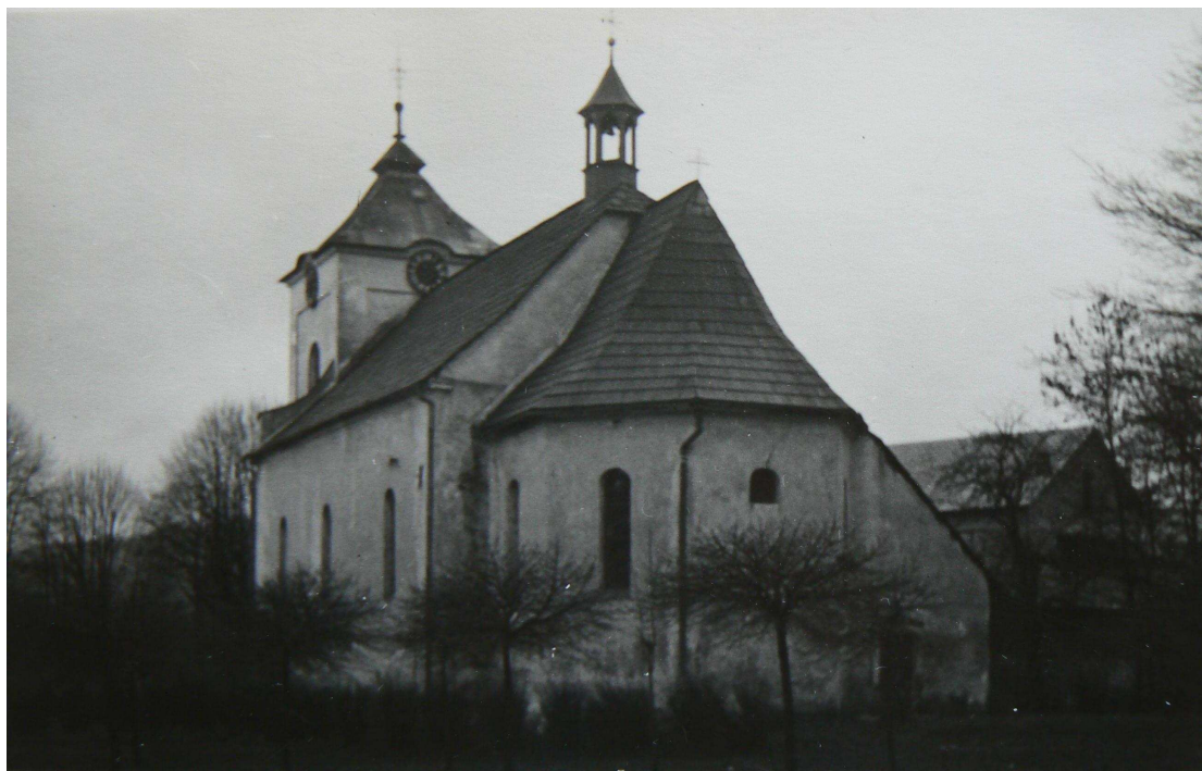
Příloha č. 14: Na této fotografii kostela z doby po roce 1935 je vidět část parkové úpravy kostela po zrušeném hřbitovu v roce 1907. Je zde dobře patrná šindelová střecha, která až na věž pokrývá celý kostel. Nahrazení šindelové střechy plechovou proběhlo až v roce 1965. Za věží je chrámová loď, v popředí je presbytář a z pravé strany je přistavěna sakristie.
