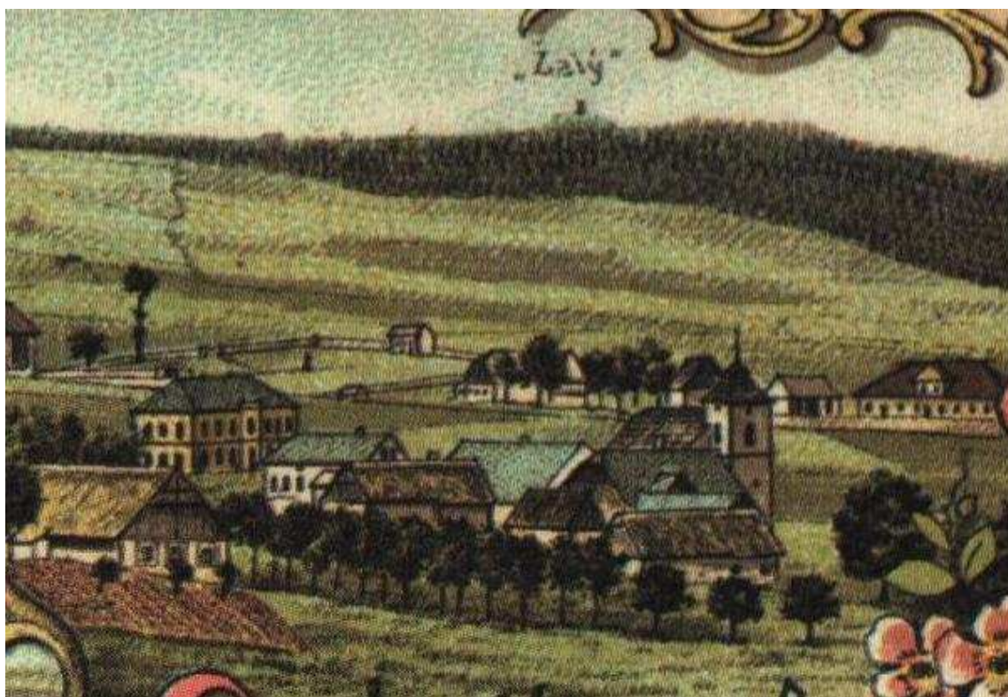
Příloha č. 5: Další výřez z pohlednice datované dnem 22. června 1899 zachycuje kostel, vlevo nahoře nový hřbitov a vpravo nahoře farní areál (zprava od věže stodola a fara). Ačkoli směrem dozadu byl plot ze pouze ze zděných sloupů a latí, směrem k návsi byla celá zeď.
