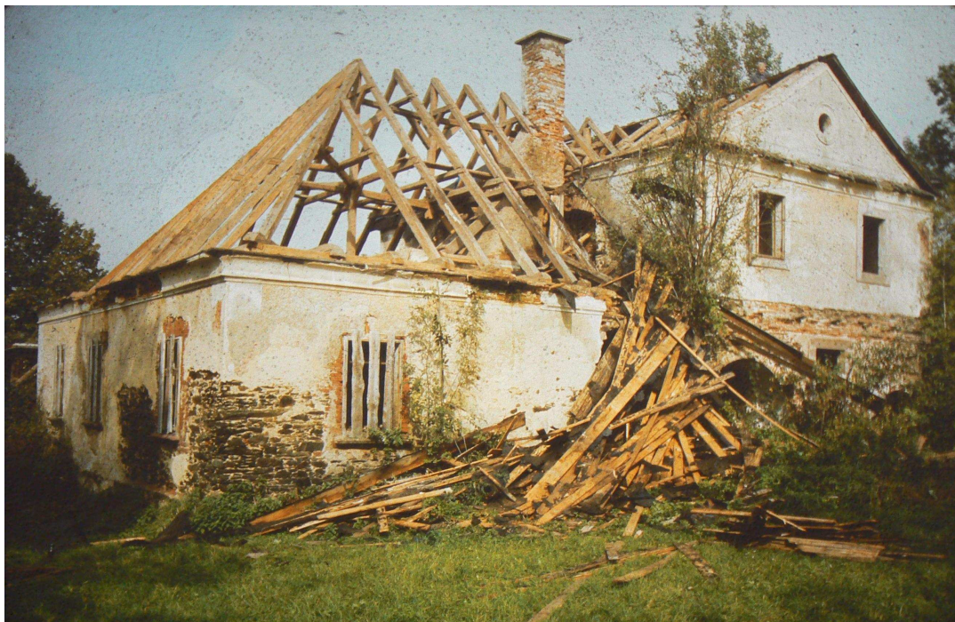
Příloha č. 31: Další fotografie z demolice v roce 1984 zachycuje tentokrát zadní část budovy směrem do farní zahrady. Kromě zbořeného levého křídla je pod štítem i patrné místo po ubourané předsíni.
