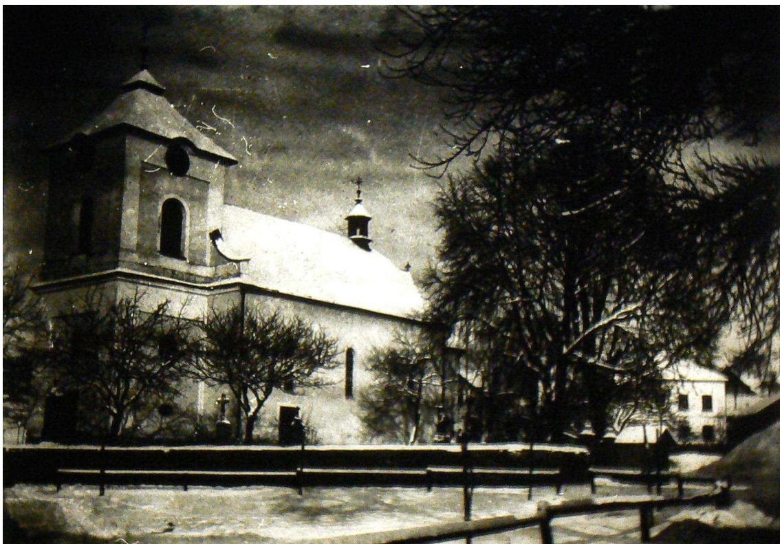
Příloha č. 4: Také tato fotografie z přelomu 19. a 20. století zachycuje kostel obklopený hřbitovní zdí. Vpravo jde vidět část původní jednopatrové školní budovy z roku 1875.
