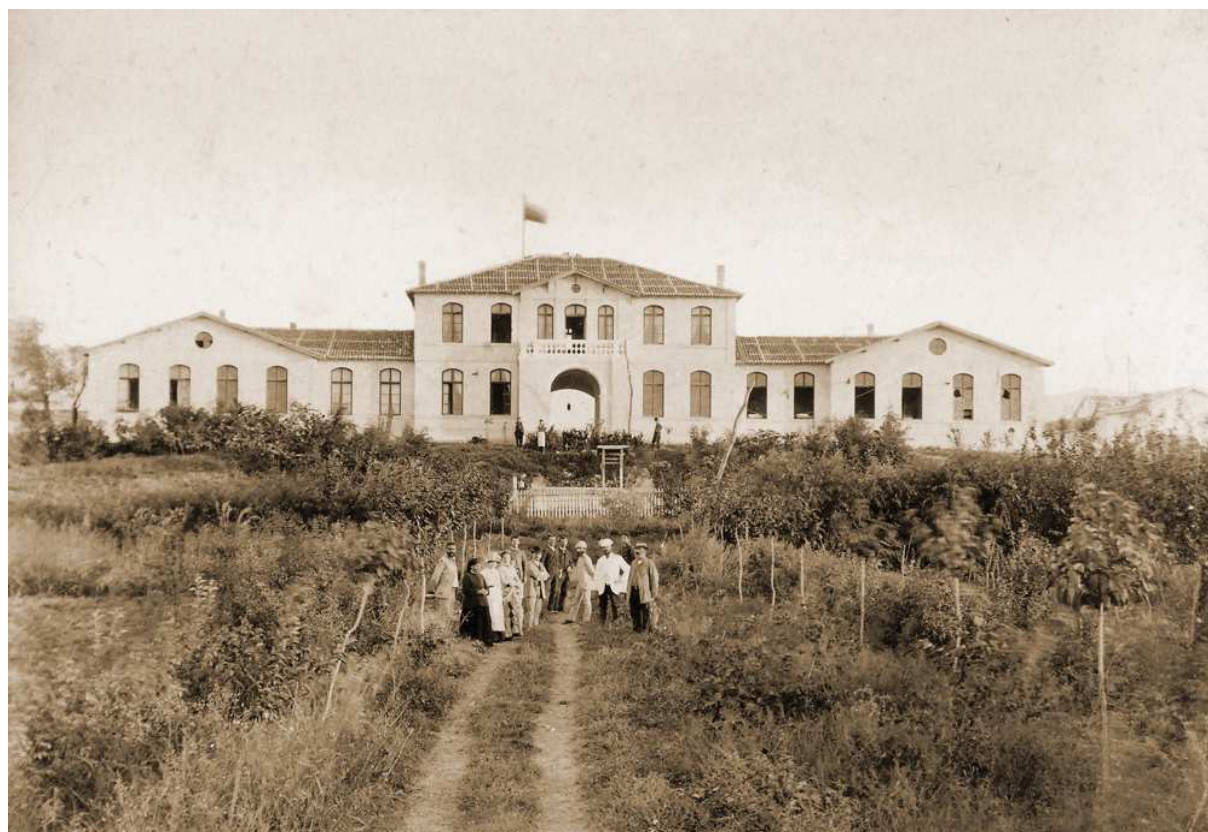
Obr. č. 7 Stará zemědělská škola v Sadovu.
