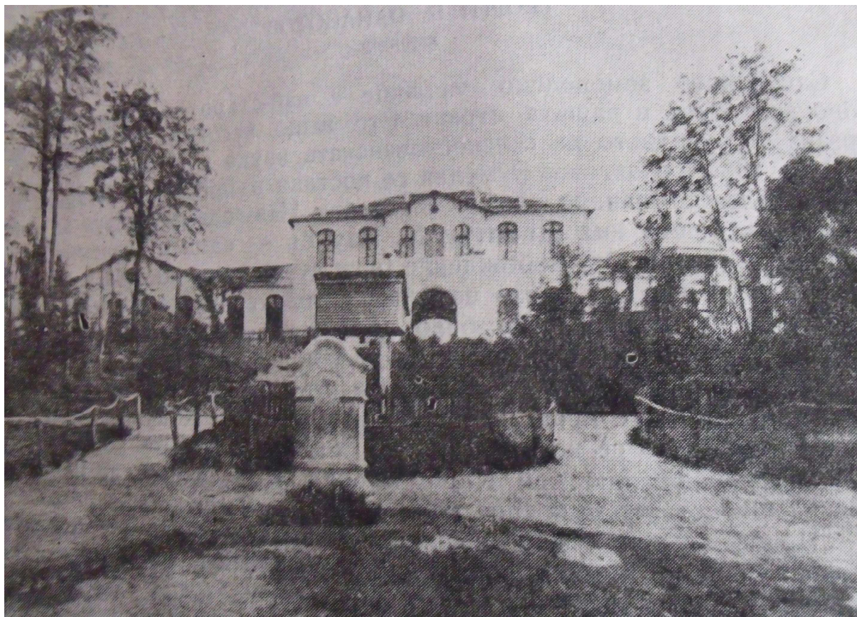
Obr. č. 6 Stará zemědělská škola v Sadovu.
