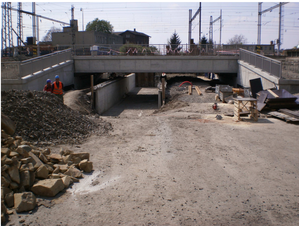
Obrázek 20: Rekonstrukce Mádrova podjezdu
