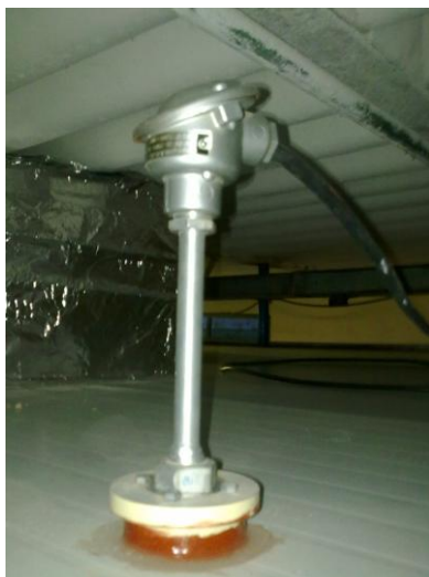
Obrázek 20: Provedení odporového snímače Pt 100
