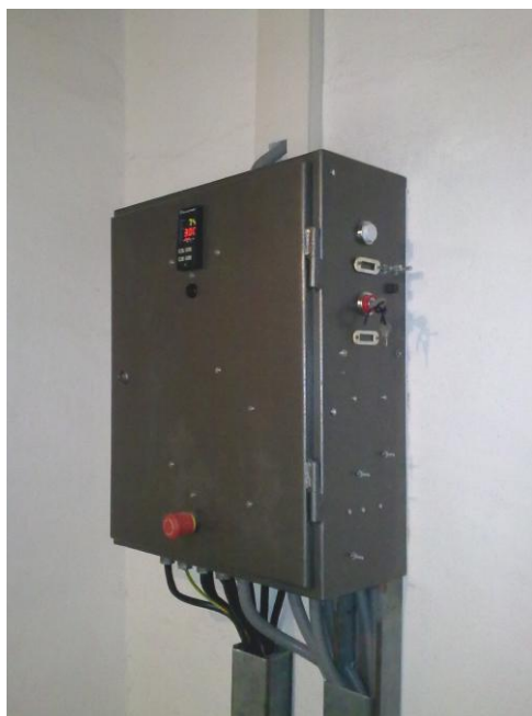
Obrázek 14: Provedení HLAVNÍHO ROZVADĚČE
