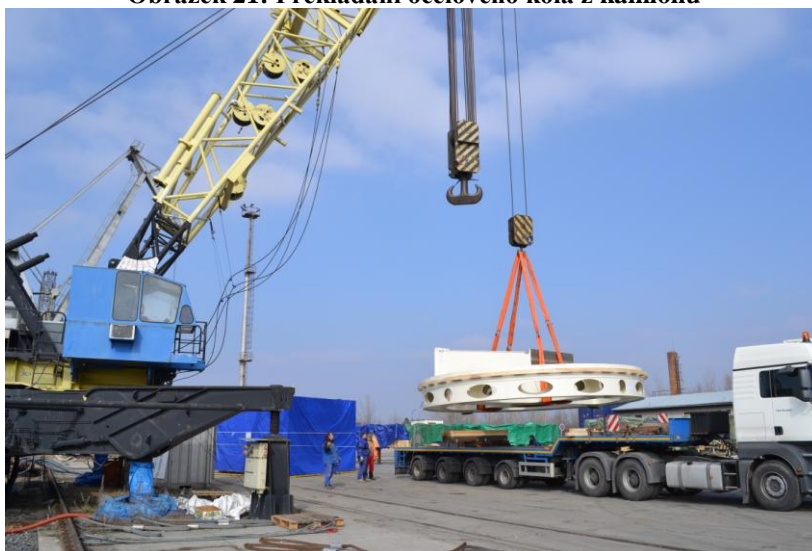
Obrázek 21: Překládání ocelového kola z kamionu
