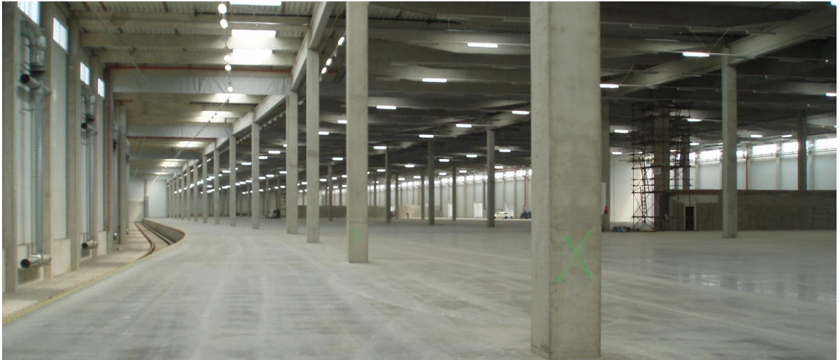
Obrázek 6: Prostory v nové skladové hale v Lovosicích s pohledem na železniční vlečku
