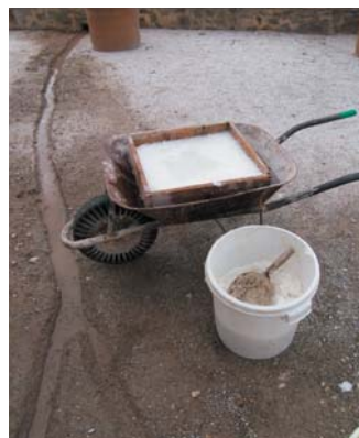
obr. 16,17 Plavení buničiny a míchání odsolovacích směsí
