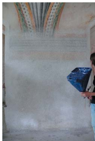
obr. 19,20,21 Nanášení separačního podstříku a odsolovací zábal na separaci
