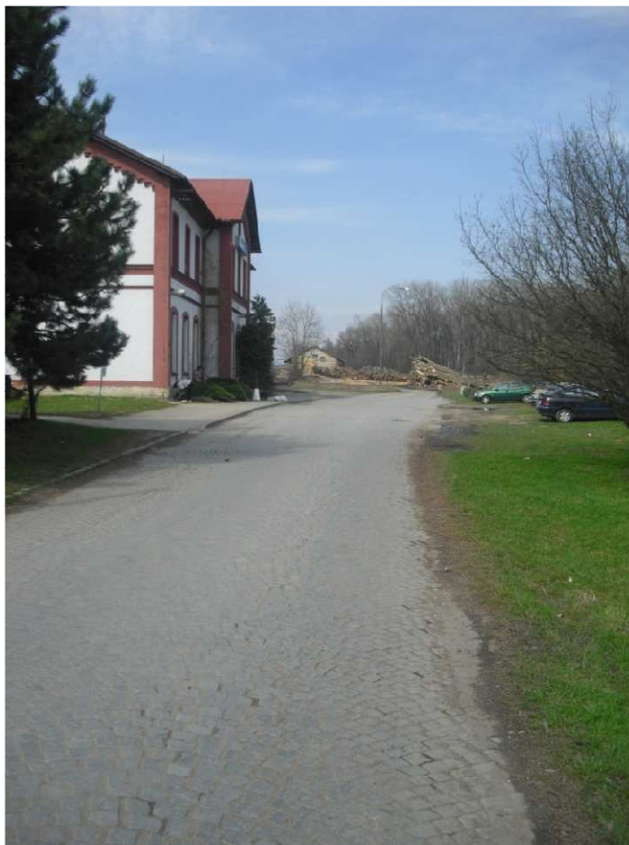
Fotodokumentace 1 - Příjezdová cesta z pohledu k výpravní budově
