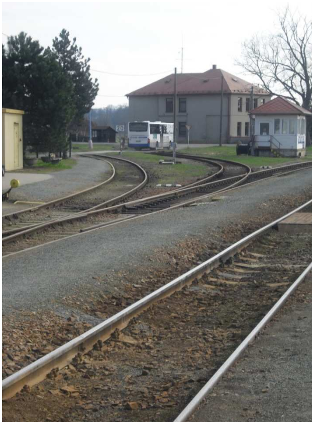
Fotodokumentace 28 - Zaústění trat' č. 028 – Dobruška, vpravo vlečka – mlékárna
