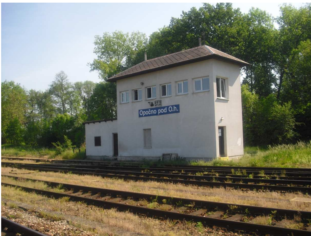
Fotodokumentace 24 - Stavědlo č. 2
