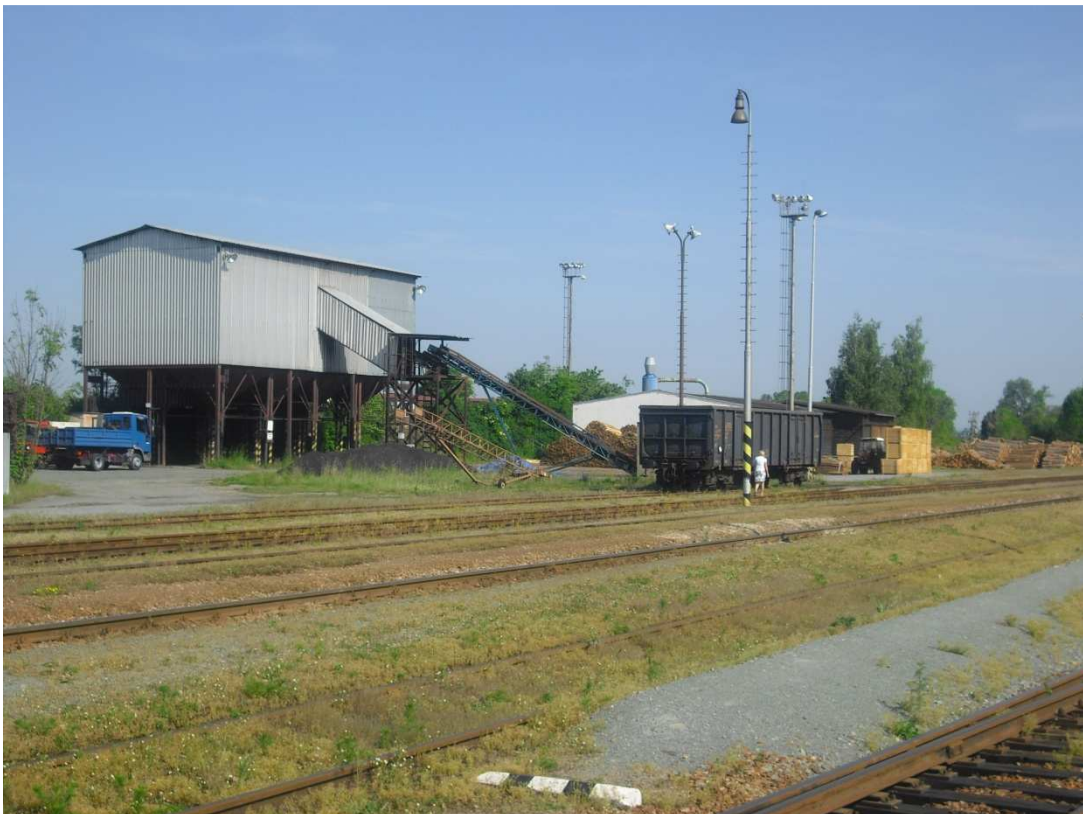
Fotodokumentace 10 - Úrovňová skládka, uhelné sklady, pásové dopravníky
