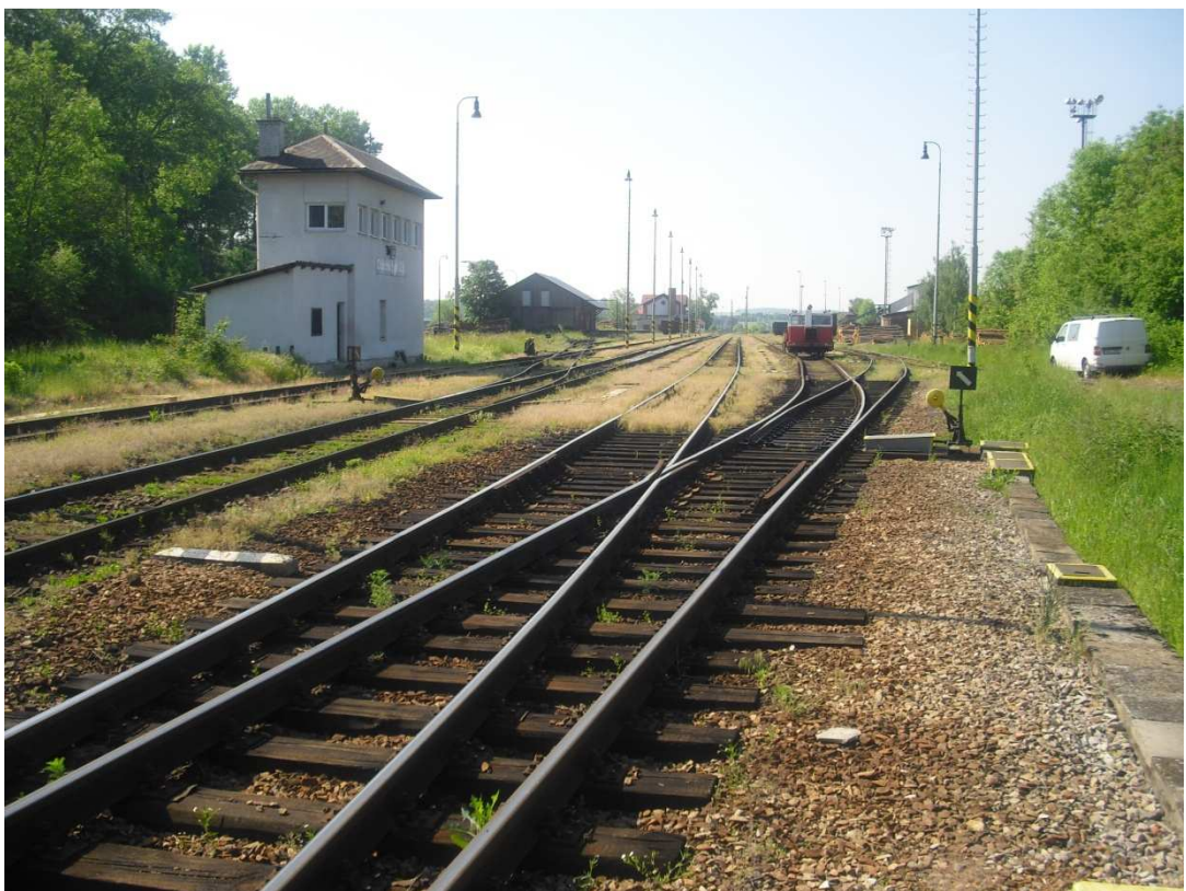
Fotodokumentace 22 - Rozvětvení bohuslavického zhlaví
