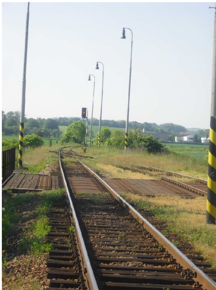
Fotodokumentace 26 - Začátek bolehošťského zhlaví, výhybka č. 1
