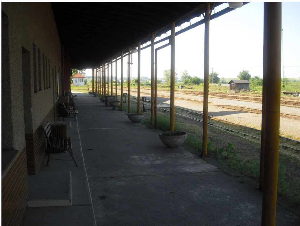
Fotodokumentace 15 - Zpevněná zastřešená plocha u výpravní budovy
