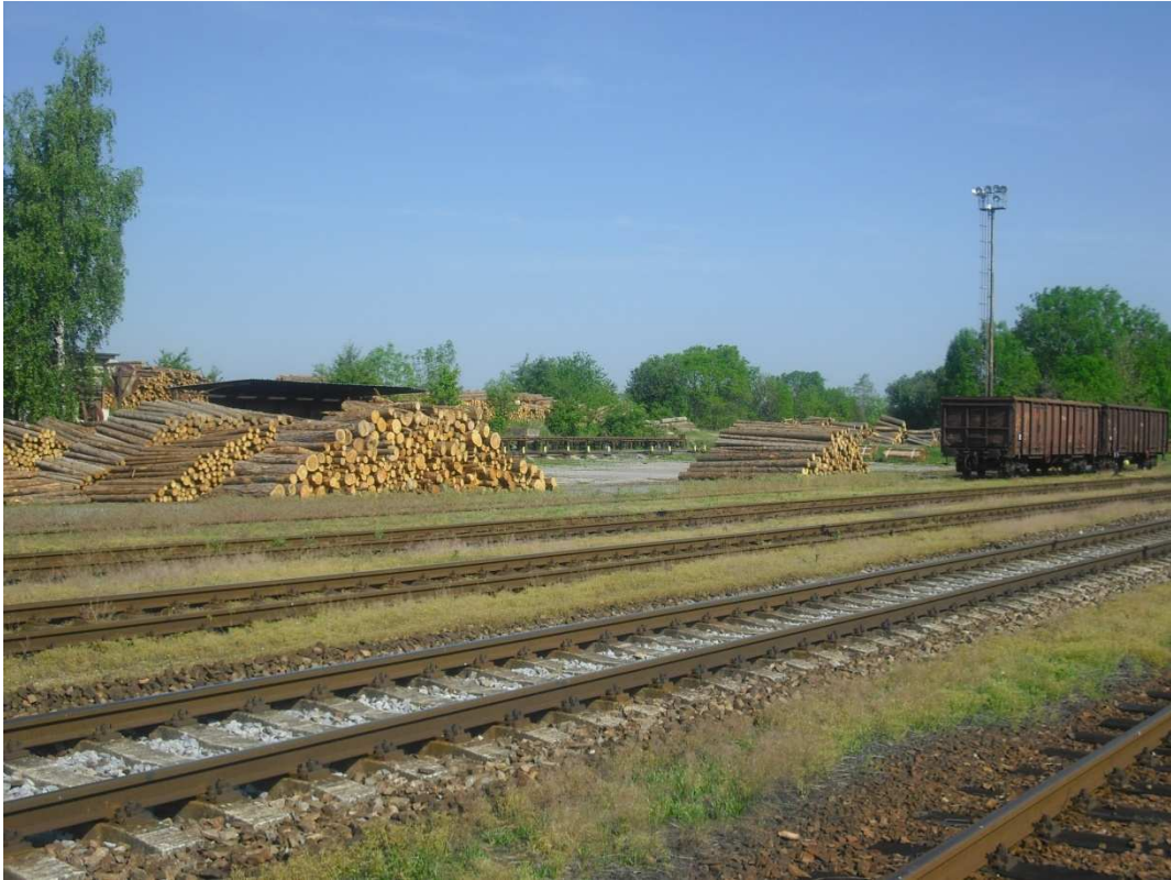
Fotodokumentace 9 - Úrovňová skládka, dřevařské sklady
