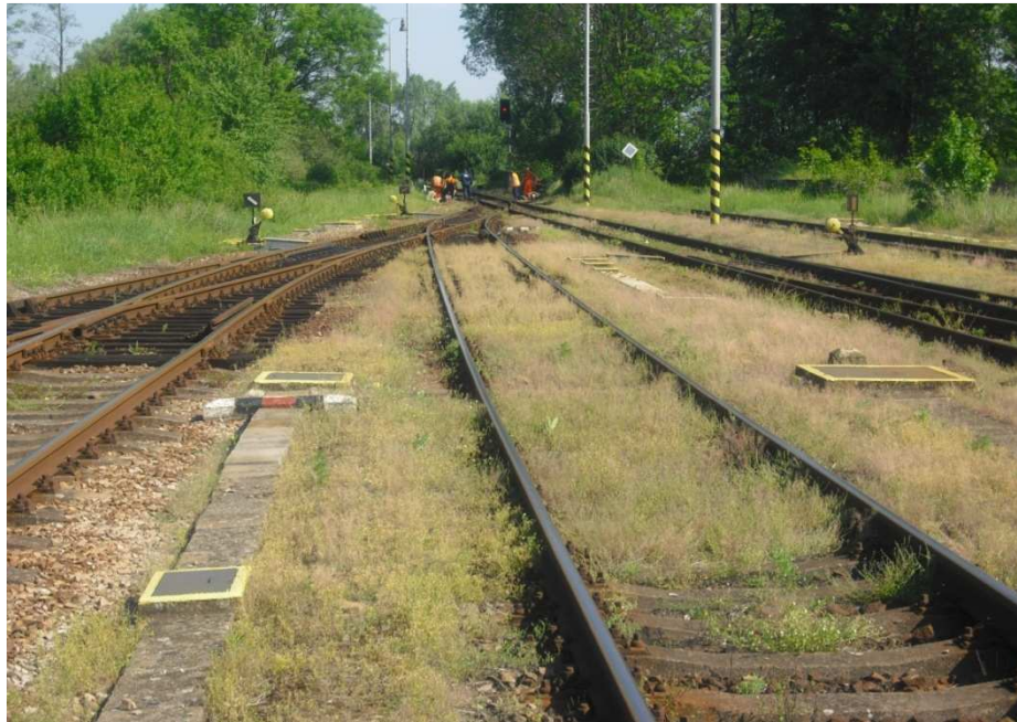
Fotodokumentace 25 - Bohuslavické zhlaví, probíhající práce na výhybce č. 17
