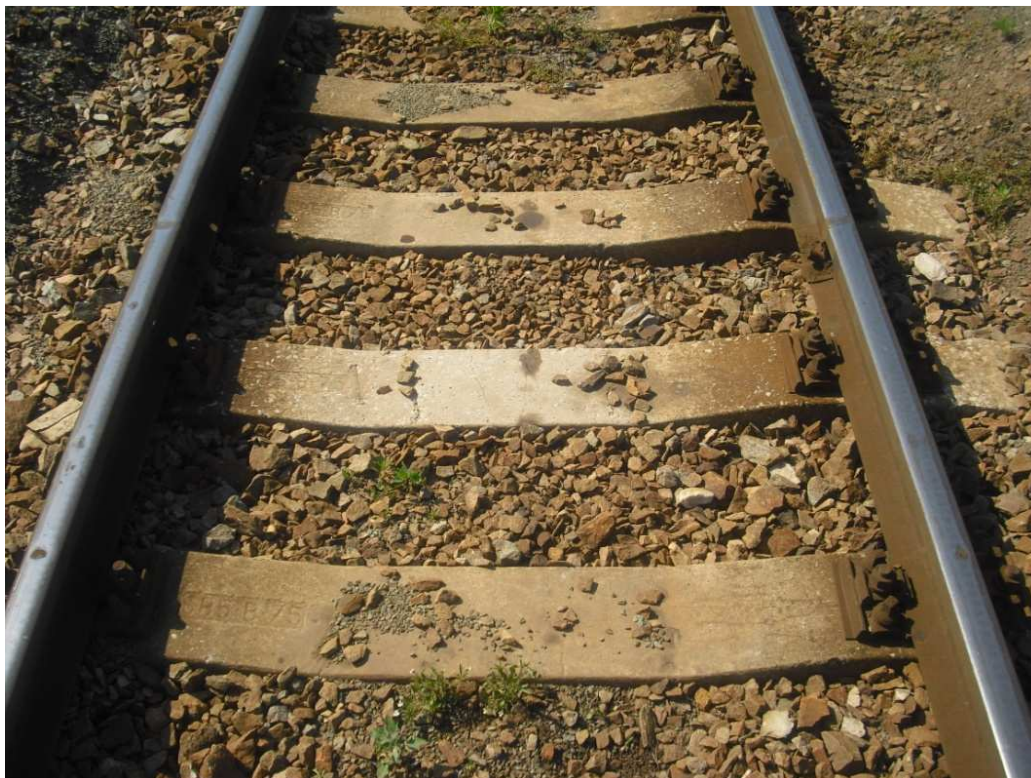
Fotodokumentace 17 - Železniční svršek - kolejnice S49, betonové pražce SB5
