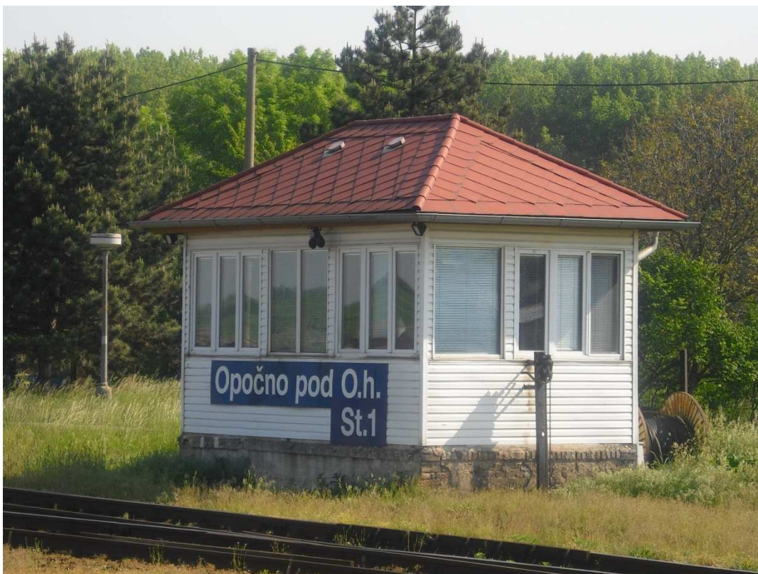
Fotodokumentace 23 - Stavědlo č. 1
