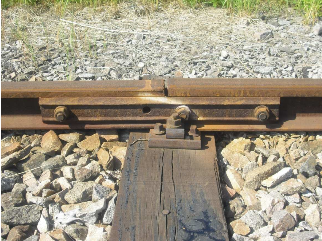
Fotodokumentace 19 - Kolejnicový styk v manipulační koleji
