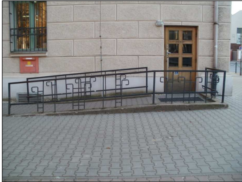
Obrázek 18 Nájezd pro vozíčkáře do České pošty [zdroj: vlastní]
