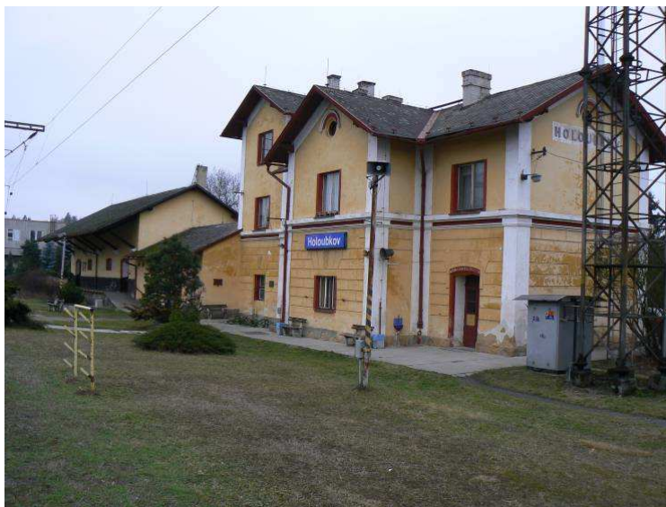
Obr. 1 Výpravní budova žst. Holoubkov
