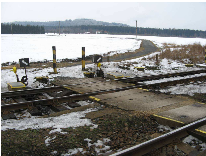
Obr. 4 Stávající přechod na kařízeckém zhlaví
