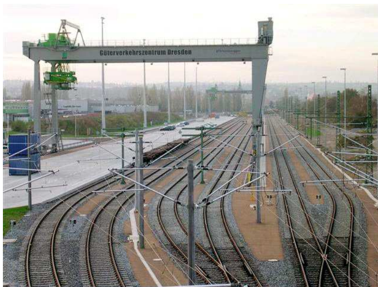
Obr. 22: Terminál GVZ Dresden
