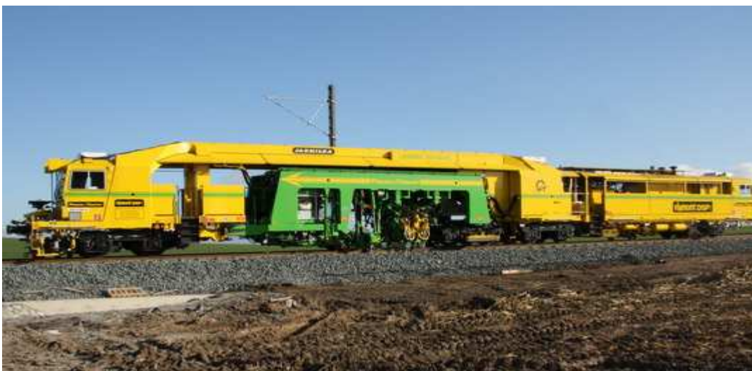
Obrázek č. 5: Údržba železniční tratě
