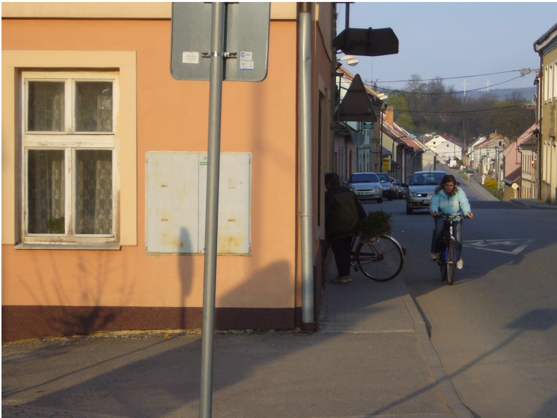
Detail stávajícího chodníku na Olomoucké ulici
