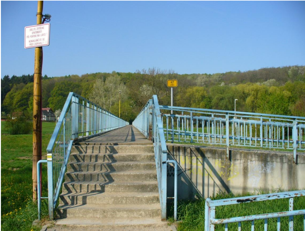
Obrázek: Lávka pro pěší přes řeku Moravu v Otrokovcích
