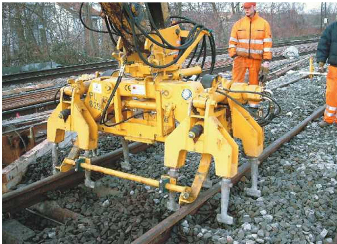
Obr. 28 Podbíjecí agregát AST 8 Windhoff [16]
