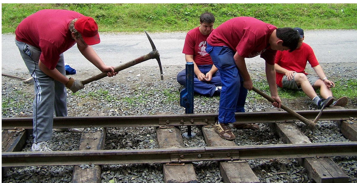
Obr. 3 Ruční podbíjení
