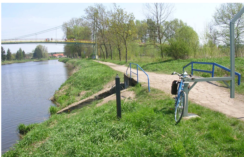
Obrázek 1: vyústění odvodňovací strouhy, v pozadí prostor přístaviště navrženého Vyhledávací studii
