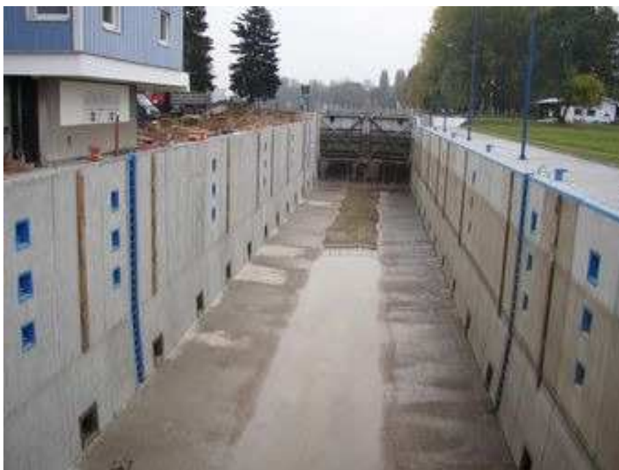
obr. 4: PK Hradištko po rekonstrukci
