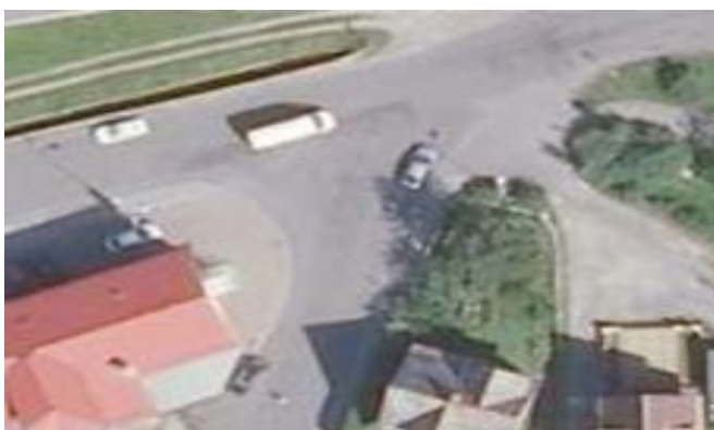
Obr. č. 10: Stav před rekonstrukci
