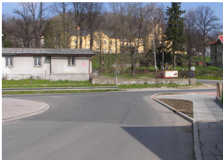
Obr. č. 2: Narovnání křižovatky typu „Y“ Zdroj: Autor
