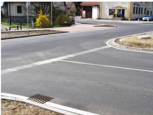
Obr. č. 11: Stav po rekonstrukci Zdroj: Autor
