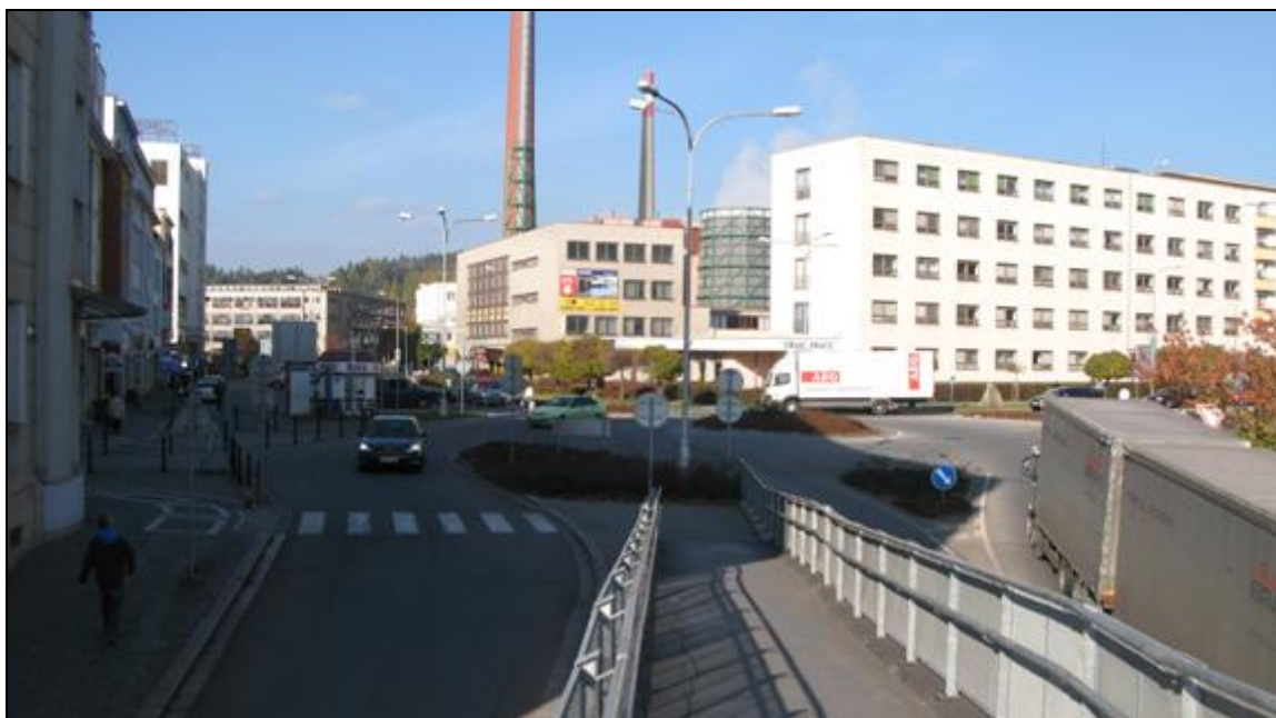
Obr. 20 – Pohled na okružní křižovatku „U Itálie“ (autor práce)
