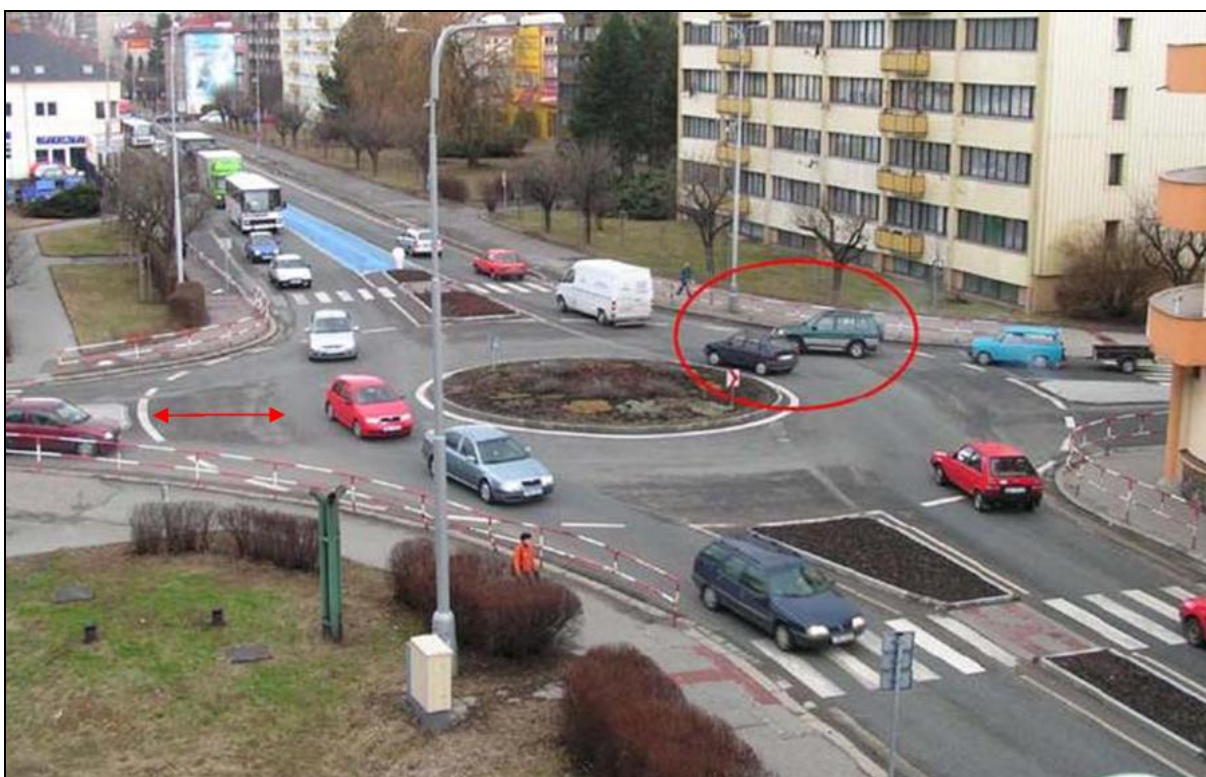
Obr. 16 – Vyznačené nedostatky na okružní křižovatce „U Slavie“ (9, úprava: autor práce)
