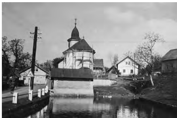
Bukvice, náves s kaplí sv. Jana Nepomuckého při opravě
