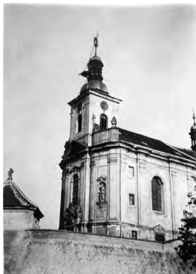
Kostel při opravě (nátěr, plechování) v roce 1945
