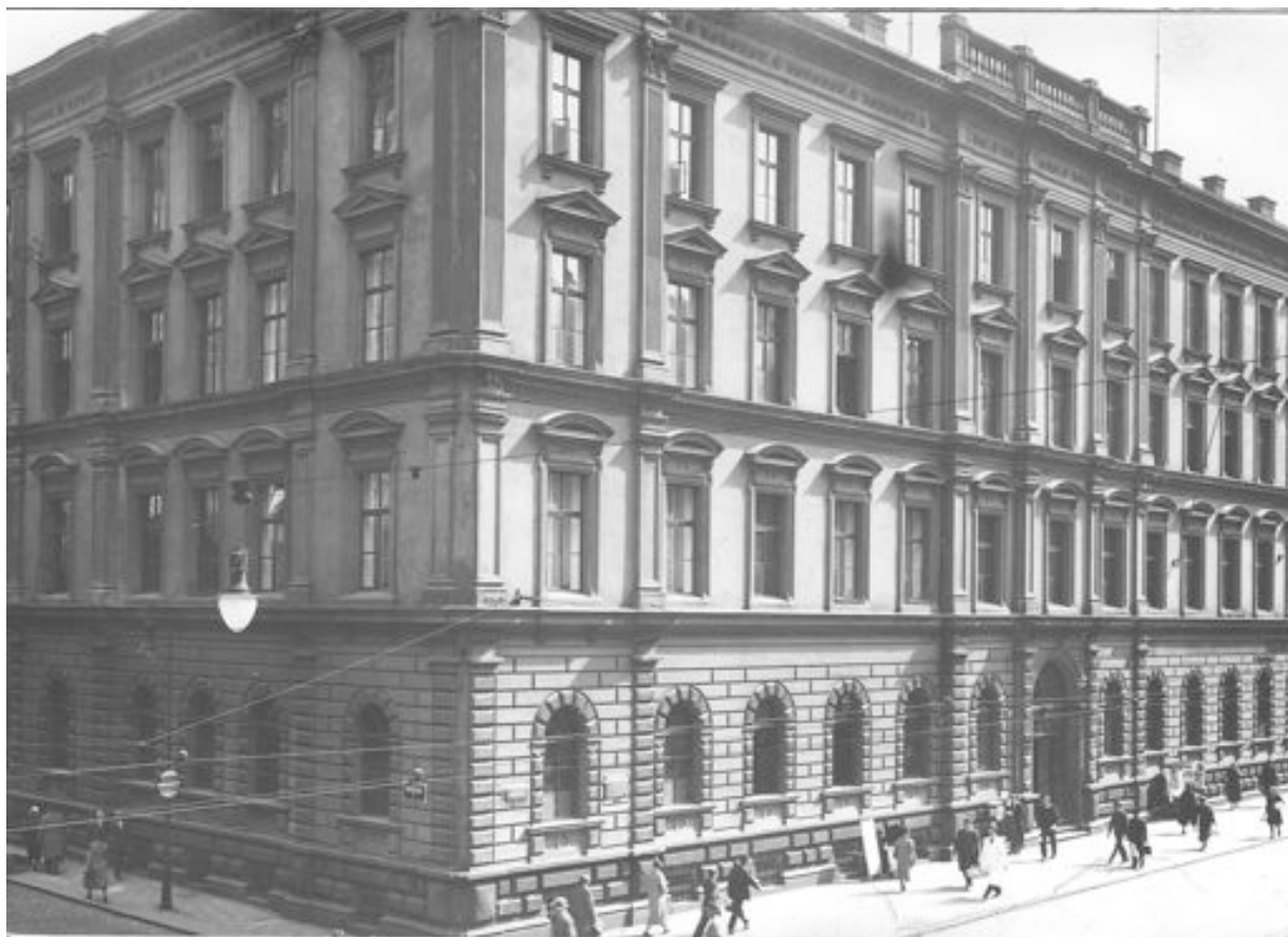
56. Hlavní poštovní úřad Praha 1, 1935.
