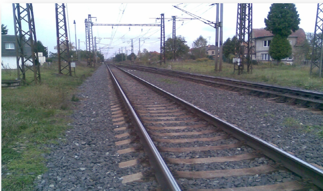
Obr. 2: Začátek úpravy – pohled od železničního přejezdu v KM 307,556 směrem ze stanice
