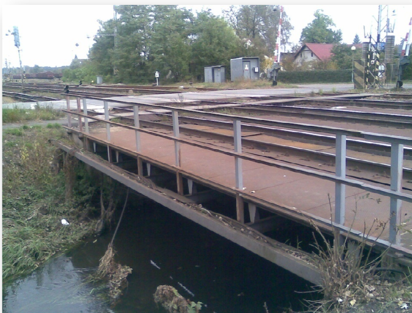
Obr. 15: Železniční ocelový most v KM 306,479
