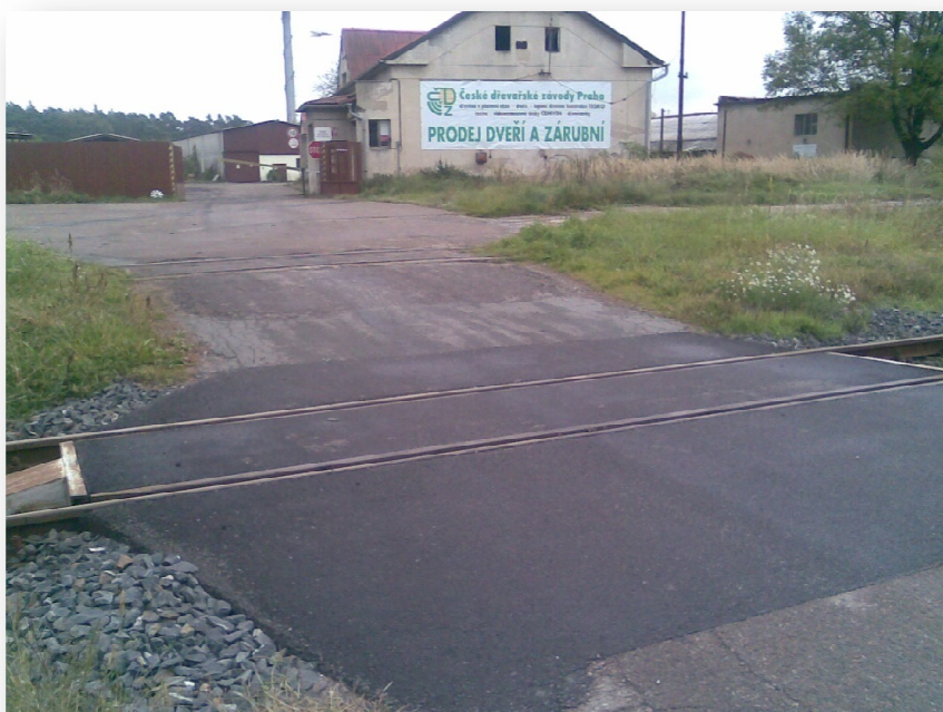
Obr. 6: Železničního přejezdu v KM 307,556 přes trať č.020
