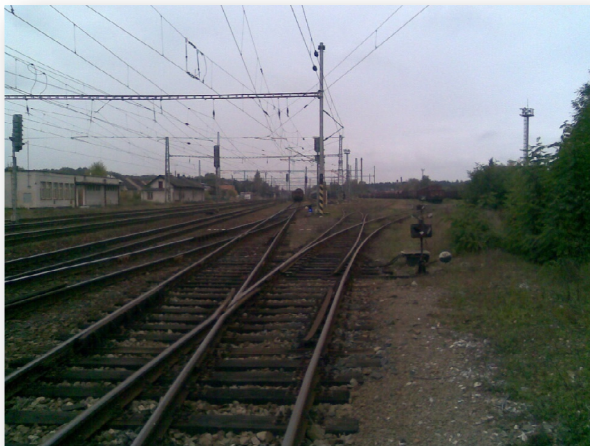
Obr. 16: Pohled na DKV u výhybky č.11
