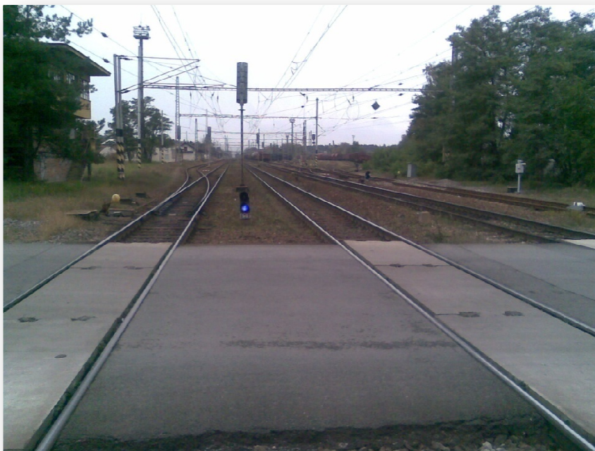
Obr. 13: Konec úpravy – pohled od železničního přejezdu v KM 306,506 směrem do stanice
