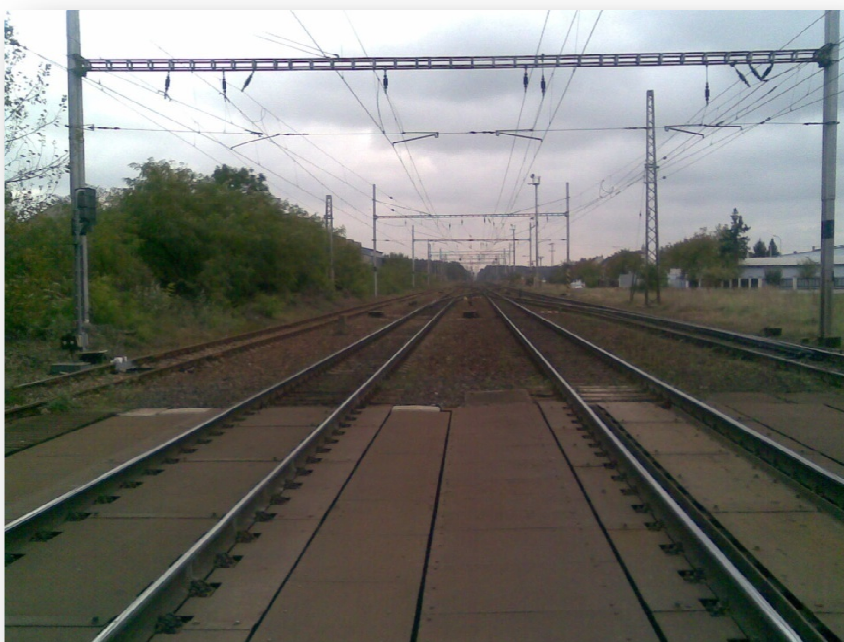
Obr. 14: Pohled od železničního přejezdu v KM 306,506 směrem ze stanice
