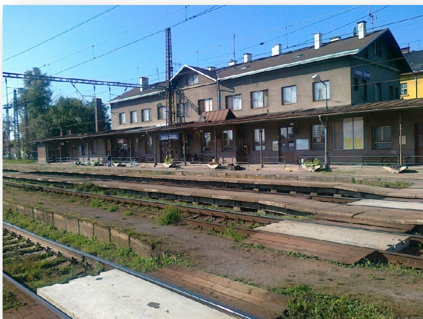
Obr. 8: Výpravní budova v žst. Velký Osek
