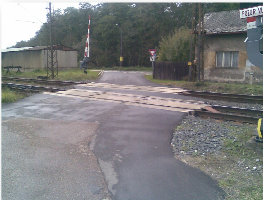
Obr. 3: Železničního přejezdu v KM 307,556 přes trať č.231
