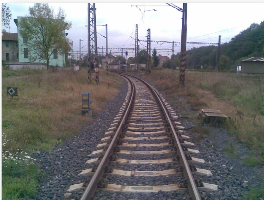
Obr. 4: Trať č.020 – pohled od železničního přejezdu v KM 307,556 směrem do stanice
