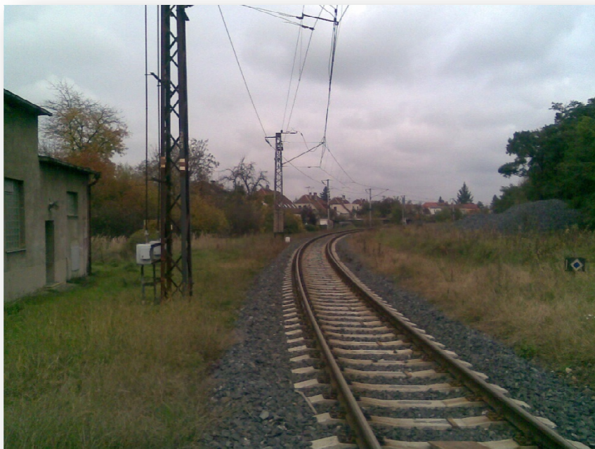
Obr. 5: Trať č.020 – pohled od železničního přejezdu v KM 307,556 směrem ze stanice
