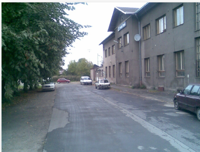
Obr. 12: Přednádražní prostor před výpravní budovou
