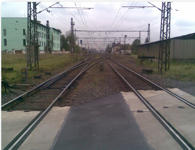
Obr. 1: Začátek úpravy – pohled od železničního přejezdu v KM 307,556 směrem do stanice
