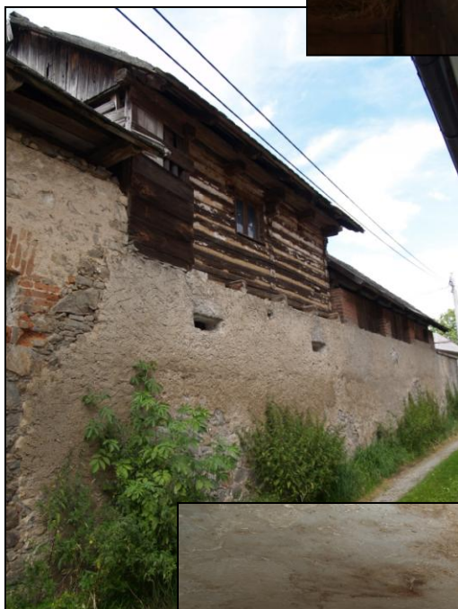
Obr. 6 – pohled na zadní stranu objektu
