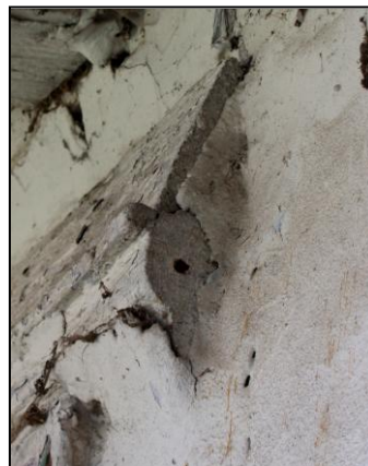
Obr. 11 – detail profilace překladové římsy
