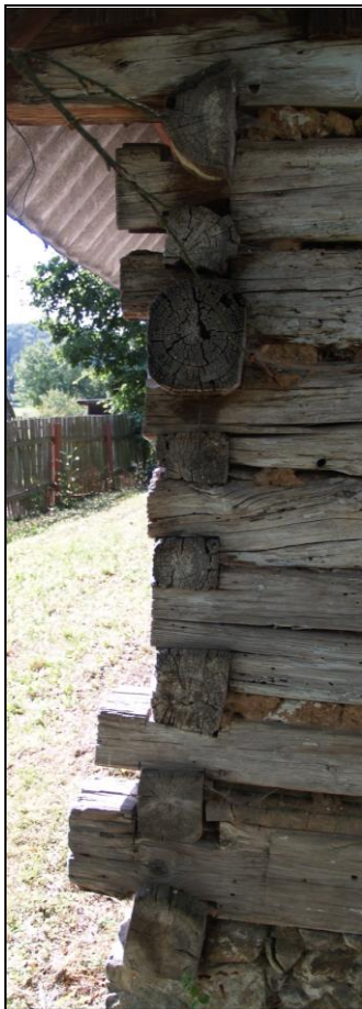
Obr. 4 - detail nároží boční a zadní stěny
