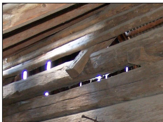
Obr. 8 – detail osedlání krokve na okapovou vaznici
