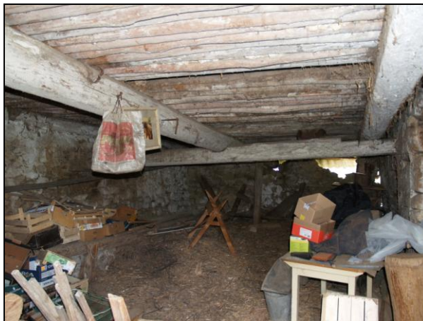
Obr. 17 - hambalkový krov nad hospodářskou částí
