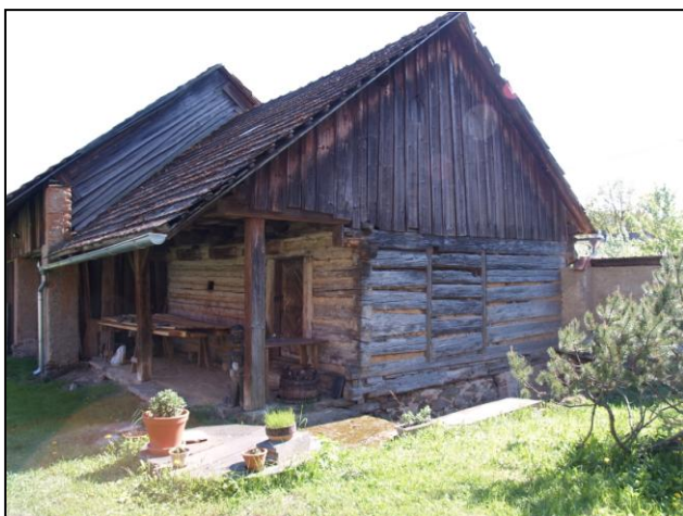
Obr. 3 – zadní strana objektu, vespod s vystupujícími podlahovými trámy
