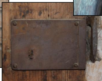
Obr. 15 – detail krabicového zámků
