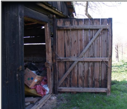
Obr. 3 – točnicová vrata trámové konstrukce
