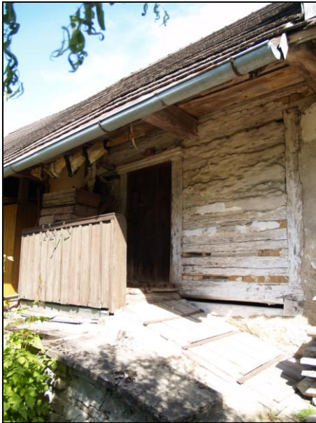
Obr. 3 – trámový portál s vloženým překladovým trámem
