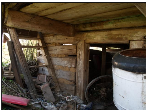
Obr. 4 – trámový portál s průběžným překladovým trámem
