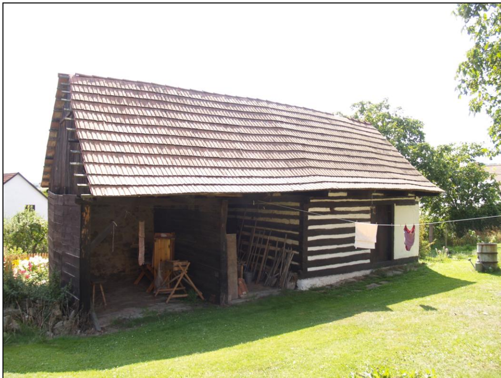
Obr. 1 – pohled od jihu
