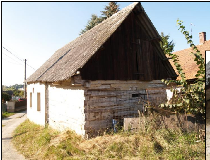
Obr. 1 – levá příčná stěna s užitkovým otvorem a bednění štítu před výměnou
