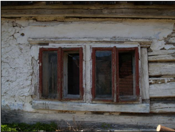
Obr. 9 – detail profilace překladové římsy
