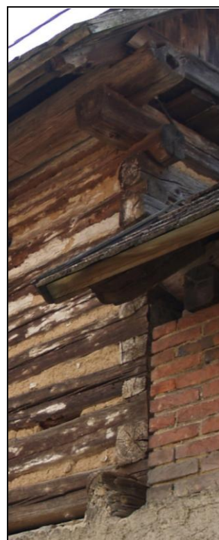
Obr. 7 – rybinové spoje a horní a dolní věnec nároží levé příčné a zadní stěny
