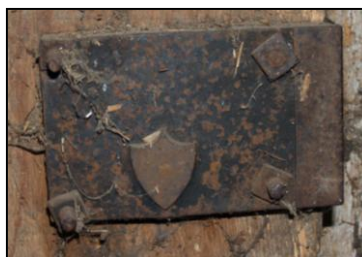
Obr. 8 – detail krabicového zámku
