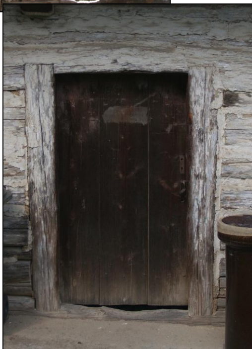
Obr. 8 – trémový portál s průběžným překládovým trémem v levé komoře
