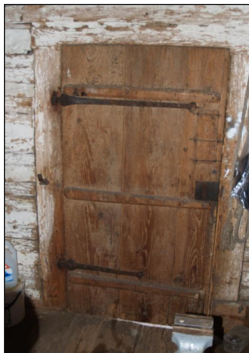
Obr. 7 – svlakové dveře s krabicovým zámekem
