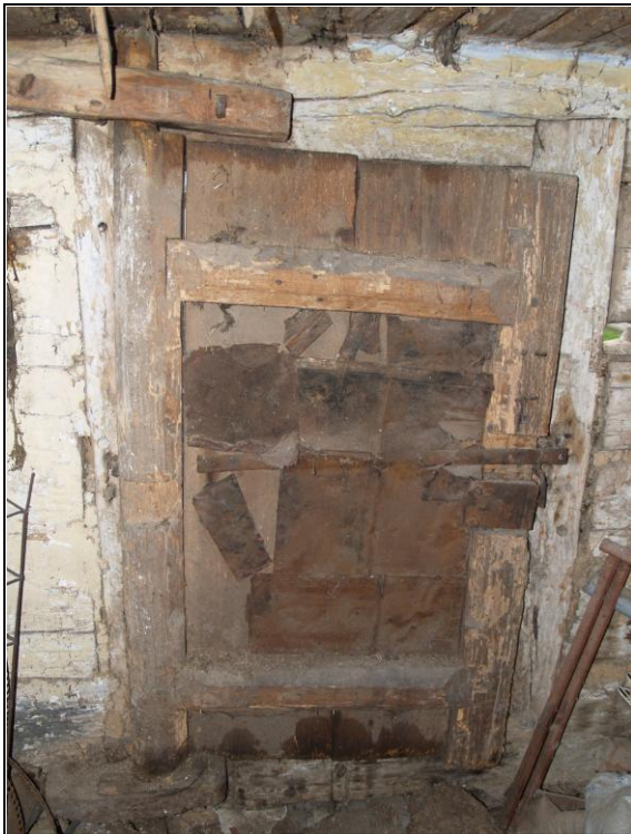
Obr. 3 – točnicové dveře trámové konstrukce
