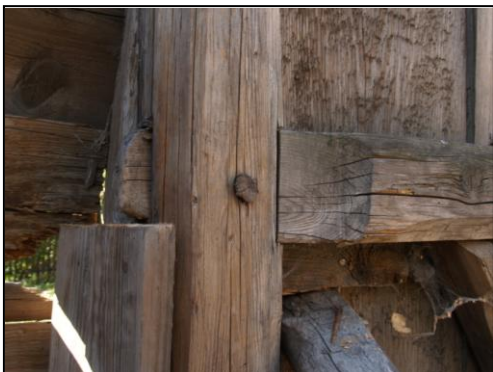
Obr. 6 – rybinové spoje
