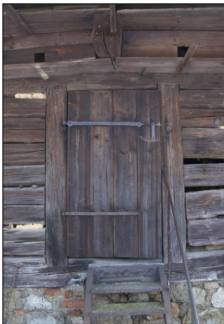
Obr. 4 – trámový portál s průběžným překladovým trámem osazený sbíjenými dveřmi
