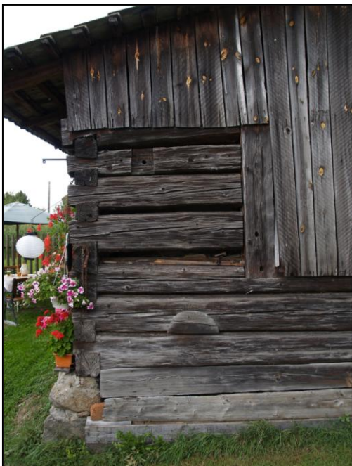
Obr. 6 – nároží s levou trámovou stojkou otvoru v přepážce mezi pemou a mlatem
