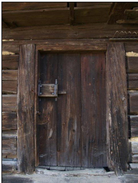
Obr. 4 – trámový portál s průběžným překladovým trámem osazený sbíjenými dveřmi
