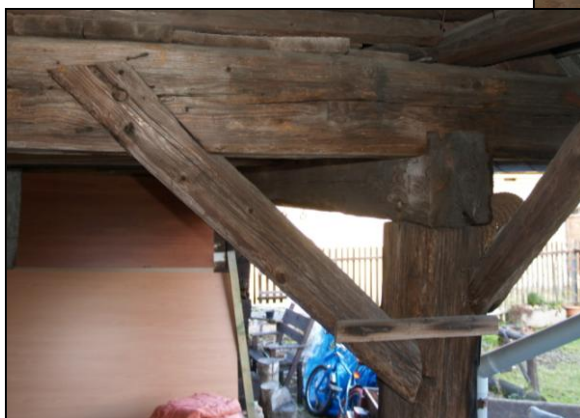
Obr. 8 – Stojka s páskem podpírající rámovou kolnu
