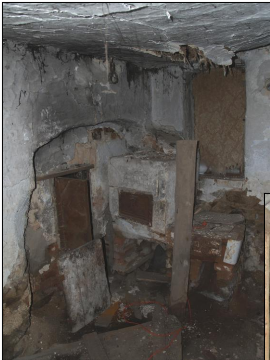
Obr. 15 – sporák umístěný před nikou s obslužným otvorem do pece
