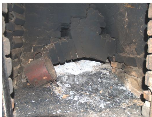
Obr. 12 – ústí pece a odtahové otvory
