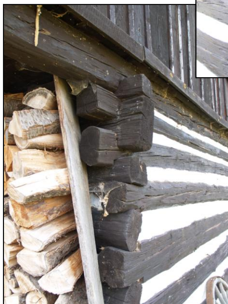
Obr. 4 – horní věnec nároží vstupní a pravé příčné stěny
