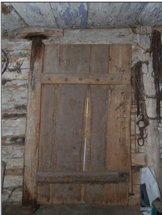
Obr. 6 – točnicové dveře trámové konstrukce
