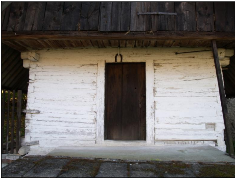
Obr. 3 – vstupní stěna s portálem s průběžným překladovým a prahovým trámem
