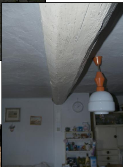
Obr. 8 – druhotně použité trámy na nároží stěn stodůlky
