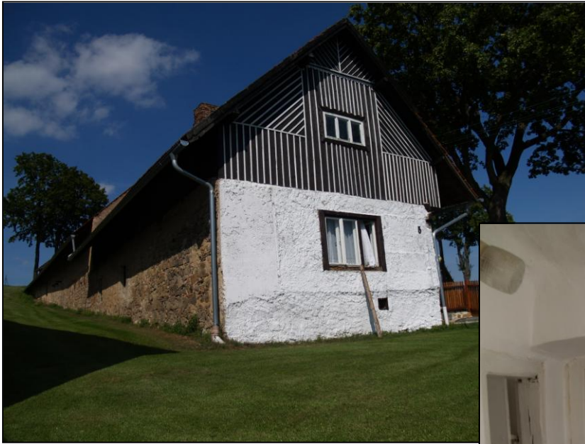
Obr. 5 – zadní a štítová stěna s bedněním
