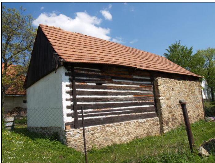
Obr. 2 - Přezděná příčná (štíťová) a zadní roubená stěna sýpky, zděná stěna kolny.
