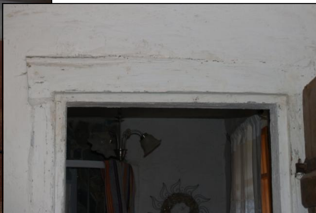
Obr. 9 – trámový portál s polodrážkou ve spíží koře (dnes koupelna)
