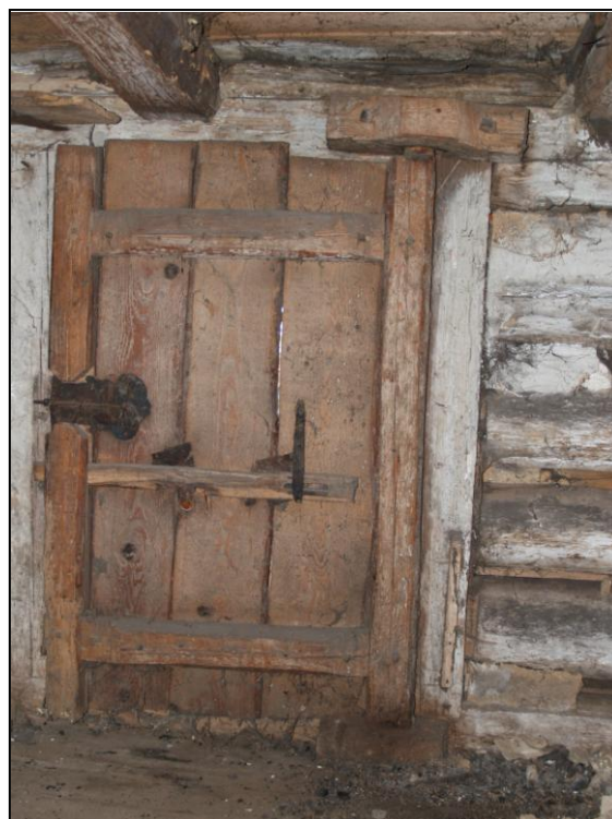
Obr. 5 – točnicové dveře se zámkem na tvarovaném nosném plechu a dřevěná závora (viz. Exkurz II.)
