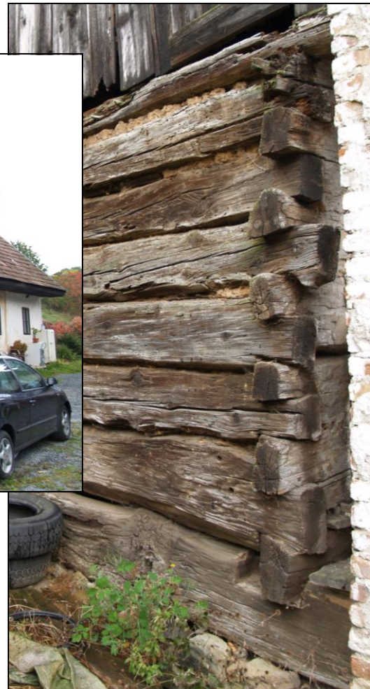
Obr. 2 – rybinové spoje s krátkými přesahy trámů na nároží vstupní a boční stěny
