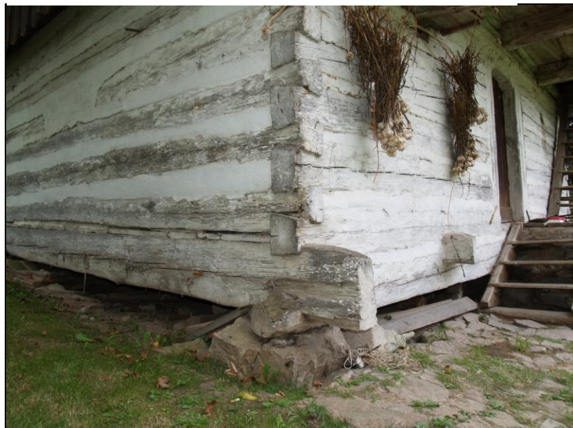
Obr. 4 – dobře zachované přesahy trámů v dolním věnci nároží
