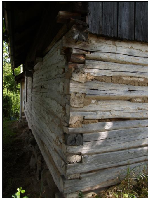
Obr. 6 – rybinové spoje a nároží levé příčné a zadní podélné stěny levé komory
