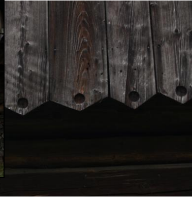
Obr. 2 – detail bednění štítu
