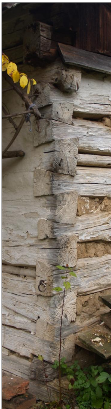
Obr. 6 – rybinové spoje na nároží pravé podélné a zadní příčné stěny
