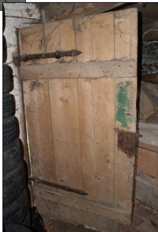
Obr. 7 – dveře sbíjené na způsob svlaku s krabicovým zámkem s taliřkovitou klikou
