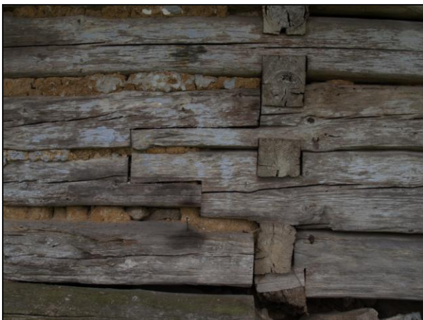
Obr. 8 – detail napojení trámů přeplátováním u zaroubené příčky mezi černou kuchyní a ko morou
