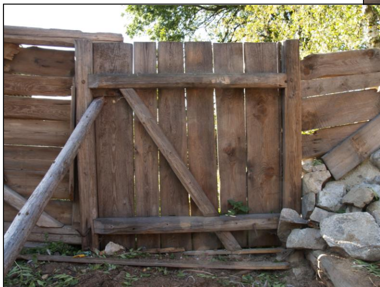
Obr. 5 – začepování horizontálního trámku do bočního zajištění kolíkem
