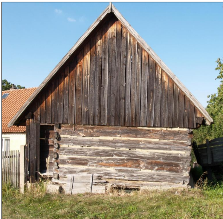
Obr. 2– Boční stěna sýpky s novým bedněním na štítě
