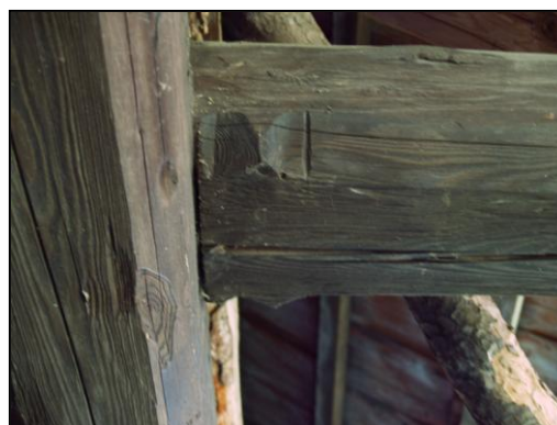
Obr. 6 – Okosení přesahujících stropních trámů
