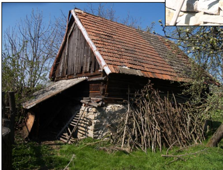
Obr. 4 – pohled od jihu
