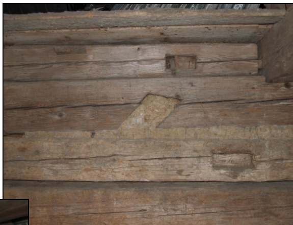
Obr. 7 – druhotně užitě trámy v levé boční stěně
