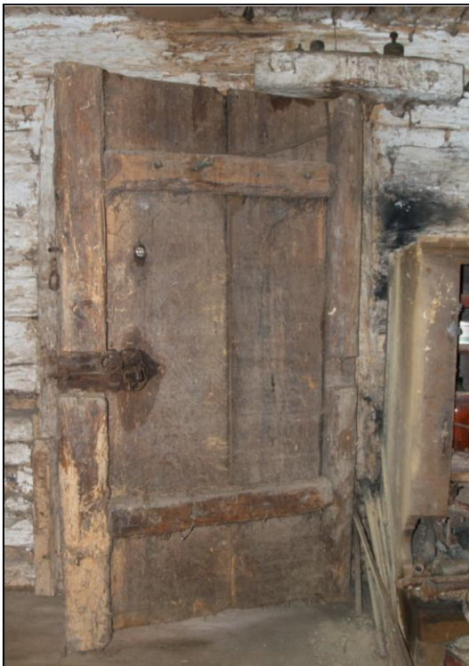
Obr. 4 – točnicové dveře trámové konstrukce se zámkem na tvarovaném nosném plechu
