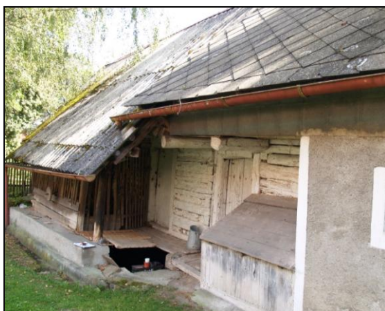
Obr. 11 – vstupní stěna II. a III. komory
