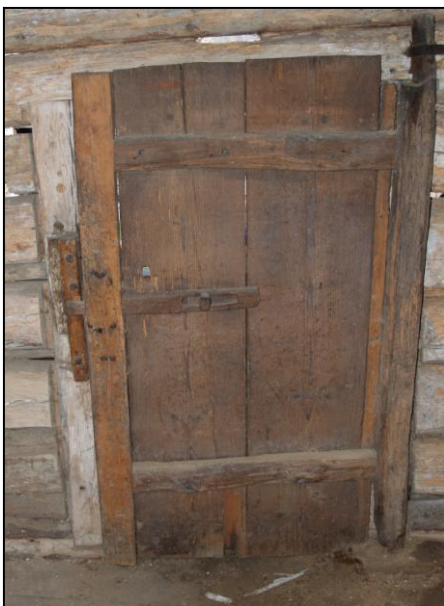
Obr. 11 – točnicové dveře rámové konstrukce s dřevěnou závorou v pravé komoře
