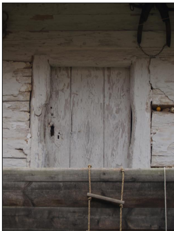
Obr. 3 – trámový portál s průběžným překladovým trámem a s oble probranými stojkami
