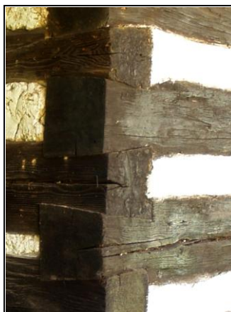
Obr. 6 – Okosení přesahujících stropních trámů
