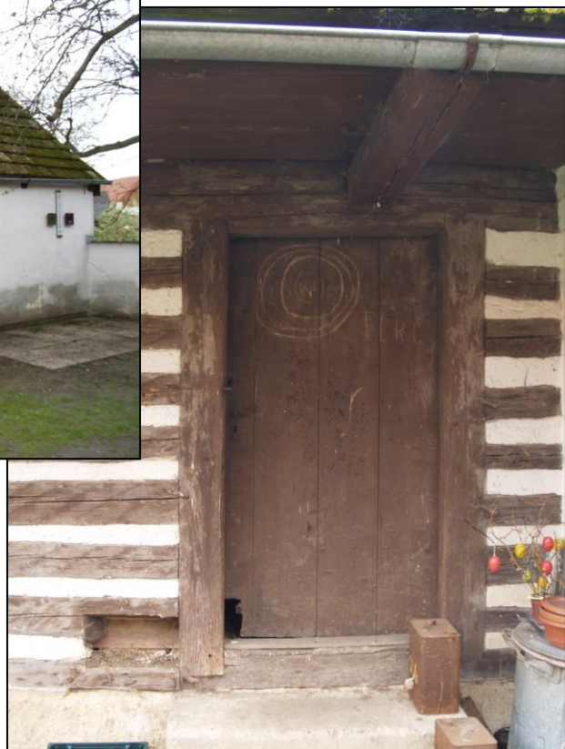
Obr. 2 – trámový portál s průběžným překladovým trámem, vedle levé stoky je otvor vedoucí do sklepa
