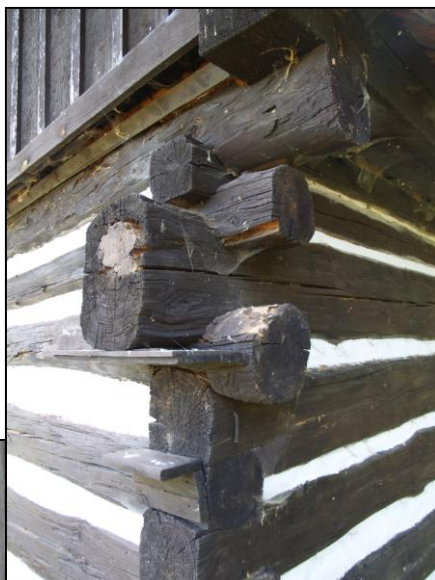
Obr. 3 – horní věnec nároží pravé příčné a zadní stěny
