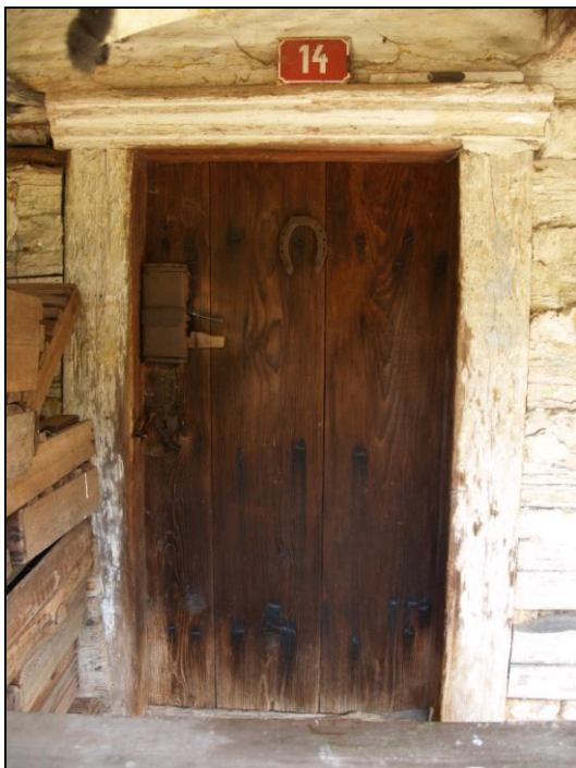
Obr. 3 – trámový portál s vloženým překladovým trámem
