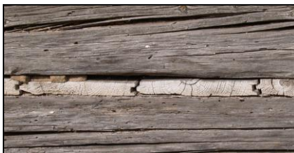
Obr. 9 – podlahová prkna spojená na pero a drážku položená na podlahové trámy a na trámy příčných stěn
