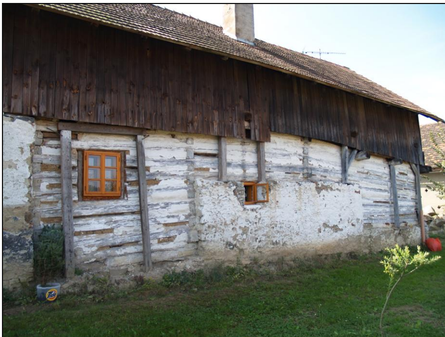
Obr. 2 – pohled od severovýchodu na zadní stranu domu s vystupujícím tělesem pece a zadní stěny černé kuchyně
