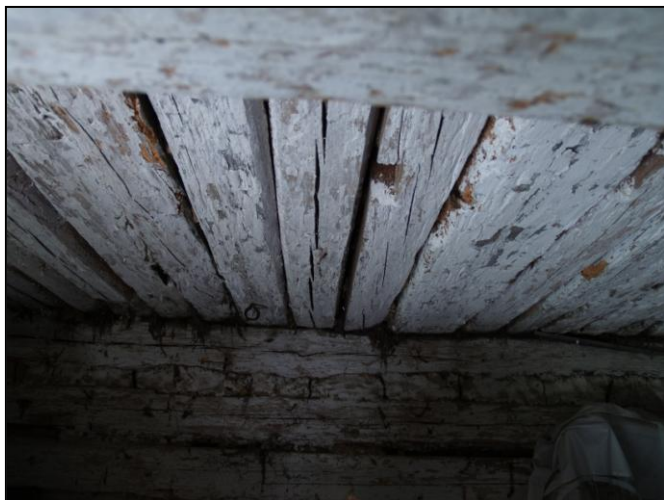
Obr. 5 – trémový strop se záklopy z půlených povalů v levé komoře
