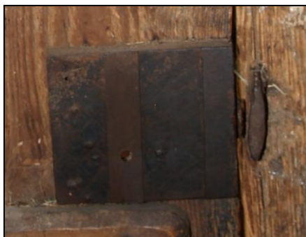
Obr. 8 – detail krabicového zámku
