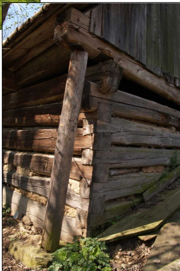
Obr. 3 – rybinové spoje a horní věnec zadní a levé příčné stěny
