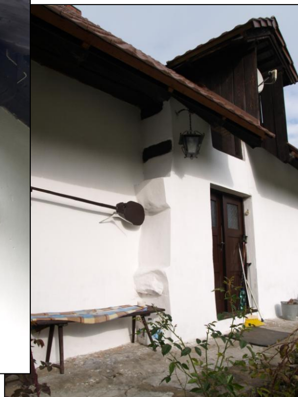
Obr. 4 – ponechané šmorce v nádvořní stěně
