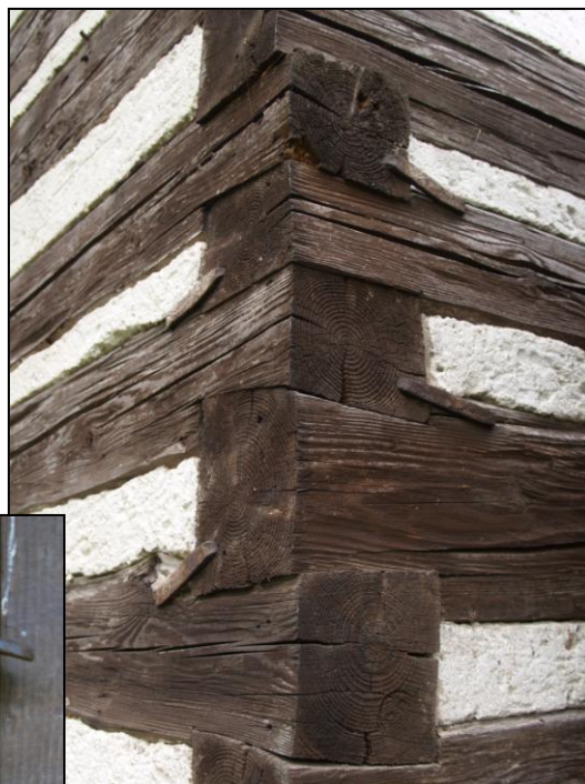
Obr. 4 – detail rybinových spojů navíc zajištěných kramlemi
