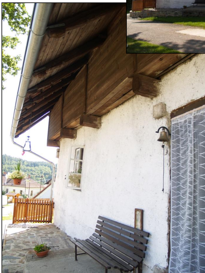
Obr. 4 – zápraží domu s krátkými přesahy stropních trámů, na kterých je vynesena dřevěná podezdívka
