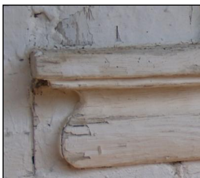
Obr. 7 – detail profilace parapetní římsy
