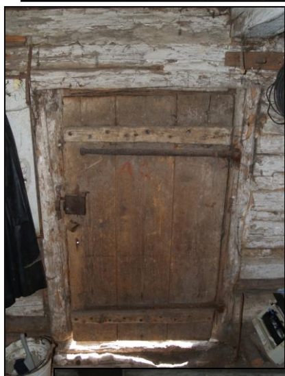
Obr. 7 – svlakové dveře s krabicovým zámekem v levé komoře
