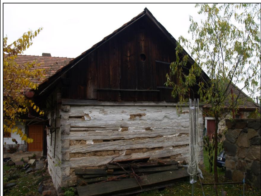
Obr. 7 – zadní stěna a bednění štítu
