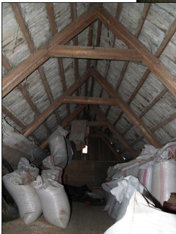
Obr. 6 – jednoduchý krov s krokve mi rozepřenými hambalky
