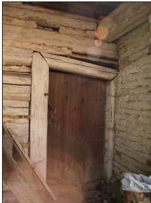
Obr. 7 – samostatný trámový portál s diagonálními švy v pravé komoře
