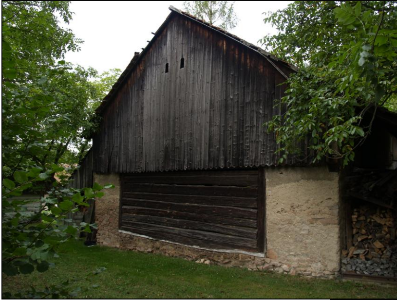
Obr. 3 – trámy vložené mezi pilíře do stojek na pero a drážku
