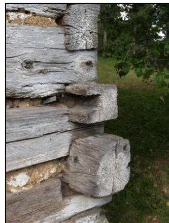
Obr. 6 – detail dolního věnce nároží boční a zadní stěny s druhotně použitými trámy
