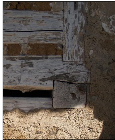
Obr. 4 – detail profilace překladového trámu portálu
