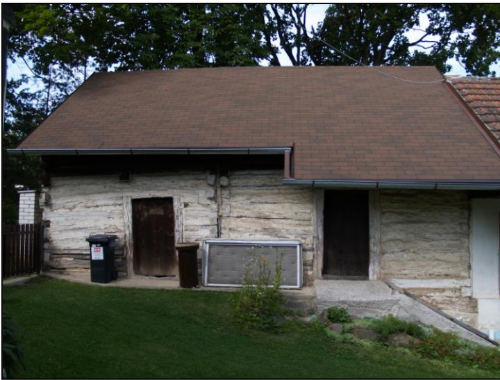
Obr. 1 – pohled na vstupní stěny objektů
