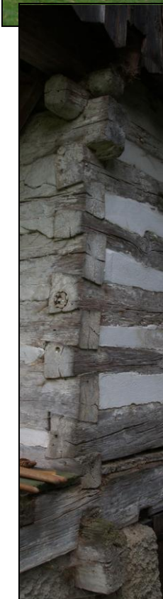
Obr. 3 – rybinové spoje, horní a dolní věnec nároží vstupní a pravé příčné stěny
