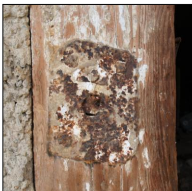
Soběhrdy čp. 11 - Obdélný štítek se šroubem s jedním otvorem v hlavě
