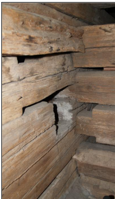
Obr. 8 – druhotně použité trámy na nároží stěn stodůlky
