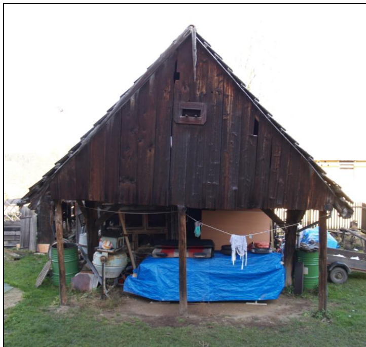
Obr. 2 – Bedněný štít s otvorem
