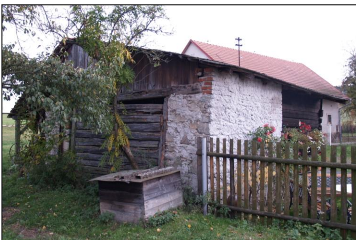
Obr. 5 – zadní stěna se zděnými pilíři
