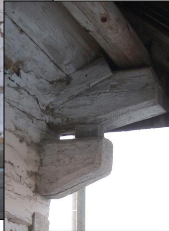
Obr. 5 – horní věnec nároží vstupní a pravé příčné stěny s šikmo podebranými trámy, z nichž vyšší patří nefunkční okapové vaznici
