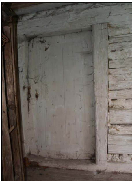
Obr. 10– horní věnec nároží pravé příčné a zadní stěny II. komory s druhotně použitými trámy
