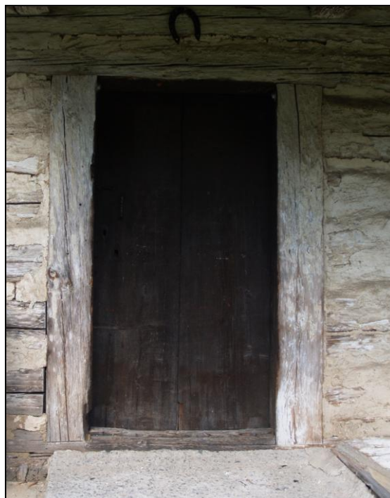
Obr. 9 – trémový portál s průběžným překládovým trémem v pravé komoře
