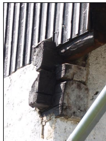
Obr. 2 – detail vystupujícího horního věnce
