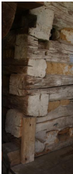
Obr. 3 – rybinové spoje na nároží vstupní a příčné stěny s druhotně použitými trámy
