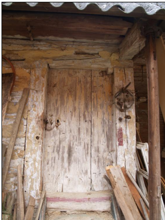
Obr. 4 – Trámový portál se šroubovým zámekem v levé stojce
