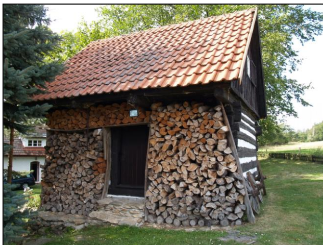
Obr. 2 – vstupní stěna s trémovým portálem a novými dveřmi
