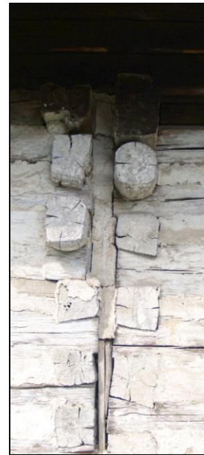
Obr. 4 – detail horního věnce a dřevěné nadezdívky nároží vstupní a levé příčné stěny
