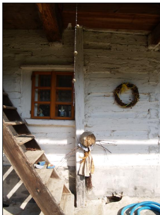
Obr. 6 – trámová zárubeň s vystouplou parapetní a překladovou římsou okenního otvoru do komory
