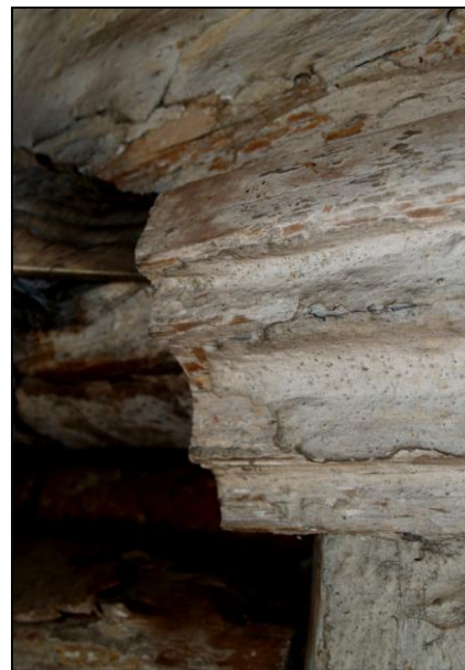
Obr. 4 – detail profilace překladového trámu portálu
