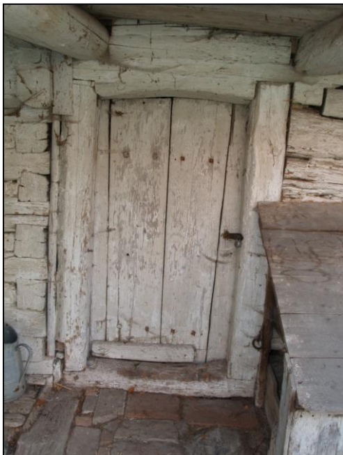
Obr. 13 trémový portál s průběžným překladovým trémem
