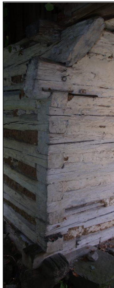
Obr. 5 – detail dolního věnce na nároží zadní a levé příčné stěny
