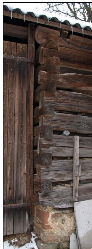
Obr. 5 – rybinové spoje a horní věnec na nároží vstupní stěny a příčky mezi pemou a mlatem
