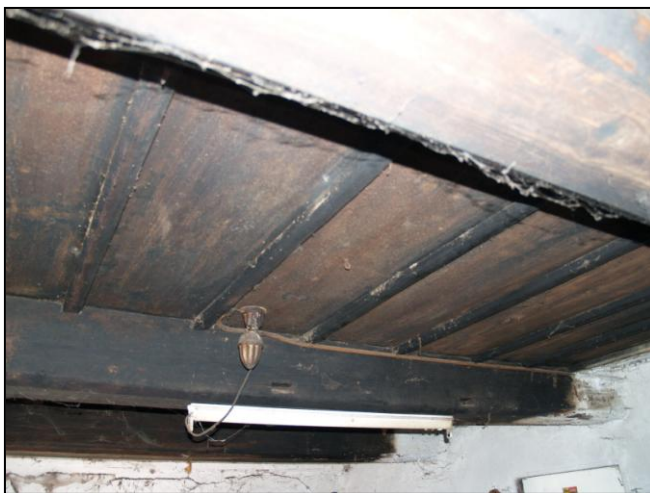
Obr. 12 – strop ve světnici se záklopovými deskami
