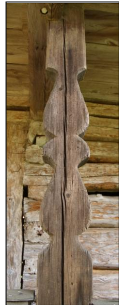
Obr. 8 – profilovaný sloupek pavláčky
