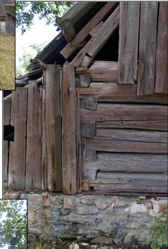
Obr. 2 – Rybinové spoje na nároží a osedláni krokve na okapovou vaznici. V prvním a čtvrtém trámu jsou sdužené otvory po kolících
