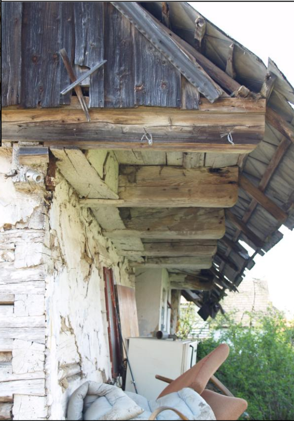
Obr. 8 – zápraží kryté přesahy stropních trámů, vepředu s ukončovací římsou
