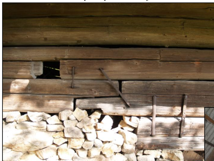
Obr. 6 – detail druhotně použitých trámů zajištěných kramlemi
