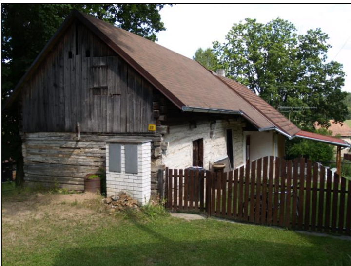
Obr. 3 – levá příčná a podélná vstupní stěna levé komory
