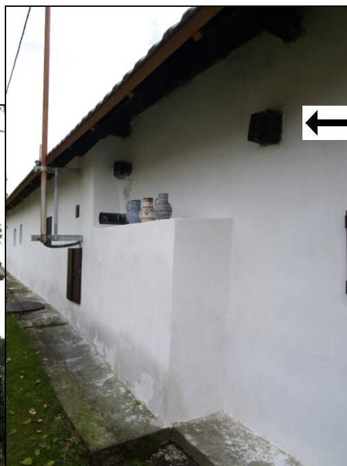
Obr. 5 – vystouplé těleso pece a přesah jednoho stropního trámu ze světnice (viz šipka)
