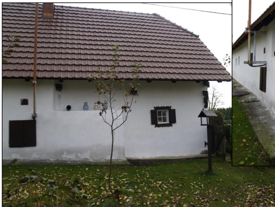
Obr. 5 – vystouplé těleso pece a přesah jednoho stropního trámu ze světnice (viz šipka)
