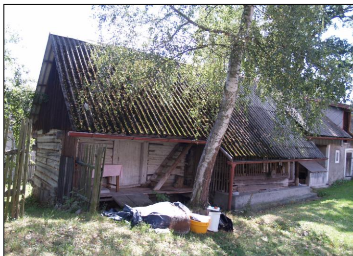
Obr. 1 – celkový pohled na objekty od severovýchodu
