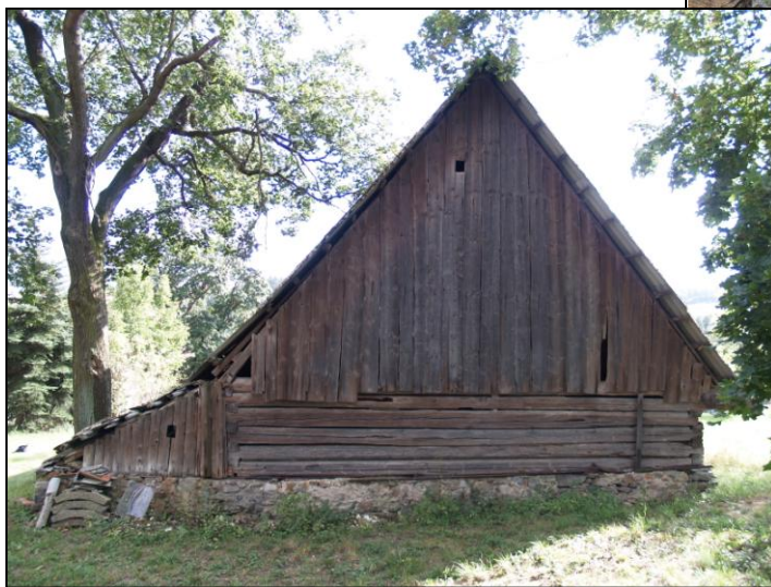
Obr. 3 - severní strana s bedněním štítu
