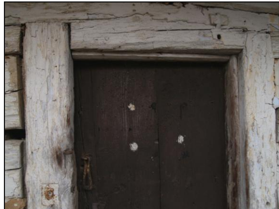
Obr. 4 – portál s průběžným překladovým trámem a se šroubovým zámkem v levé stojce (viz. Exkurz. III)
