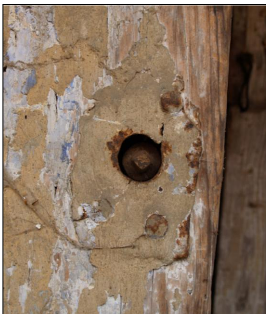
Petroupim čp. 23 – detail štítku se šroubem se čtvercovou hlavou
