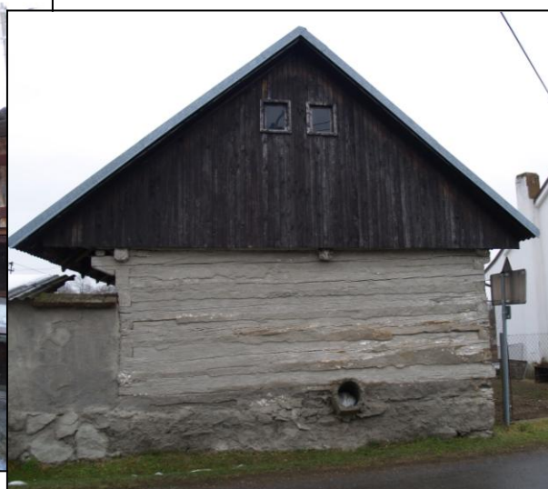
Obr. 2 – pravá příčná stěna a štít s novým bedněním
