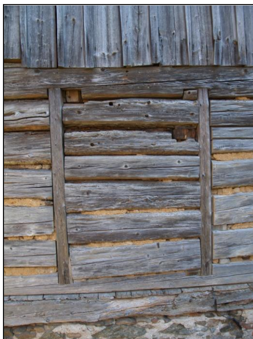
Obr. 2 – zatarasený portál v pravé příčné stěně
