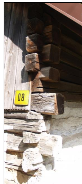
Obr. 4 – detail horního věnce a dřevěné nadezdívky nároží vstupní a levé příčné stěny
