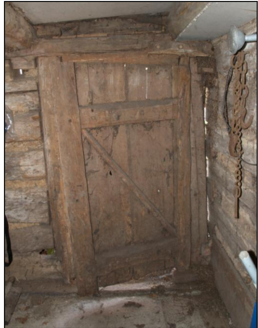
Obr. 14 - točnicové dveře trémové konstrukce se ztužovací diagonálou
