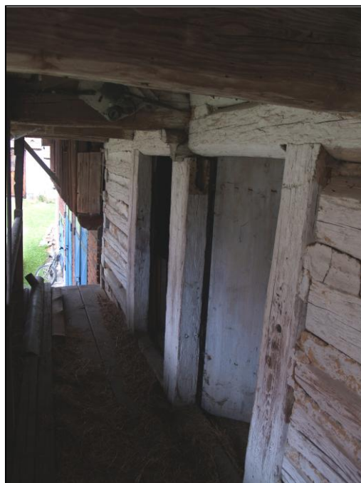
Obr. 7 – rybinové spoje a horní a dolní věnec nároží levé příčné a zadní stěny
