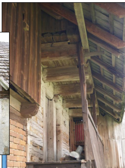
Obr. 2 – pavlůčka s přesahy stropních trámů, které vynášejí okapovou vaznici
