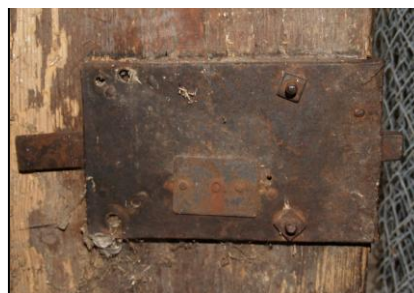
Obr. 6 – krabicový zámek připevněný na svlakových dveřích
