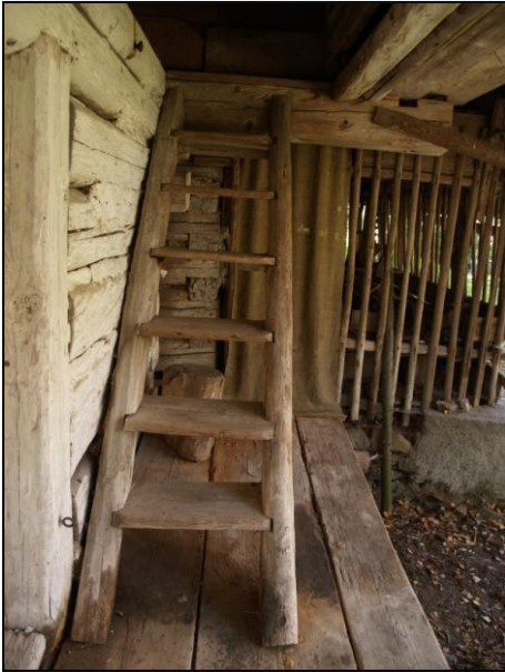
Obr. 2 – pavlůčka I. komory s žebřikovým schodištěm
