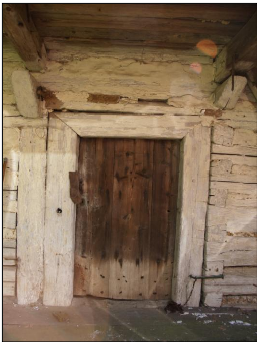
Obr. 6 – samostatný trámový portál s diagonálními švy v levé komoře
