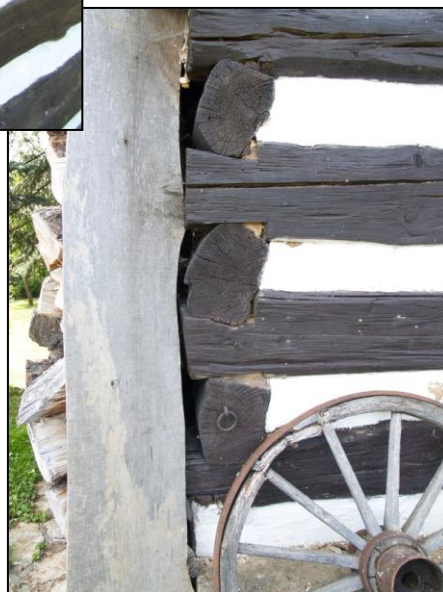
Obr. 5 – rybinové spoje z půlených trámů a kuláčů na nároží pravé příčné a vstupní stěny
