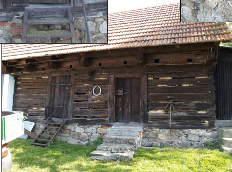
Obr. 5 – vstupní strana s oběma portály a zaroubenou příčkou
