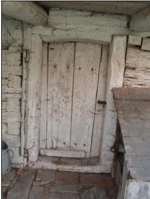
Obr. 13 trémový portál s průběžným překladovým trémem
