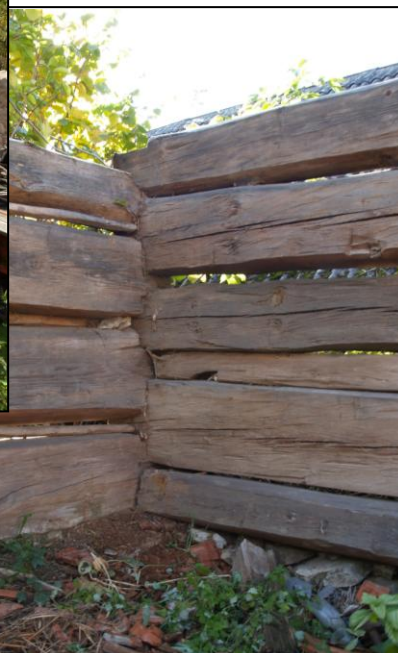
Obr. 2 – vrstvení trámů
