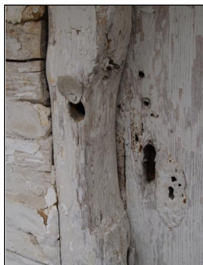
Obr. 4 – detail stojky s otvorem po šroubovém zámku
