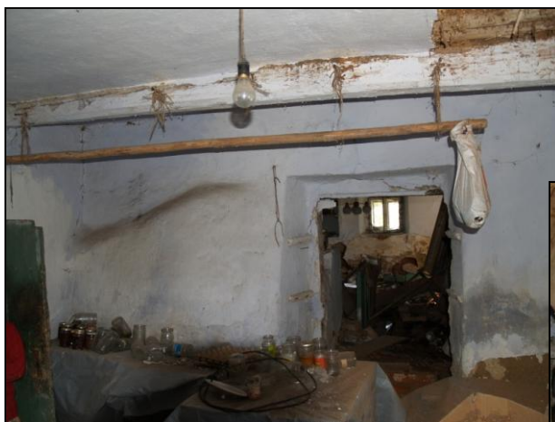
Obr. 14 – komora druhého traktu - pohled ke světničce, ve stěně je viditelné těleso pece
