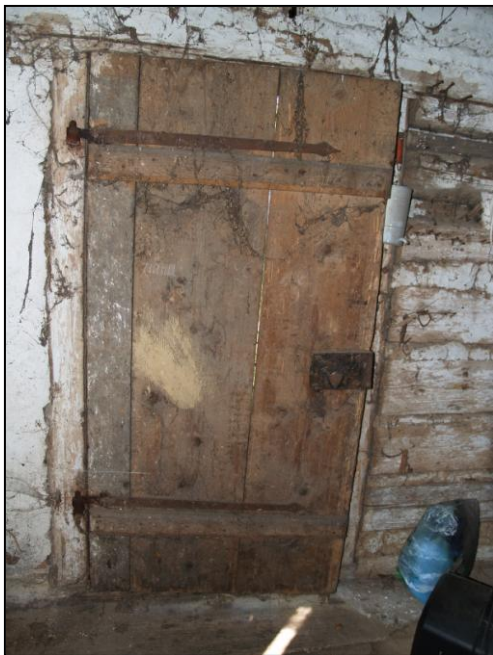
Obr. 7 – svlakové dveře
