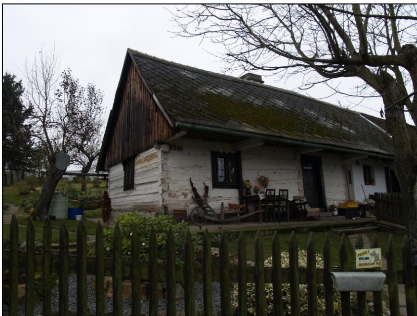
Obr. 3 – štítová stěna a nové bednění štítu
