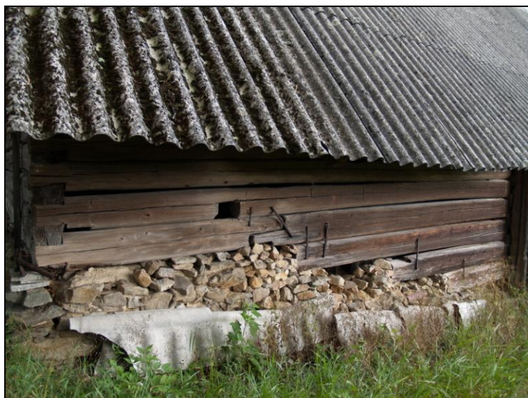
Obr. 6 – detail druhotně použitých trámů zajištěných kramlemi
