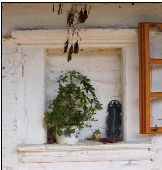
Obr. 5 – trámová zárubeň zataraseného okenního otvoru do světnice s profilovanou parapetní a překladovou římsou
