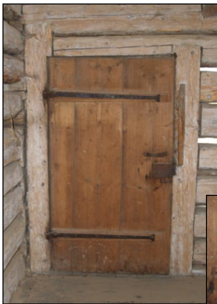
Obr. 13 – svlakové dveře v levé komoře
