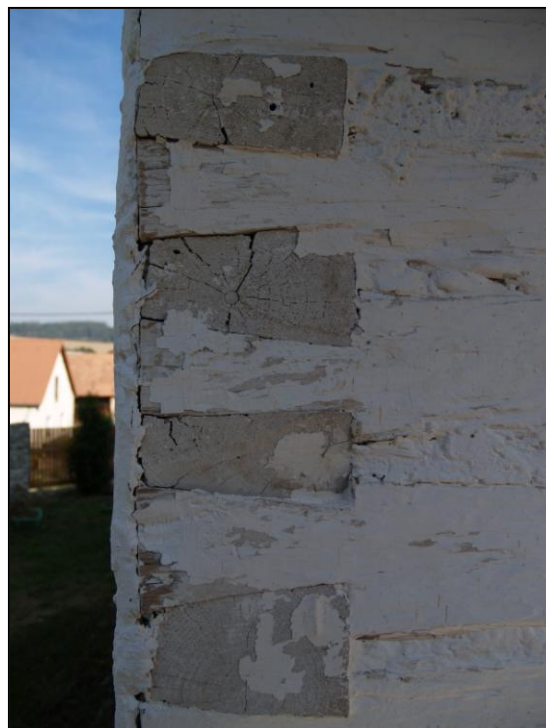
Obr. 4 – nezvykle tenká čela rybinových spojů na nároží vstupní a boční stěny
