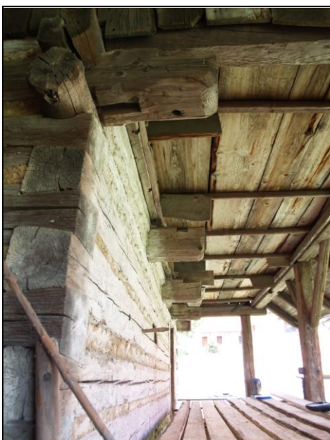
Obr. 6 – úzkový otvor vyznačený do dvou sousedních trámů, zajištěný nasekaným pásem železa
