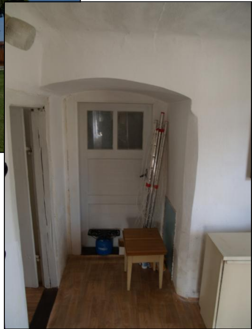
Obr. 6 – segmentově zaklenutá nika a okosený roh vedoucí ke komoře
