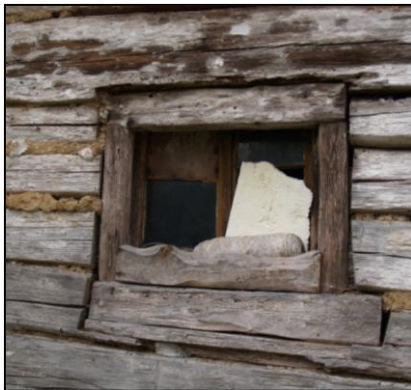
Obr. 2 – detail trámové zárubně okenního otvoru
