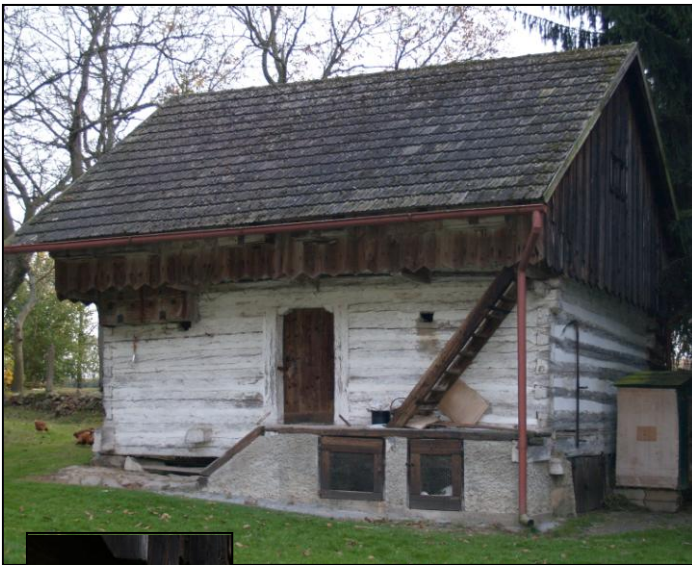
Obr. 3 – rybinové spoje, horní a dolní věnec nároží vstupní a pravé příčné stěny
