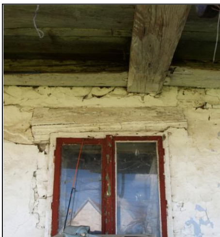
Obr. 10 – trámový okenní otvor s profilovanou překladovou římsou
