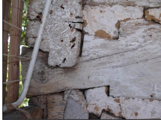
Obr. 5 - trámový portál s obloukovitě probraným průběžným překladová trémem, v levo dole je vchod pro kočku
