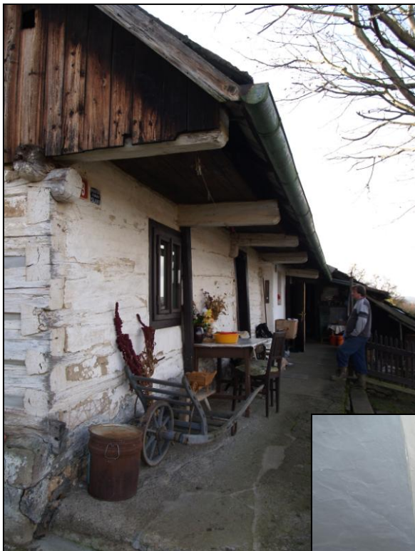
Obr. 5 – zápraží kryté přesahy stropních trámů
