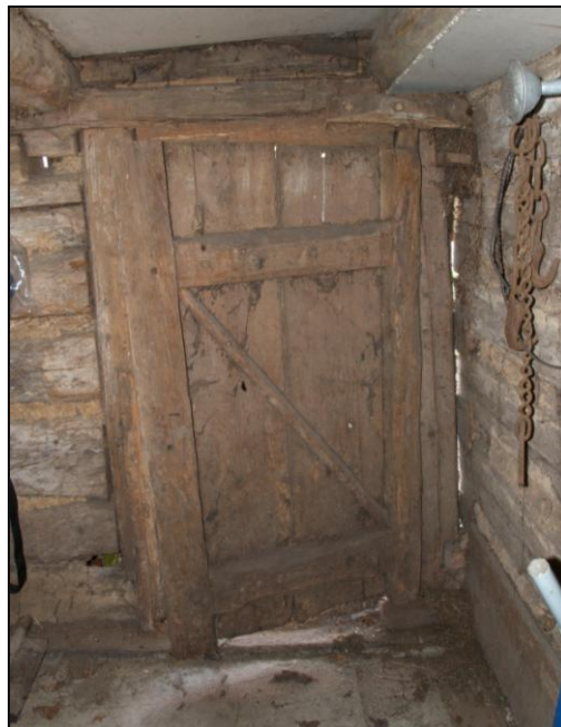
Obr. 14 - točnicové dveře trémové konstrukce se ztužovací diagonálou
