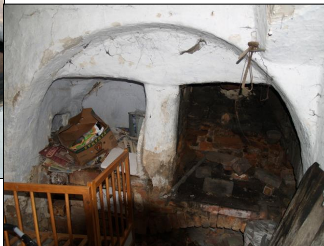
Obr. 13 – půlkruhově zaklenutá nika s přepážkou oddělující sporák (vlevo) a pec (vpravo)
