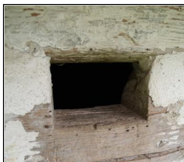
Obr. 7 – užitkový otvor vyříznutý do jednoho trámu
