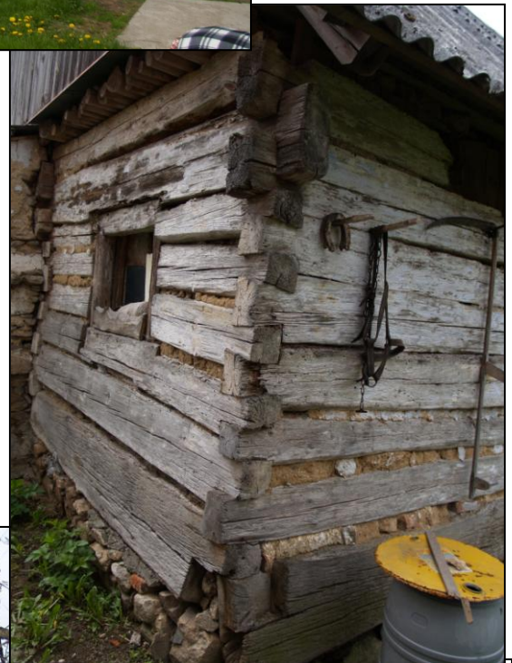
Obr. 3 – rybinové spoje a homí a dolní věnec nároží
