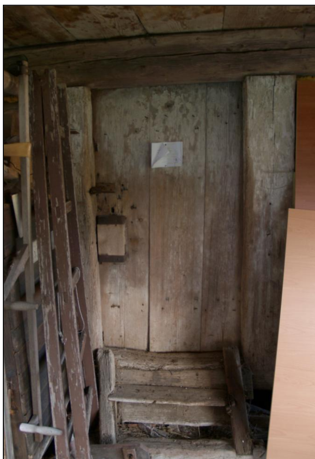
Obr. 4 – Trámový portál s průběžným překladovým trámem, na dveřích je umístěn dřevěný zámek (viz Exkurz II.)
