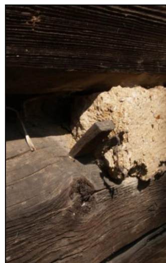
Obr. 6 – lepenice přichycená kolíčkem
