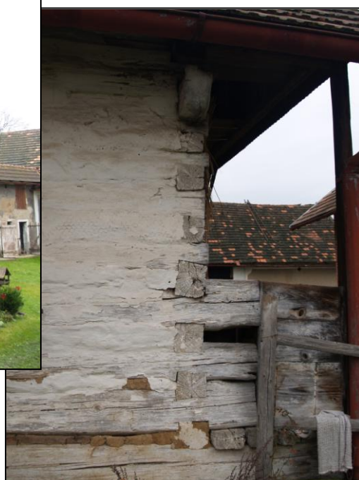
Obr. 3 – trámový portál s průběžným překladovým trámem a s oble probranými stojkami
