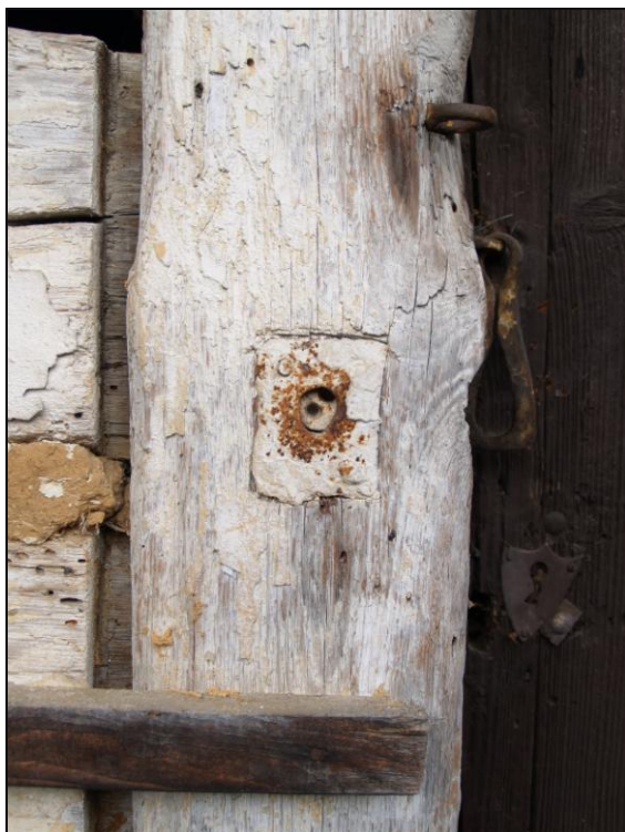
Petroupim čp. 21 - otvor s obdélným plechovým štítkem, ve kterém je šroub s hlavou se dvěma otvory.
