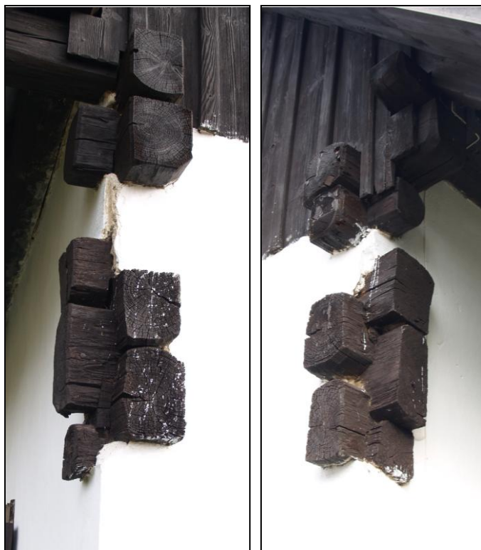
Obr. 2 a 3 – horní věnce nároží a nad nimi přesahy trámů roubené půdní nadezdívky
