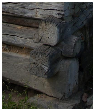
Obr. 5 – detail dolního věnce na nároží zadní a levé příčné stěny
