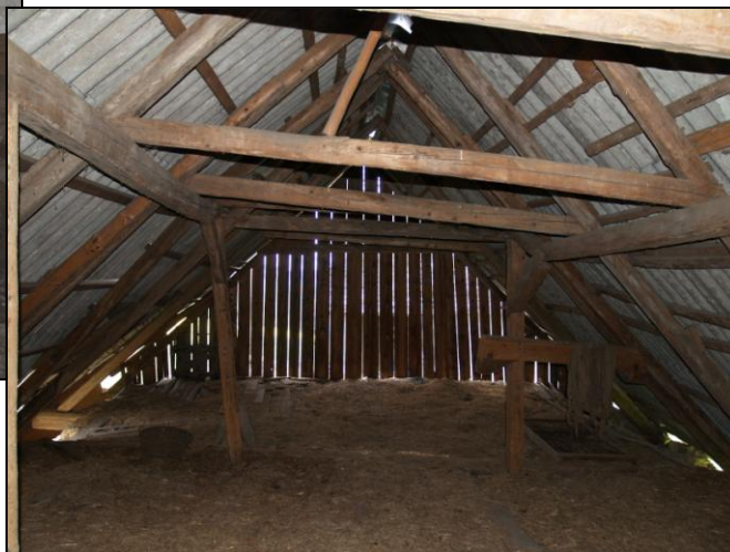
Obr. 17 - hambalkový krov nad hospodářskou částí
