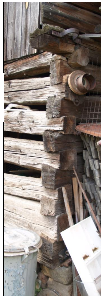
Obr. 4 – rybinové spoje a železná točnicová objímka na horním věnci nároží
