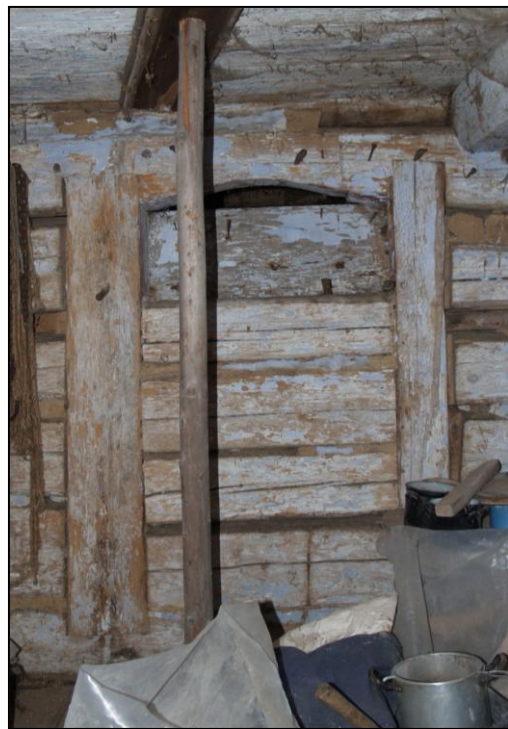
Obr. 7 – původní trámový portál s obloukově tvarovaným průběžným překladovým trámem
