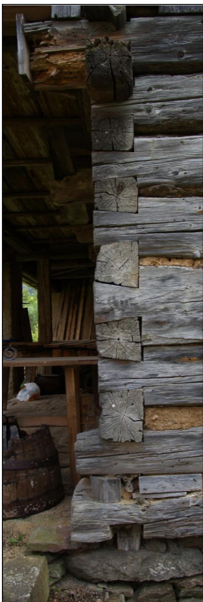
Obr. 8 – rybinové spoje a horní a dolní věnec nároží vstupní a boční stěny
