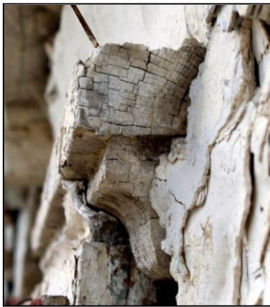
Obr. 10 – trámový okenní otvor s profilovanou překladovou římsou
