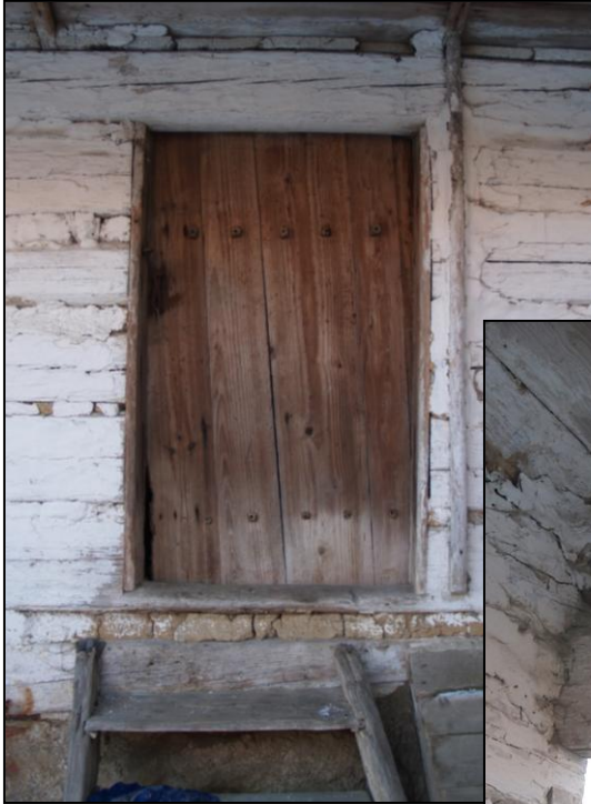
Obr. 5 – horní věnec nároží vstupní a pravé příčné stěny s šikmo podebranými trámy, z nichž vyšší patří nefunkční okapové vaznici
