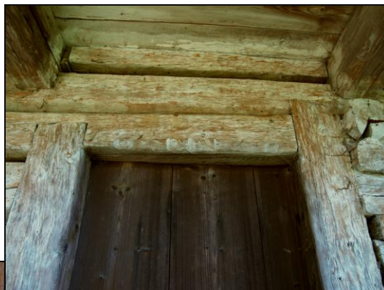
Obr. 14 – trámový portál s průběžným překladovým trámem zdobený záseky nad vstupním prostorem
