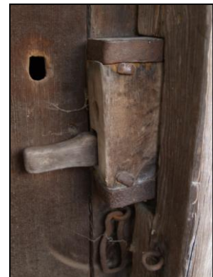
Obr. 10 – detail dřevěného zámku na dveřích pravé komory
