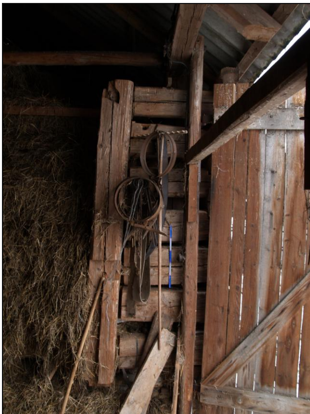
Obr. 6 – trámová stojka ohraničující odstraněný otvor v přepážce mezi pemou a mlatem
