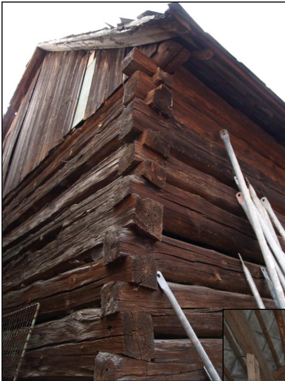
Obr. 3 – rybinové spoje s krátkými přesahy zhlaví a horní věnec na nároží zadní a pravé příčné stěny
