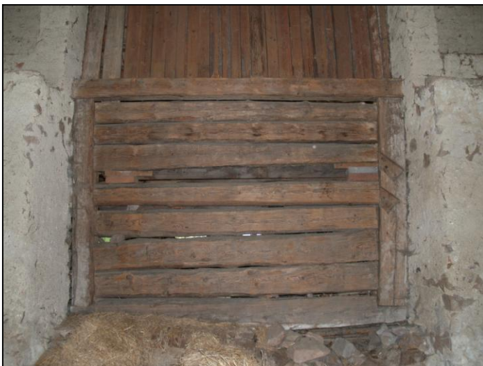
Obr. 3 – trámy vložené mezi pilíře do stojek na pero a drážku
