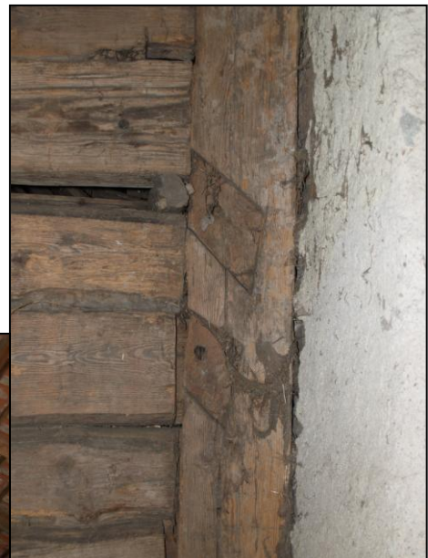
Obr. 4 – detail plátových rybinových dlabů z druhotně užitého dřeva na pravé stojce
