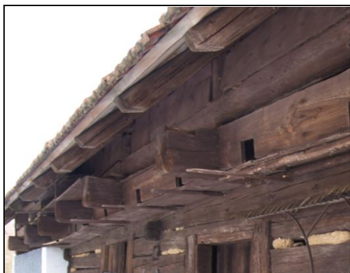
Obr. 6 – stropní trámy s dřevěnou nadezdívkou, která nahradila okapovou vaznici
