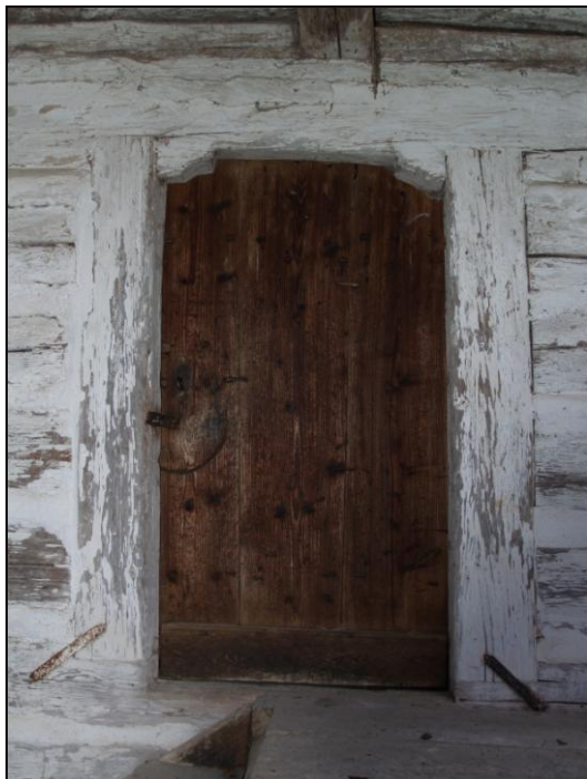
Obr. 5 – trémový portál se sedlově tvarovaným nadpražím
