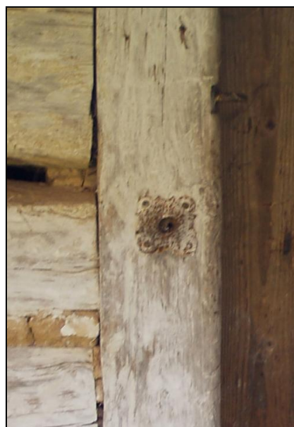
Choratice čp. 4 – čtvercový štítek zdobený zaoblenými rohy a prolámanými středy s kruhovým otvorem pro šroub
