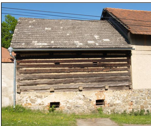
Obr. 4 – zápraží s přesahy stropních trámů, původní okapová vaznice je odstraněna
