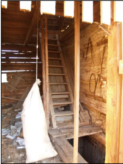
Obr. 6 – Žebříkové schodiště do podkroví, před ním vchod do sklepa
