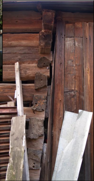
Obr. 2 – rybinové spoje na nároží podélné stěny a příčky mezi mlatem a pernou
