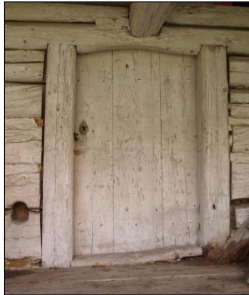
Obr. 5 - trámový portál s obloukovitě probraným průběžným překladová trémem, v levo dole je vchod pro kočku
