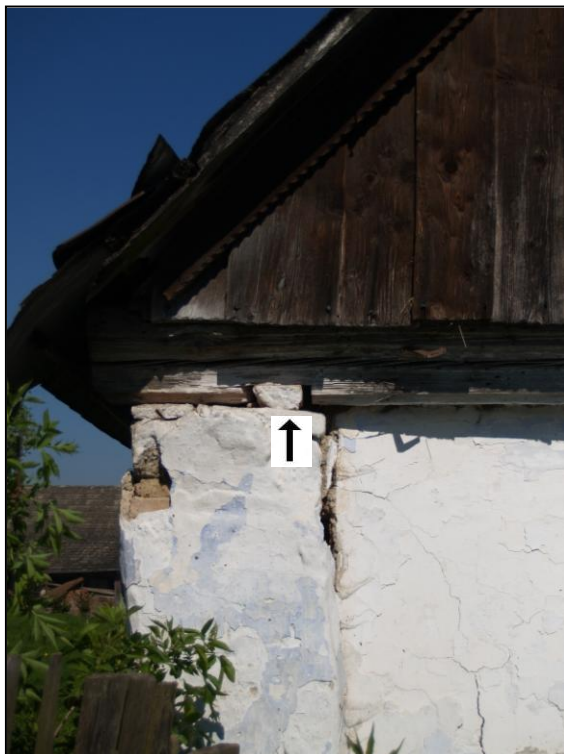
Obr. 6 – profilace ukončovací římsy
