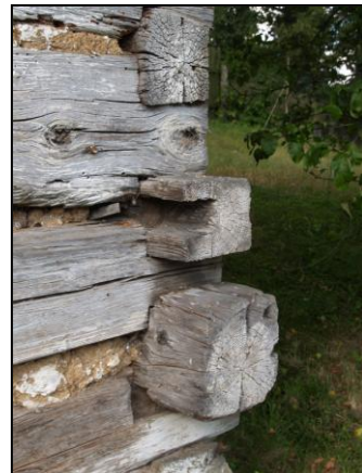
Obr. 6 – detail dolního věnce nároží boční a zadní stěny s druhotně použitými trámy
