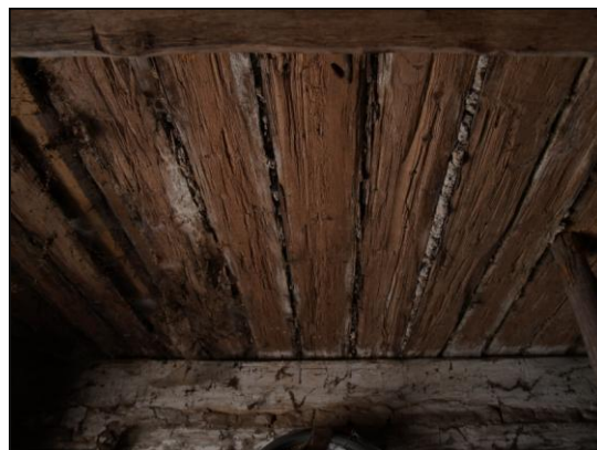
Obr. 7 – trémový strop se záklopy z půlených povalů
