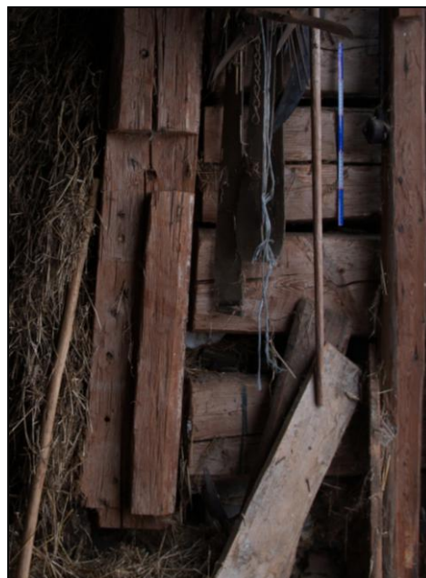
Obr. 7 – detail dlabu, ve kterém byly kolíky připevněny trámy či fošny oddělující pemou od mlatu
