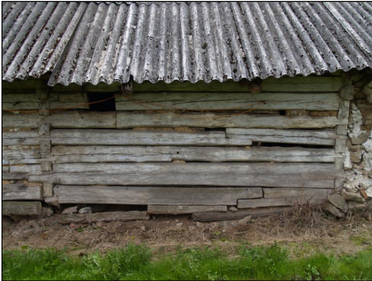
Obr. 7 – zadní stěna komory s řadou přeplátovaných trámů
