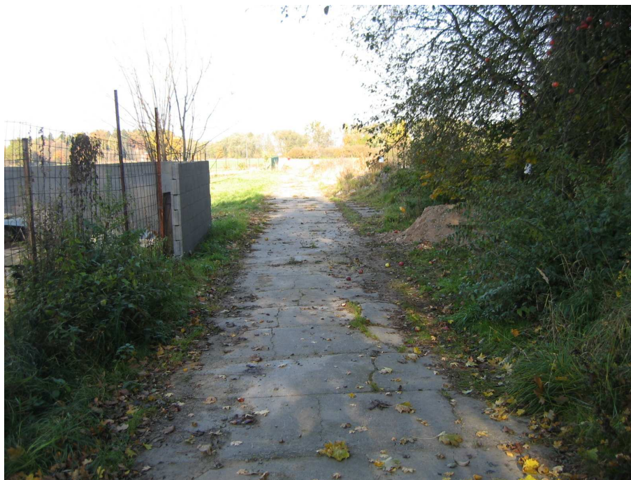
Pohled v úseku A na severovýchod
