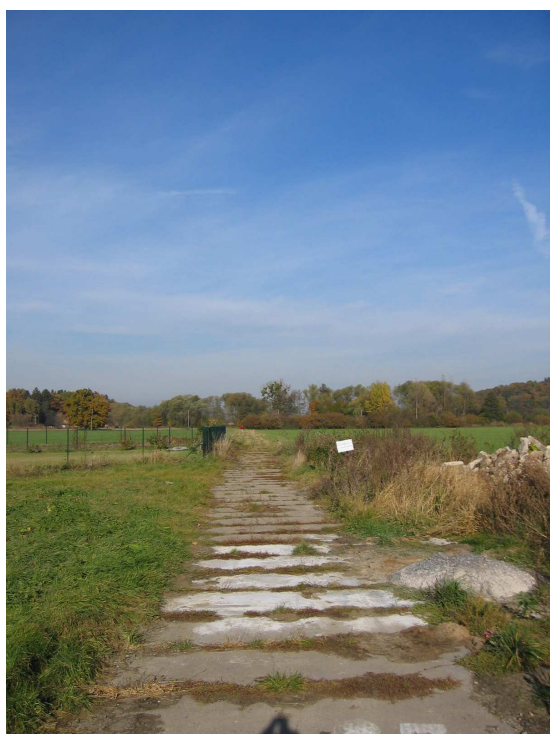
„Úsek A“ staničení 0.10 km – 0.20 km
