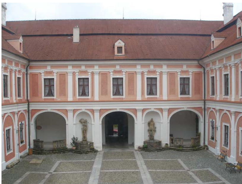
Příloha III. nádvoří zámku Červený Hrádek (foto M. Strouhalová)
