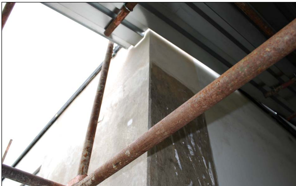
Foto č. 34: Horní terasa, jihovýchodní nároží pokoje Grety, aplikace uhličitanu amonného.
