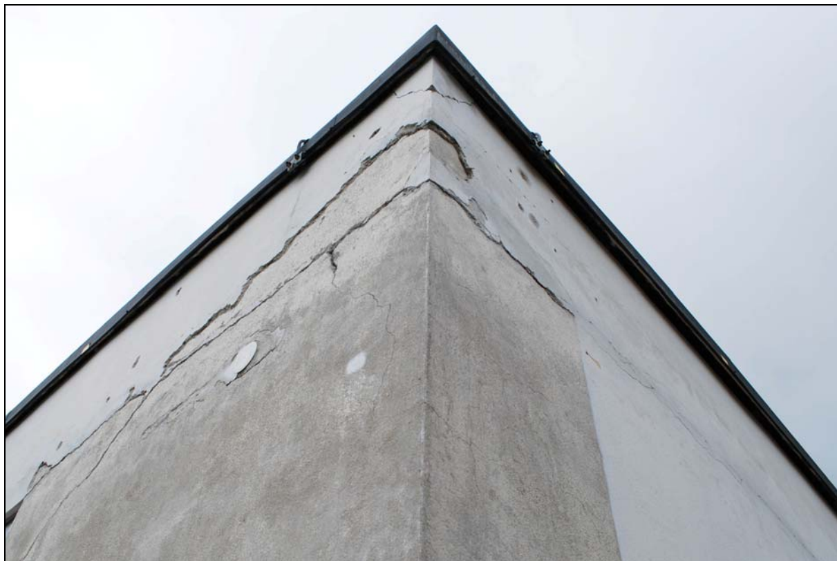
Foto č. 28: Horní terasa, jihovýchodní nároží pokoje Grety, stav po odkryvu mladších nátěrů.
