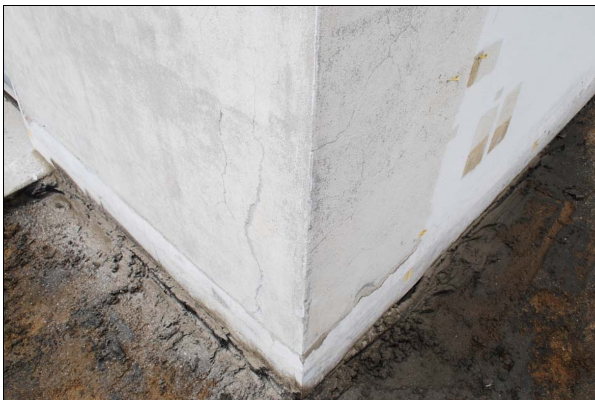
Foto č. 28: Horní terasa, jihovýchodní nároží pokoje Grety, stav po odkryvu mladších nátěrů.
