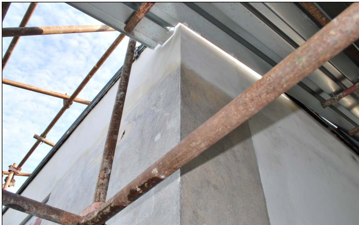
Foto č. 37: Horní terasa, jihovýchodní nároží pokoje Grety, před nátěrem. Doplňky natřeny první vrstvou nátěru pro snížení rozdílu v nasákavosti mezi nasákavými doplňky a velmi málo nasákavými originálními omítkami.
