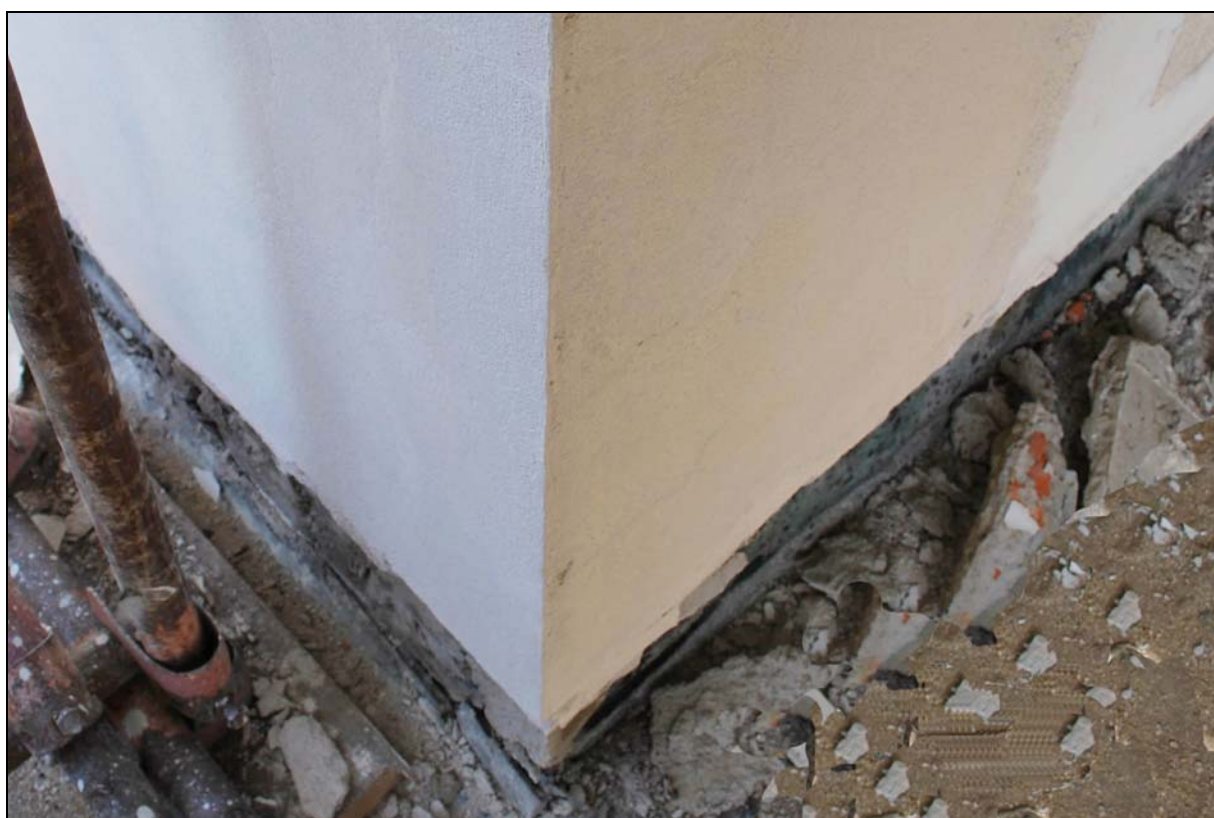
Foto č. 38: Horní terasa, jihovýchodní nároží pokoje Grety, po nátěru. Jižní nároží po celoplošném nátěru vápennou lazurovou probarvenou jemným podílem z bratčického písku a s přídavkem lněného oleje.
