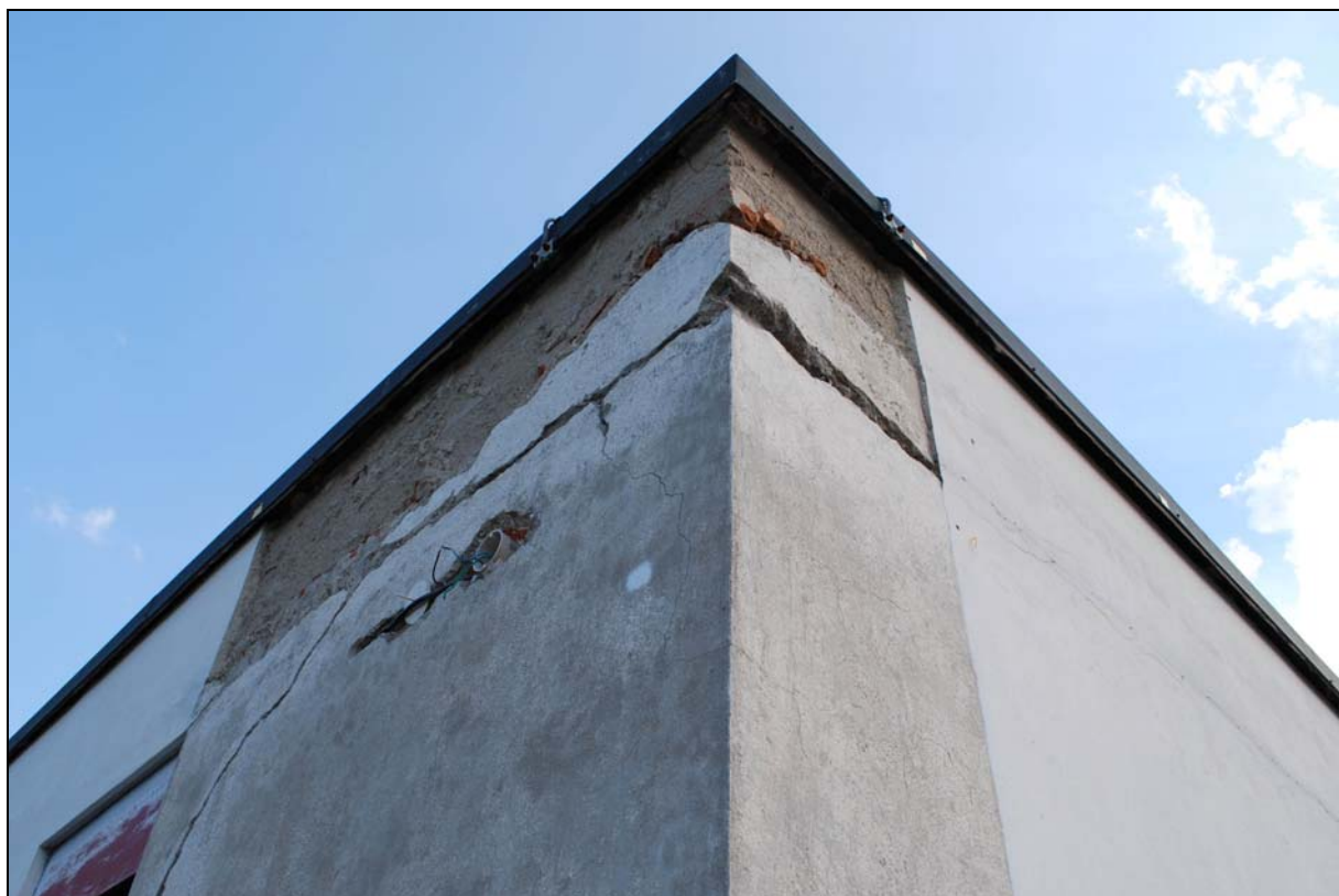
Foto č. 30: Horní terasa, jihovýchodní nároží pokoje Grety, situace po odstranění mladších nevhodných doplňků.
