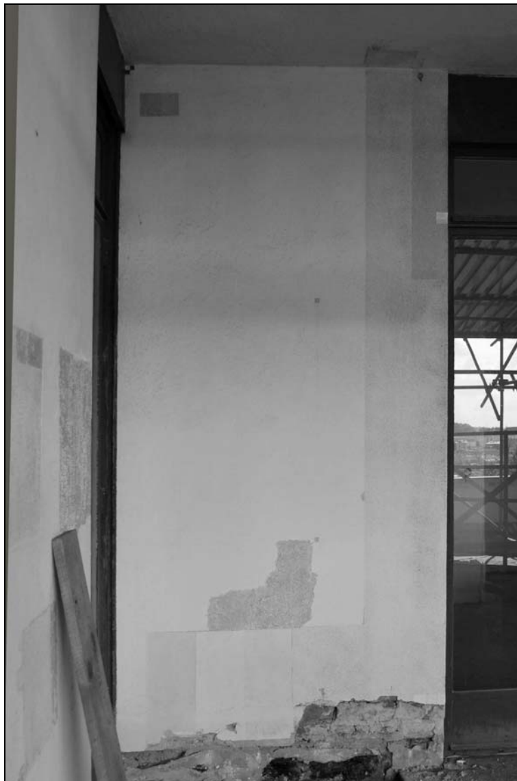
Plocha A. Na ní byl proveden exemplární odryv původního povrchu pod vedením prof. Ivo Hammera a zkoušky nátěrů vápennou lazurou pod vedením prof. Thomase Danzla.
