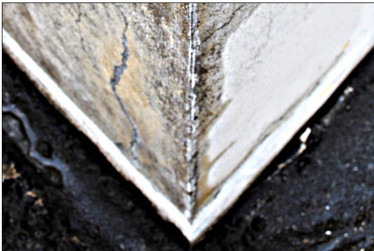
Foto č. 29: Horní terasa, jihovýchodní nároží pokoje Grety, situace za deště. Deštěm je nejvíce namáhána jihozápadní fasáda. Východní je zavlhčena pouze několik centimetrů od nároží. Na horní fotografii je patrné přemítání původních dislokovaných omítek.
