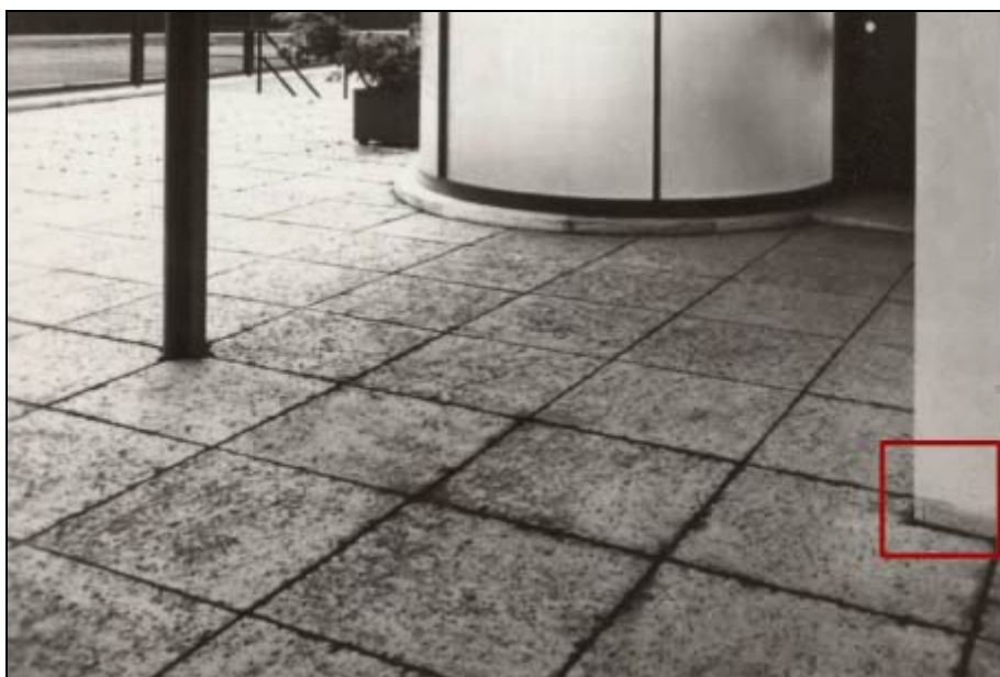
Na historické fotografii z 30. let jsou patrné původní sokly.
