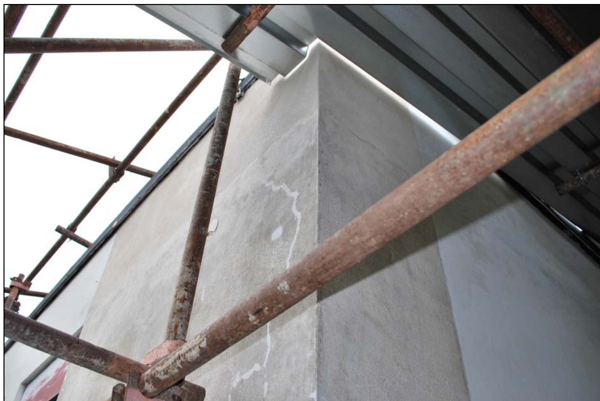
Foto č. 36: Horní terasa, jihovýchodní nároží pokoje Grety, situace během tmelení.
