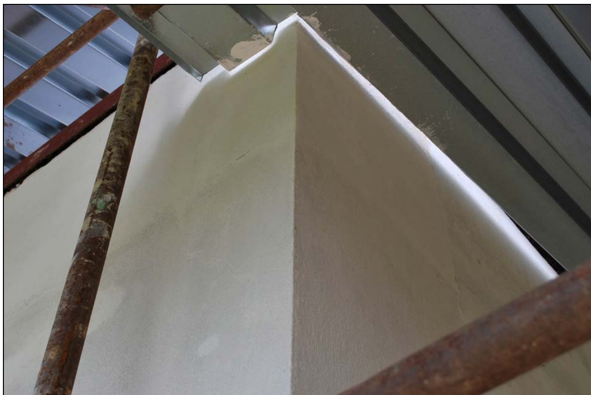
Foto č. 38: Horní terasa, jihovýchodní nároží pokoje Grety, po nátěru. Jižní nároží po celoplošném nátěru vápennou lazurovou probarvenou jemným podílem z bratčického písku a s přídavkem lněného oleje.
