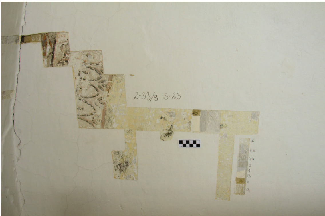
Obr. 6: Detail sondy pocházející z průzkumu v roce 2003. Stav před restaurováním. Odkryv byl proveden z velké části na vrstvu nástěnné malby, vpravo dole viditelná stratigrafie podkladových a omítkových vrstev.
