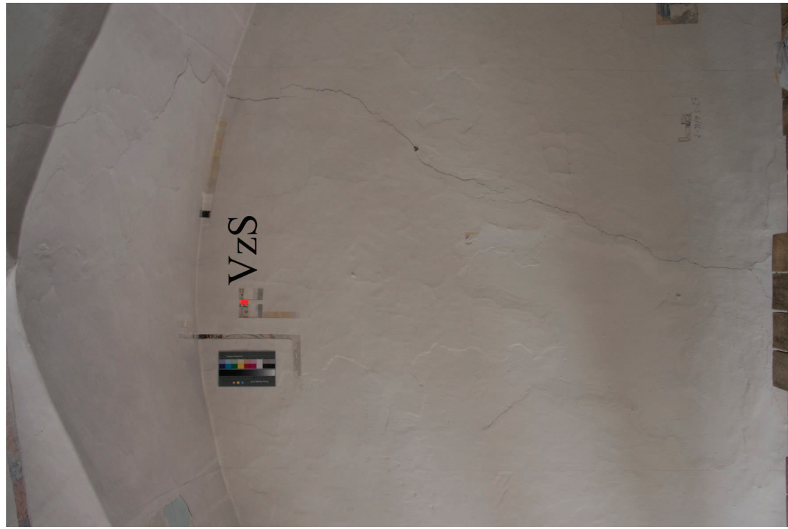
Obr. 24: Vyznačení místa odběru vzorku vrchních překryvných nátěrů - Michaela Navrátilová. Foto: M. Navrátilová, upravila D. Urbanová.
