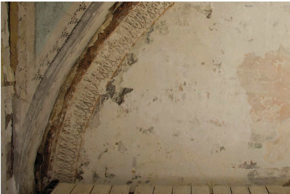
Obr. 10: Totéž místo, stav po odkryvu. Hranice dochování malby se shoduje s rozhraním viditelným již před odkryvem.
