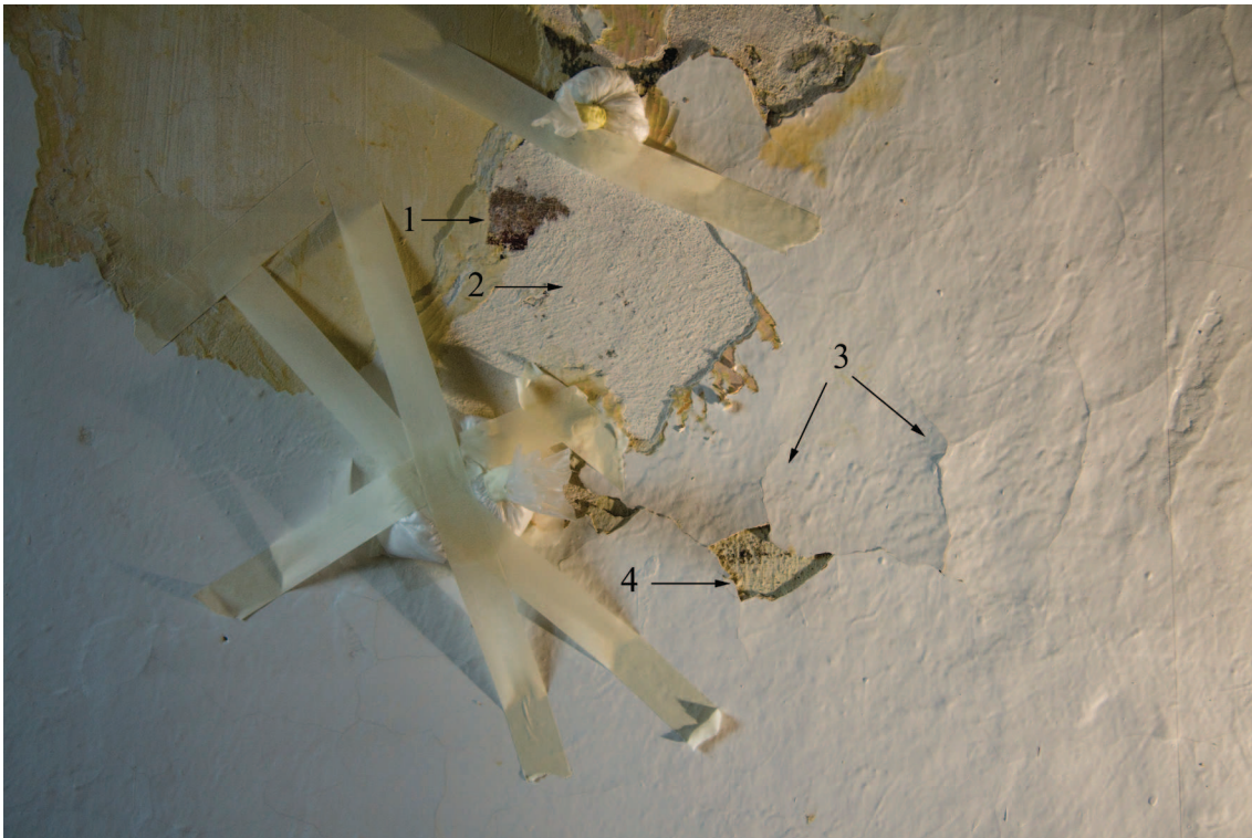
Obr. 30: Detail upevňování odchlípnutých krakel překryvných nátěrových vrstev s barevnou vrstvou malby. Foto v bočním světle. Pod zvednuté okraje krakel byl injektován Primal SF016 1:1, místo bylo přelepeno japonským papírem a přitlačeno k podkladu pomocí vatových polštářků.
