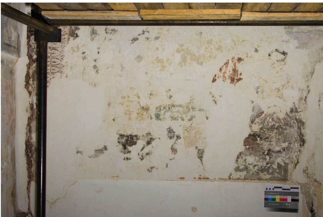
Obr. 52: Stav po restaurování, celkový pohled na díl vymezený ke komplexnímu restaurátorskému zásahu. Foto v rozptýleném světle.
