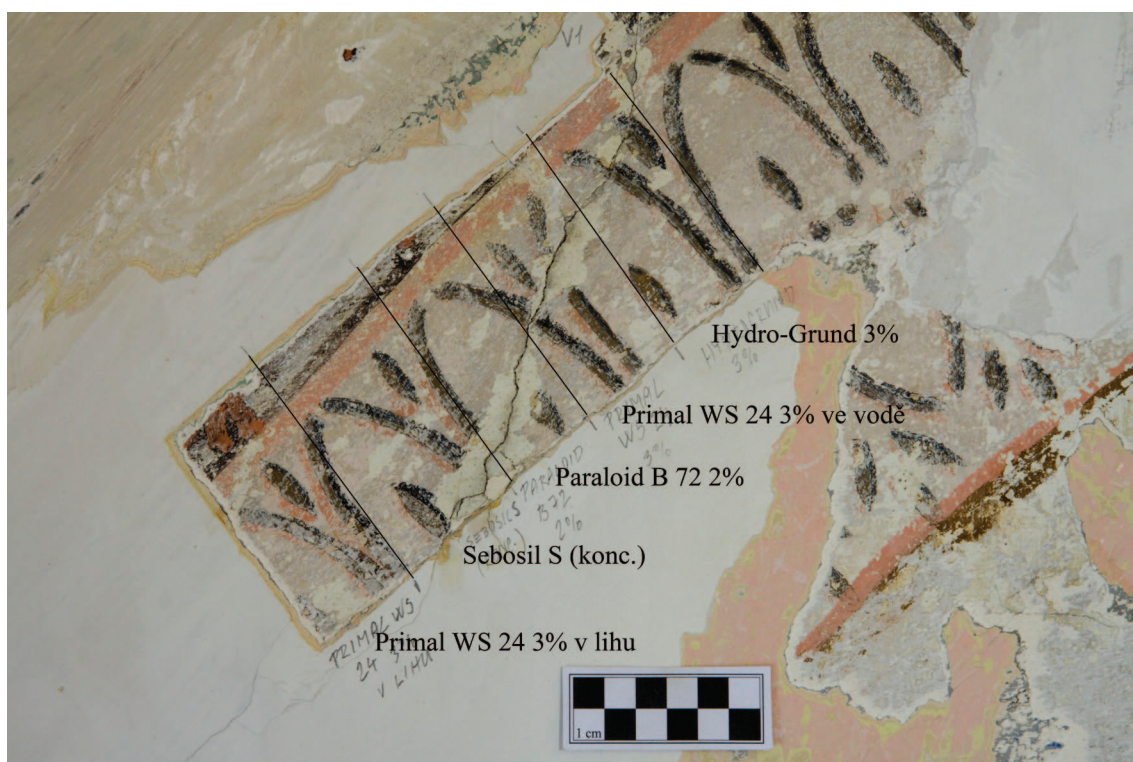
Obr. 28: Detail zkoušek zpevňování barevné vrstvy během odkryvu, dekor v horní části východní stěny. Konsolidanty byly aplikovány pouze na problematické části, kde barevná vrstva při odkryvu opadávala (zde na fotografii podél praskliny). Ostatní místa byla odkrývána bez zpevňování.
