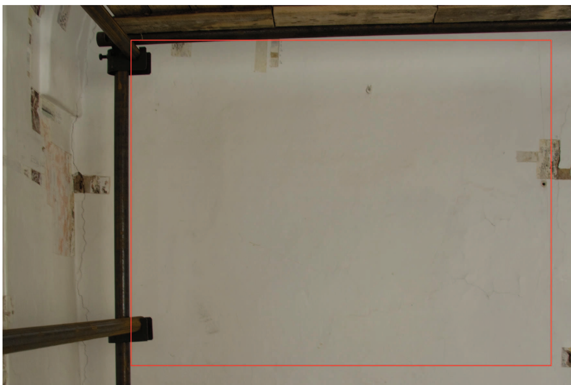
Obr. 14: Vyznačení místa, které je znázorněno na termogramu.
