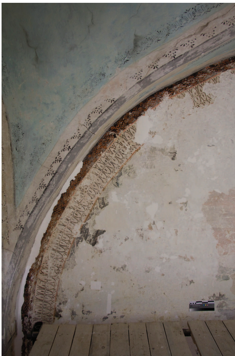
Obr. 50: Horní část vymezeného dílu, stav po tmelení. Foto v rozptýleném světle.
