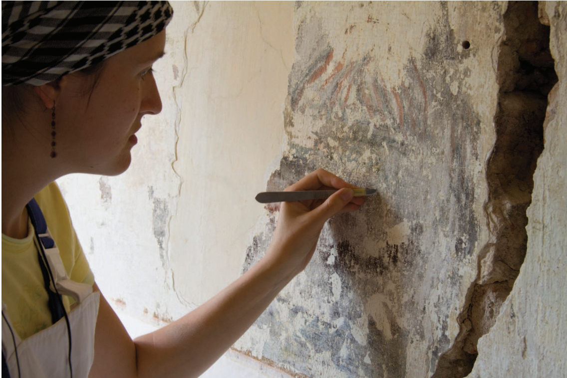
Obr. 42: Dočišťování míst, kde byl při odkryvu aplikován Primal SF016 ředěný 1:1 s vodou.
