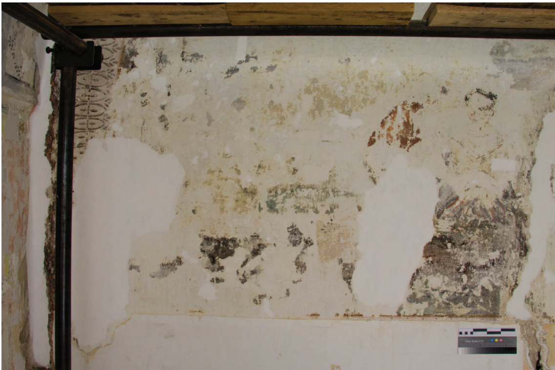
Obr. 49: Spodní část vymezeného dílu, stav po tmelení. Foto v rozptýleném světle.
