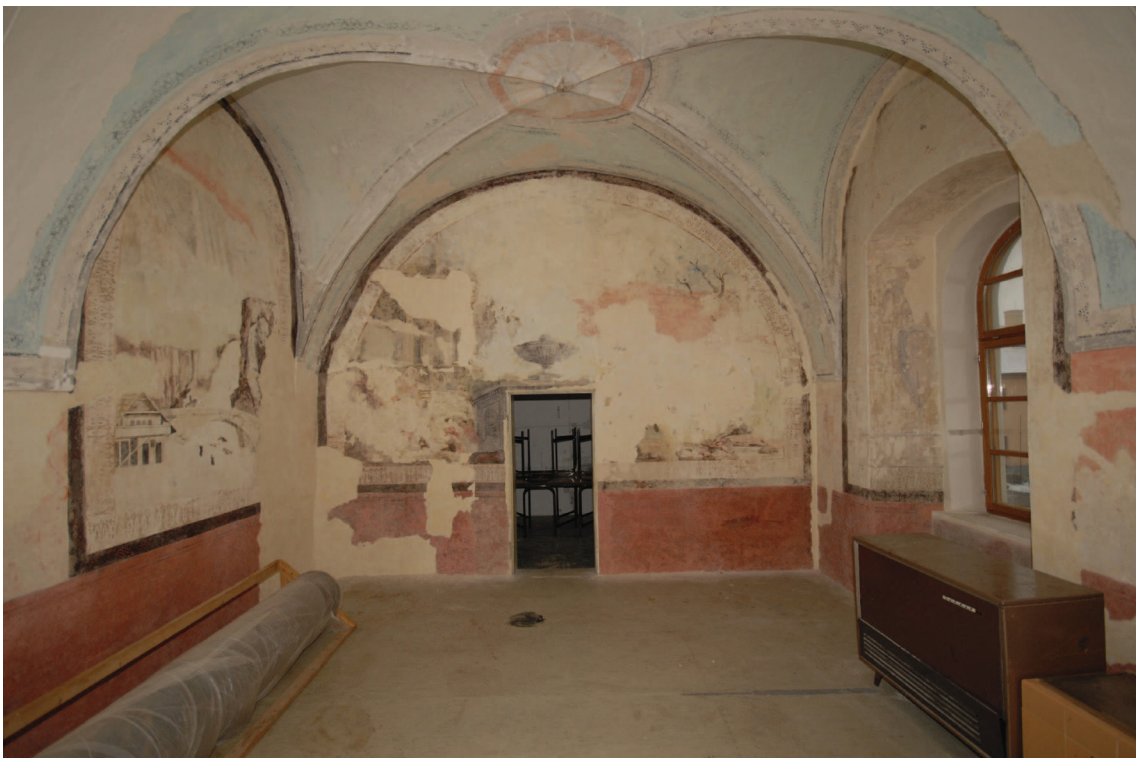
Obr. 2: Západní stěna, část severní a jižní stěny a část klenby v místnosti 2.04. Uprostřed západní stěny se nachází dveřní otvor do sousední místnosti. Na stěnách lze vidět nástěnné malby, které byly zrestaurovány v letech 2004 - 2006 studenty IRKT Litomyšl (od roku 2005 Fakulta restaurování Univerzity Pardubice). Foto z: MACEK, Petr, BERÁNEK, Jan, CHOTĚBORSKÁ, Lucie. Bývalý piaristický klášter při kostele Nalezení sv. Kříže, stavebněhistorický průzkum . Praha, 2008.
