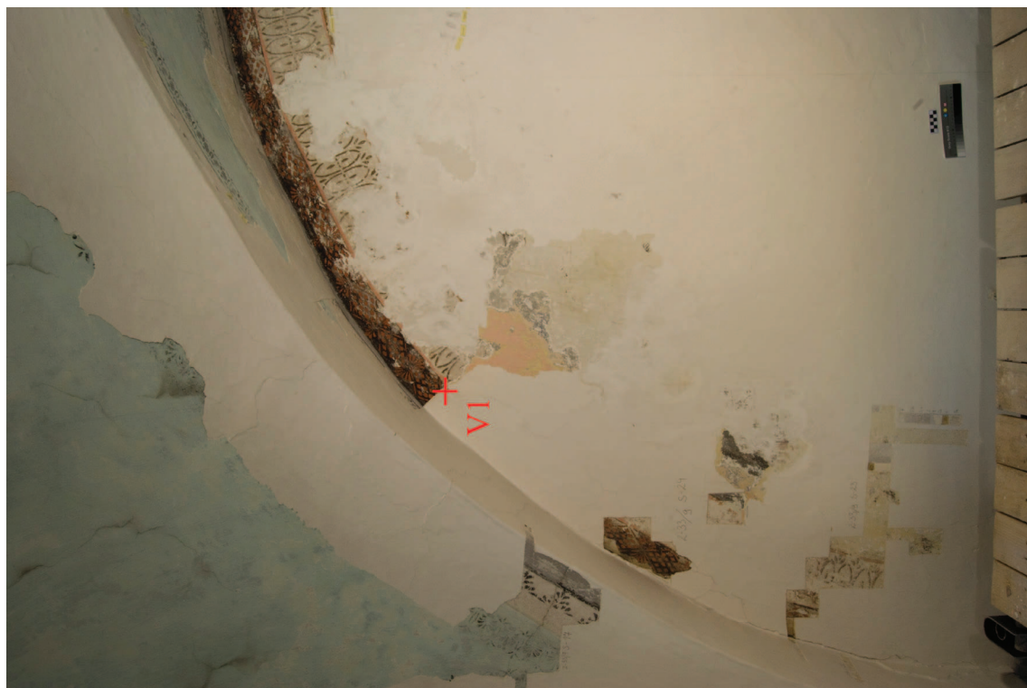
Obr. 20: Význačení místa odběru vzorku vrchních překryvných nátěrů na východní stěně.
