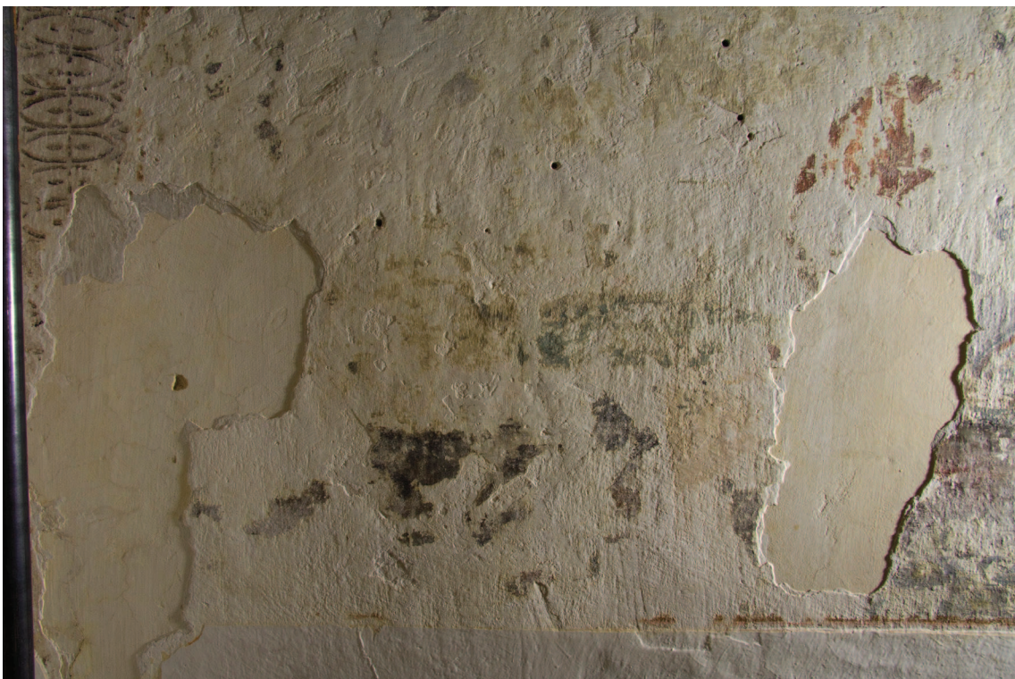
Obr. 41: Stav po odkryvu, foto v ostrém bočním světle, detail.
