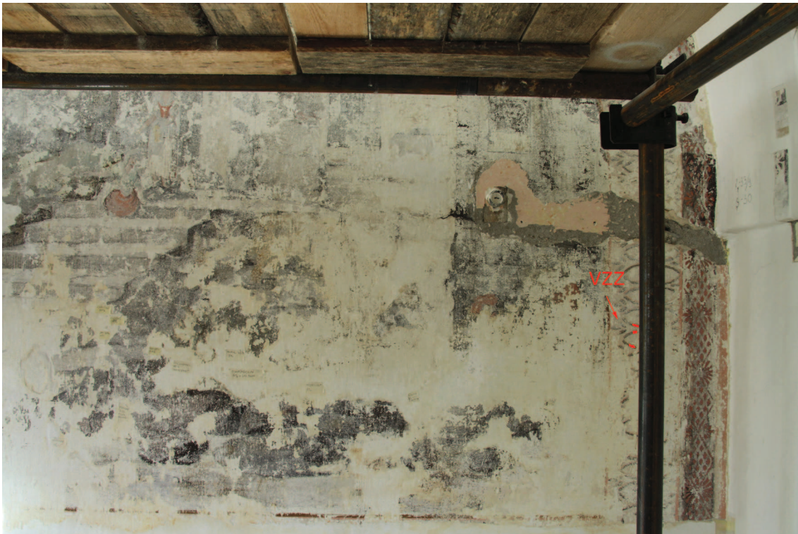
Obr. 22: Vyznačení místa odběru vzorku barevné vrstvy na východní stěně - Markéta Kalíková. Foto: M. Kalíková, upravila: D. Urbanová
