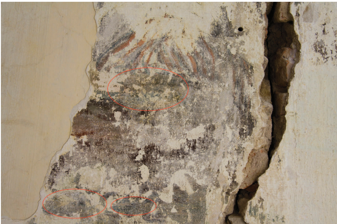
Obr. 43: Vyznačení problematických míst, kde byl aplikován Primal SF016 1:1 s vodou. Stav po odkryvu, před odstraňováním disperze rozpouštědly.
