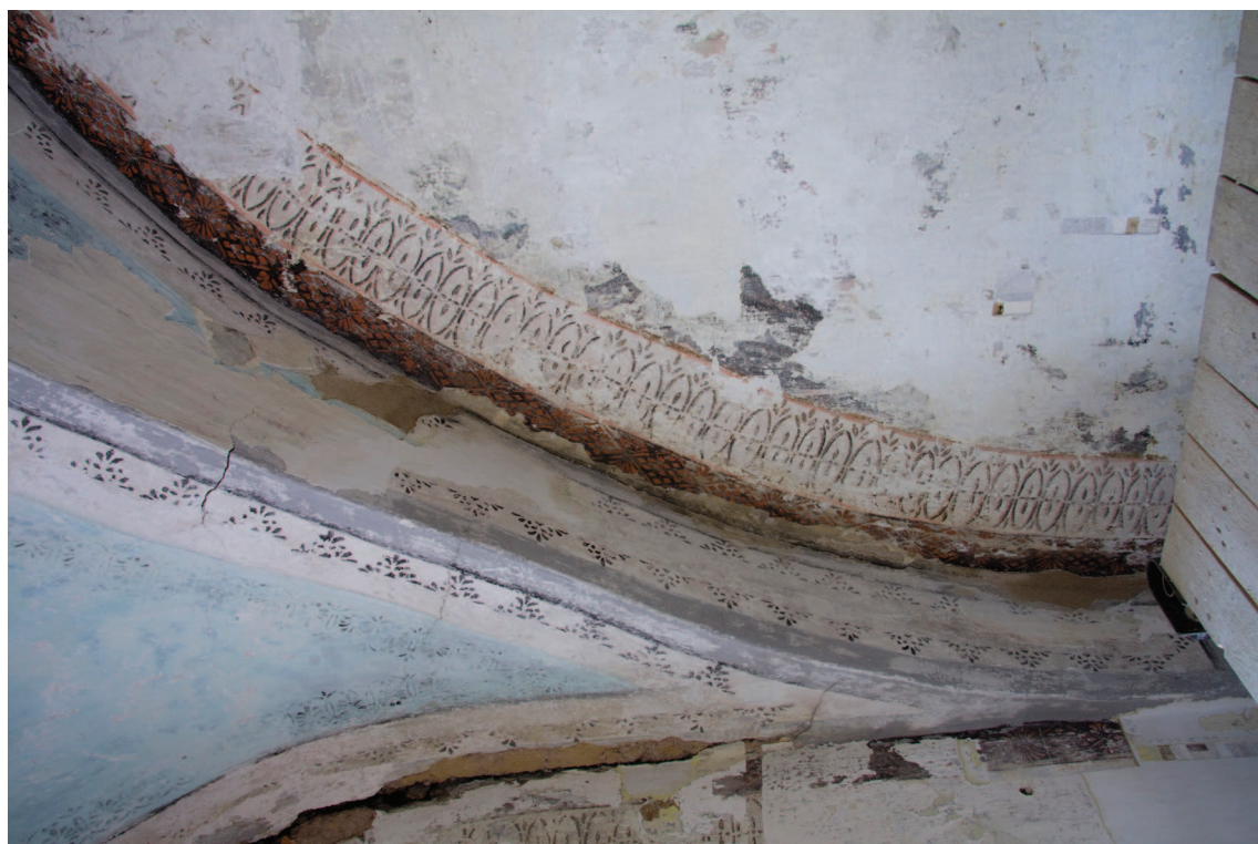
Obr. 46: Prasklina v levém rohu mezi východní stěnou a náběhem klenby, po nanesení vrstvy hrubého a vrstvy jemnějšího tmelu.
