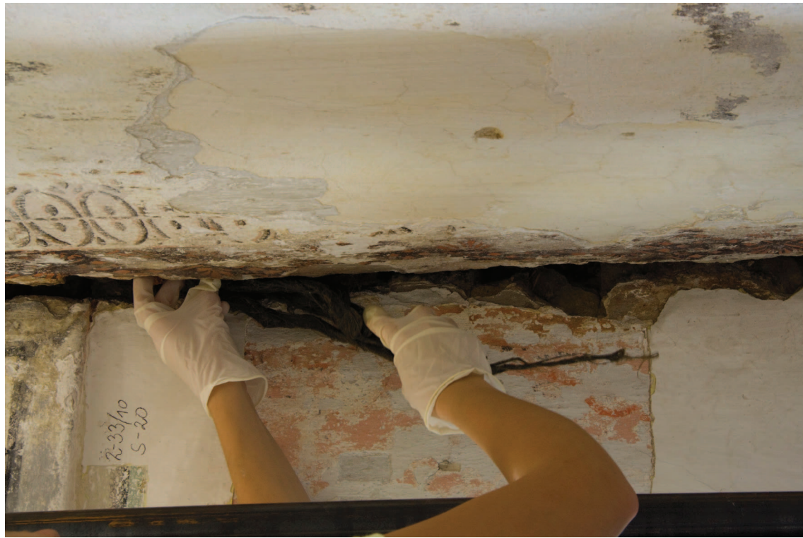
Obr. 44: Vytváření podkladu pro tmel v prasklině v levém rohu východní stěny. V hloubce cca 10 cm byla vytvořena zarážka z úlomků cihel a lněné koudele na kterou byl následně vrstven vápenný tmel. V hloubce praskliny tak byl ponechán prostor pro pozdější možné zásahy v případě statických problémů.
