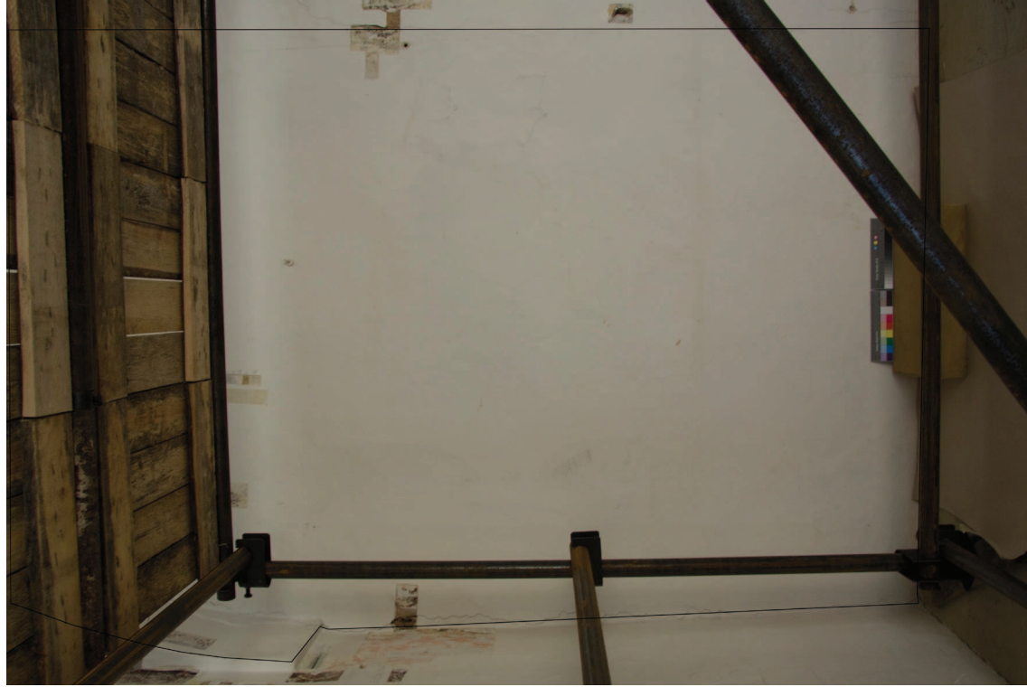
Obr. 3: Spodní část dílu vymezeného původním zadáním k samostatnému restaurování, zvýrazněno černou linkou. Z tohoto zadání byla v průběhu prací odebrána partie soklu a spodního dekorativního pásu, který sahá do výšky 109 cm od podlahy. Stav před restaurováním, foto v rozptýleném světle.
