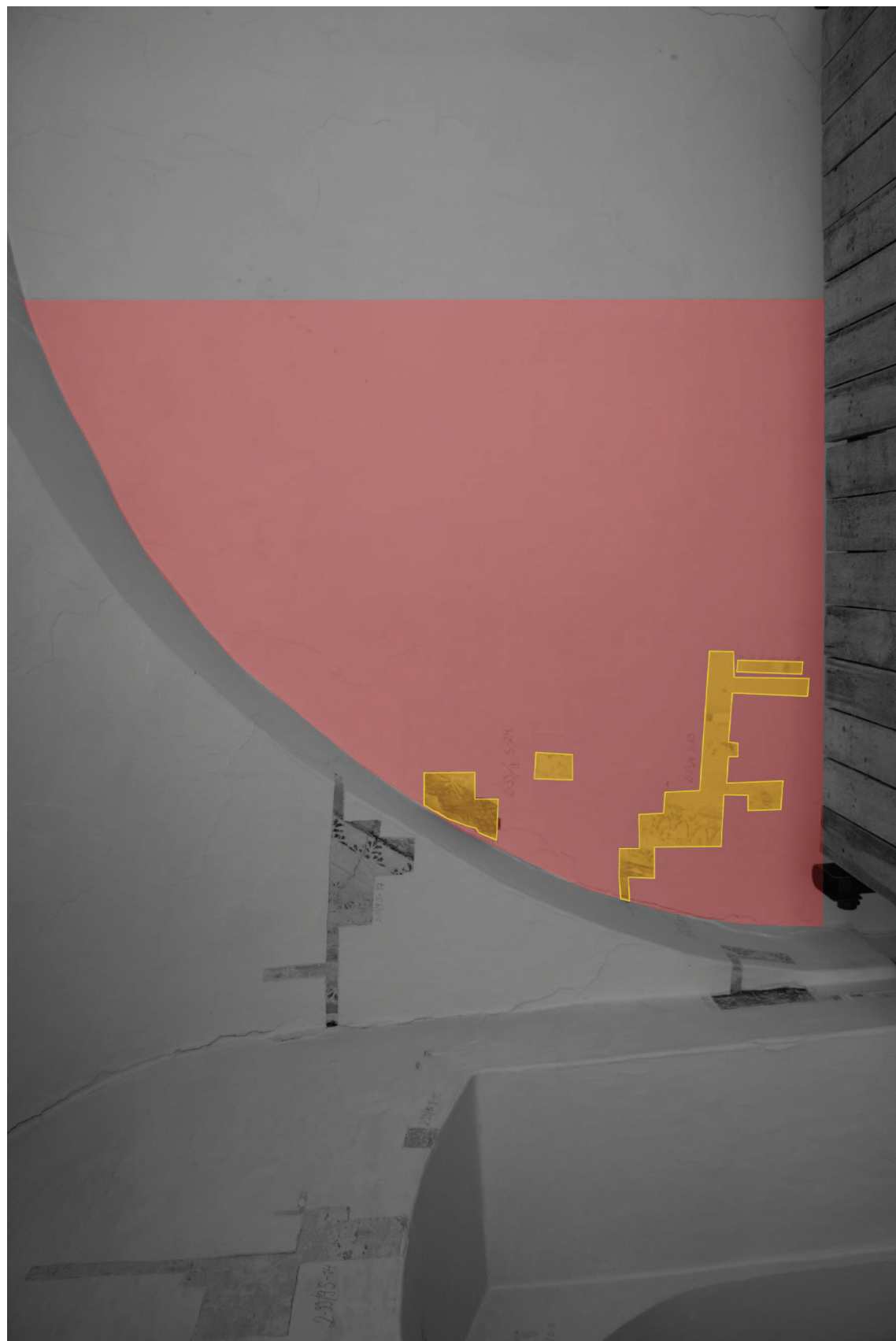
Graf. 4. Vyznačení sond pocházejících z průzkumu provedeného v roce 2003 studenty Institutu restaurování a konzervačních technik v Litomyšli pod vedením Josefa Čobana, ak. mal.
