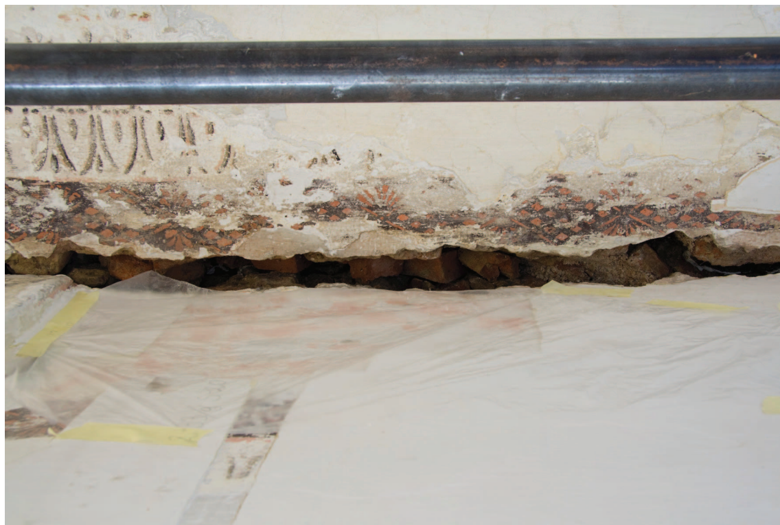
Obr. 45: Detail praskliny po vytvoření podkladu pro tmel z vrstvy lněné koudele a cihel.
