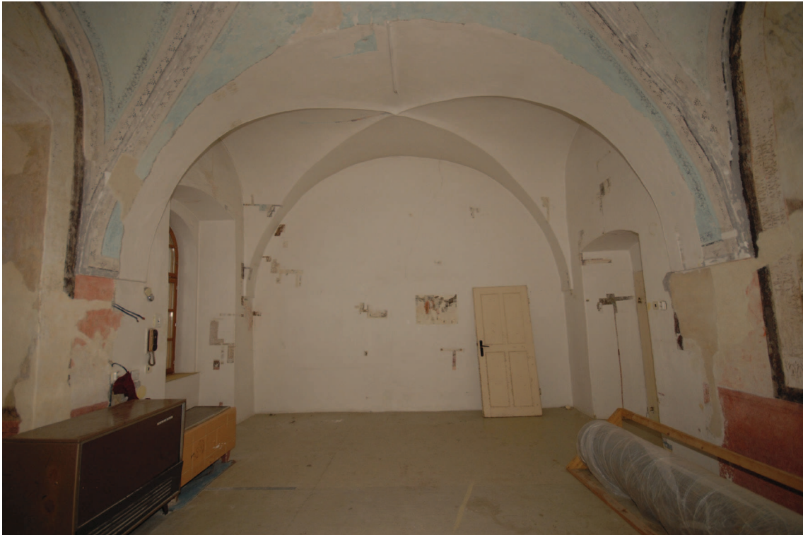
Obr. 1: Východní stěna, část severní a jižní stěny a část klenby v místnosti 2.04. Stav před restaurováním. Vpravo se nacházejí vstupní dveře do místnosti. Na snímku jsou patrné sondy pocházející z průřezu, který byl proveden studenty IRKT Litomyšl pod vedením Josefa Čobana, ak. mal. v roce 2003. Foto z: MACEK, Petr, BERÁNEK, Jan, CHOTĚBORSKÁ, Lucie. Bývalý piaristický klášter při kostele Nalezení sv. Kříže, stavebněhistorický průzkum . Praha, 2008.
