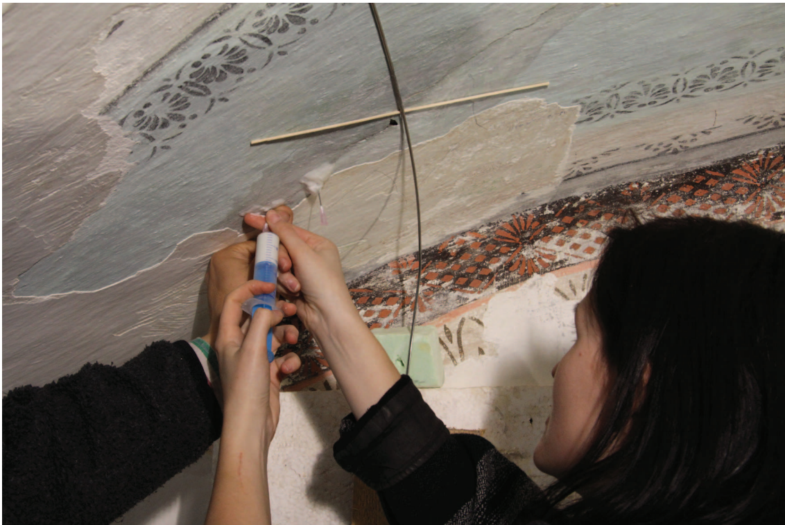
Obr. 32: Injektování dutiny v klenbě Ledanem D2 během workshopu Hlubková konsolidace nástěnných maleb, který proběhl na Fakultě restaurování Univerzity Pardubice. Před injektáží byly odpouklé vrstvy zabezpečeny proti odpadnutí a povrch byl zafixován dočasným konsolidantem - cyklododekan 70% v technickém benzínu.
