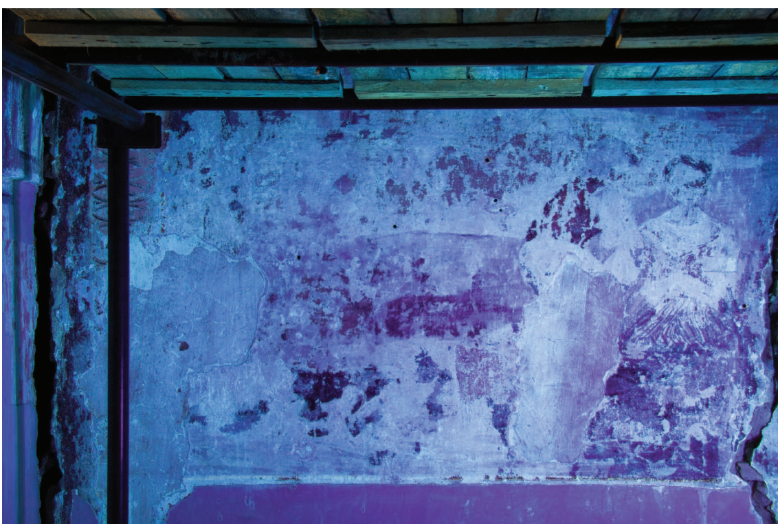
Obr. 37: Spodní část vymezeného dílu v levé části východní stěny. Stav po odkryvu a odstranění nevhodných vysrávek a tmelů, celkový pohled, foto v UV světle.
