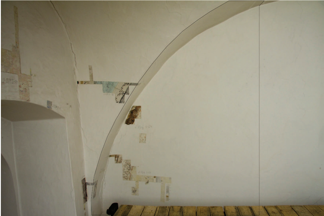
Obr. 5: Horní část úseku vymezeného k samostatnému restaurování, zvýrazněno černou linkou. Stav před restaurováním, foto v roptýleném světle. Sondy pochází z průzkumu provedeného zde v roce 2003.
