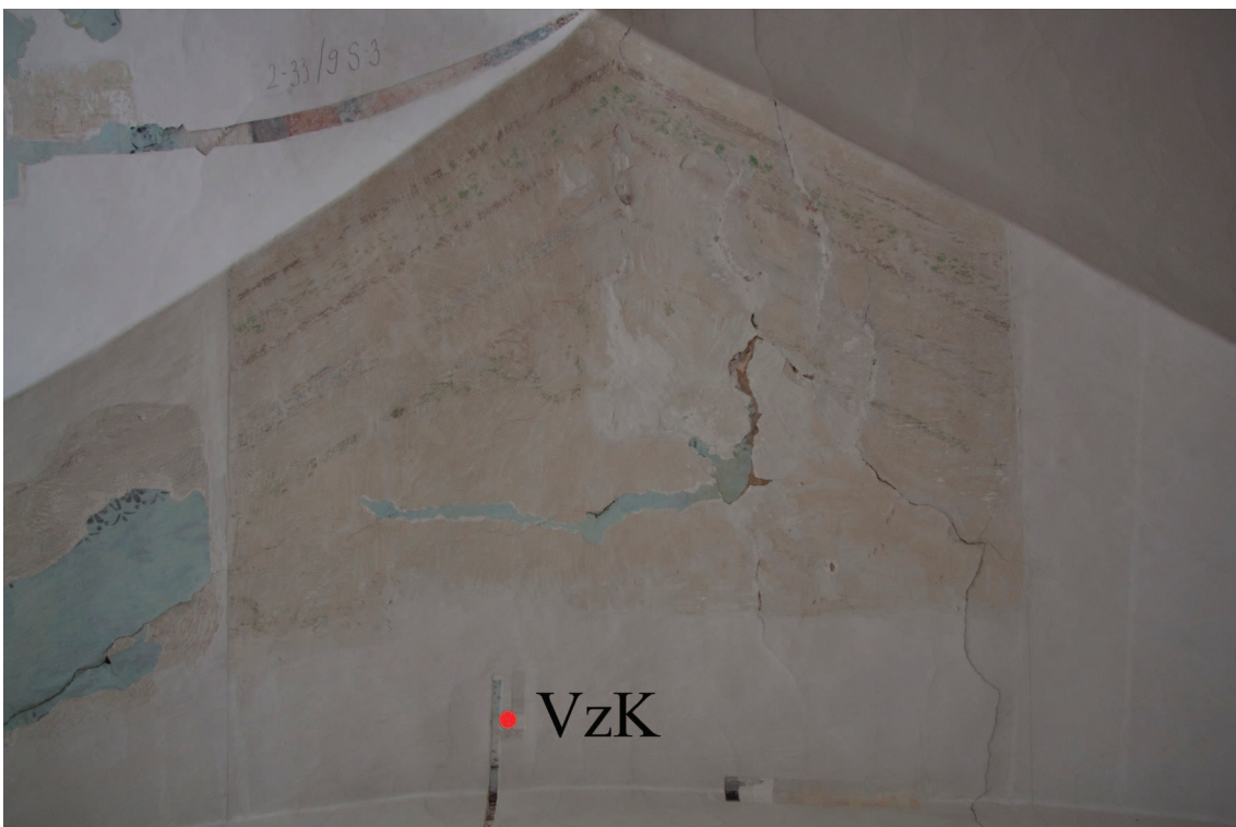
Obr. 23: Vyznačení místa odběru vzorku vrchních překryvných nátěrů na klenbě - Michaela Navrátilová. Foto: M. Navrátilová.
