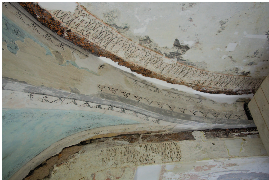
Obr. 47: Prasklina v levém rohu mezi východní stěnou a náběhem klenby, stav po vytmelení.
