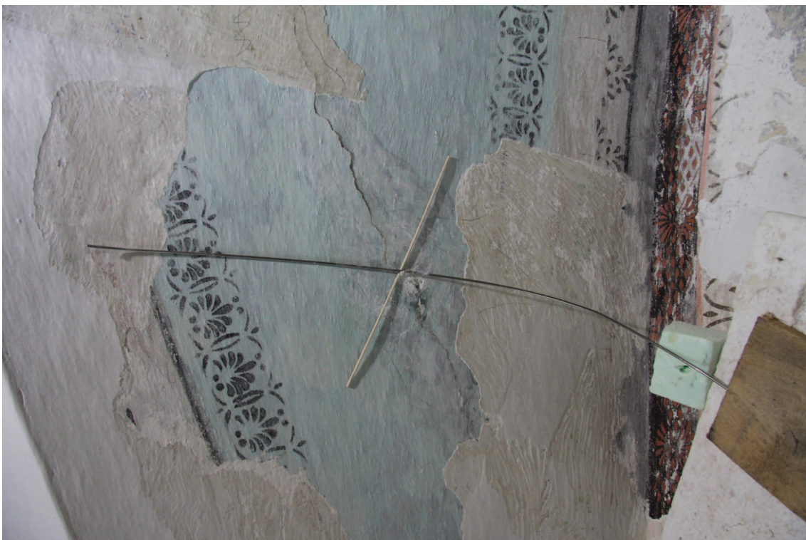
Obr. 33: Detail stejného místa po injektáži.
