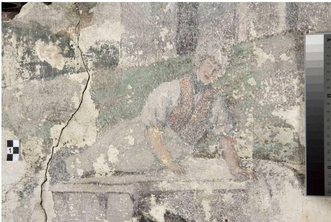
Obr. 36. Detail figury mladého muže (délka figury 39 cm), stav po odkryvu a odstranění mladších nevhodných vysprávek. Malba byla silně zpráškovatělá a na většině míst uvolněná. Konsolidována byla akrylátovou disperzí Primal WS24 . V omítkové vrstvě se vyskytují praskliny a uvolnění především v okolí statické trhliny, které byly zpevňovány Ledanem D2 s plavenou křídou.
