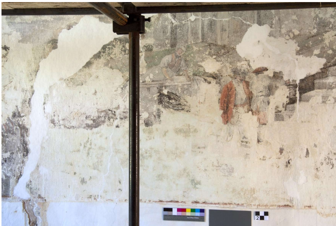
Obr. 40. Spodní část mého úseku na stěně (jeho vrchní polovina). Stav po vytmelení defektů závěrečným vápenno-písčítým tmelem a opatření tmelů vápenným nátěrem z vápna a mramorové moučky. Pro bakalářskou práci bylo rozhodnuto prezentovat tuto spodní částí odkryté malby na stěně (v této části upravit povrch tmelů vápenným nátěrem a provést retuše).
