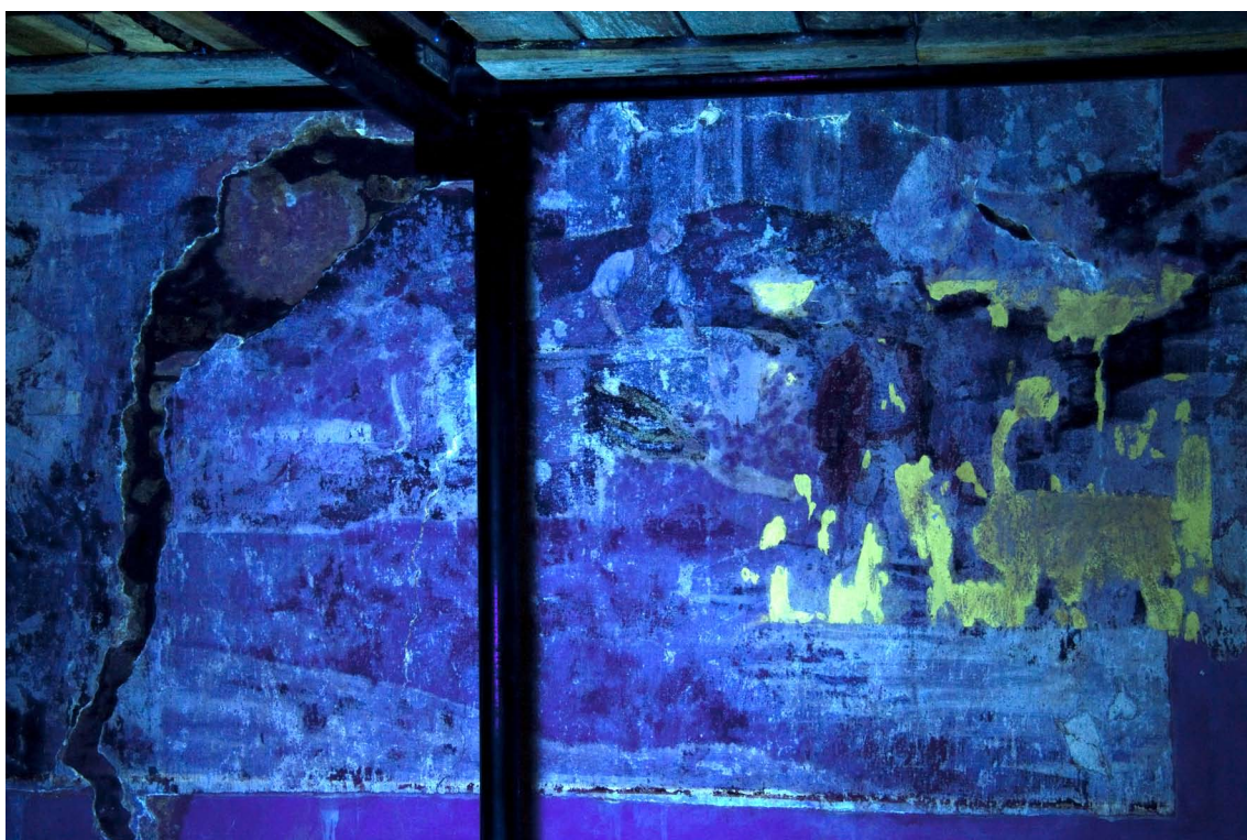
Obr. 35. Vrchní část mého úseku na stěně (jeho spodní polovina). Foto v UV světle po odkryvu, v průběhu hrubého tmelení statické trhliny. Dobře čitelná jsou kompoziční rozvržení jednotlivých prostorových plánů (architektury, figur a krajiny). Výrazně žlutě luminoval povrch tmelů, resp. jejich povrchová úprava (2% Primal SF016 ) na úseku z předchozí etapy restaurování.
