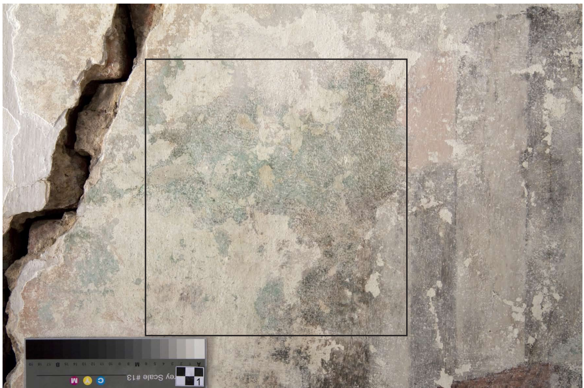
Obr. 28. Stav po přichycení souvrství a odkryvu. Na některých místech konsolidant pronikl také na povrch malby a mezi rozvolněné překrývající nátěry, čímž celé souvrství prosytil a zpevnil. Tato skutečnost ztížila odkryv a zpevněné druhotné nátěry nebylo možné odstranit beze zbytku. Pozůstatky silně přichycených překrývajících nátěrů zůstaly na povrchu malby (ve vyznačené partii zeleno-hnědého stromovi).
