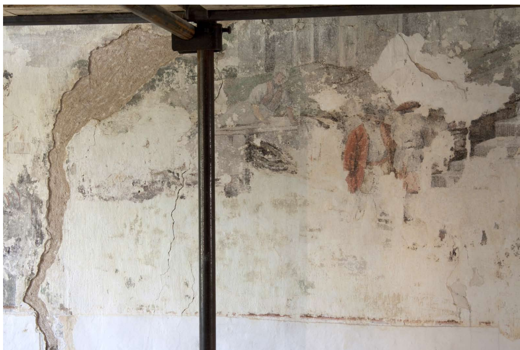
Obr. 39. Spodní část mého úseku na stěně (jeho vrchní polovina). Stav po vytmelení defektů hrubým vápenno-písčitým tmelem.
