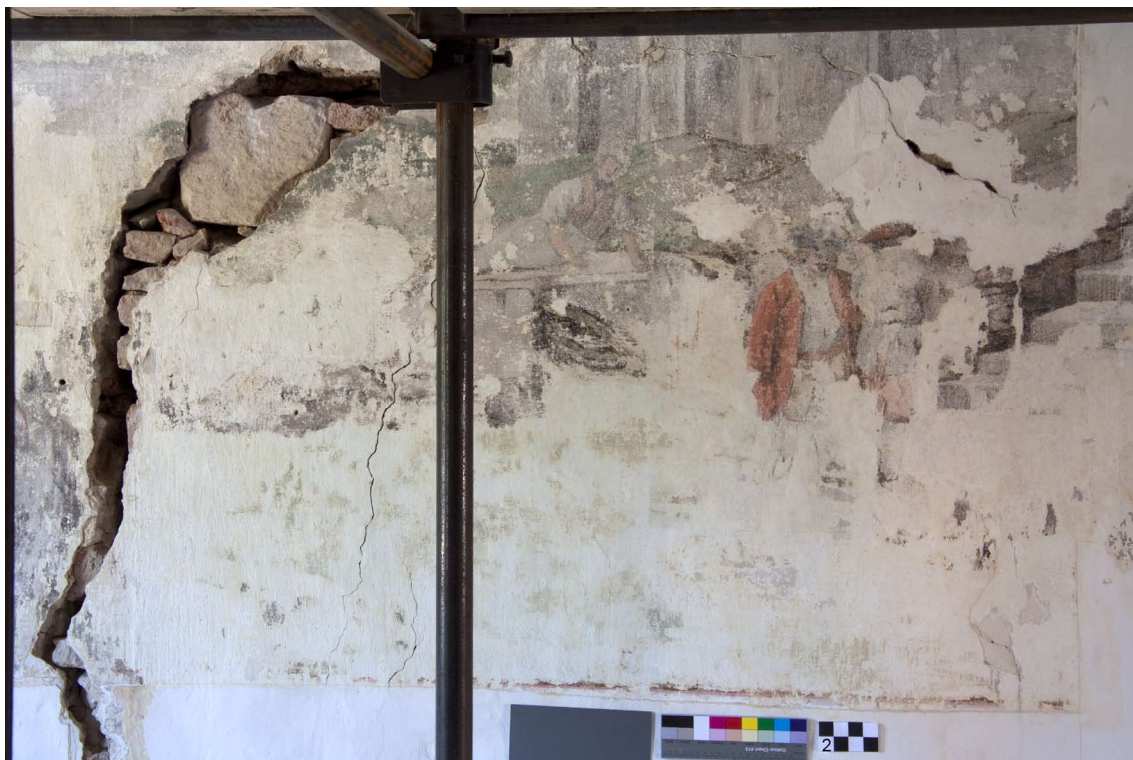
Obr. 34. Spodní část mého úseku na stěně (jeho vrchní polovina), stav po odkryvu a odstranění mladších nevhodných vysrávek. Soudržné vysrávky provedené na úseku z předchozí etapy restaurování byly ponechány. Malba je fragmentárně dochovaná. V mém úseku se v malovaném výjevu nachází tři figury zasazené do krajinného prostředí s architekturou.
