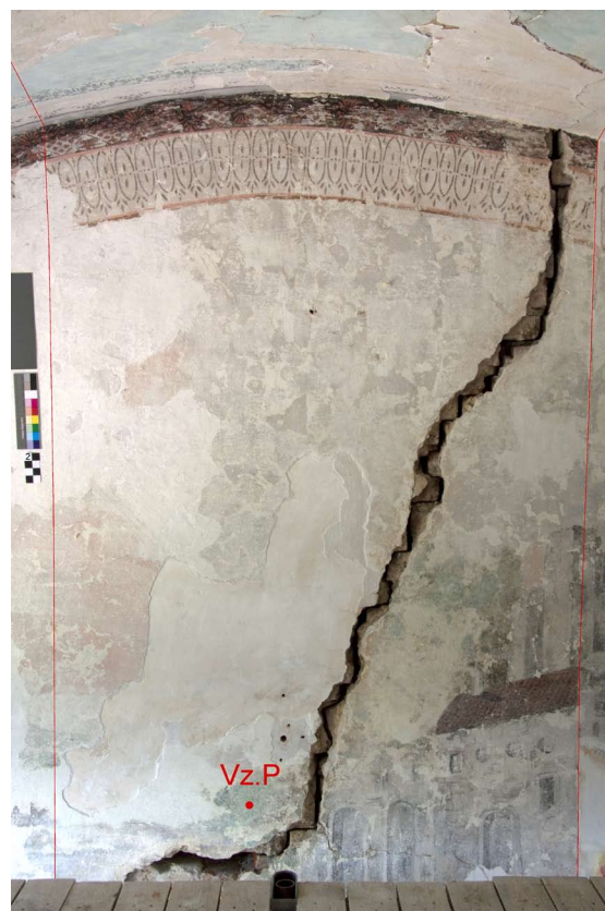
Obr. 50. Místo odběru práškového vzorku Vz.P pro analýzu pojiv malby. Vzorek byl odebrán před plošnou fixáží v místě, kde nebyla malba během odkryvu konsolidována.
