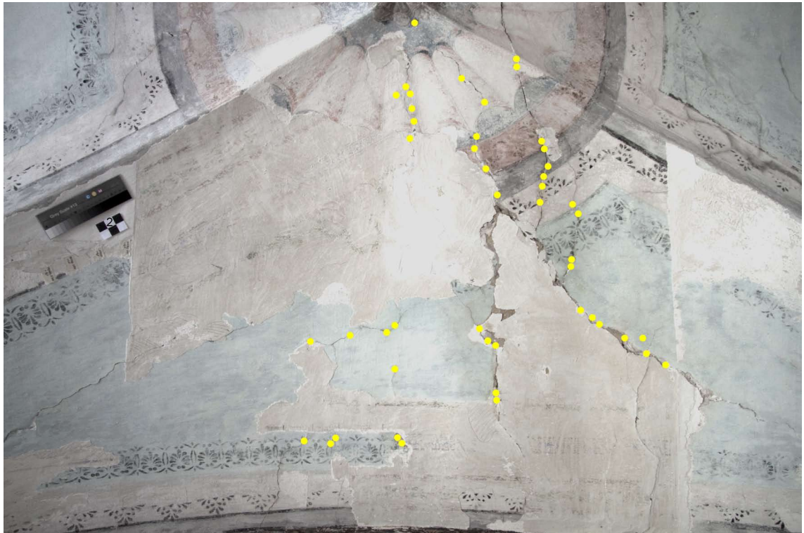
Obr. 54. Můj úsek klenební kápě. Žlutě vyznačená jsou místa hloubkové konsolidace ( Ledan D2 : plavená křída 2:1).
