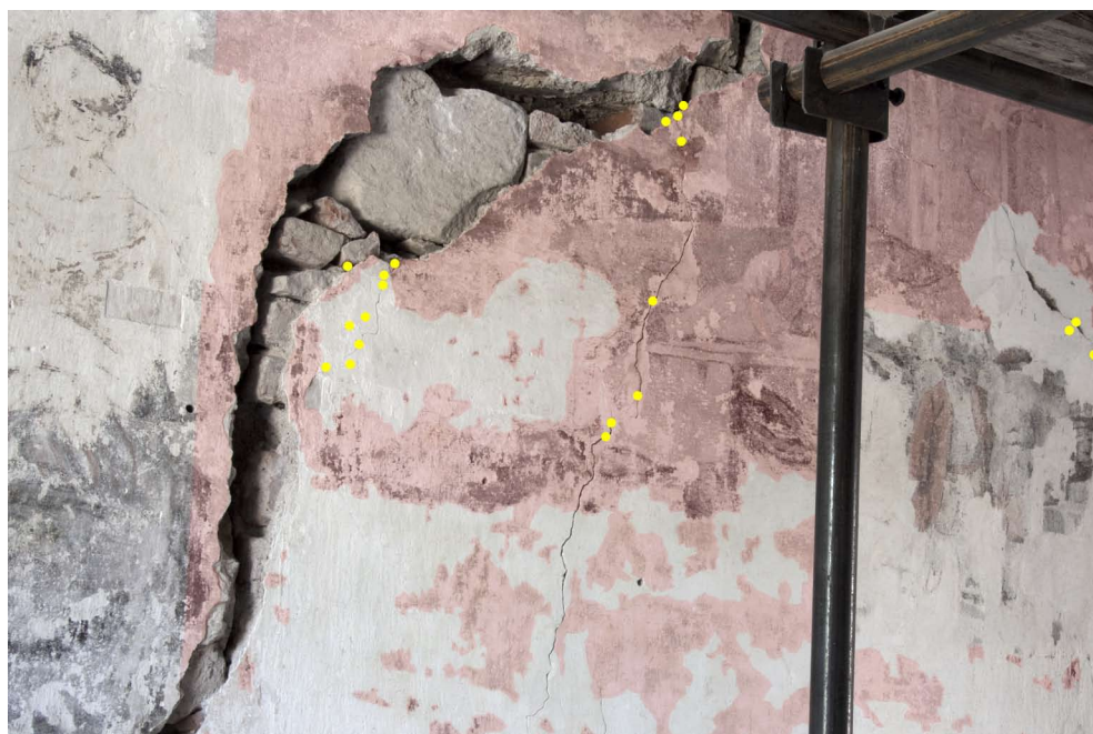
Obr. 53. Spodní část mého úseku na stěně. Žlutě vyznačená jsou místa hloubkové konsolidace ( Ledan D2 : plavená křída 2:1). Červeně tónovány jsou místa plošné fixáže zprašující se malby ( Primal WS24 3% v lihu, 1-2x). Lokální konsolidace malby není značená vzhledem k tomu, že během odkryvu byla většina míst kde je malba dochovaná konsolidována.
