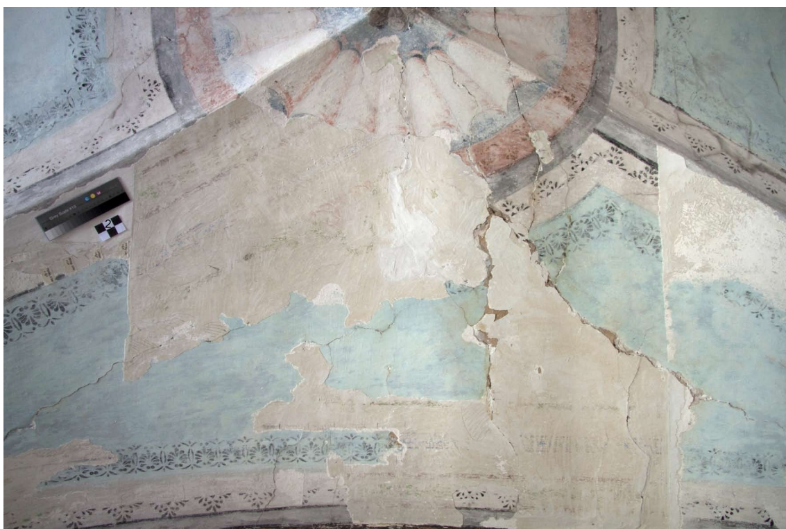
Obr. 47. Můj úsek klenební kápě v průběhu odkryvu a konsolidace (současný stav).
