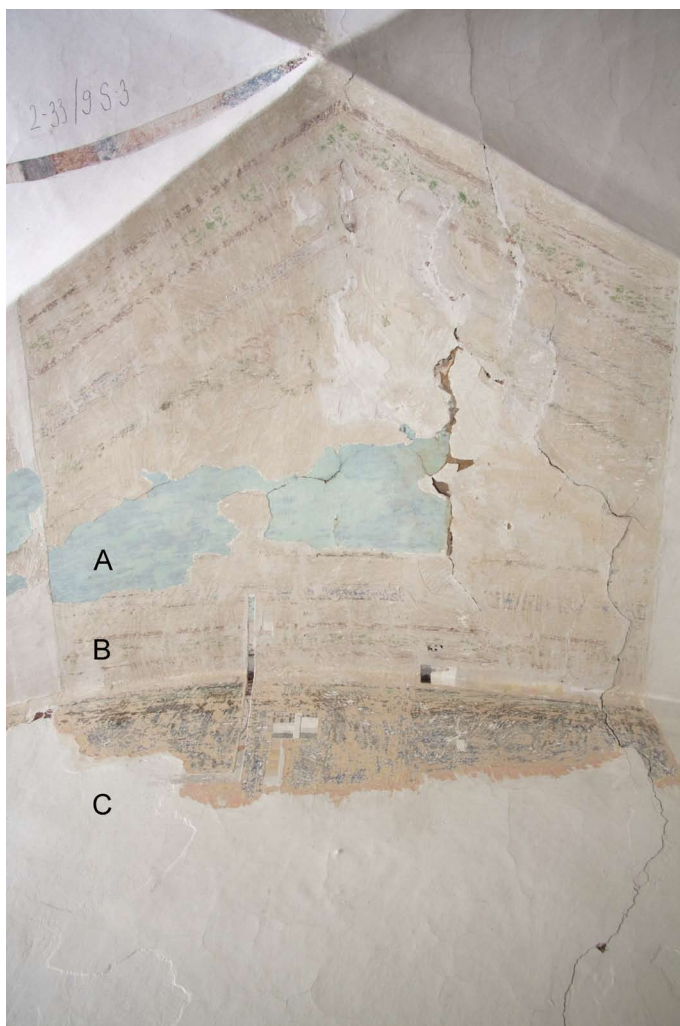
Obr. 45. Můj úsek klenební kápě v průběhu odkryvu: A) odhalená malba určená k restaurování, B) vápenný štuk, který bezprostředně překrývá malbu, na němž se nachází jednoduchá dekorativní výmalba v základních barvách červené, černé, zelené a modré. C) mladší bílé nátěry.
