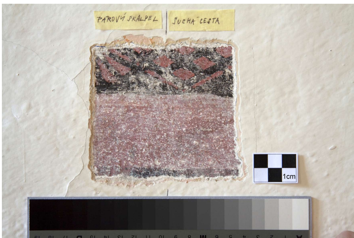
Obr. 18. Zkouška odkryvu vápenného šuku přímo překrývacího malbu (svrchní mladší nátěry byly odstraněny běžnými mechanickými metodami) provedena pomocí párového skalpela a suchou cestou běžnými mechanickými metodami.
