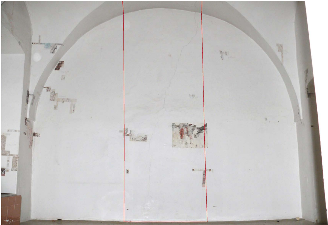
Obr. 3. Východní stěna před započítím restaurátorských prací. V r. 2003 byl v celé místnosti proveden stratigrafický průzkum souvrství omítek a nátěrů na zdivu. Sonda č. 2-33/9 S-26 na východní stěně byla v r. 2005 rozšířena na obdélníkový tvar (45,5x64,5 cm) a odkrytá malba byla restaurována. Obr. převzat a upraven (zdroj: Mgr. Art. Jan Vojtěchovský).
