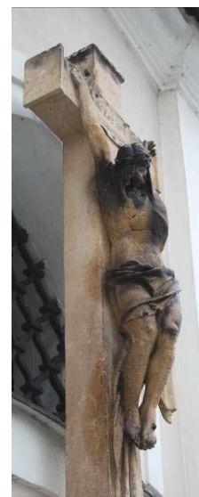
Obr. 23 Ukázka zčernalých depositů na povrchu
