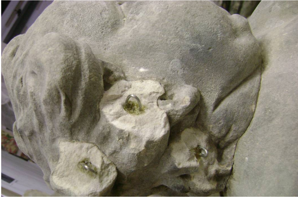
Obrázek 23: Detail s kotvičkami na plastické doplňky, průběh restaurování
