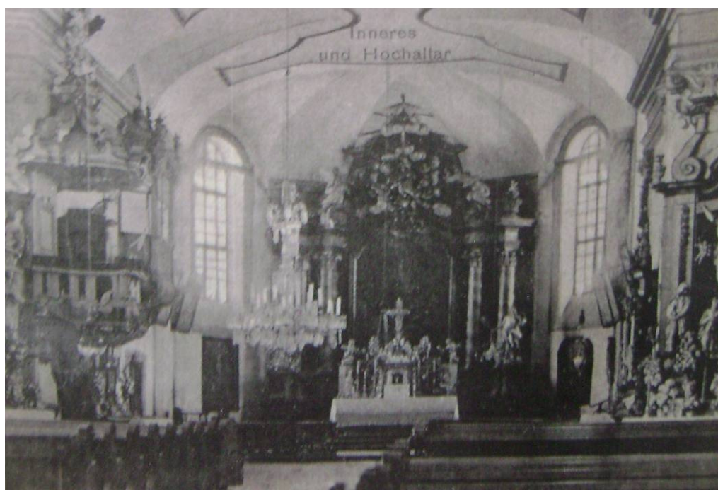
Obrázek 27: Bohatý interiér kostela
