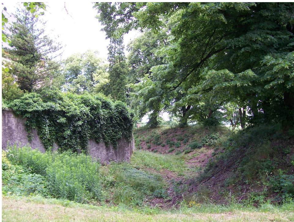
Obr. 22. Tvrziště v Kostelci u Heřmanova Městce, val s příkopem u kostela
