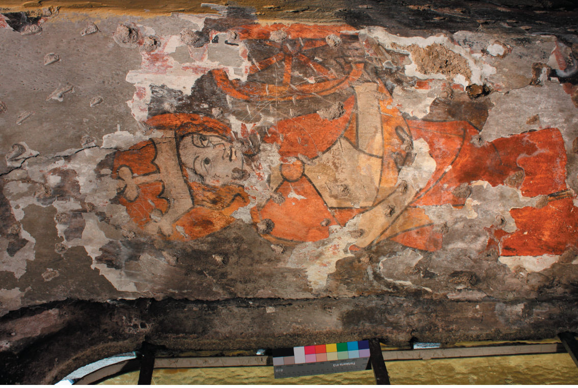
Obr. 21. Okenní špaleta. Mučednice. Stav malby před restaurováním. Březen 2010.
