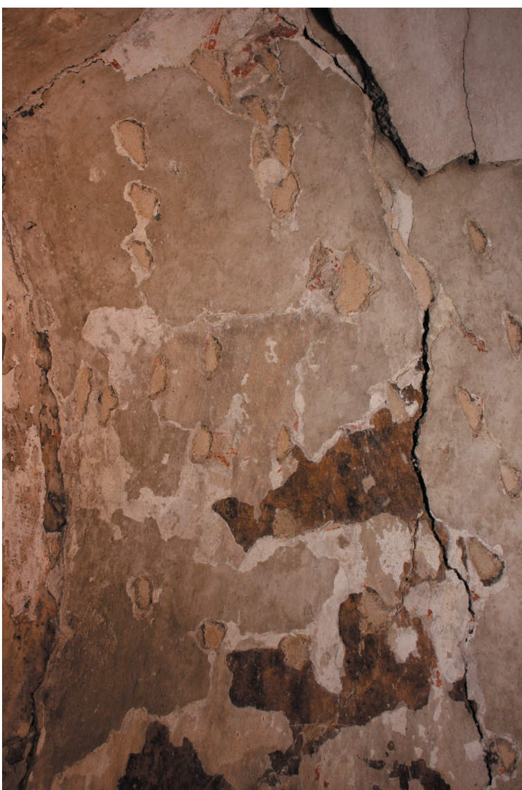
Obr.15., Obr. 16. Okenní špaleta. Průběh tmelení. Finální vrstva tmelu.
