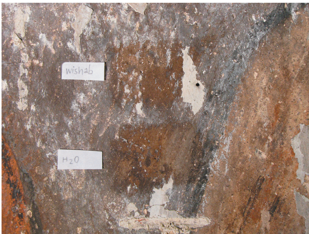
Obr. 50. Levá strana okenní špalety. Zkoušky čištění šedého zákalu na barevné vrstvě.
