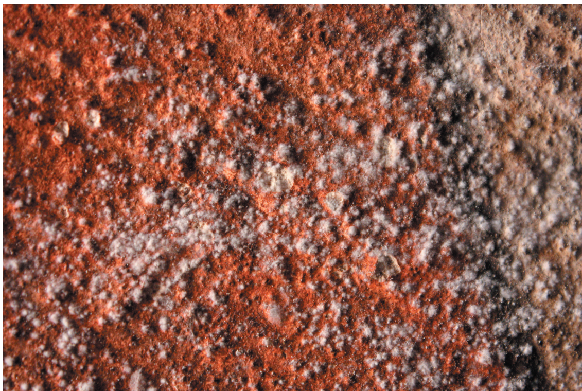
Obr. 25. Povrch dochovaných nástěnných maleb v okenní špaletě je znehodnocen výkvěty solí a působením mikroorganismů. Foto: M. Třesohlavá.
