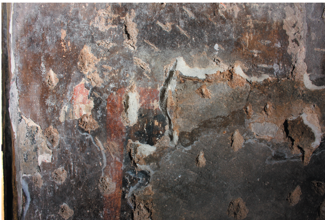
Obr. 24. Ztmavnutí nástěnných maleb bylo s největší pravděpodobností způsobeno vlivem požáru. Na fotografii jsou velmi dobře čitelné solné mapy. Foto: M. Třesohlavá.
