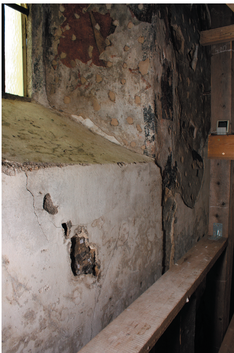
Obr. 3. Východní stěna. Čištění povrchu nejmladší omítkové vrstvy s mono- chromním vápenným nátě- rem. Foto: M. Třesohlavá
