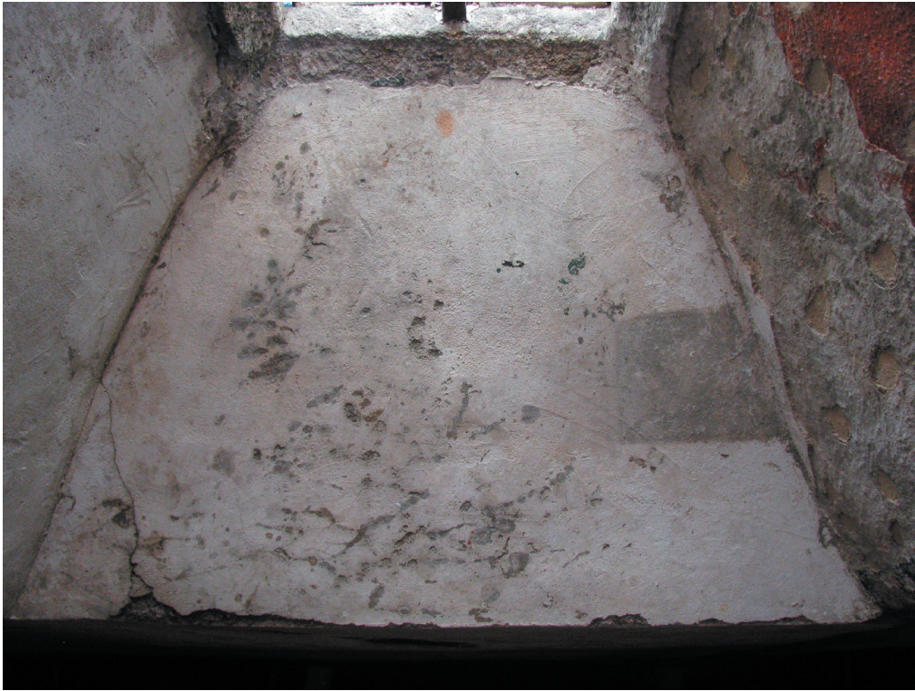
Obr. 5. Okenní špaleta. Bankál v průběhu redukce povrchového deponátu.
