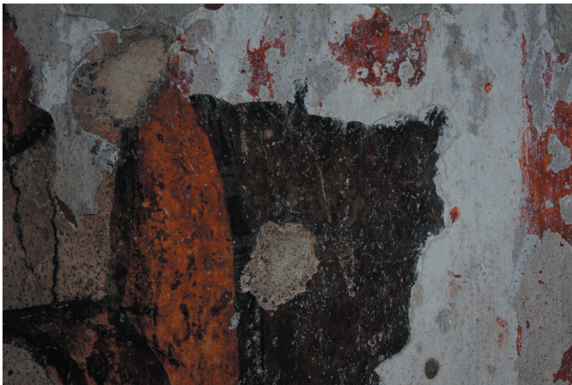
Obr. 12. Okenní špaleta. Průběh upevňování mladších monochromních nátěrů.
