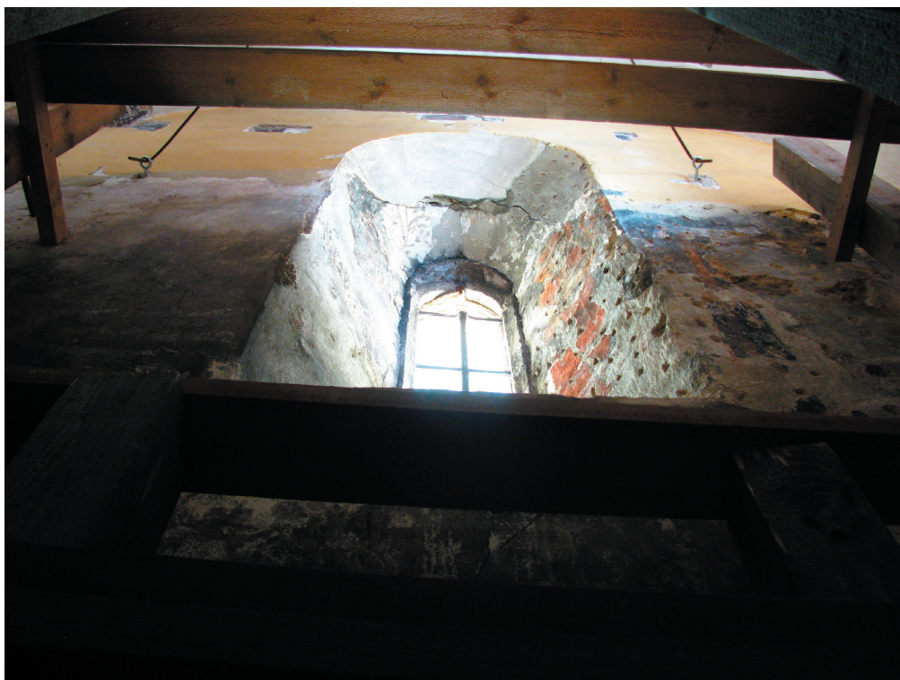
Obr. 7. Východní stěna presbytáře. Okenní špaleta v těsném prostoru za oltářem. Nynější vzdálenost oltáře od stěny činí 76-95 cm. Únor 2010.
