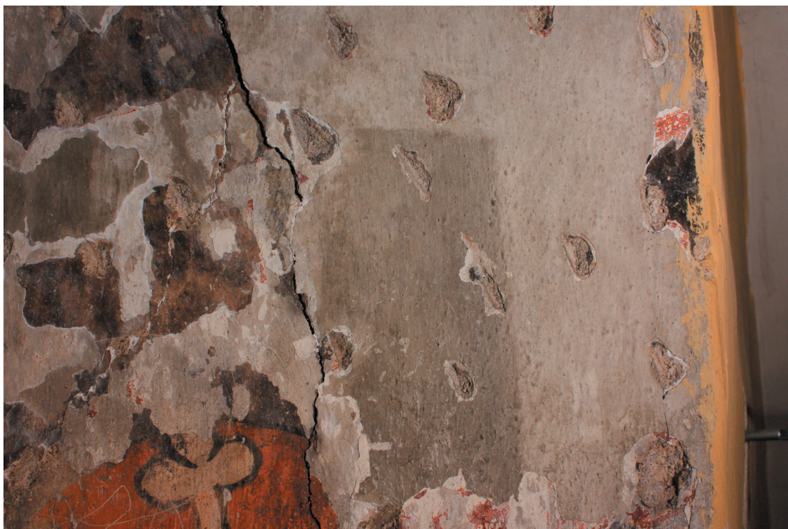
Obr. 7. Okenní špaleta. Čištění mladších monochromních nátěrů.
