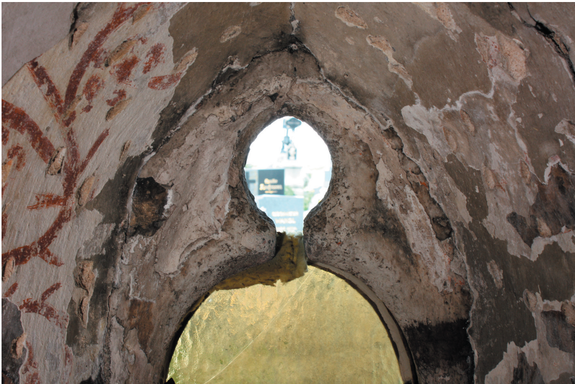
Obr. 6. Okenní špaleta. Snímání nečistot z povrchu vápenných nátěrů na žulové kružbě.
