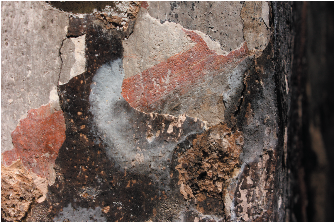
Obr. 30. Pravá strana okenní špalety. Souvrství několika vápenných nátěrů. Je zde dobře patrné zčernání maleb (pravděpodobně vlivem požáru) a tvorba solných map. Foto: M. Třesohlavá.
