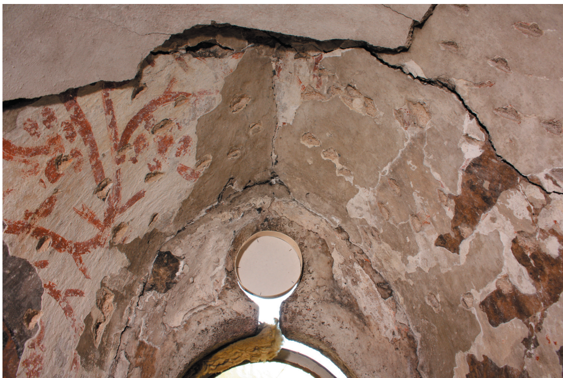
Obr. 11. Okenní špaleta. Pravá část v průběhu upevňování mladších monochromních nátěrů.
