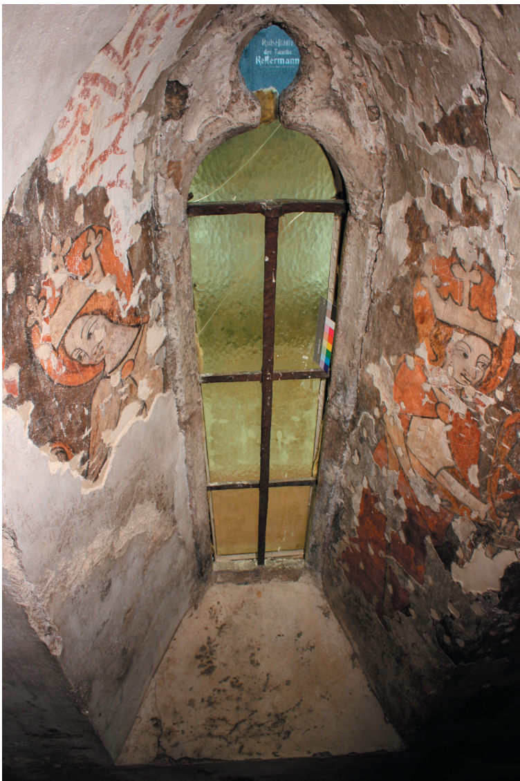
Obr. 17., Obr. 18. Okenní špaleta. Stav maleb po vytmelení.
