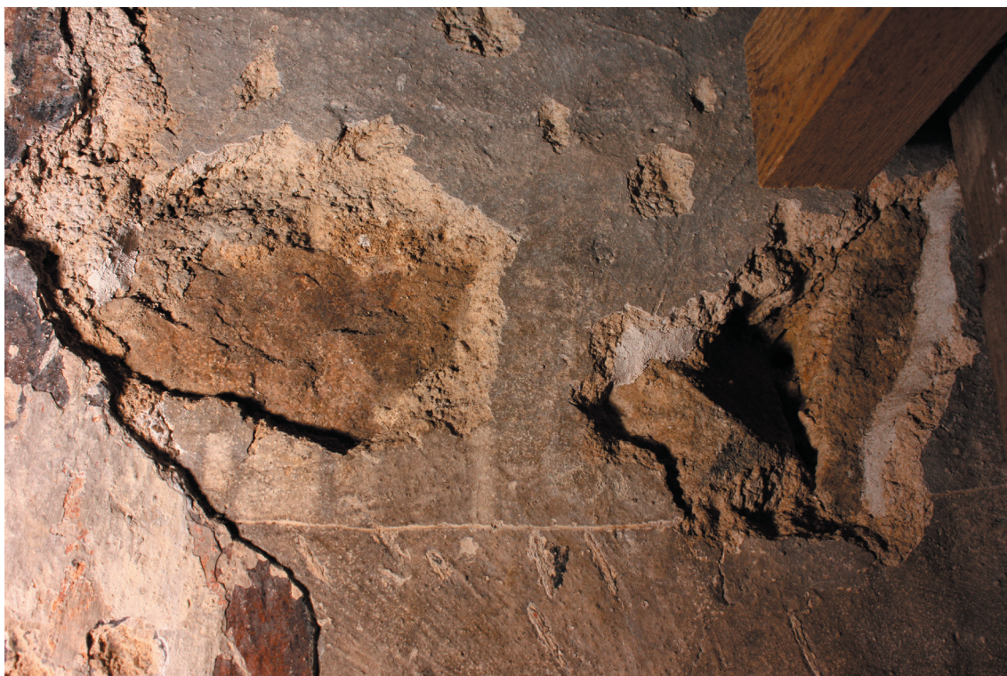
Obr. 1. Východní stěna. Zajišťování omítkových vrstev podtmelením.
