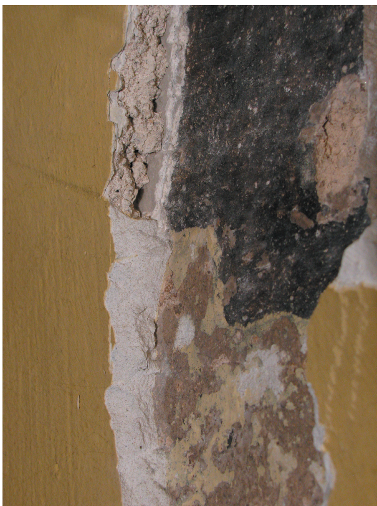
Obr. 21. Spodní část východní stěny. Nález minimálně dvou vysprávek, které zřejmě souvisí s instalací oltáře v 18. století.
