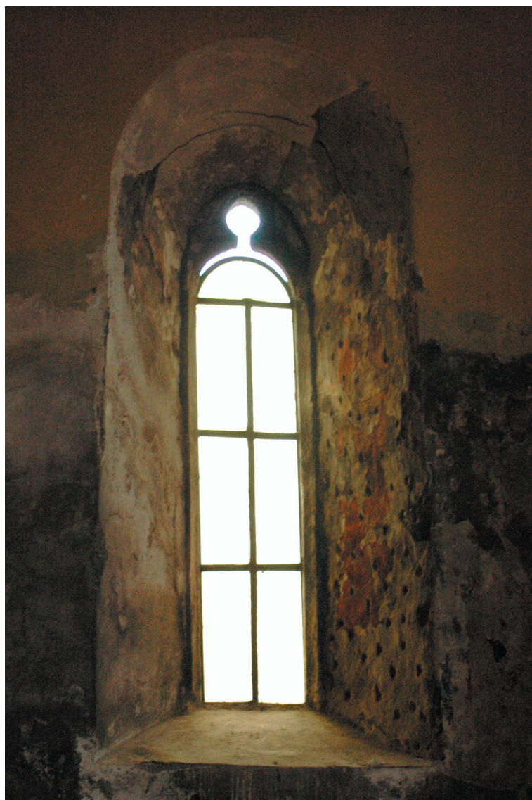
Obr. 3. Pohled na východní stěnu presbytáře po demontáži oltáře. Listopad 2009. Foto: P. Weiss.
