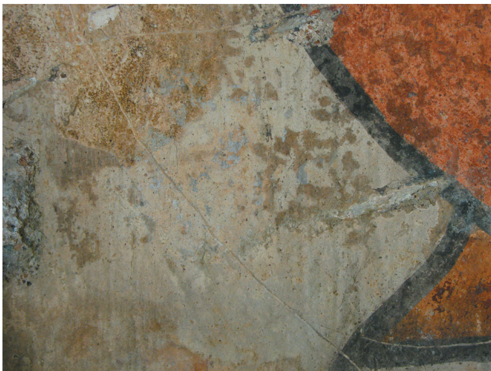
Obr. 8. Okenní špaleta. Čištění nejstarší dochované barevné vrstvy. Levá strana - stav po vyčištění.
