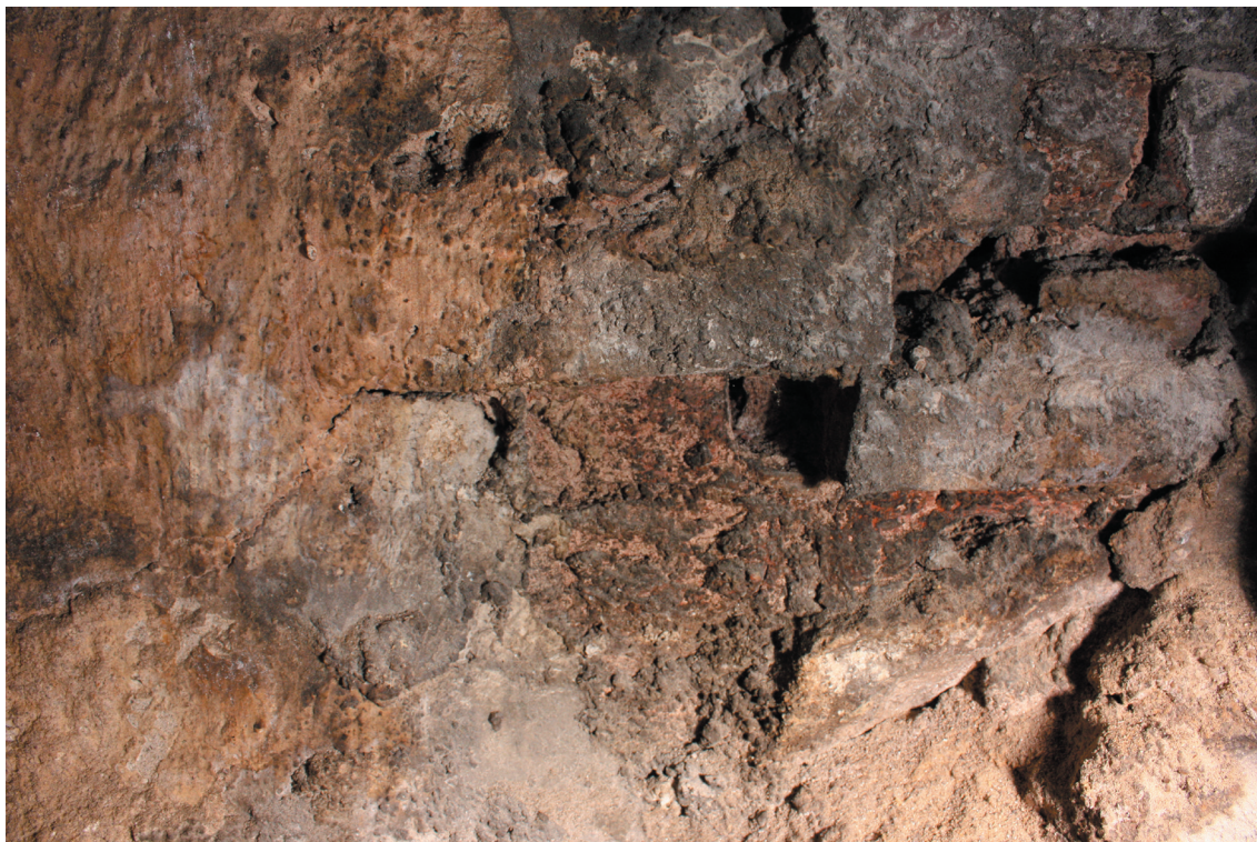
Obr. 14. Smíšené zdivo spodní části východní stěny presbytáře je tvořeno lomovým kamenem (žulou) a cihlami. Foto: M. Třesohlavá.
