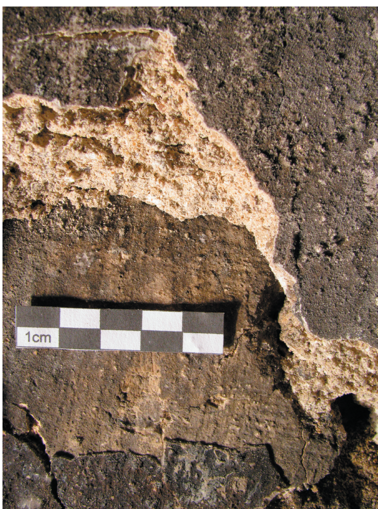
Obr. 19. Povrch barokní omítky s vrstvou světlého monochromního nátěru.
