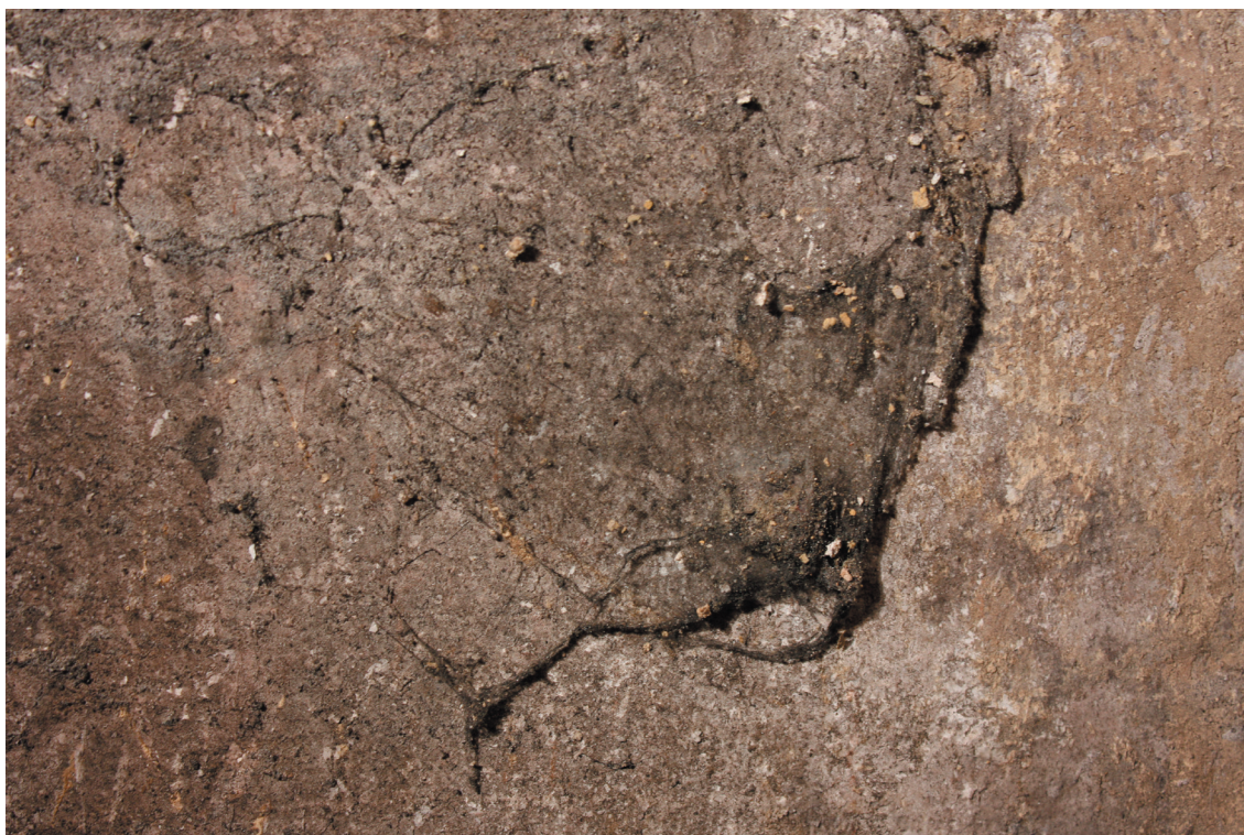
Obr. 23. Východní stěna. Povrch omítek s monochromními nátěry je pokryt silnou vrstvou prachového depozitu a pavučin. Foto: M. Třesohlavá.
