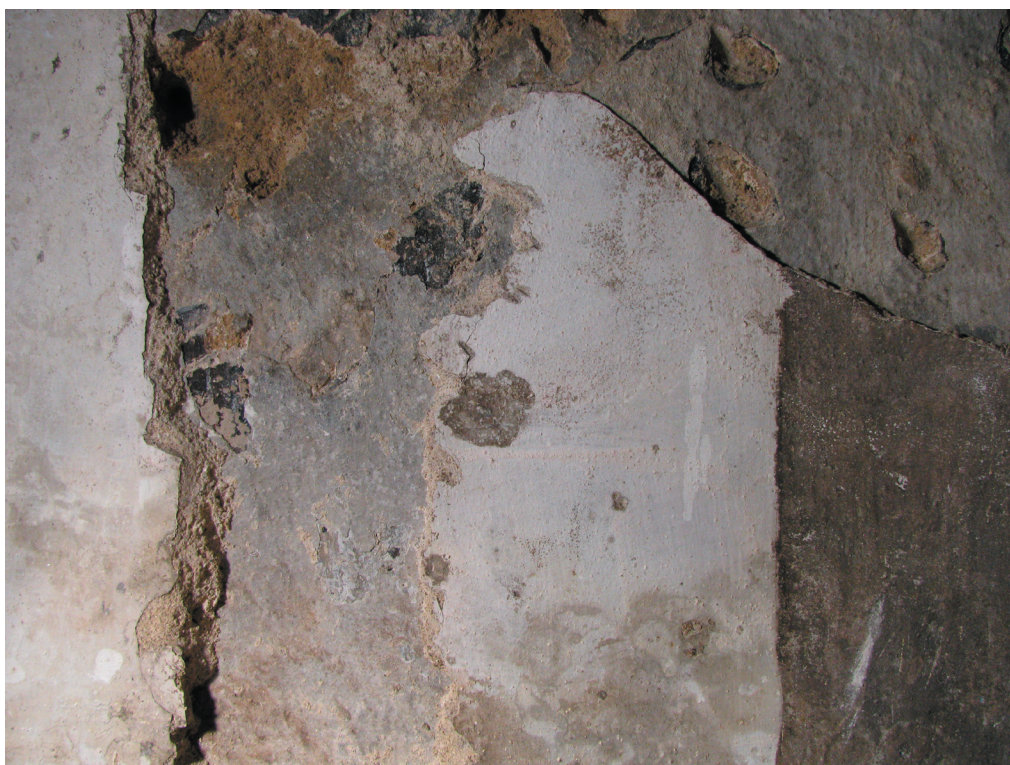
Obr. 2. Východní stěna. Čištění povrchu nejmladší omítkové vrstvy s monochromním vápenným nátěrem.
